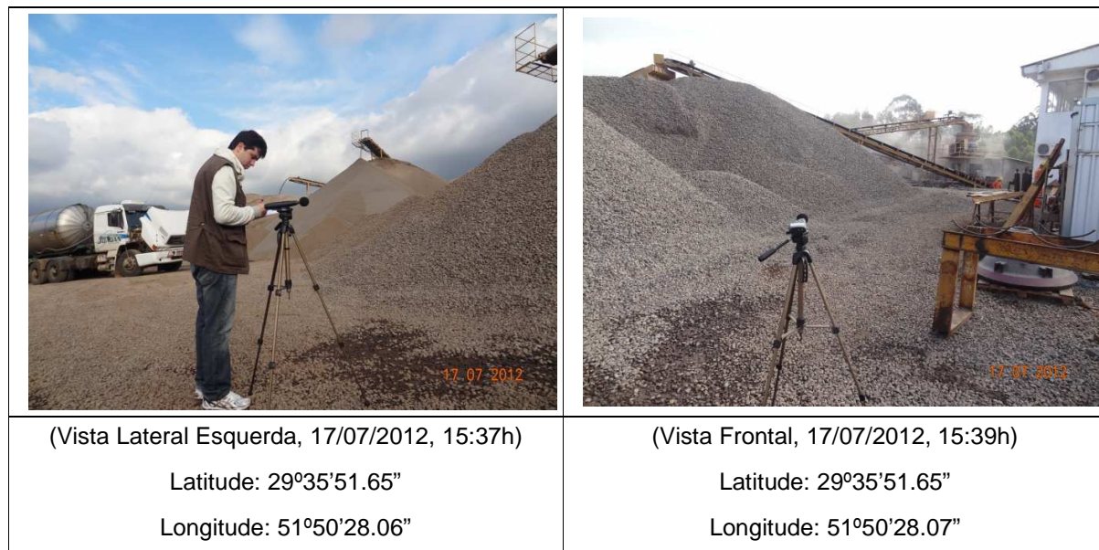
Fotos - Usina de Asfalto/Britagem – Ponto: Centro de Controle
