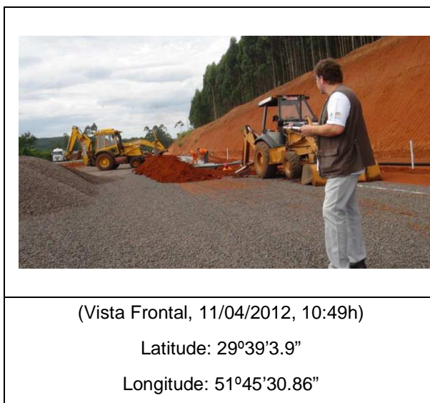
Fotos - Km 375, Frente de Obras – ao longo da rodovia BR-386
