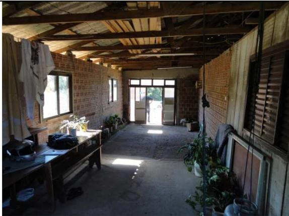
Garagem, sem forro, sem piso cerâmico, sem reboco nas paredes de alvenaria, parede da direita fora do prumo - visão dos fundos para a frente da residência
