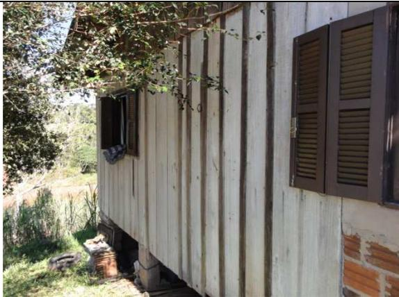
Visada do centro para esquerda – conjugado entre alvenaria e madeira – fachada
