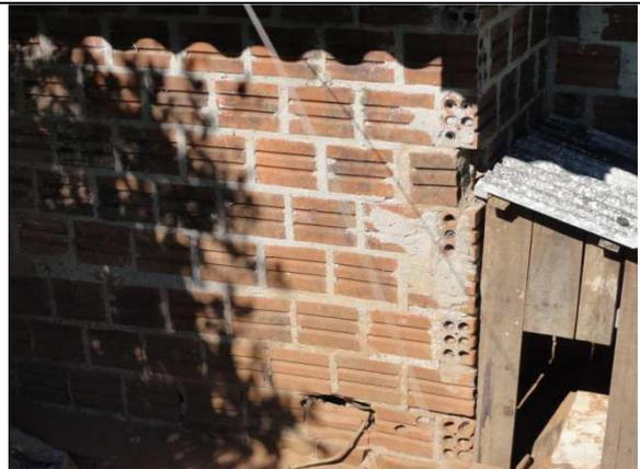
Parede sem reboco, tijolo quebrado – lateral direita
