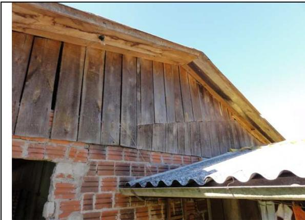
Detalhe do telhado do anexo, parede sem reboco e tábuas para cobrir a parede e o beirado – fundos
