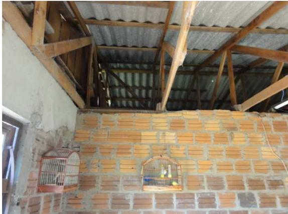
Garagem, detalhe dos caibros do telhado e da parede sem reboco
