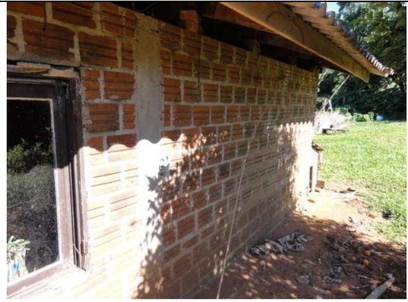
Parede sem reboco, toda a extensão – lateral direita
