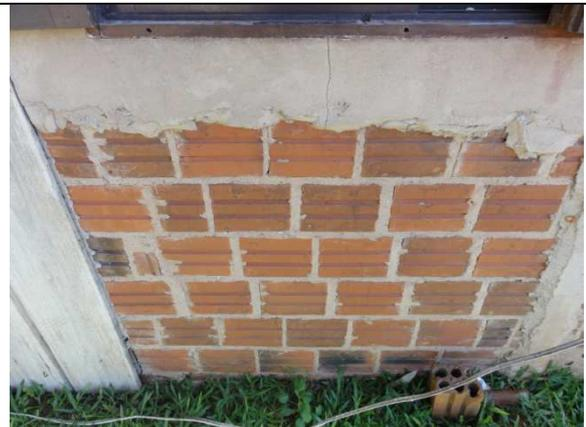
Fissura e reboco faltante na parede abaixo da janela do quarto - fachada
