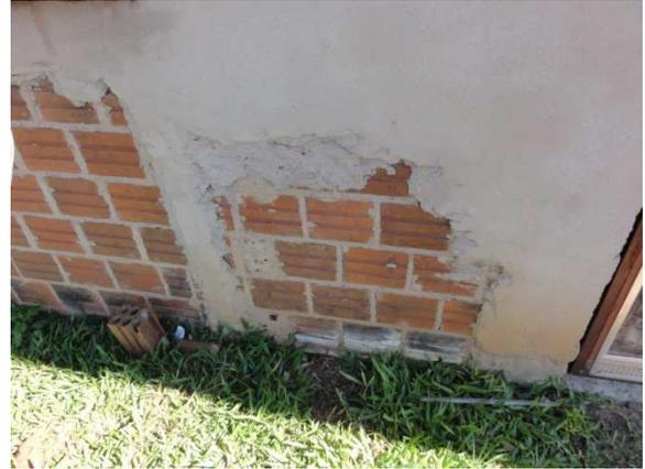
Falta de reboco na parede - lado esquerdo da porta de entrada - fachada
