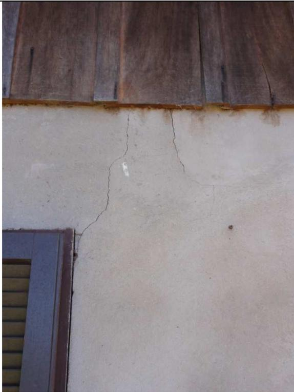
Fissura na parede do lado direito da janela do quarto - fachada
