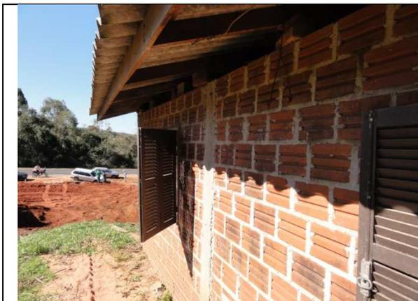
Telha fibrocimento, sem reboco, sem calçada, sem forro – lateral direita
