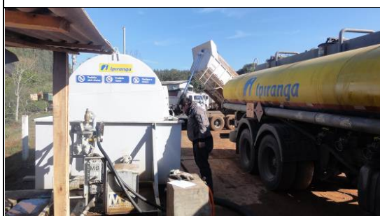
Verificação da bacia de retenção de óleo – tanque de combustível da área de apoio, km 14+500 LD. 04/07/11.
