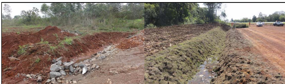
Barreira de rachão e terra, retendo sedimentos. 08/09/11. Revestimento de talude com leivas, km 10+800 LD. 15/09/11.
