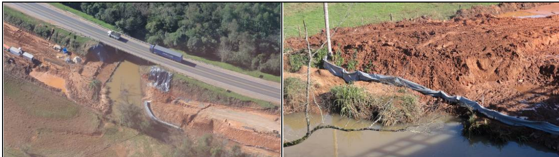
Arroio Concórdia - vista aérea onde é observado: bacia de sedimentação, barreira com bidim, cobertura de taludes c/ lona preta e gabião. 25/07/11.
