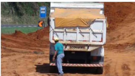
Lona sendo instalada sobre a carga.
