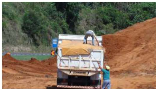
Detalhe da lona instalada.
