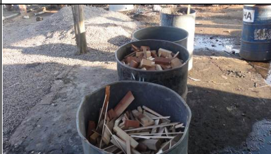
Resíduos da obra (restos de madeira – confecção de formas), reaproveitado como lenha em microempresa local. 27/07/11.
