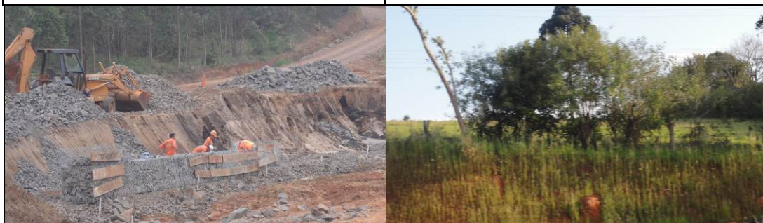
Gabião em construção, km 28 +700 LD. 22/09/11. Hidro-semeadura em talude de corte, km 12+900 LD, 22/09/11.
