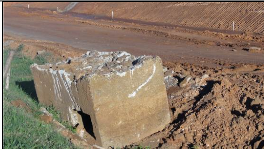
Restos de estruturas antigas de drenagem, km 27+040 LD. 04/07/11.
