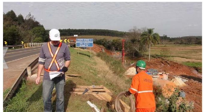
**Figura 38 – MD1 medição do ruído junto aos operários na obra da ponte Arroio Concórdia**
