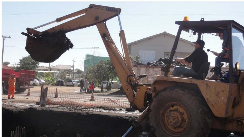
**Figura 31** – MD1 medição do ruído junto ao operador da retro escavadeira em funcionamento.
