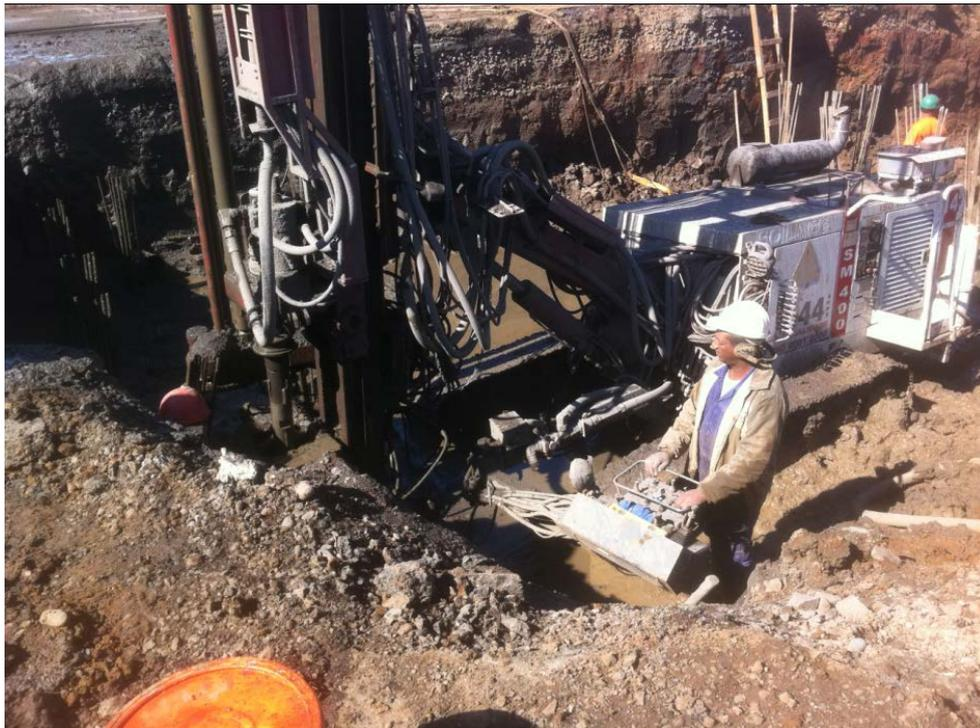
Figura 33 – MD2 medição do ruído junto ao operador do bate estaca em funcionamento
