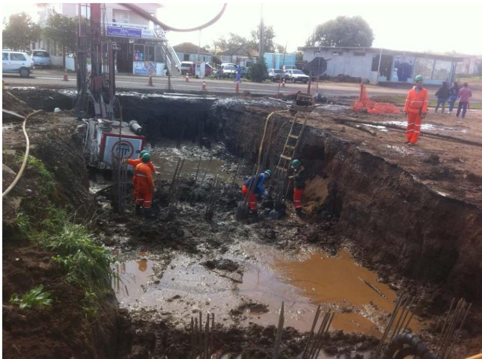
**Figura 35** – MD3 medição do ruído junto aos operários próximos (5m) ao bate estaca em funcionamento
