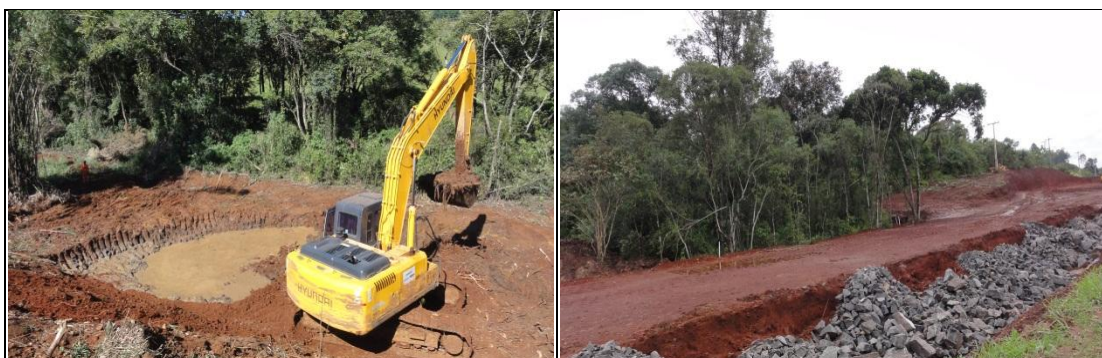
Remoção de solos encharcados, km 15+840 LD. 07/04/11.
