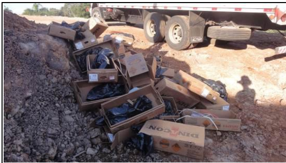
Resíduos, embalagens plásticas e de papelão, resultantes das detonações na pedreira, a ser tratado pela DINACON. 06/06/11.
