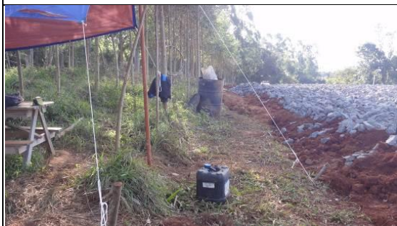
Toneis para recolhimento de resíduos na área do canteiro de britagem. 06/06/11.
