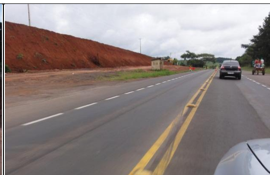
Talude no limite da faixa de domínio com área da futura EC 17 (alternativa), km 9+400. 02/04/11.
