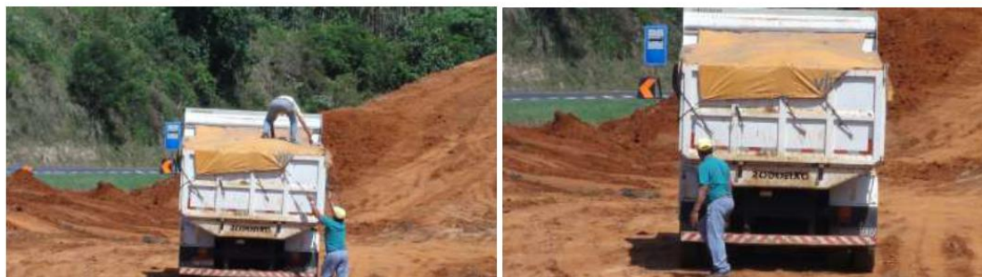
Detalhe da lona instalada.
