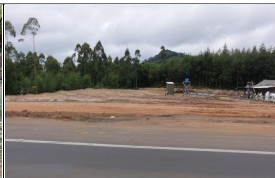
Sanitários instalados na frente de obras, km
