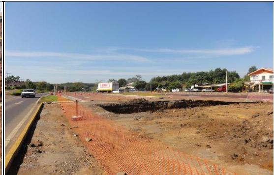
Continuidade das escavações para construção das bases do viaduto. 20/04/11.
