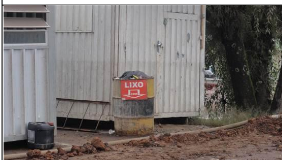
Tonel para recolhimento de resíduos - área de construção do Viaduto de Fazenda Vila Nova. 21/06/11.
