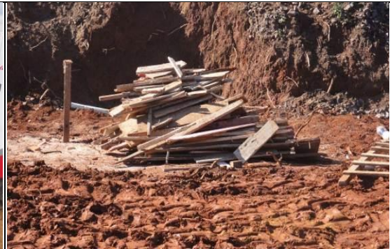
Resíduos de madeira utilizada em formas, dispostas em pilhas para recolhimento posterior, km 10+480. 19/05/11.
