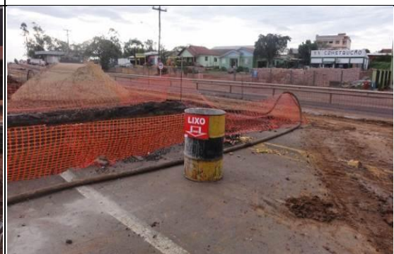
Tonel para recolhimento de resíduos, Viaduto de Fazenda Vila Nova. 25/05/11.
