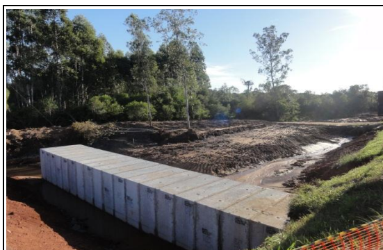
Construção de BSCC. 25/04/11.
