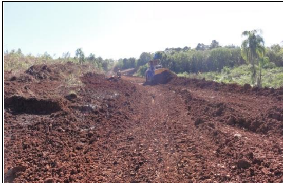
Pedreira - abertura de via para circulação de máquinas caminhões. 28/04/11.
