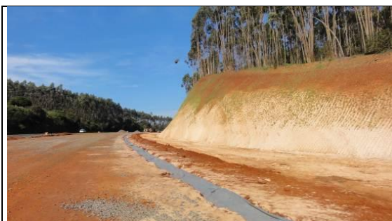
Área de corte, execução de drenagem longitudinal com utilização de manta geotêxtil. Km 23+260 LD. 02/06/11.
