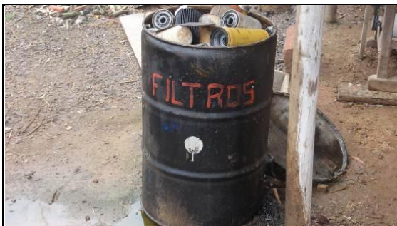
Tonel para recolhimento de filtros - área de apoio às obras de terraplenagem, km 14+500 LD. 21/06/11.
