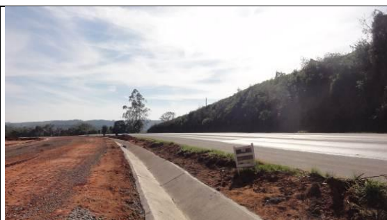
Calhas de drenagem no canteiro central, km 22+880 LD. 02/06/11.
