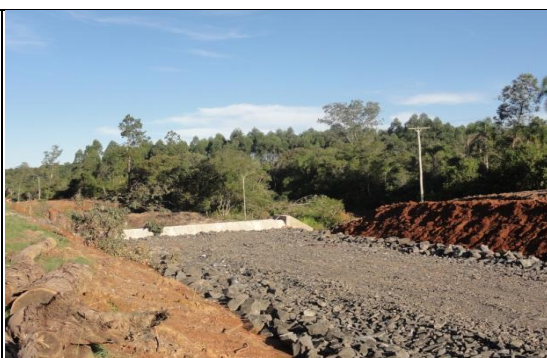
Implantação de BSTC e utilização de rachão na base do aterro, km10+400 LD. 20/04/11.
