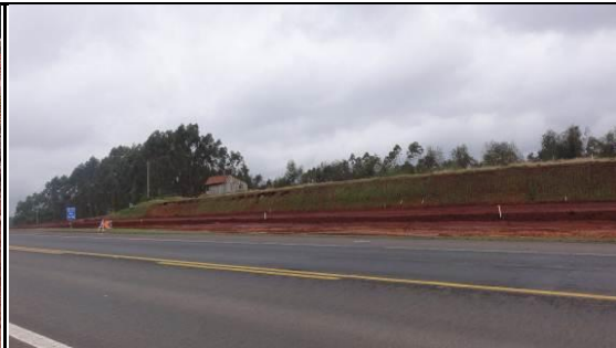
Hidrossemeadura em talude de corte, km 24+440 LD. 21/06/11.
