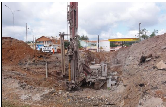
Viaduto - bate estaca em operação. 05/04/11.
