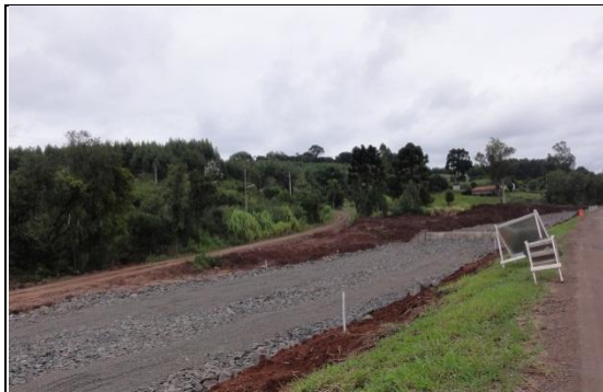
Uso de "rachão" na base do aterro, km 11+800 LD. 18/04/11.
