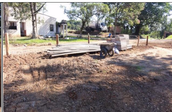
Construção de cercas para delimitação da área de apoio. 04/04/11.
