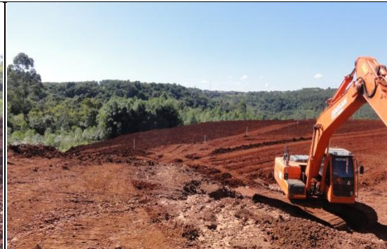
Operações de terraplenagem para implantação do canteiro de britagem. 28/04/11.
