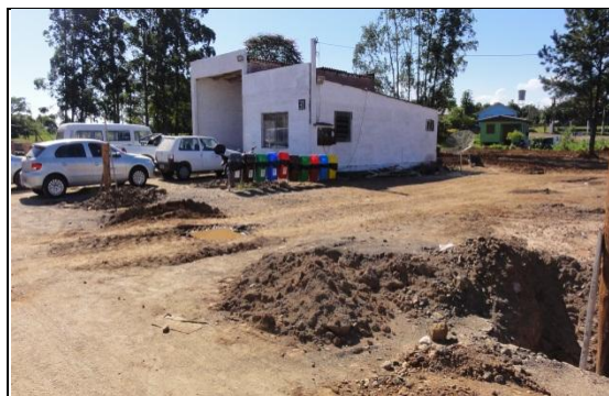
Área de apoio à construção do viaduto - escritório (via lateral da BR 386, km 16+400). 04/04/11.
