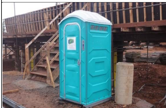
Utilização de banheiros químicos, tratamento de dejetos, Viaduto de Fazenda Vila Nova. 23/05/11.
