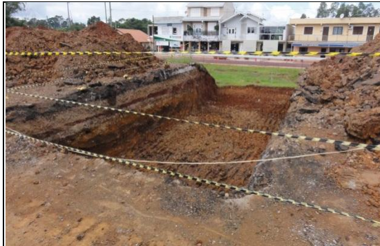
Escavação para implantação das bases do Viaduto de Fazenda Vila Nova. 05/04/11.
