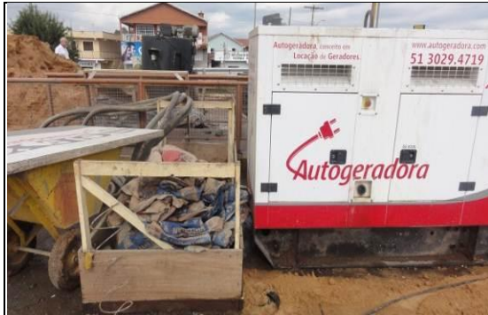
Acondicionamento temporário de sacos de cimento em caixas e barreira de areia no entorno do gerador (localização temporária). Viaduto Fazenda Vila Nova. 11/05/11.
