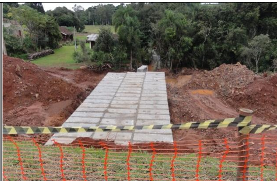
Construção de galeria BTCC, km12+300 LD. 18/04/11.
