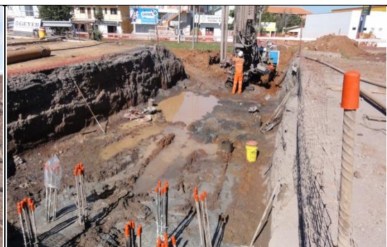
Implantação de estacas. 29/04/11.
