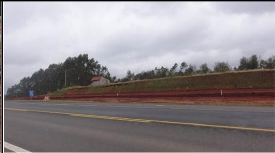
Hidrossemeadura em talude de corte, km 24+440 LD. 21/06/11.
