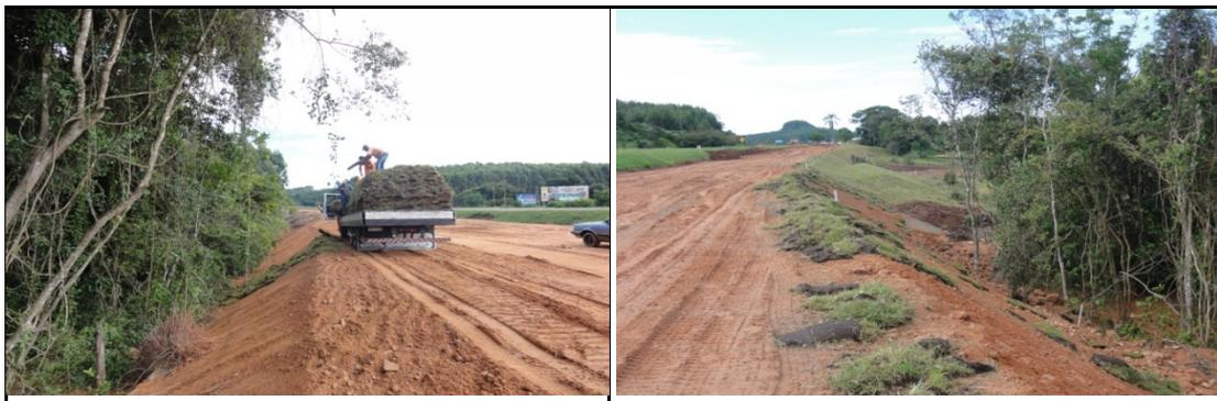
Carga de leivas para proteção de talude, km 29+980 LD. 13/04/11.
