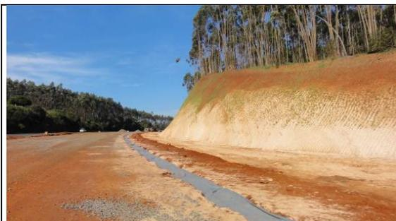
Área de corte, execução de drenagem longitudinal com utilização de manta geotêxtil. Km 23+260 LD. 02/06/11.
