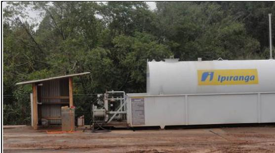
Tanque de combustível e bacia de retenção de óleo diesel - área de apoio às obras de terraplenagem, km 14+500 LD. 21/06/11.
