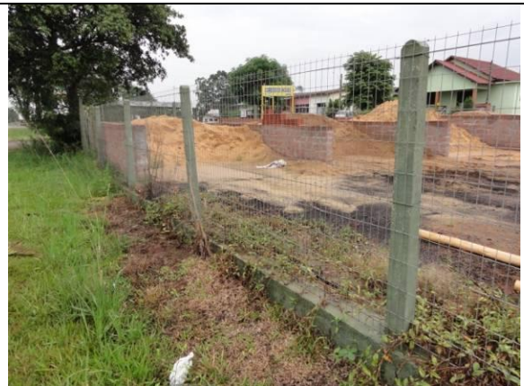
Fachada - Portão (DSC04081, 23/02/2011, 16:29h)
