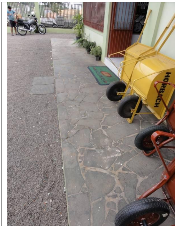
Fachada – Calçada de pedras (DSC03831, 23/02/2011, 10:54h)
