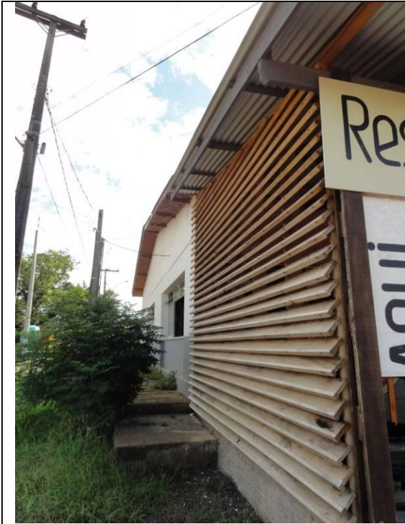
Lateral Direita – Parede D (DSC04493, 24/02/2011, 09:48h)
