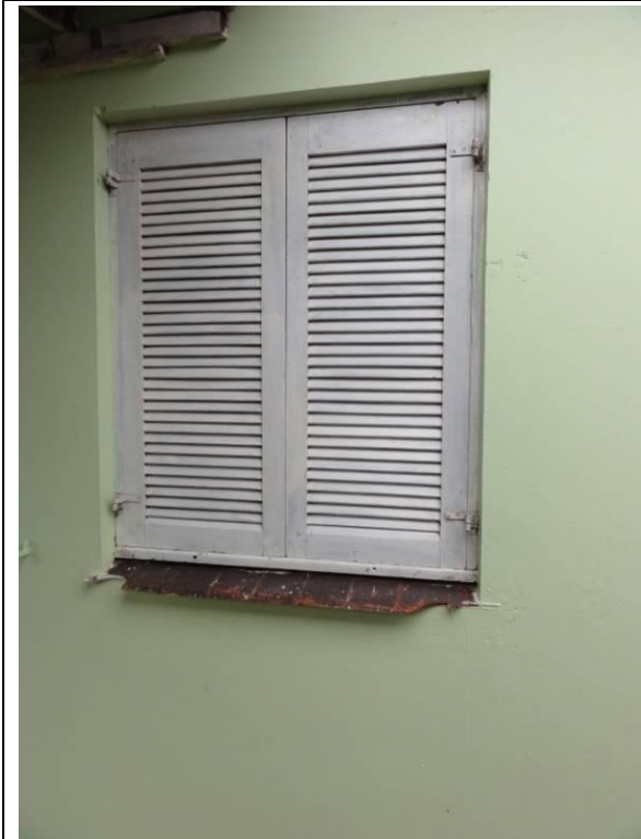
Lateral Direita- parede D (20 23/02/2011, 17:31h)
