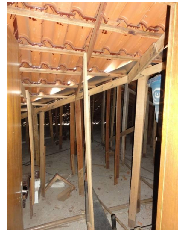
3º Piso – Sótão (DSC04035, 23/02/2011, 11:30h)
