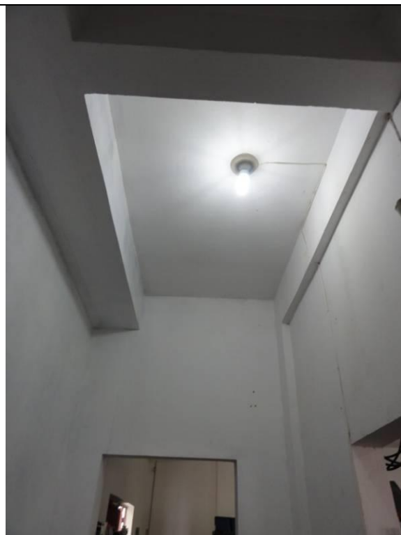
Piso Inferior – Loja (DSC03890, 23/02/2011, 11:05h)
