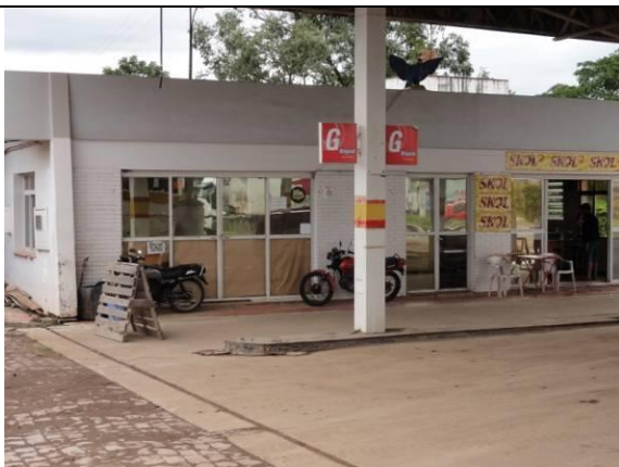
Fachada (DSC04697, 24/02/2011, 11:05h)
