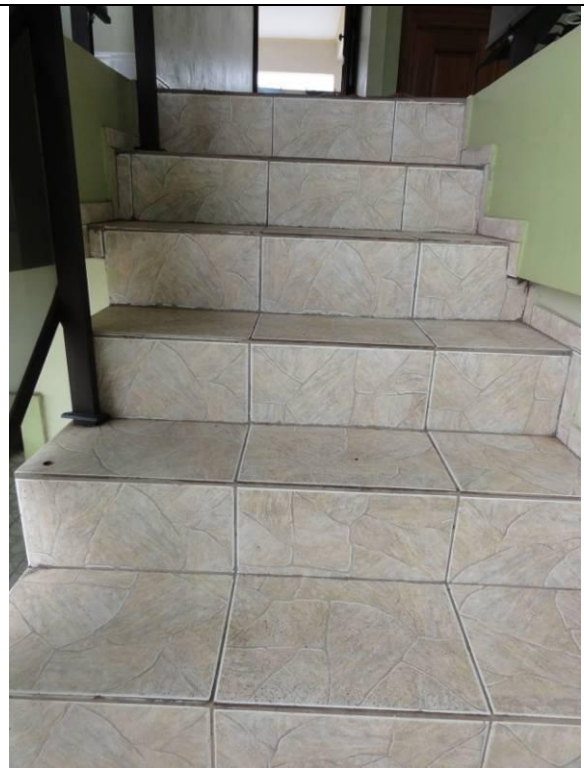
Escada (DSC03918, 23/02/2011, 11:12h)
