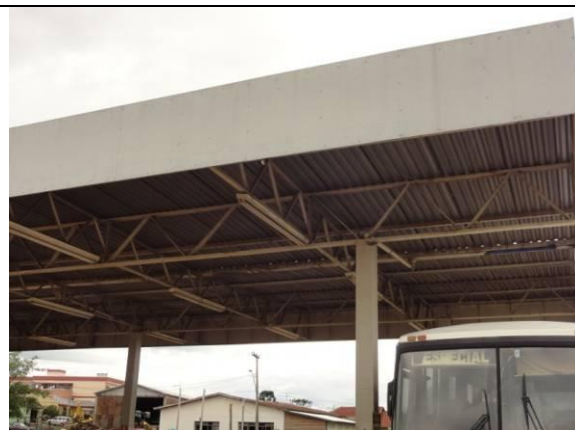
Fachada - Cobertura (DSC04690, 24/02/2011, 11:03h)
