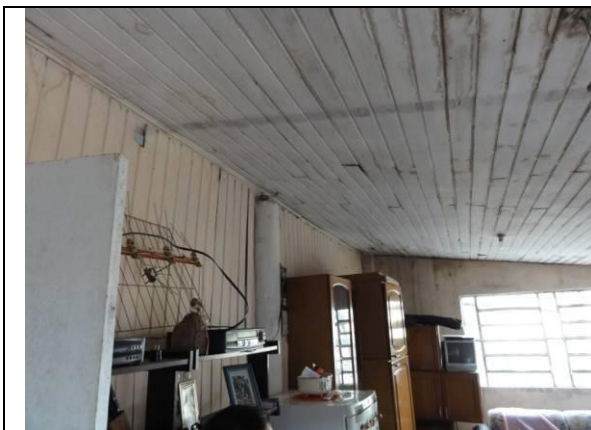
Sala / Cozinha – Teto com forro de madeira (DSC03652, 23/02/2011, 09:56h)
