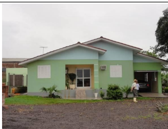
Casa - Fachada (DSC04151, 23/02/2011, 16:47h)
