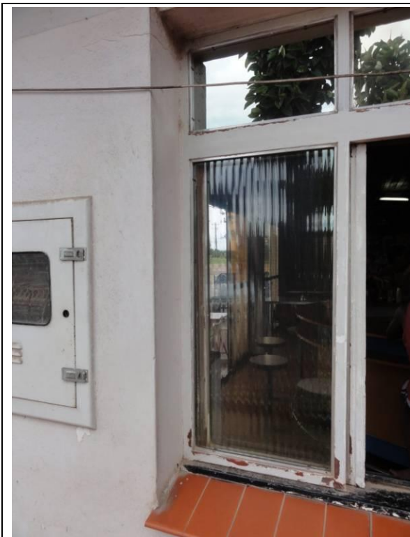
Lateral Esquerda- Parede B (DSC04768, 24/02/2011, 11:15h)
