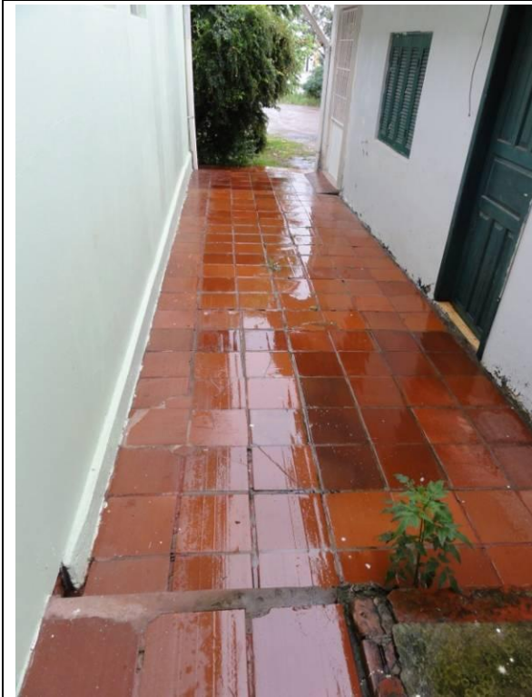
Lateral Direita- parede D (DSC04322, 23/02/2011, 17:32h)
