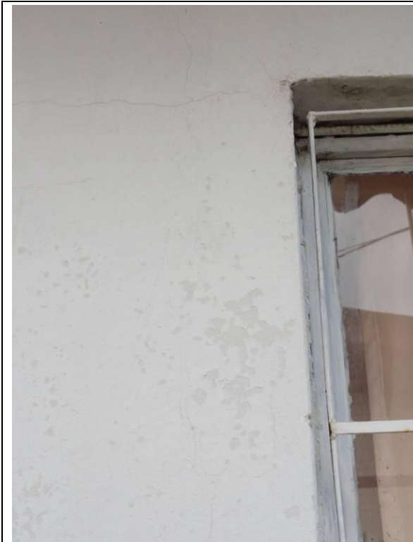
Lateral Direito – Parede D (DSC04391, 24/02/2011, 09:23h)
