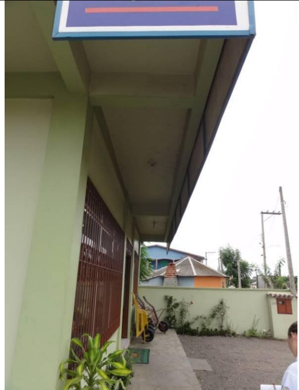
Fachada (DSC03844, 23/02/2011, 10:56h)
