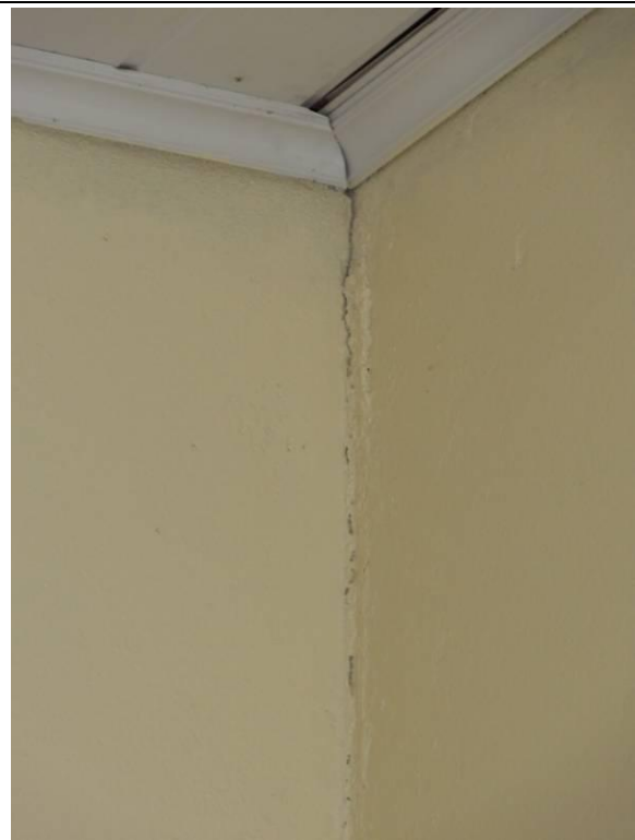
Garagem (DSC04241, 23/02/2011, 17:05h)
