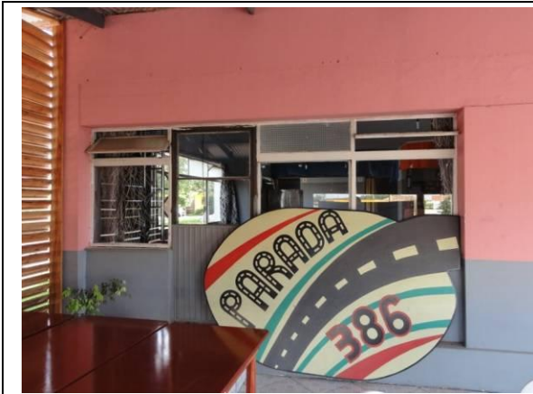
Fachada - Entrada (DSC04489, 24/02/2011, 09:47h)
