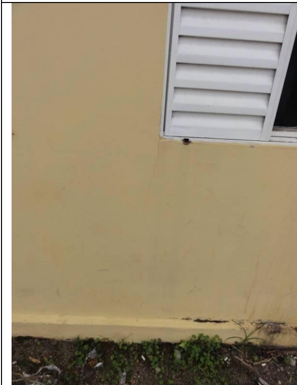
Fachada (DSC03727, 23/02/2011, 10:20h)
