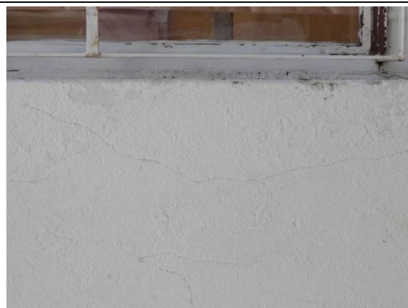
Lateral Direito – Parede D (DSC04394, 24/02/2011, 09:23h)
