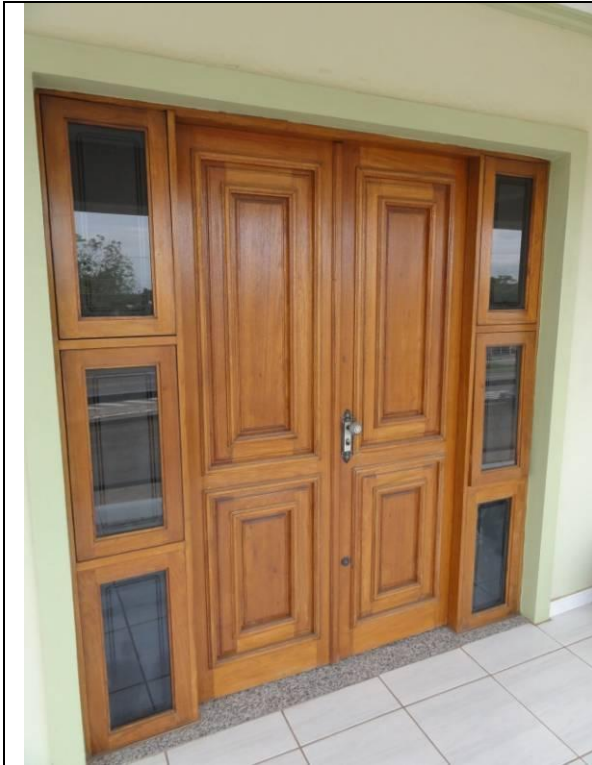
Piso Superior - Sacada (DSC03951, 23/02/2011, 11:16h)
