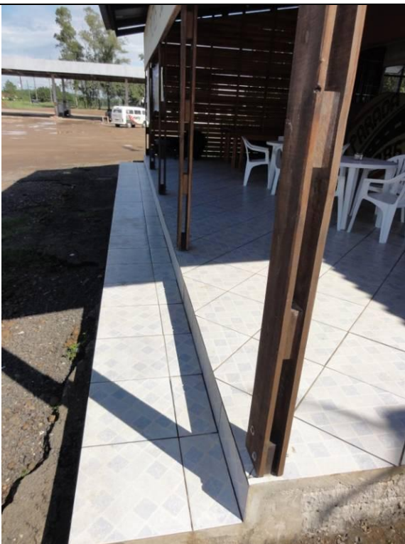
Fachada - Cobertura (DSC04483, 24/02/2011, 09:46h)
