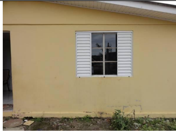
Fachada (DSC03726, 23/02/2011, 10:20h)
