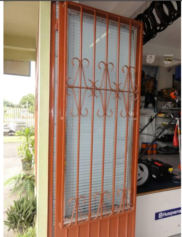
Piso Inferior – Loja – Entrada (DSC03846, 23/02/2011, 10:56h)
