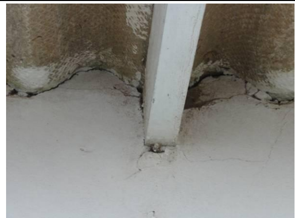
Lateral Direito – Parede D (DSC04416, 24/02/2011, 09:26h)
