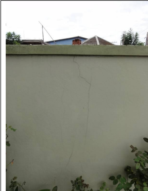
Fachada – Muro (DSC03827, 23/02/2011, 10:54h)
