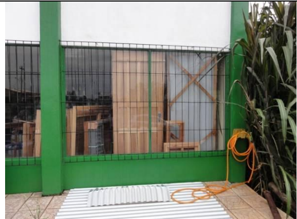
Fachada - Vidraças (DSC04091, 23/02/2011, 16:32h)
