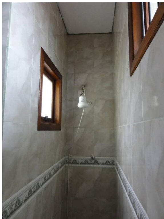
3º Piso – Quarto 2 - WC (DSC04030, 23/02/2011, 11:29h)
