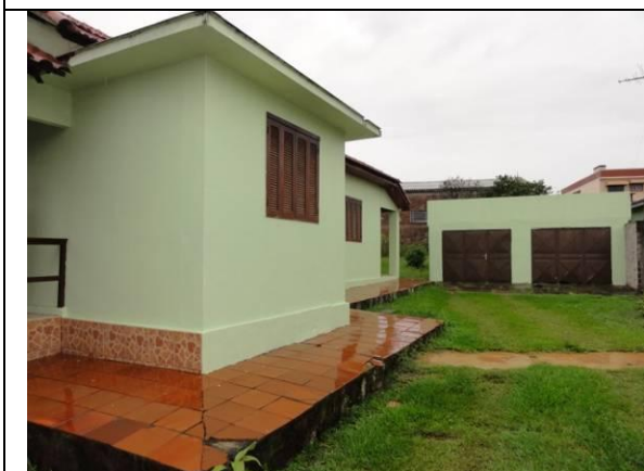
Lateral Esquerda – Parede B (DSC04255, 23/02/2011, 17:16h)
