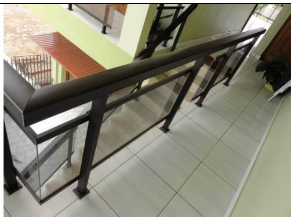
Piso Superior - Sacada (DSC03943, 23/02/2011, 11:15h)
