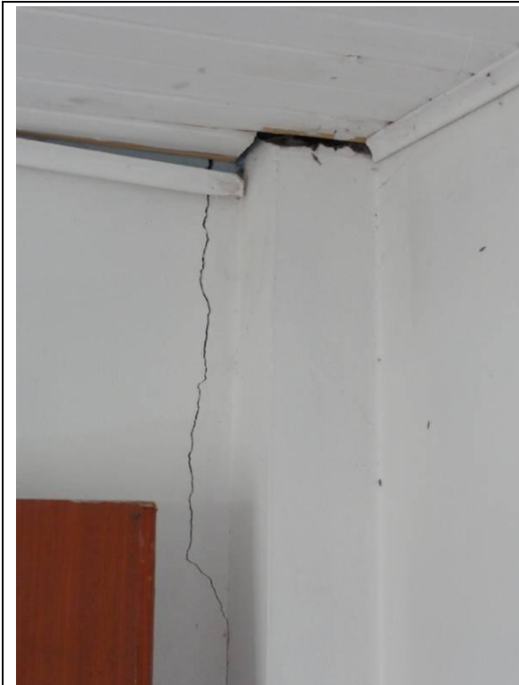
Quarto 3 – Parede 14(DSC03793, 23/02/2011, 10:29h)
