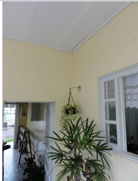
Garagem (DSC04239, 23/02/2011, 17:05h)
