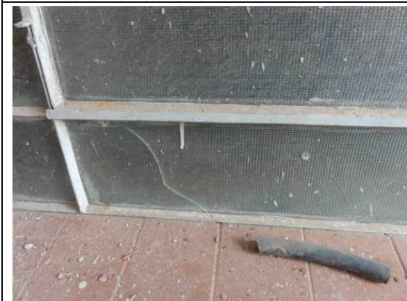
Lateral Direita – Parede D (DSC04722, 24/02/2011, 11:09h)
