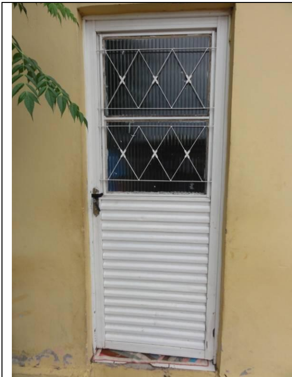
Fachada (DSC03737, 23/02/2011, 10:21h)
