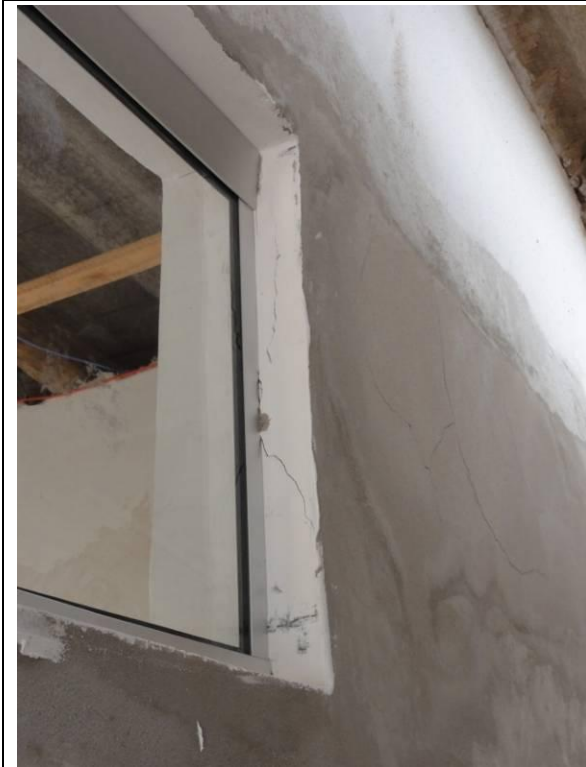
Lateral Direita – Parede D (DSC04724, 24/02/2011, 11:10h)
