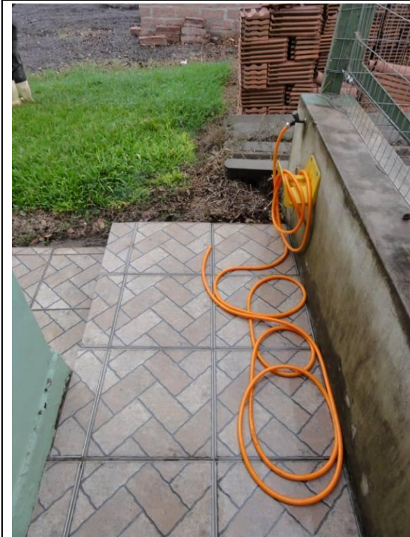
Lateral Direita – Parede D (DSC04166, 23/02/2011, 16:50h)
