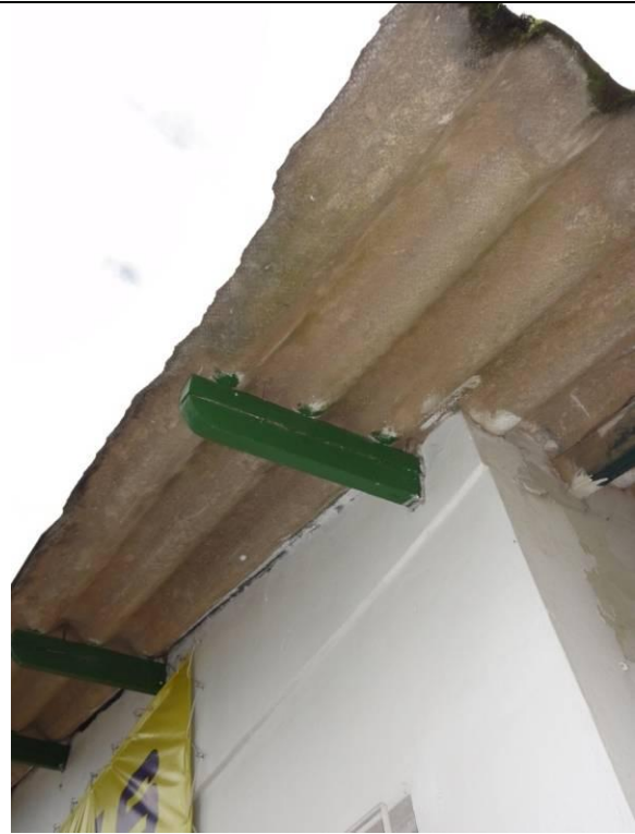
Fachada - Marquise (DSC04336, 24/02/2011, 09:14h)
