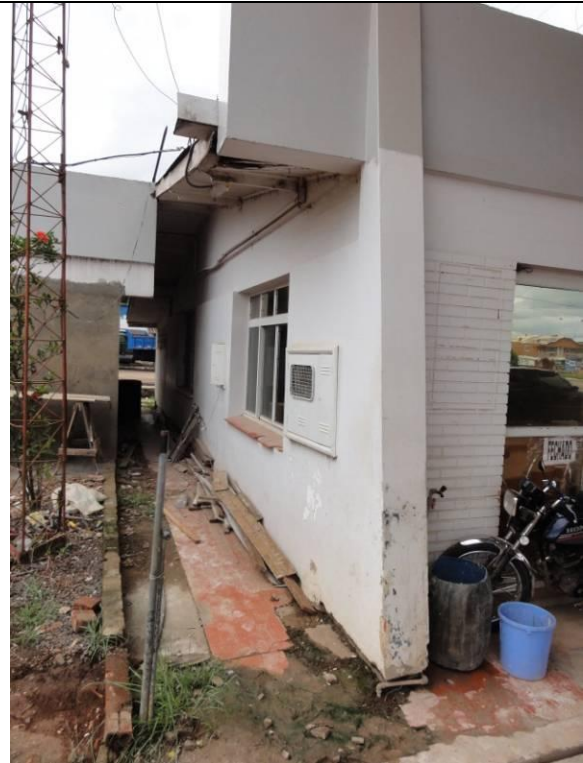
Lateral Direita – Parede D (DSC04711, 24/02/2011, 11:07h)
