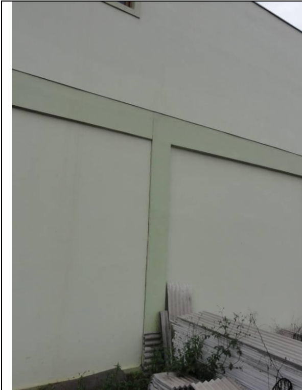
Lateral Direito – Parede D (DSC04062, 23/02/2011, 16:14h)
