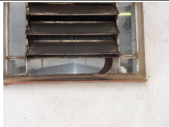
Lateral Esquerda- Parede B (DSC04755, 24/02/2011, 11:13h)
