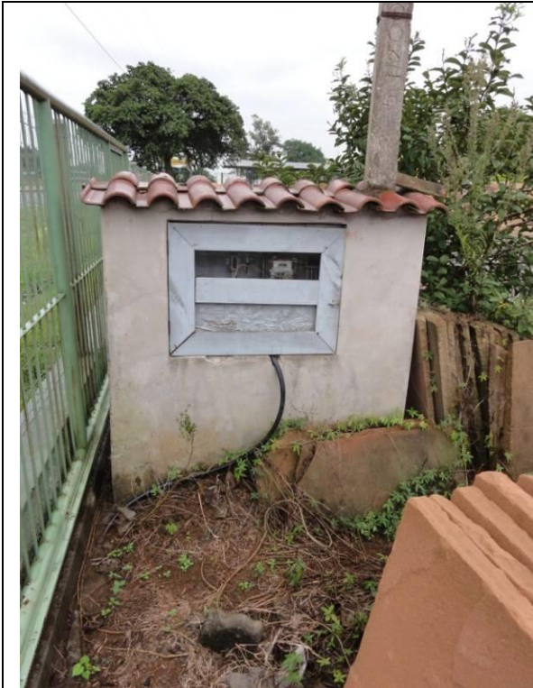
Muro com caixa de luz (DSC04086, 23/02/2011, 16:30h)
