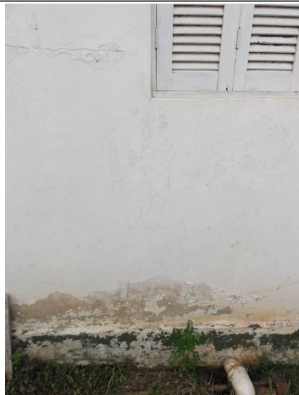
Lateral Direito – Parede D (DSC04406, 24/02/2011, 09:25h)
