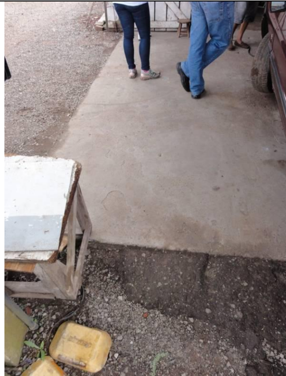
Fachada –Piso de concreto (DSC03627, 23/02/2011, 09:52h)
