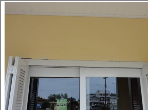
Casa - Varanda (DSC04156, 23/02/2011, 16:48h)
