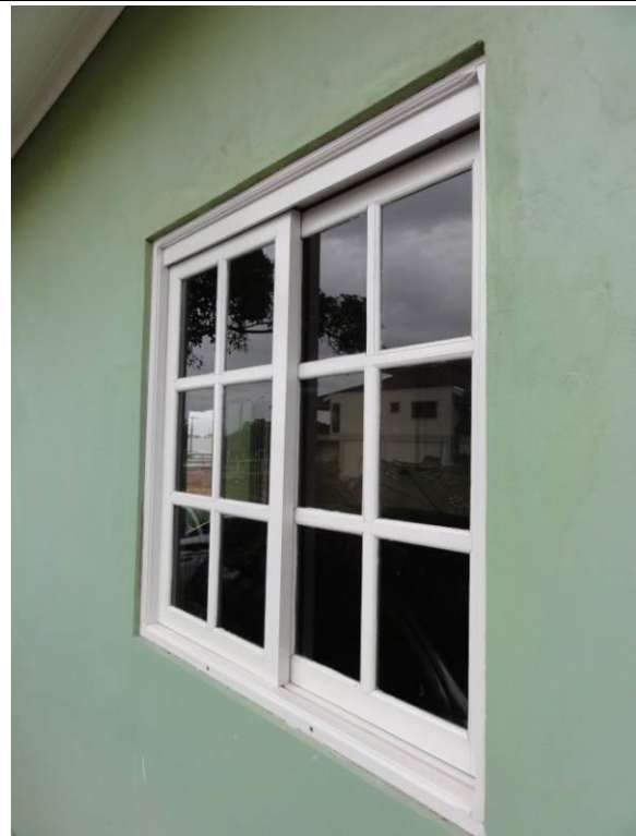
Lateral Esquerda – Parede B (DSC04187, 23/02/2011, 16:53h)
