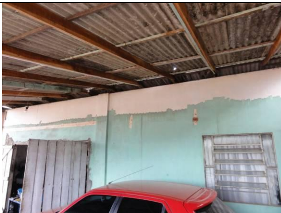
Fachada – Cobertura com telhas de fibrocimento (DSC03618, 23/02/2011, 09:51h)
