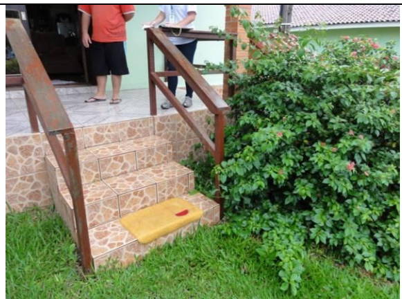
Fachada (DSC04246, 23/02/2011, 17:15h)
