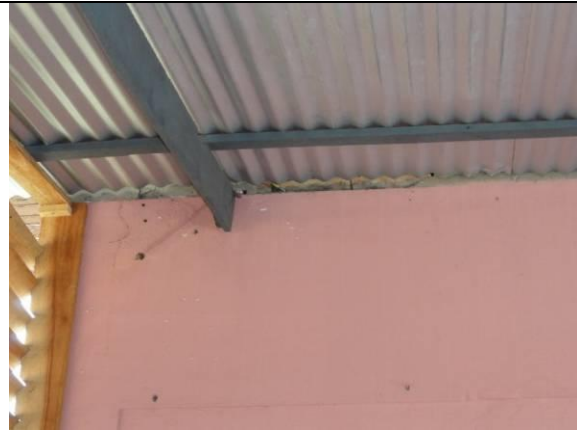
Fachada - Entrada (DSC04492, 24/02/2011, 09:47h)
