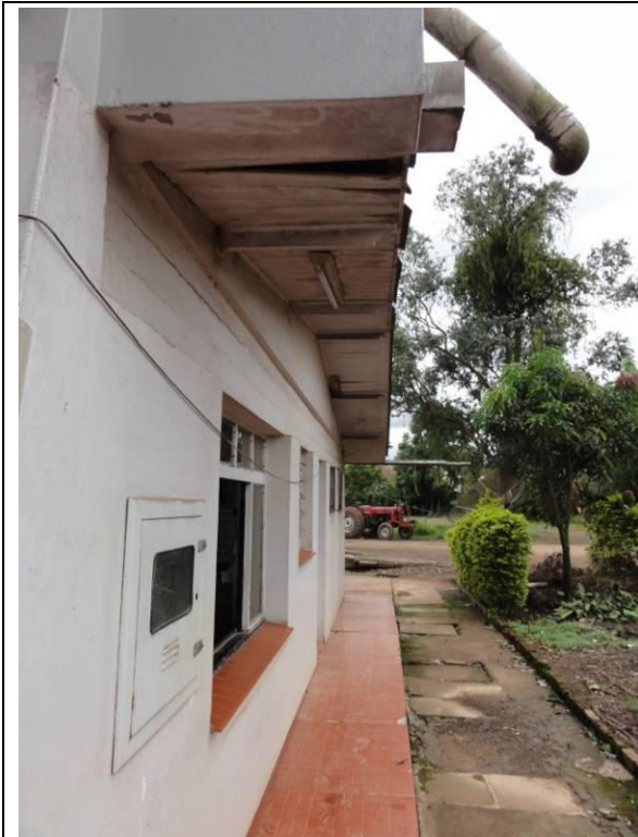
Lateral Esquerda- Parede B (DSC04772, 24/02/2011, 11:15h)
