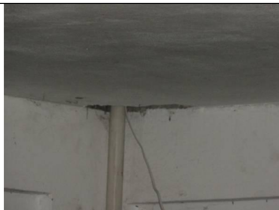
Piso Inferior – Loja (DSC03894, 23/02/2011, 11:06h)
