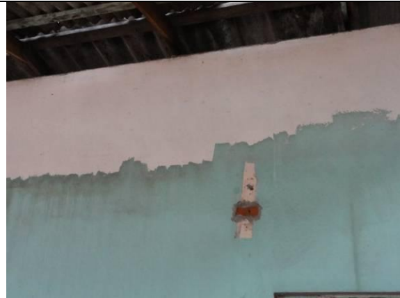
Fachada (DSC03621, 23/02/2011, 09:52h)
