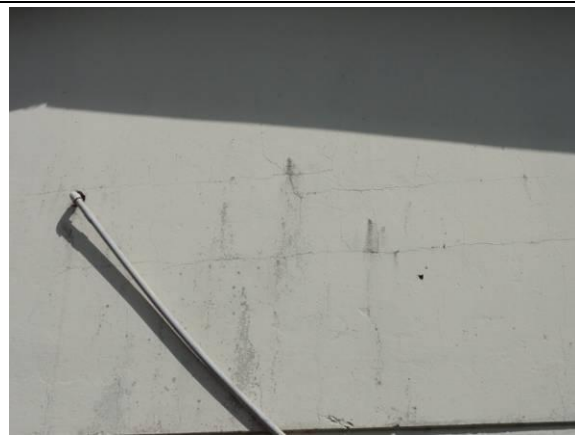
Lateral Direita – Parede D (DSC04572, 24/02/2011, 10:04h)
