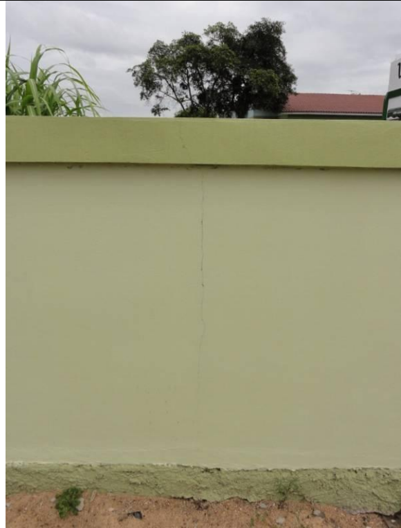
Muro (DSC03910, 23/02/2011, 11:09h)
