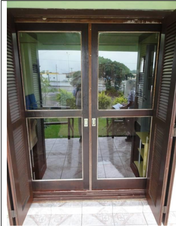
Fachada (DSC04247, 23/02/2011, 17:15h)
