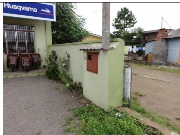
Fachada (DSC03820, 23/02/2011, 10:53h)
