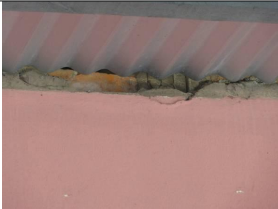
Fachada - Entrada (DSC04491, 24/02/2011, 09:47h)
