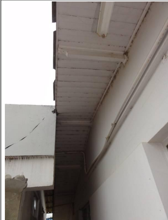
Lateral Direita – Parede D (DSC04718, 24/02/2011, 11:09h)
