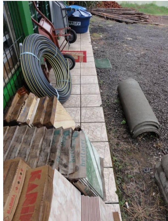
Fachada - Calçada de piso cerâmico (DSC04095, 23/02/2011, 16:32h)
