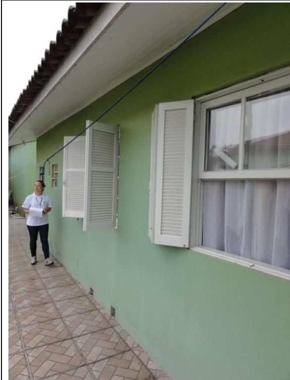
Lateral Direita – Parede D (DSC04168, 23/02/2011, 16:50h)
