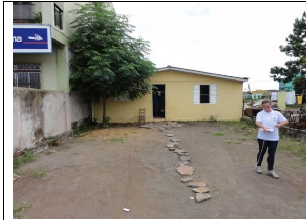
Fachada (DSC03721, 23/02/2011, 10:19h)
