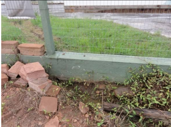
Fachada - Portão (DSC04088, 23/02/2011, 16:31h)
