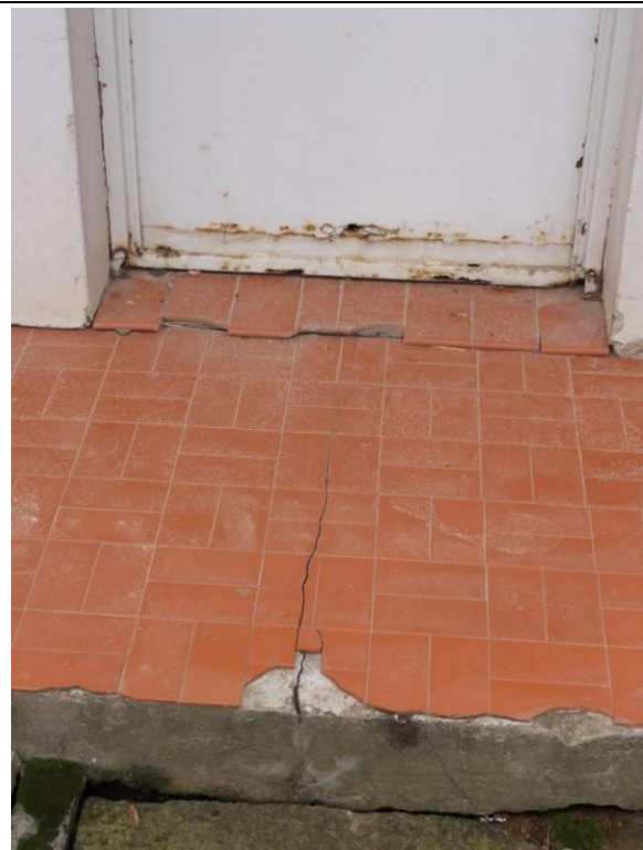
Lateral Esquerda- Parede B (DSC04757, 24/02/2011, 11:14h)
