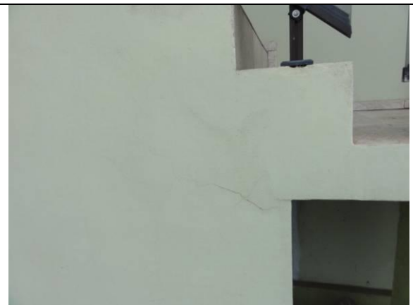
Escada (DSC03840, 23/02/2011, 10:55h)
