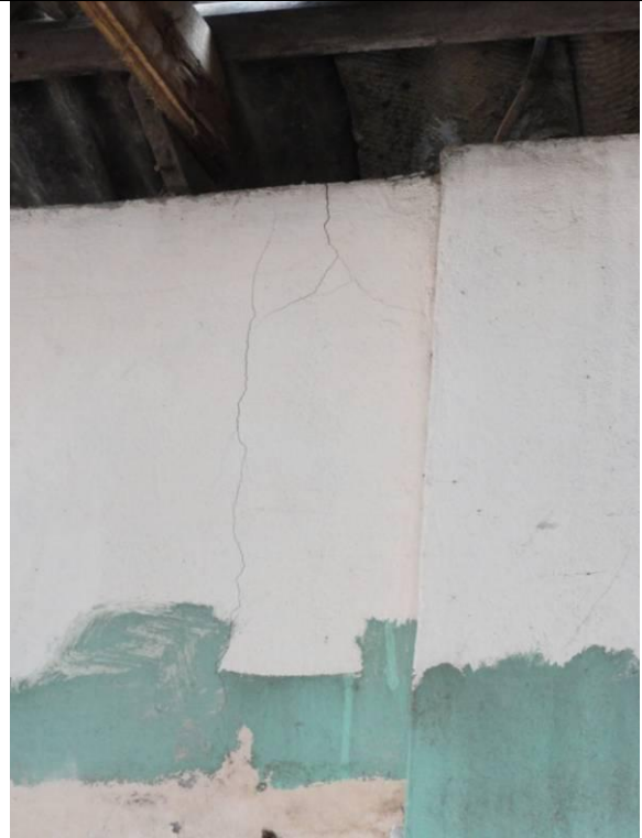
Fachada (DSC03625, 23/02/2011, 09:52h)
