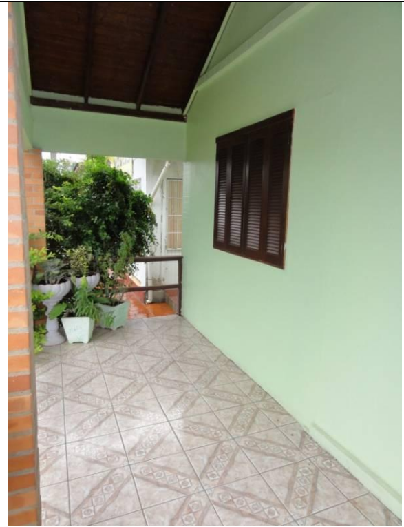
Fachada - Area (DSC04248, 23/02/2011, 17:15h)
