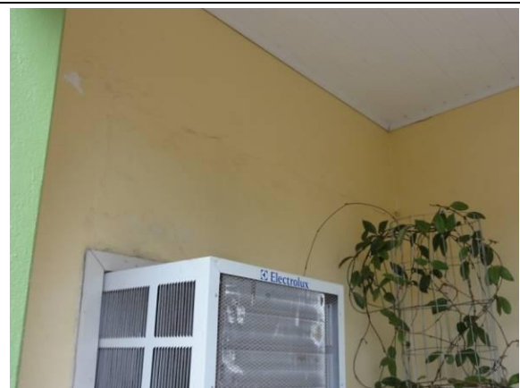
Casa - Varanda (DSC04157, 23/02/2011, 16:48h)
