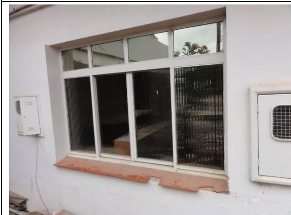
Lateral Direita – Parede D (DSC04716, 24/02/2011, 11:08h)
