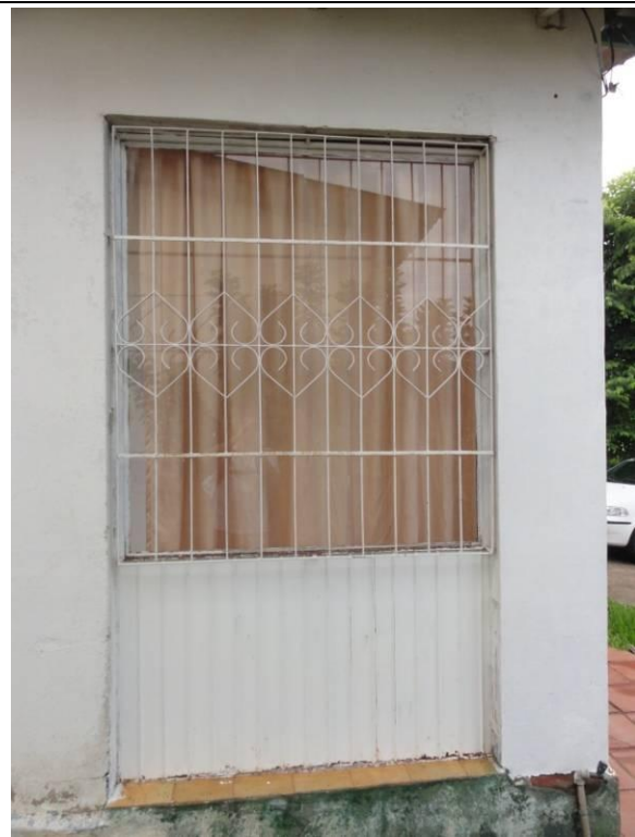
Lateral Direito – Parede D (DSC04382, 24/02/2011, 09:22h)
