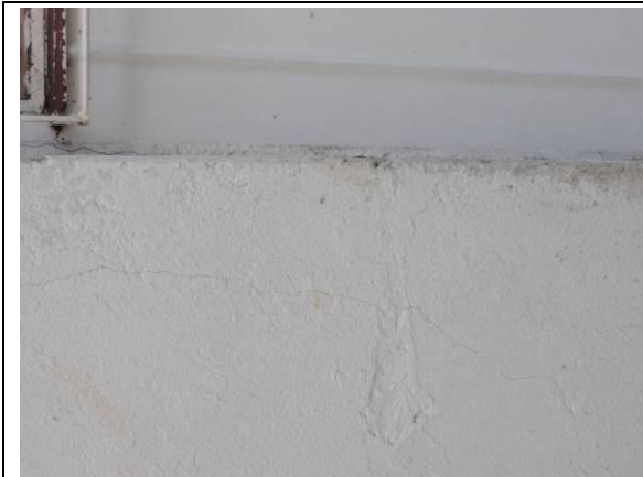
Lateral Direito – Parede D (DSC04395, 24/02/2011, 09:23h)
