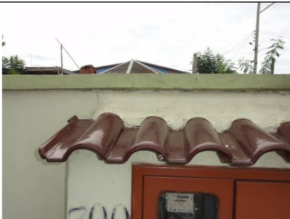
Fachada – Muro com caixa de luz (DSC03825, 23/02/2011, 10:53h)
