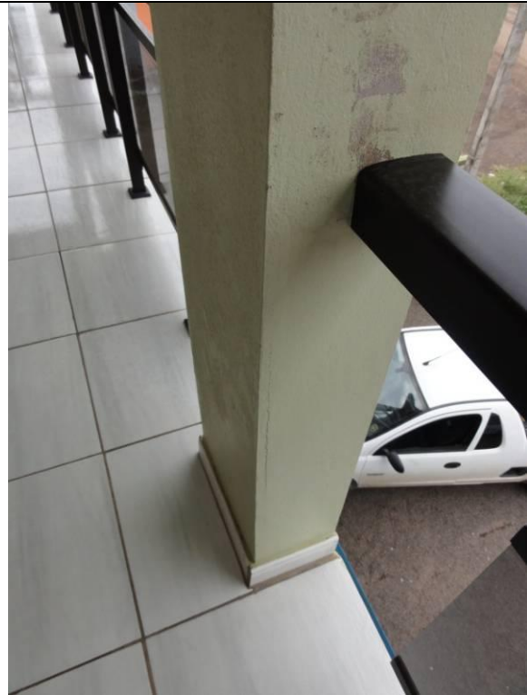
Piso Superior - Sacada (DSC03966, 23/02/2011, 11:18h)
