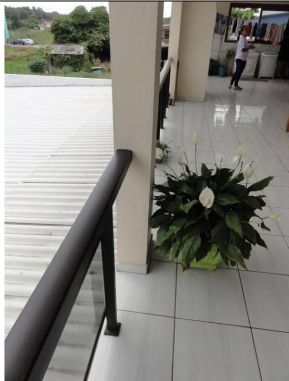
Piso Superior – Area – Vista para fundos (DSC03988, 23/02/2011, 11:22h)
