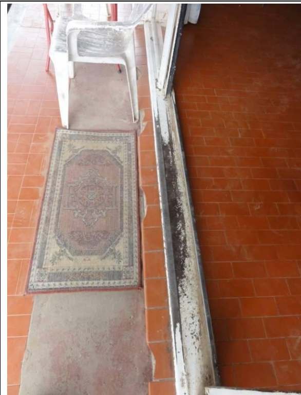
Entrada (DSC04775, 24/02/2011, 11:16h)
