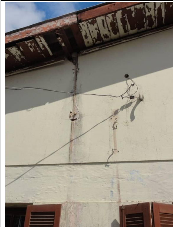
Lateral Direita – Parede D (DSC04560, 24/02/2011, 10:03h)
