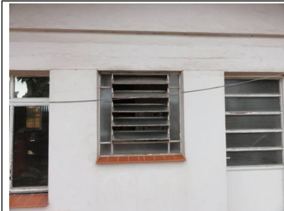
Lateral Esquerda- Parede B (DSC04760, 24/02/2011, 11:14h)
