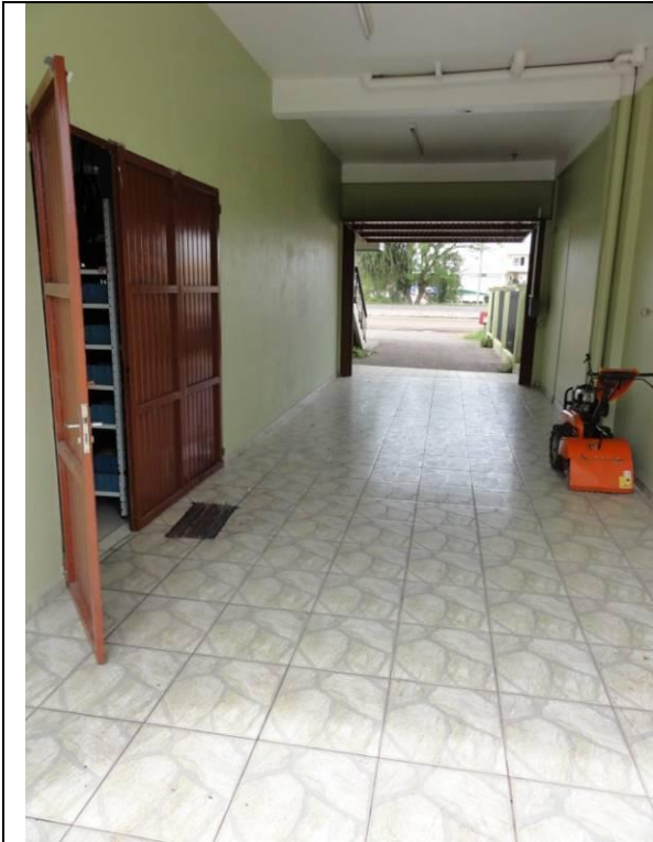
Fundos - Garagem (DSC03897, 23/02/2011, 11:06h)
