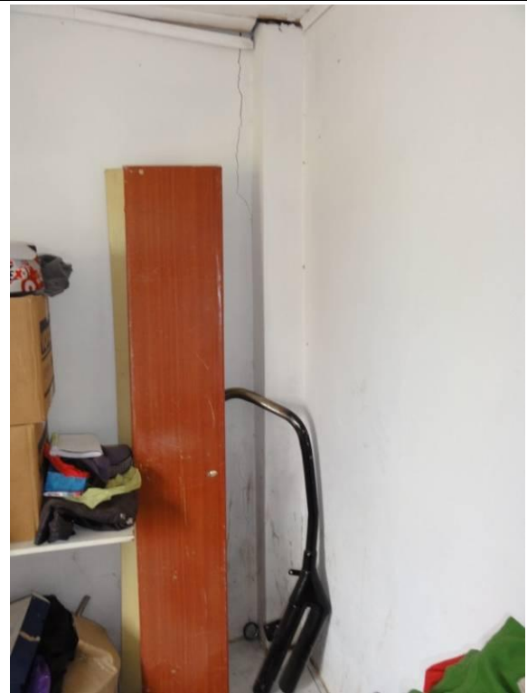
Quarto 3 – Parede 14(DSC03792, 23/02/2011, 10:28h)
