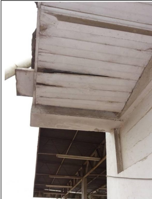
Lateral Esquerda- Parede B (DSC04770, 24/02/2011, 11:15h)
