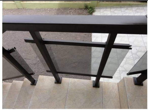
Escada (DSC03924, 23/02/2011, 11:13h)
