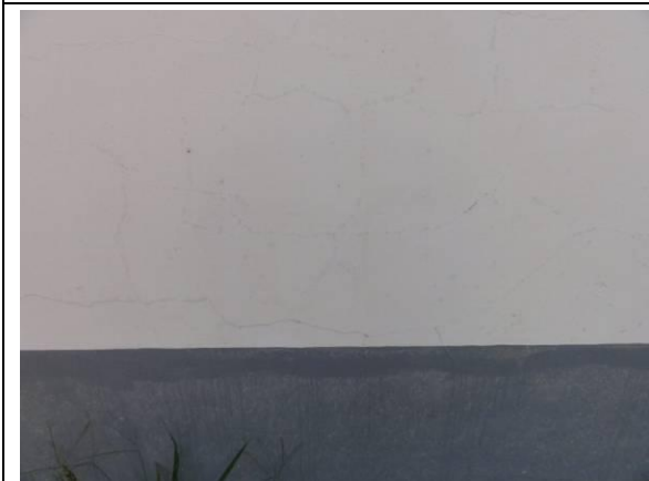
Lateral Esquerda - Parede (DSC04532, 24/02/2011, 09:54h)
