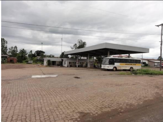
Fachada (DSC04687, 24/02/2011, 11:02h)
