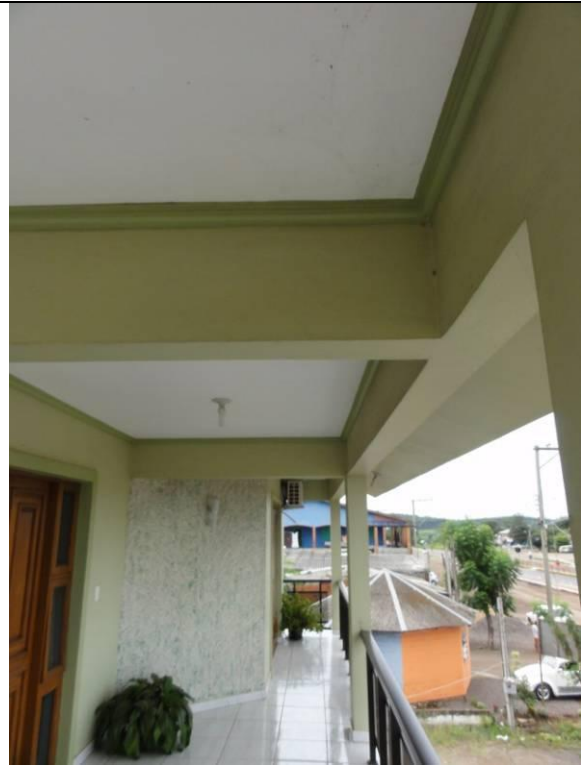
Piso Superior - Sacada (DSC03948, 23/02/2011, 11:15h)
