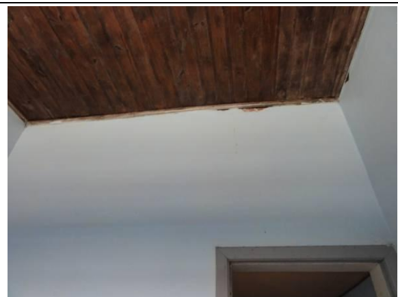
WC 1 e WC 2 (DSC04606, 24/02/2011, 10:10h)
