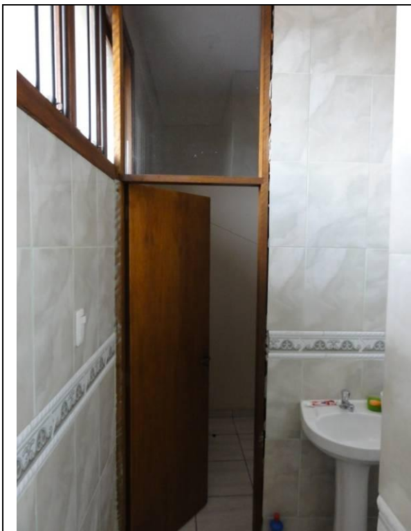
3º Piso – Quarto 2 - WC (DSC04031, 23/02/2011, 11:29h)
