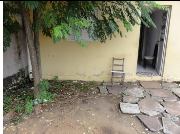
Fachada (DSC03722, 23/02/2011, 10:19h)
