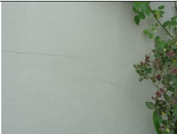
Fachada – Muro (DSC03829, 23/02/2011, 10:54h)
