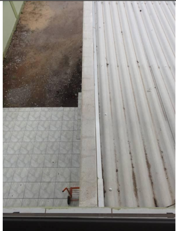
Piso Superior – Area – Vista para fundos (DSC03984, 23/02/2011, 11:22h)
