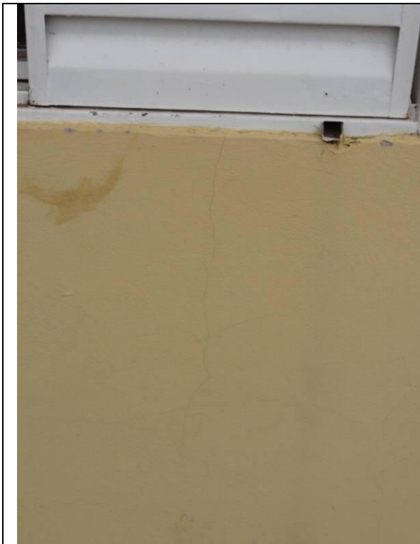
Fachada (DSC03735, 23/02/2011, 10:21h)
