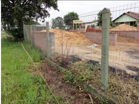
Fachada - Portão (DSC04082, 23/02/2011, 16:29h)
