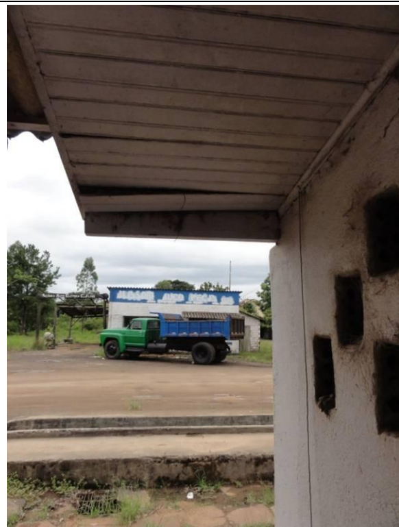
Lateral Direita – Parede D (DSC04735, 24/02/2011, 11:11h)
