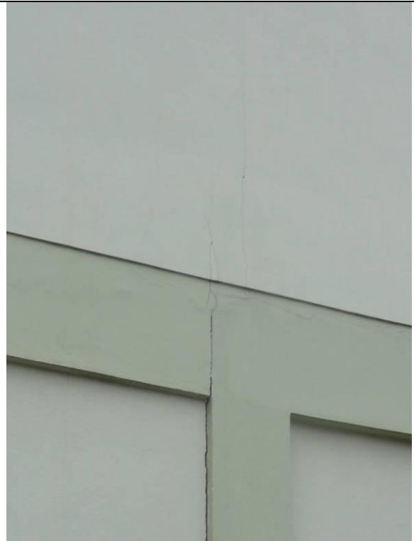
Lateral Direito – Parede D (DSC04063, 23/02/2011, 16:15h)
