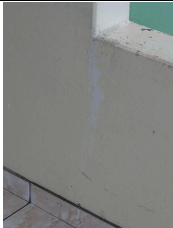
Casa - Varanda (DSC04155, 23/02/2011, 16:48h)
