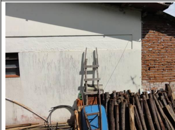
Lateral Direita – Parede D (DSC04565, 24/02/2011, 10:03h)
