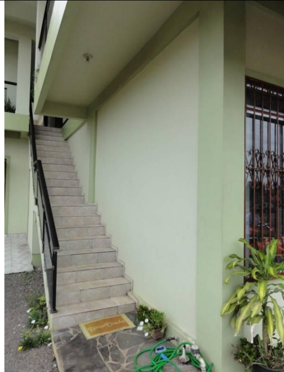
Escada lateral (DSC03836, 23/02/2011, 10:55h)
