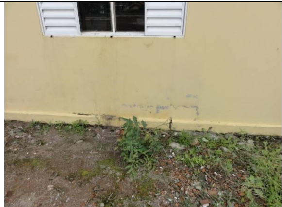
Fachada (DSC03732, 23/02/2011, 10:20h)
