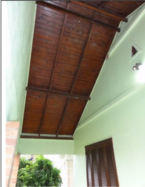
Fachada – Area - Teto (DSC04249, 23/02/2011, 17:15h)
