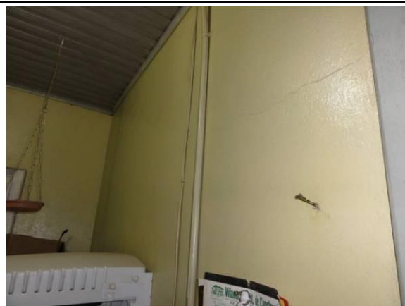
Area de Serviço (DSC04304, 23/02/2011, 17:26h)
