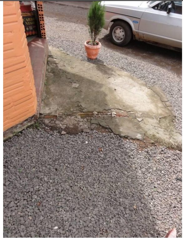
Fachada - Calçada (DSC03703, 23/02/2011, 10:09h)
