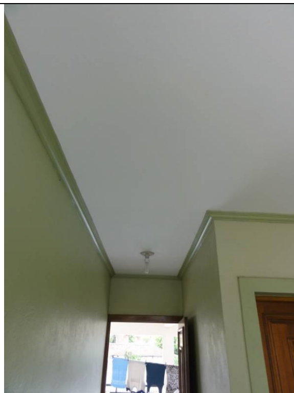
Piso Superior - Sacada (DSC03938, 23/02/2011, 11:14h)
