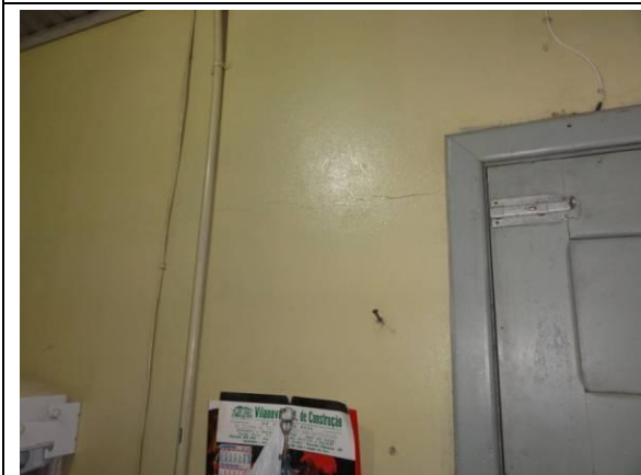
Area de Serviço (DSC04303, 23/02/2011, 17:26h)
