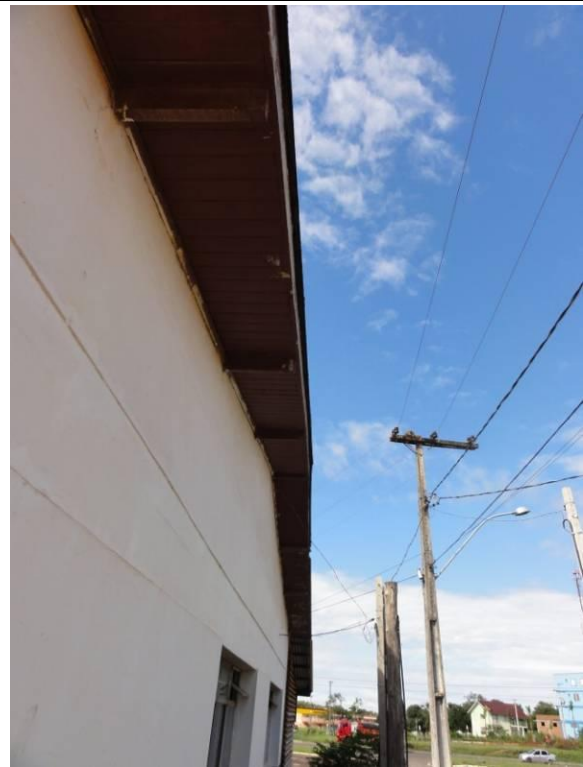
Lateral Esquerda - Parede (DSC04535, 24/02/2011, 09:55h)
