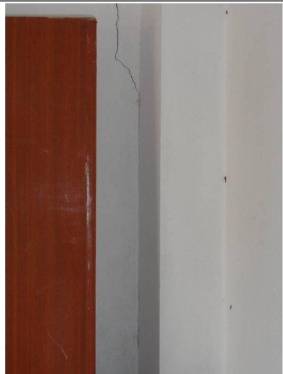
Quarto 3 – Parede 14(DSC03794, 23/02/2011, 10:29h)
