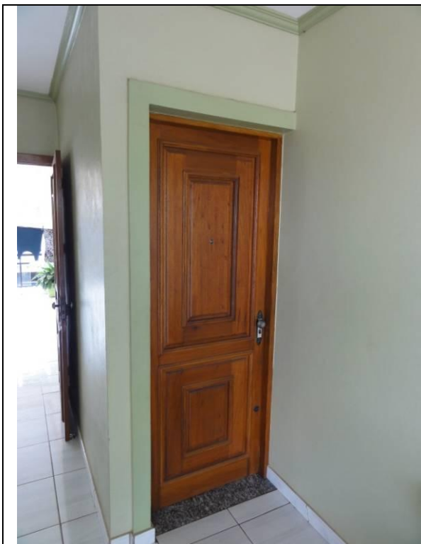
Piso Superior - Sacada (DSC03937, 23/02/2011, 11:14h)
