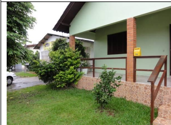
Fachada (DSC04245, 23/02/2011, 17:15h)
