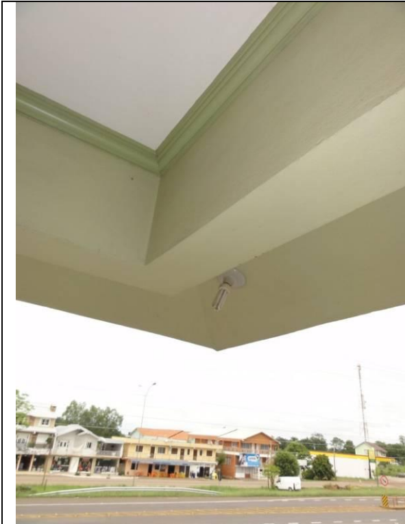
Piso Superior - Sacada (DSC03947, 23/02/2011, 11:15h)
