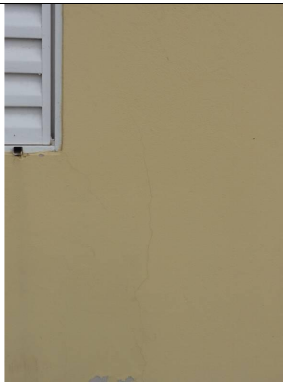
Fachada (DSC03734, 23/02/2011, 10:21h)
