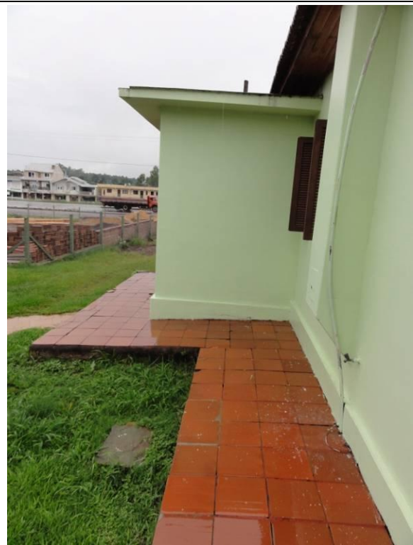
Lateral Esquerda – Parede B (DSC04274, 23/02/2011, 17:19h)
