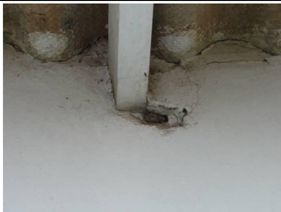
Lateral Direito – Parede D (DSC04415, 24/02/2011, 09:26h)
