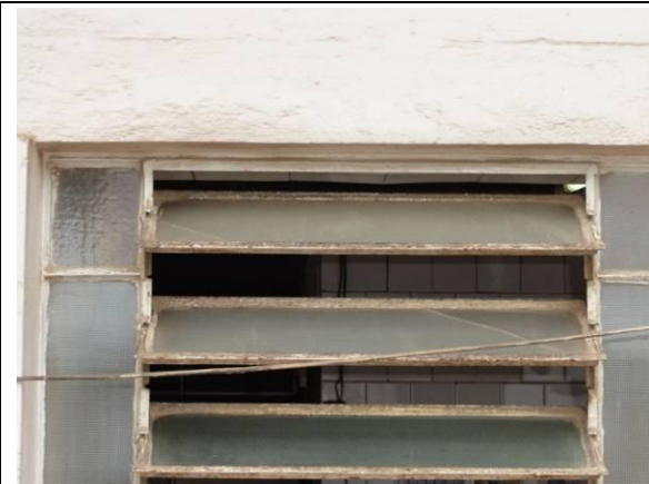
Lateral Esquerda- Parede B (DSC04761, 24/02/2011, 11:14h)
