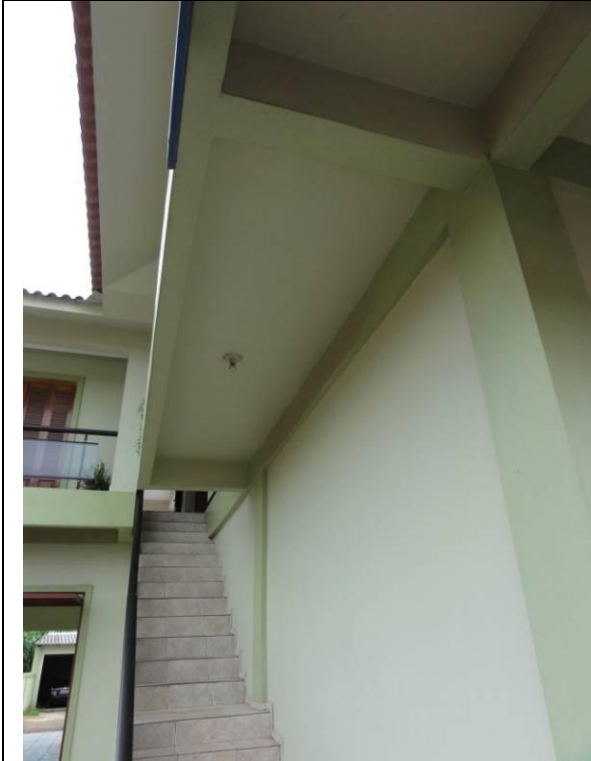
Escada (DSC03843, 23/02/2011, 10:56h)
