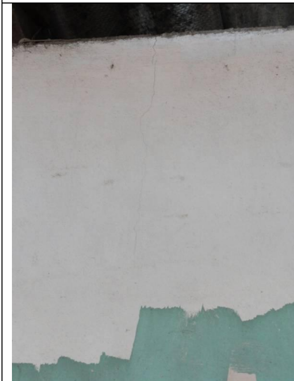
Fachada (DSC03622, 23/02/2011, 09:52h)
