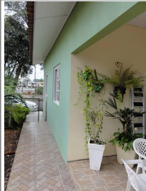
Lateral Esquerda – Parede B (DSC04186, 23/02/2011, 16:53h)
