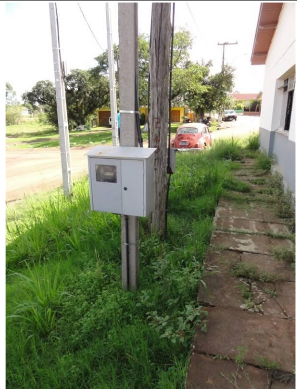
Lateral Direita – Parede D (DSC04496, 24/02/2011, 09:48h)
