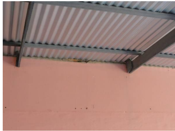
Fachada - Entrada (DSC04490, 24/02/2011, 09:47h)
