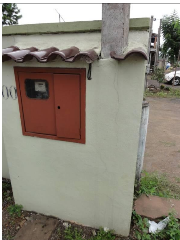
Fachada – Muro com caixa de luz (DSC03822, 23/02/2011, 10:53h)
