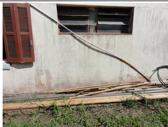
Lateral Direita – Parede D (DSC04563, 24/02/2011, 10:03h)
