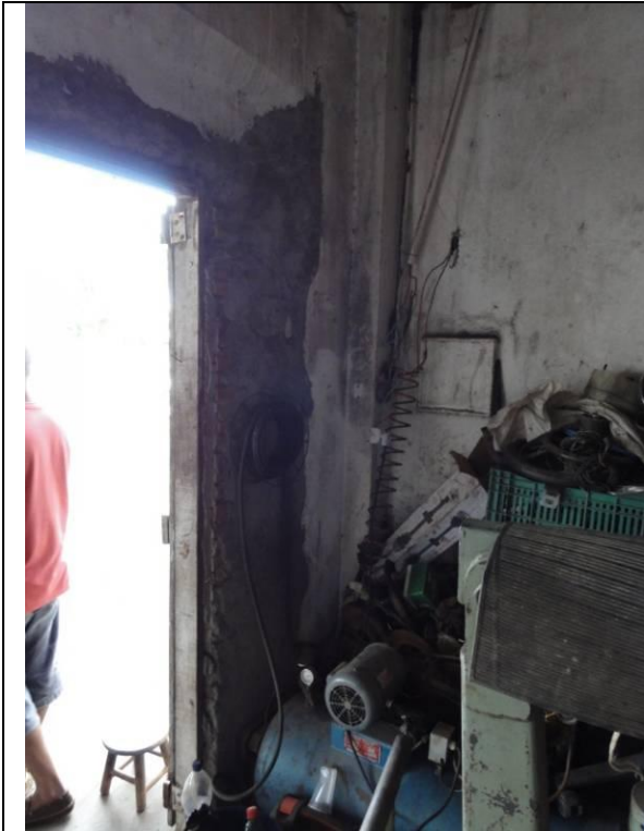
Sala 1 Mecânica (DSC03642, 23/02/2011, 09:54h)
