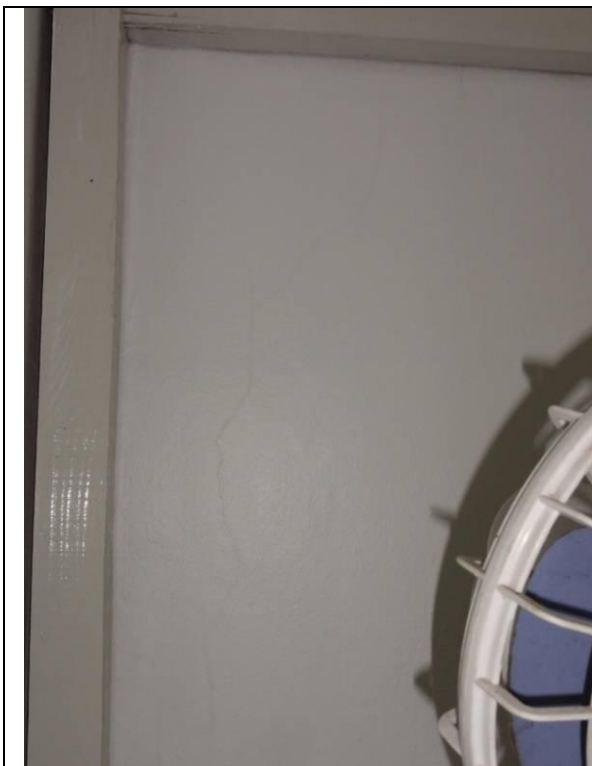
Piso Inferior – Loja – Sala 1 (DSC03871, 23/02/2011, 11:01h)
