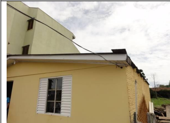
Fachada (DSC03731, 23/02/2011, 10:20h)
