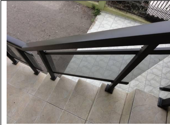
Escada (DSC03923, 23/02/2011, 11:13h)
