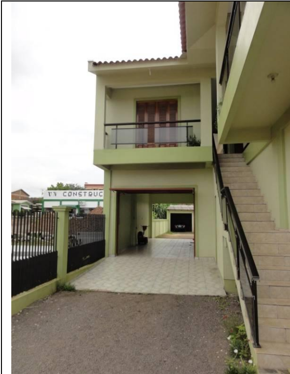
Fachada – Garagem (DSC03837, 23/02/2011, 10:55h)
