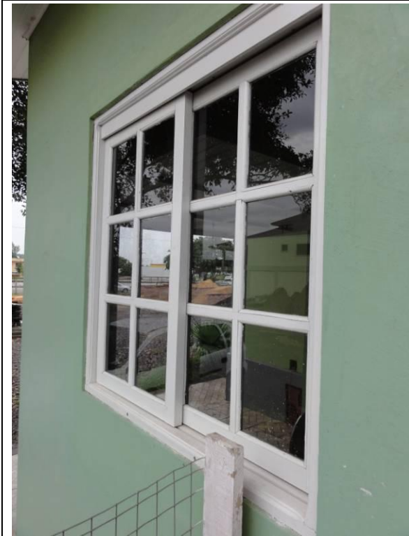
Lateral Esquerda – Parede B (DSC04188, 23/02/2011, 16:53h)
