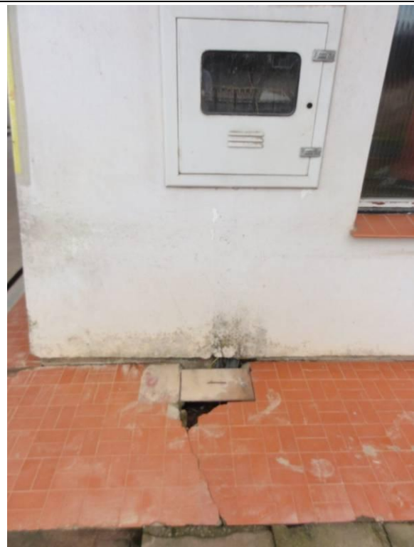
Lateral Esquerda- Parede B (DSC04771, 24/02/2011, 11:15h)
