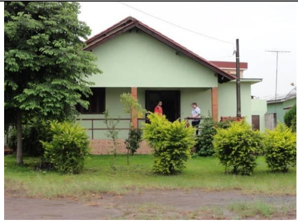
Fachada (DSC04244, 23/02/2011, 17:14h)
