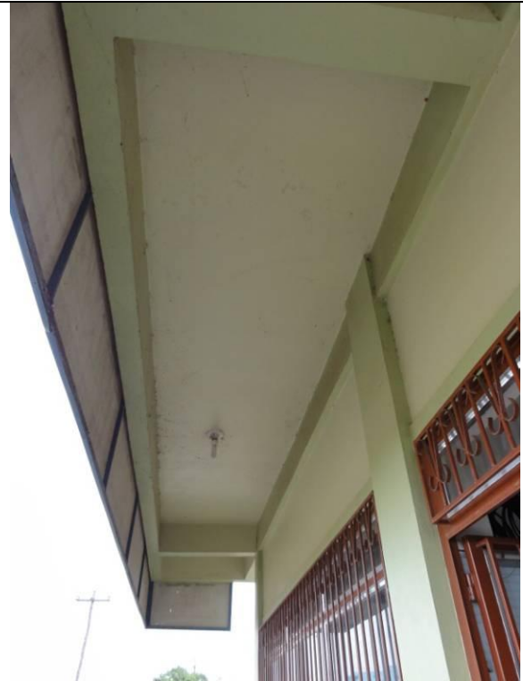
Fachada – Marquise (DSC03834, 23/02/2011, 10:54h)
