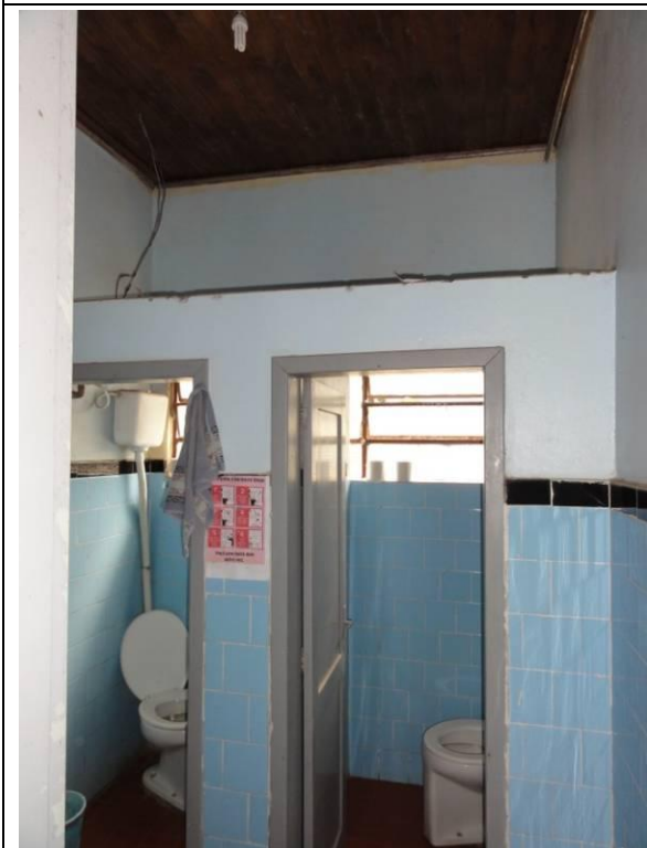
WC 1 e WC 2 (DSC04609, 24/02/2011, 10:10h)
