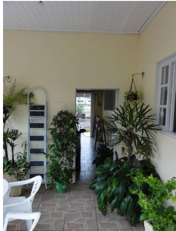
Lateral Esquerda – Parede B (DSC04185, 23/02/2011, 16:53h)
