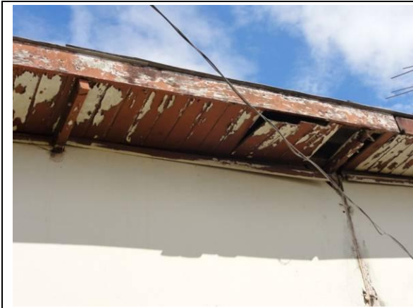
Lateral Direita – Parede D (DSC04556, 24/02/2011, 10:02h)
