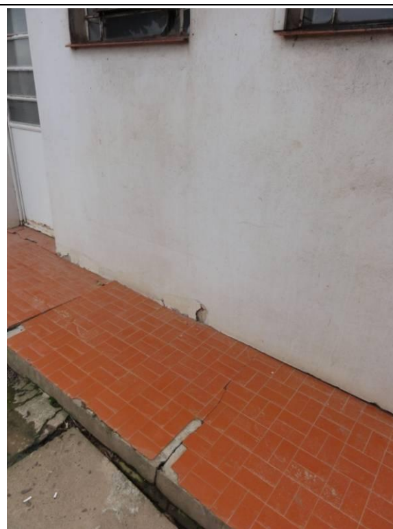
Lateral Esquerda- Parede B (DSC04751, 24/02/2011, 11:13h)
