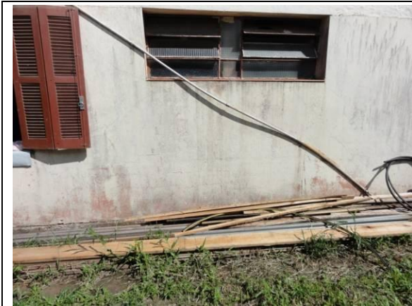
Lateral Direita – Parede D (DSC04563, 24/02/2011, 10:03h)
