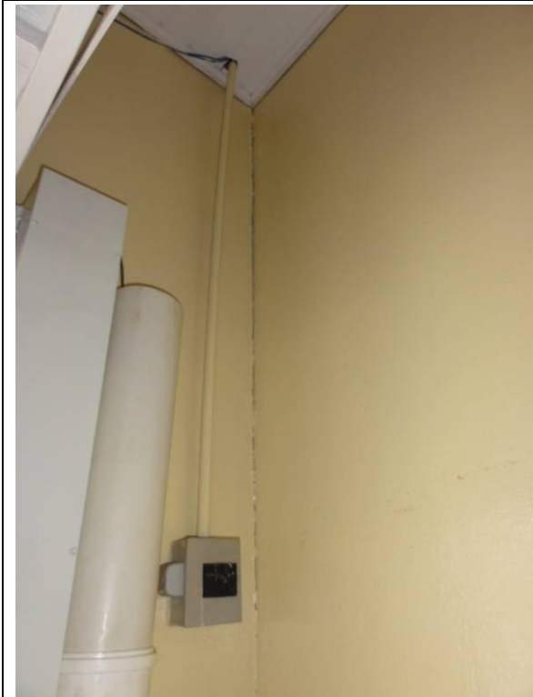
Garagem (DSC04236, 23/02/2011, 17:04h)
