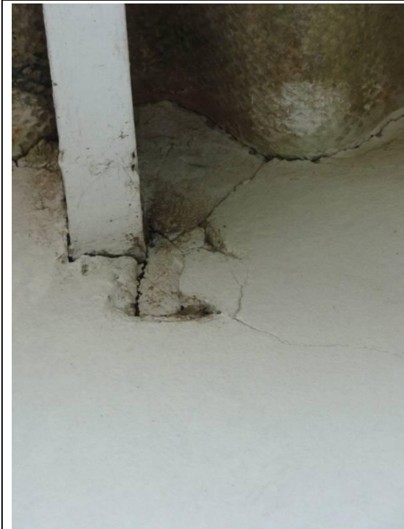
Lateral Direito – Parede D (DSC04389, 24/02/2011, 09:23h)
