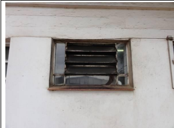
Lateral Esquerda- Parede B (DSC04754, 24/02/2011, 11:13h)
