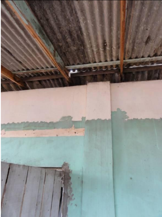
Fachada – Cobertura com telhas de fibrocimento (DSC03624, 23/02/2011, 09:52h)
