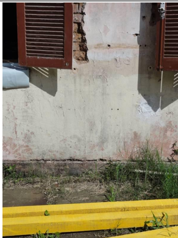
Lateral Direita – Parede D (DSC04574, 24/02/2011, 10:04h)
