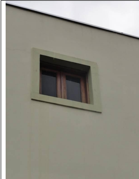
Lateral Direito – Parede D (DSC04064, 23/02/2011, 16:15h)
