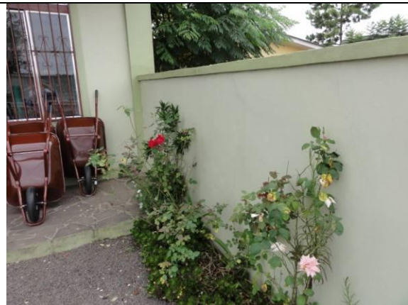
Fachada – Muro (DSC03826, 23/02/2011, 10:53h)
