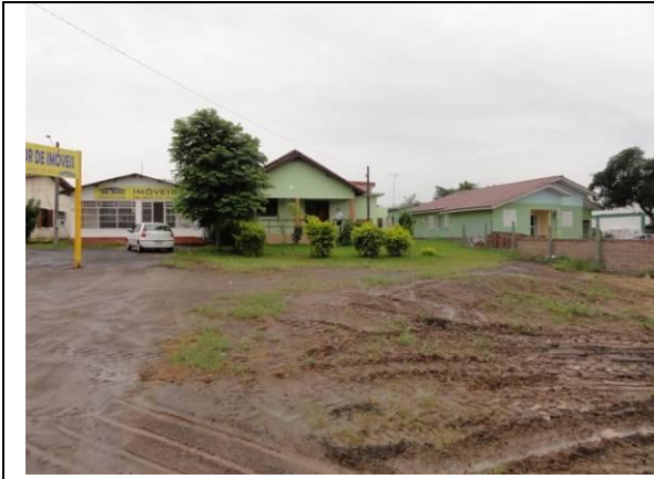
Fachada (DSC04243, 23/02/2011, 17:14h)
