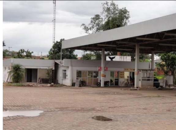
Fachada (DSC04688, 24/02/2011, 11:03h)
