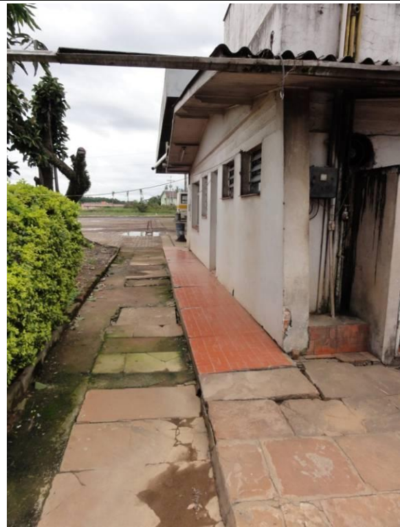
Lateral Esquerda- Parede B (DSC04749, 24/02/2011, 11:13h)
