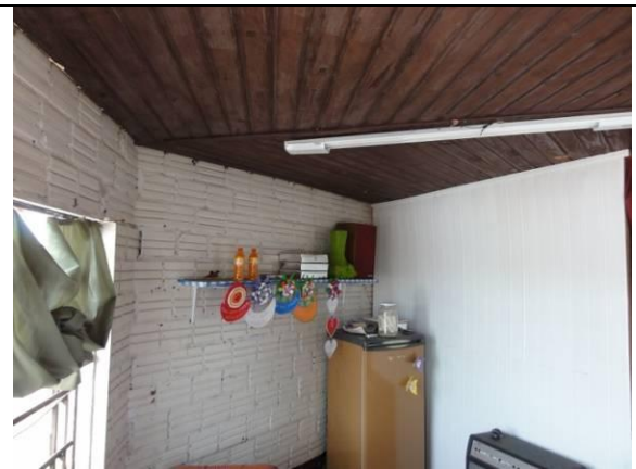
Sala – Teto com forro de madeira (DSC03705, 23/02/2011, 10:09h)
