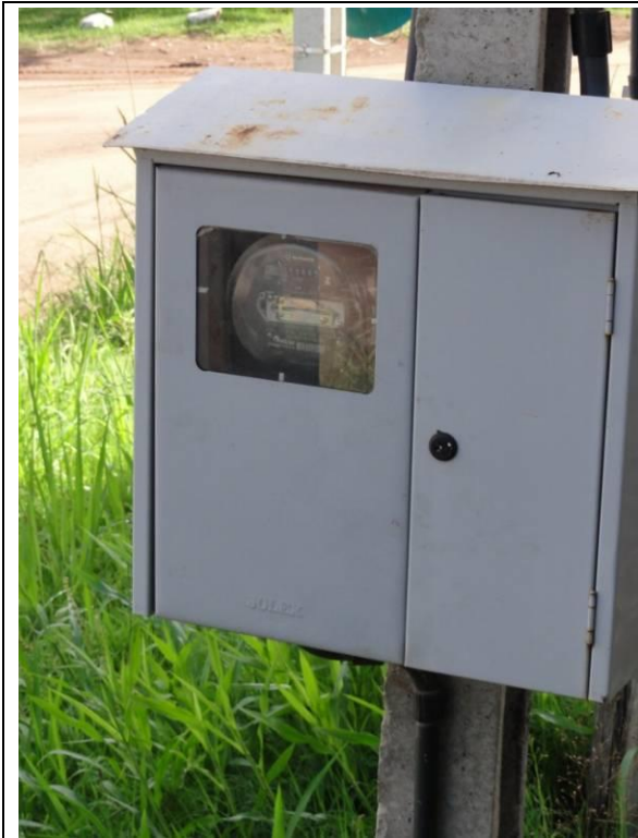
Caixa de luz (DSC04497, 24/02/2011, 09:49h)
