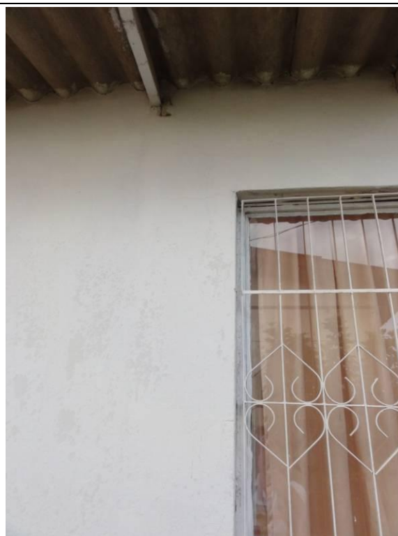
Lateral Direito – Parede D (DSC04388, 24/02/2011, 09:23h)
