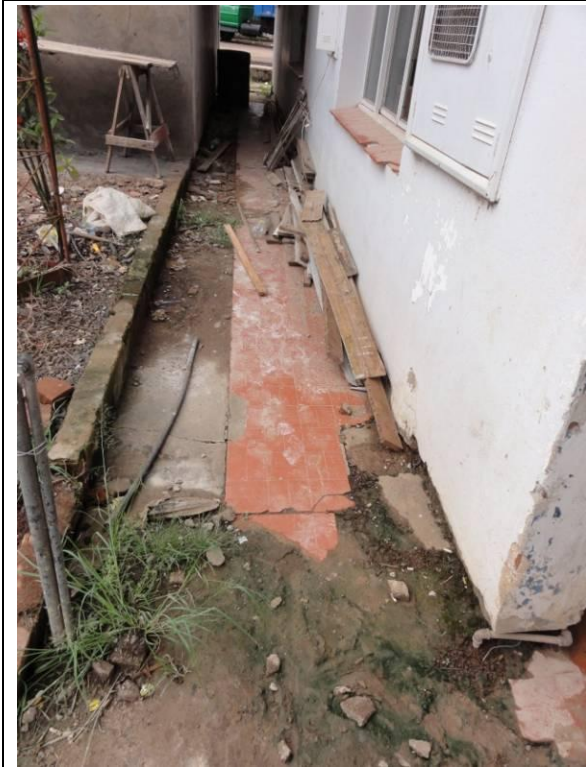
Lateral Direita – Parede D (DSC04712, 24/02/2011, 11:07h)
