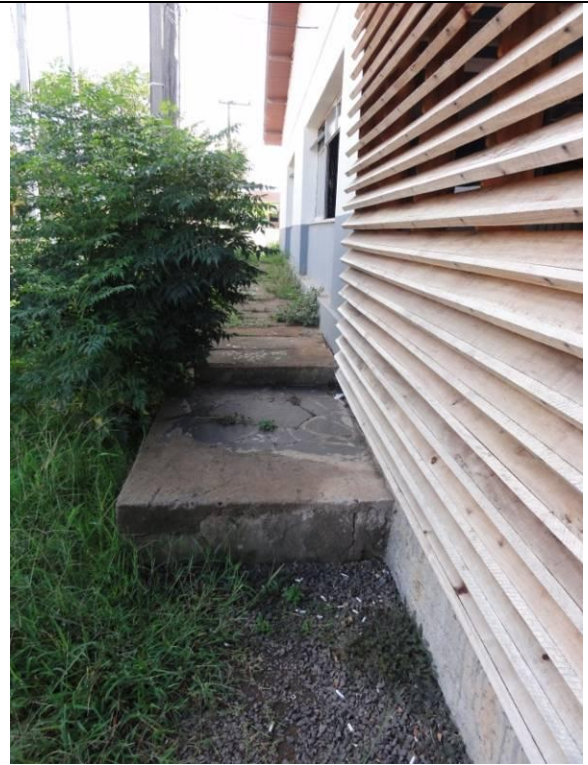
Lateral Direita – Parede D (DSC04494, 24/02/2011, 09:48h)
