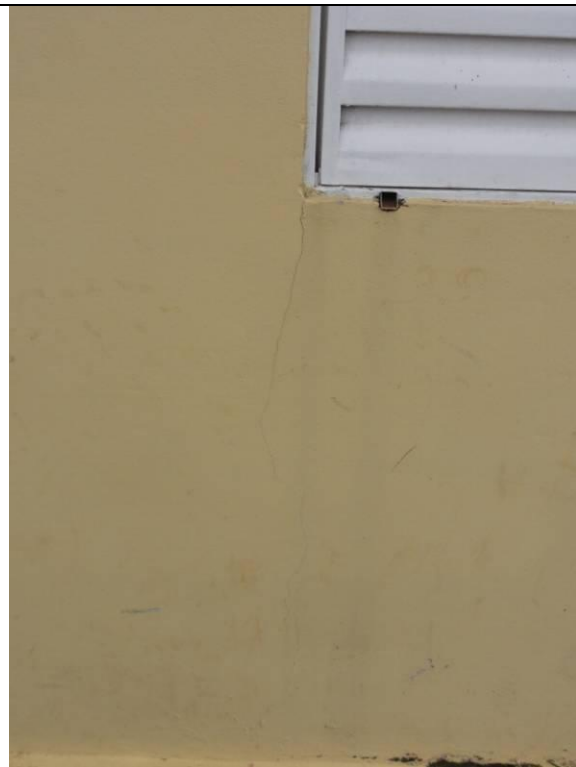
Fachada (DSC03728, 23/02/2011, 10:20h)
