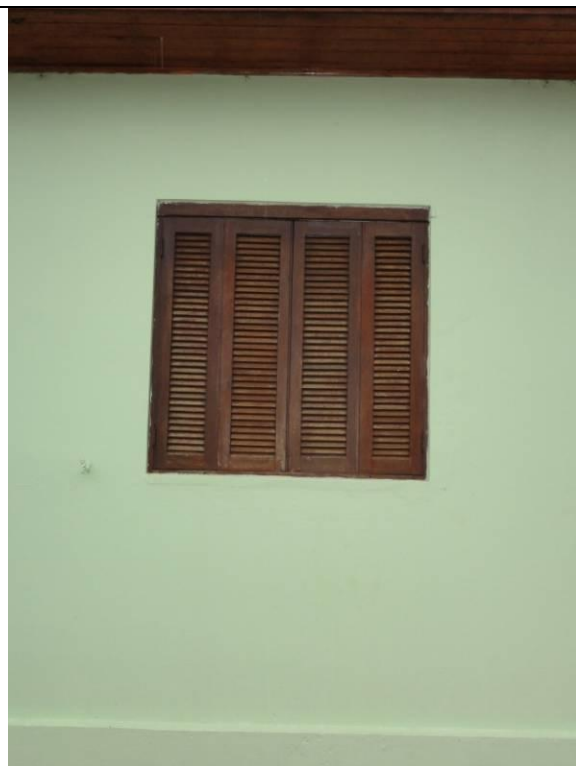
Lateral Esquerda – Parede B (DSC04264, 23/02/2011, 17:18h)
