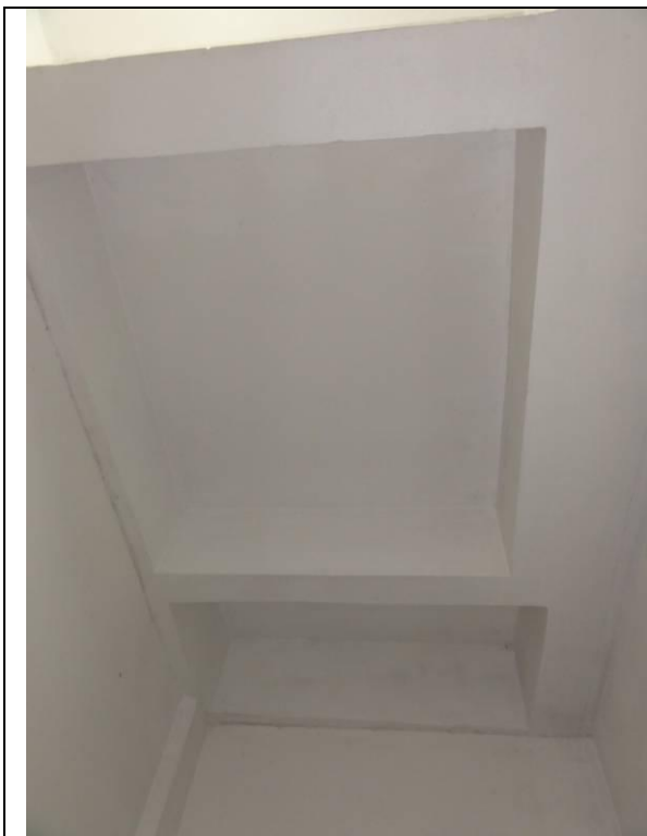
Piso Inferior – Loja (DSC03889, 23/02/2011, 11:04h)
