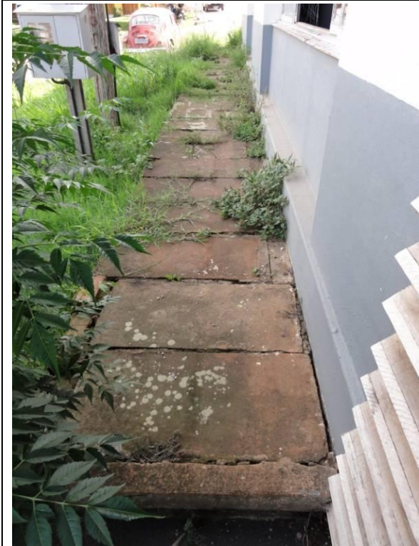
Lateral Direita – Parede D (DSC04495, 24/02/2011, 09:48h)
