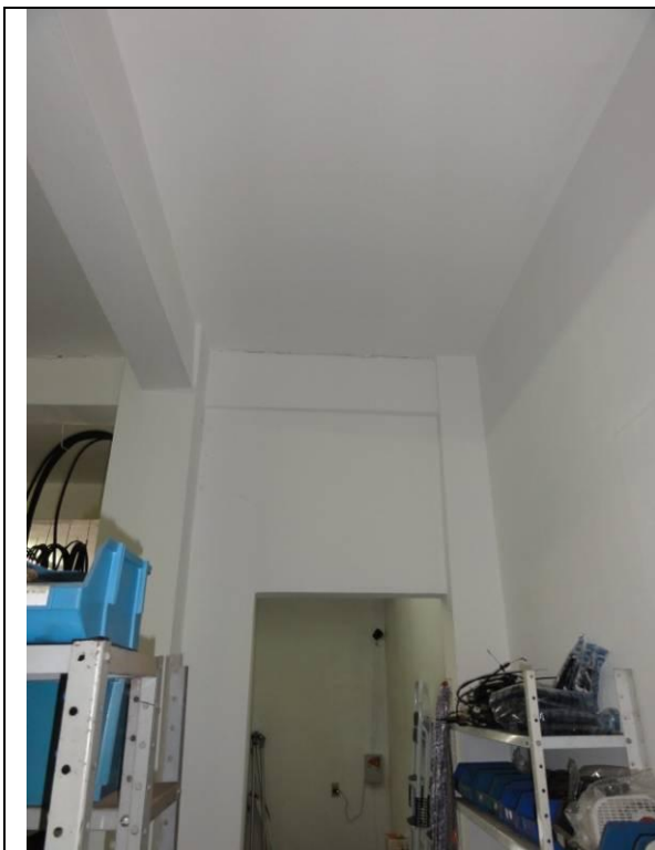
Piso Inferior – Loja (DSC03885, 23/02/2011, 11:04h)
