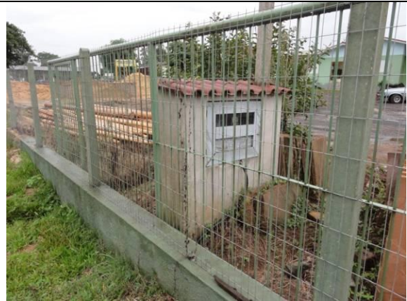
Fachada - Portão (DSC04077, 23/02/2011, 16:28h)
