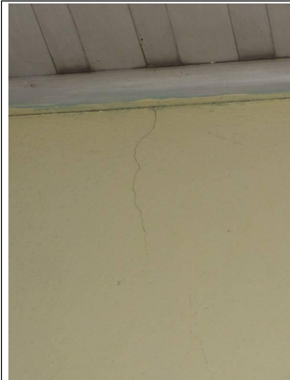
Area de Serviço (DSC04301, 23/02/2011, 17:26h)
