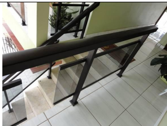
Piso Superior - Sacada (DSC03944, 23/02/2011, 11:15h)
