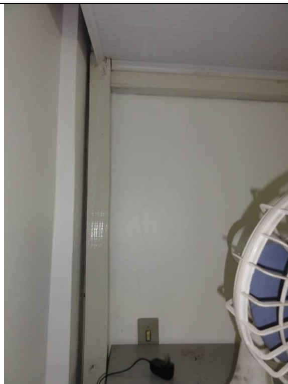
Piso Inferior – Loja – Sala 1 (DSC03870, 23/02/2011, 11:01h)
