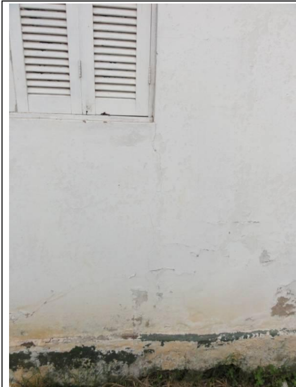
Lateral Direito – Parede D (DSC04403, 24/02/2011, 09:24h)
