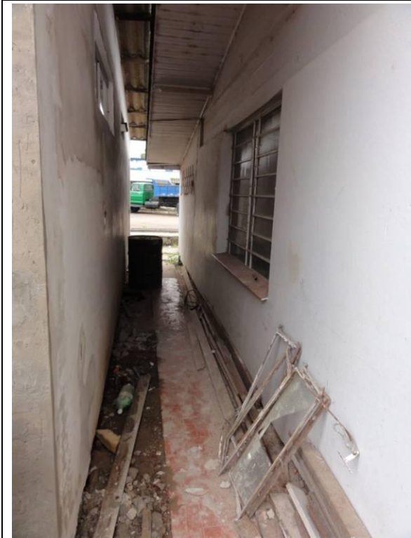
Lateral Direita – Parede D (DSC04720, 24/02/2011, 11:09h)
