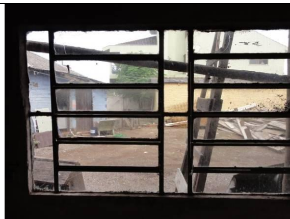
Sala / Cozinha (DSC03653, 23/02/2011, 09:56h)
