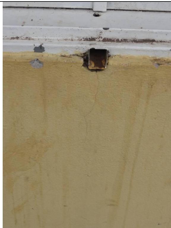
Fachada (DSC03736, 23/02/2011, 10:21h)
