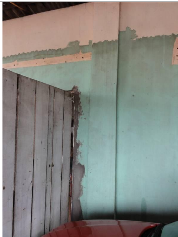
Fachada (DSC03623, 23/02/2011, 09:52h)
