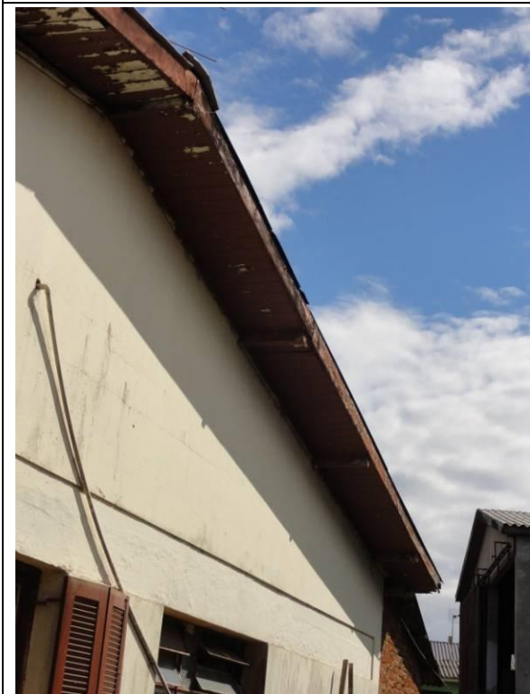
Lateral Direita – Parede D (DSC04558, 24/02/2011, 10:02h)
