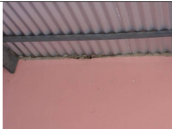
Fachada - Entrada (DSC04488, 24/02/2011, 09:47h)
