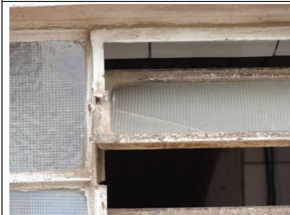
Lateral Esquerda- Parede B (DSC04762, 24/02/2011, 11:14h)
