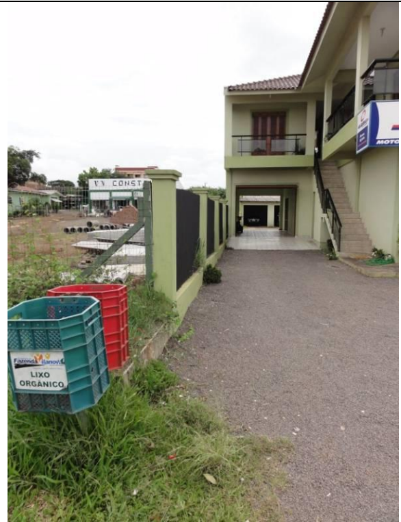
Fachada – Garagem (DSC03838, 23/02/2011, 10:55h)
