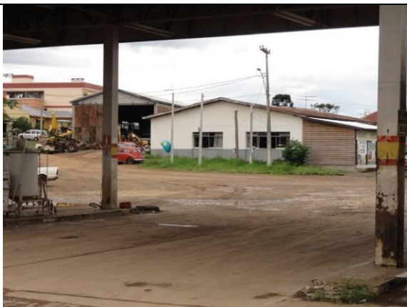
Fachada (DSC04689, 24/02/2011, 11:03h)
