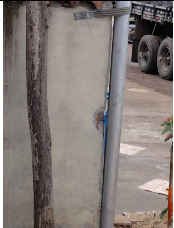
Fachada (DSC03615, 23/02/2011, 09:51h)
