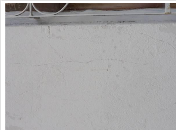
Lateral Direito – Parede D (DSC04393, 24/02/2011, 09:23h)
