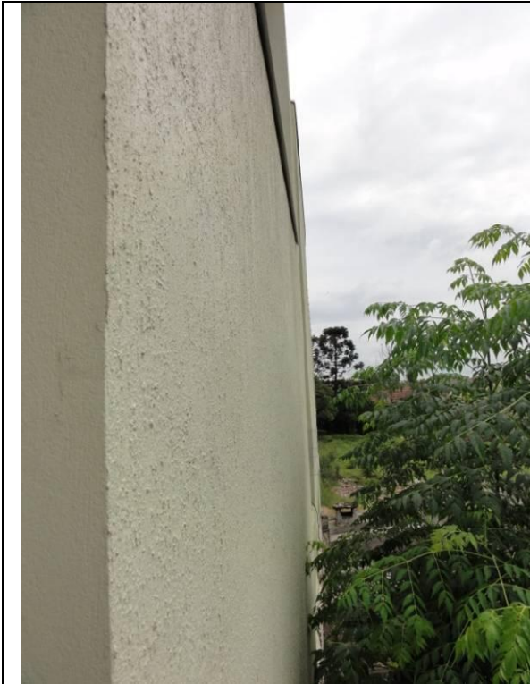
Piso Superior - Sacada (DSC03959, 23/02/2011, 11:17h)
