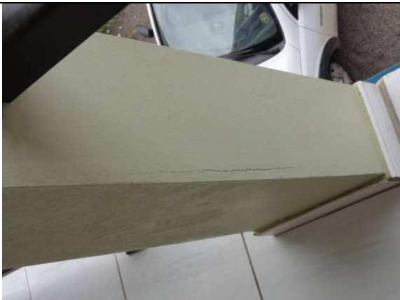
Piso Superior - Sacada (DSC03967, 23/02/2011, 11:19h)
