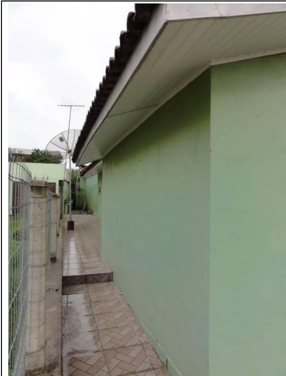
Lateral Direita – Parede D (DSC04162, 23/02/2011, 16:50h)
