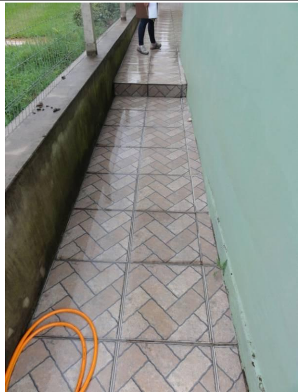
Lateral Direita – Parede D (DSC04165, 23/02/2011, 16:50h)
