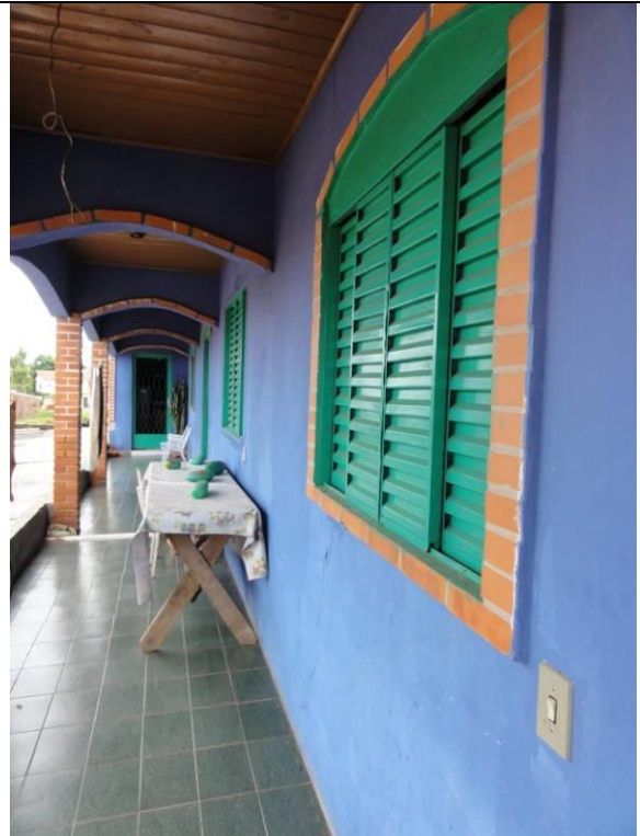
Piso Superior – Sacada (DSC03601, 23/02/2011, 09:40h)
