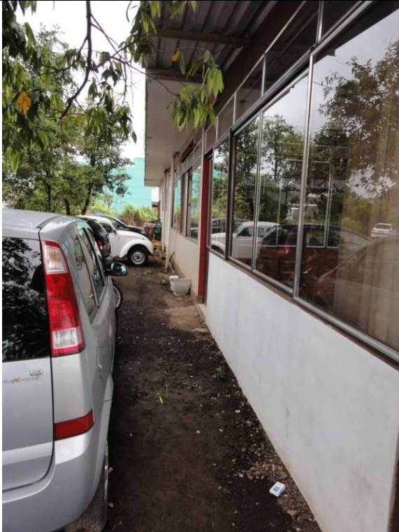
Fachada - Vidraça (DSC02767, 22/02/2011, 09:31h)
