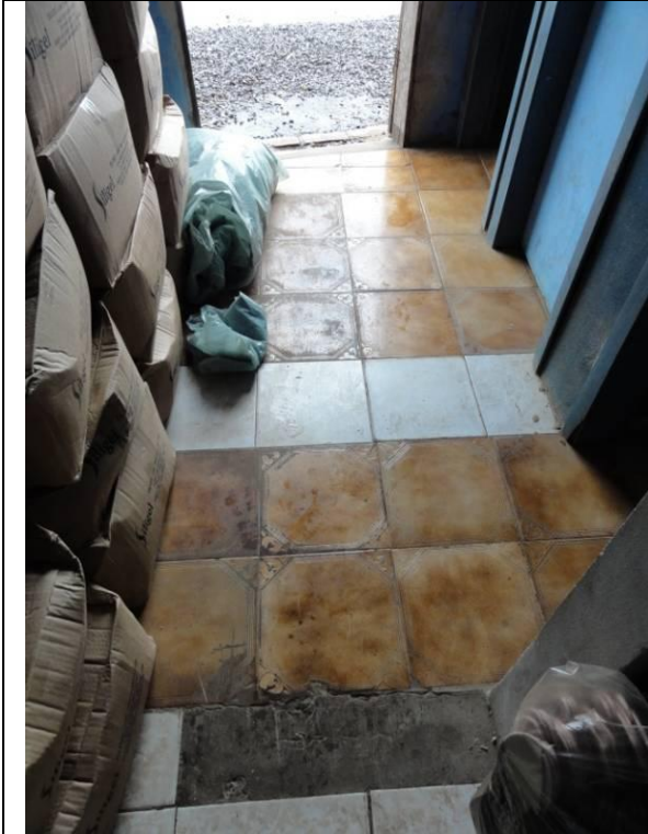
Piso Inferior – Fábrica (DSC03093, 22/02/2011, 11:24h)
