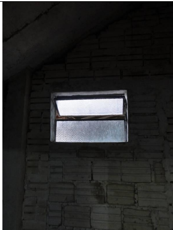
Parte 1 – Piso inferior – Igreja (DSC02681, 21/02/2011, 17:44h)
