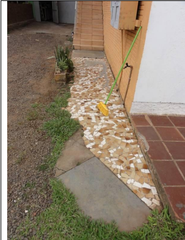
Lateral Direto – Parede D (DSC02264, 21/02/2011, 15:53h)
