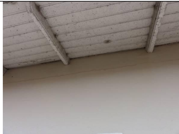
Piso superior – Sacada (DSC02943, 22/02/2011, 10:14h)
