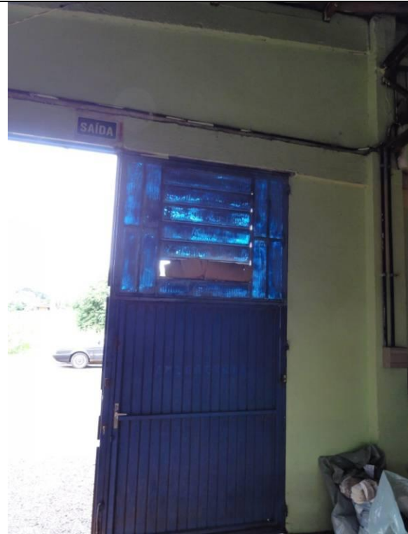
Piso Inferior – Fábrica – Parte 2 (DSC03248, 22/02/2011, 16:59h)
