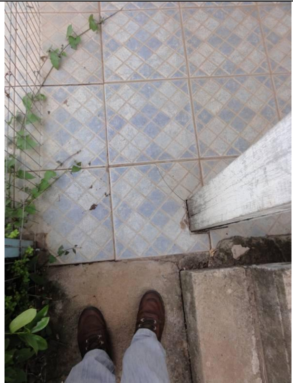
Parte 2 – Piso inferior – Fundos – Escada (DSC02519, 21/02/2011, 16:49h)
