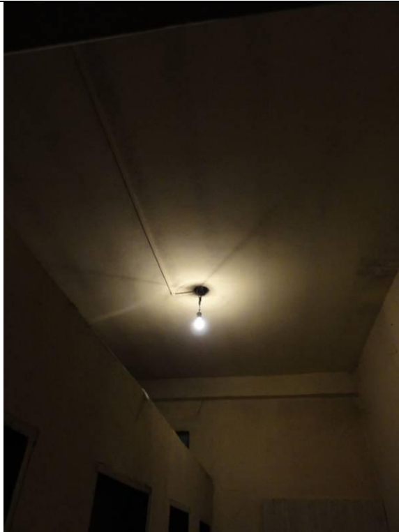
Piso Inferior – Fábrica – Parte 2 - WC (DSC03205, 22/02/2011, 16:51h)
