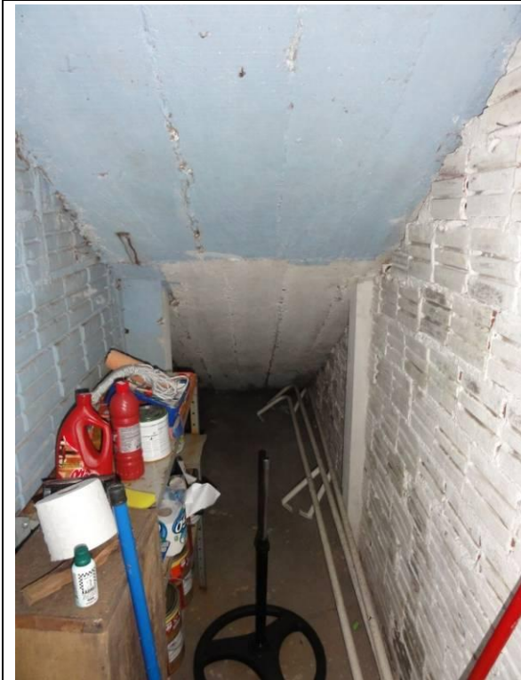
Parte 1 – Piso inferior – Igreja (DSC02682, 21/02/2011, 17:44h)
