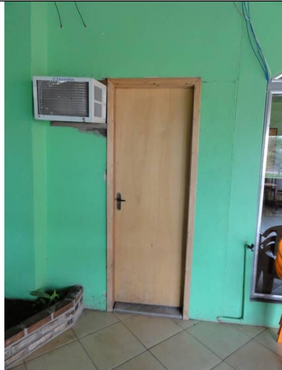
Parte 2 – Piso inferior – Lanchonete - Cobertura fachada (DSC02586, 21/02/2011, 17:02h)
