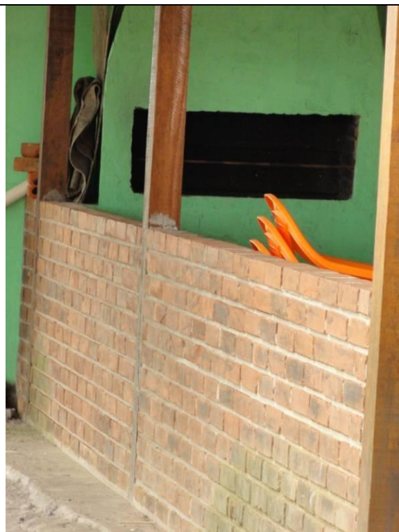
Cobertura Fachada(DSC02483, 21/02/2011, 16:41h)
