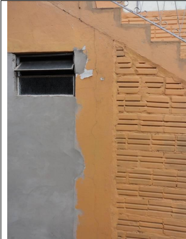
Lateral Direto – Parede D (DSC02272, 21/02/2011, 15:55h)
