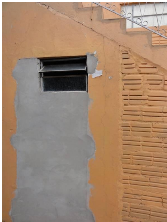
Lateral Direto – Parede D (DSC02271, 21/02/2011, 15:55h)
