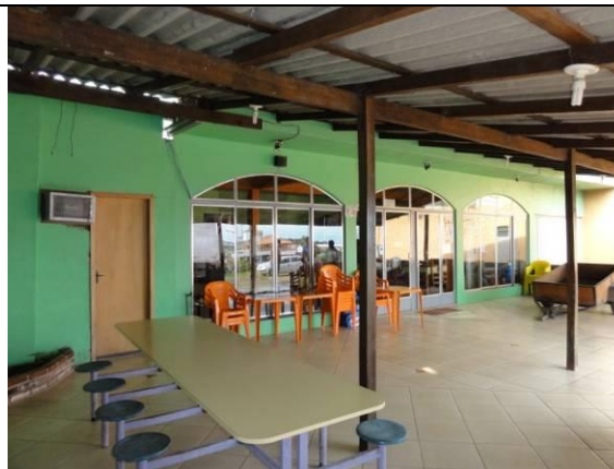
Parte 2 – Piso inferior – Lanchonete - Cobertura fachada (DSC02590, 21/02/2011, 17:04h)
