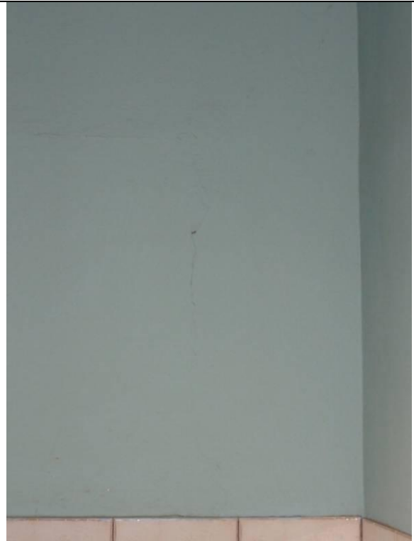
Parte 2 – Piso inferior – Lanchonete - WC (DSC02578, 21/02/2011, 17:00h)
