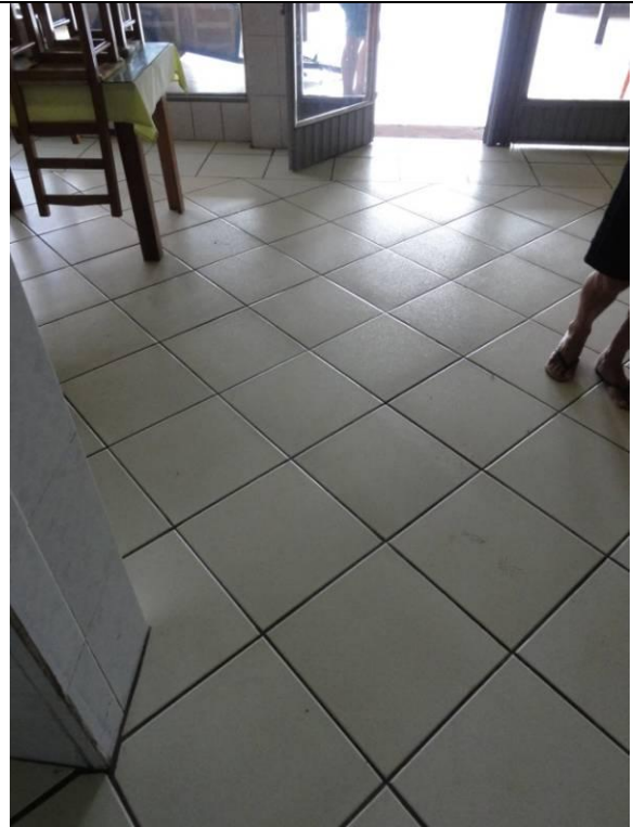
Parte 2 – Piso inferior – Lanchonete (DSC02568, 21/02/2011, 16:58h)
