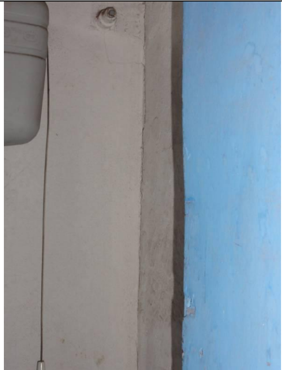
Piso Inferior – Fábrica – WC (DSC03092, 22/02/2011, 11:23h)
