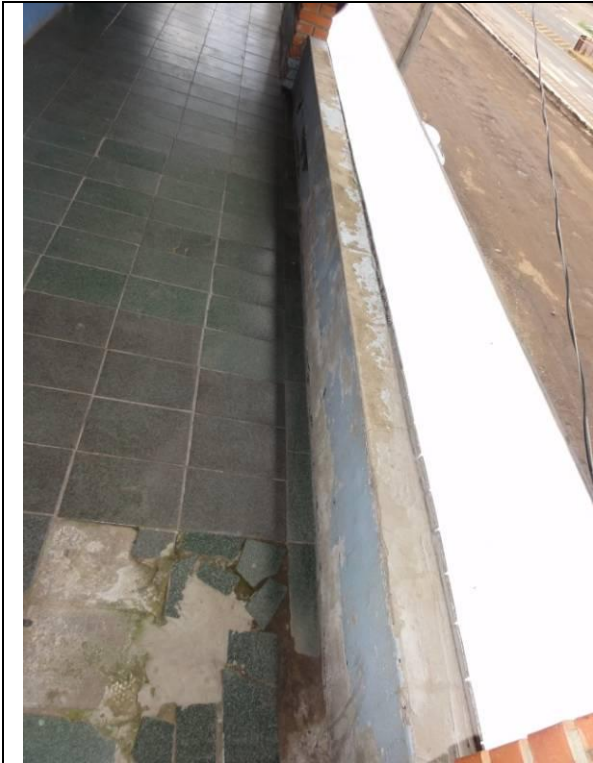
Piso Superior - Sacada (DSC03544, 23/02/2011, 09:33h)
