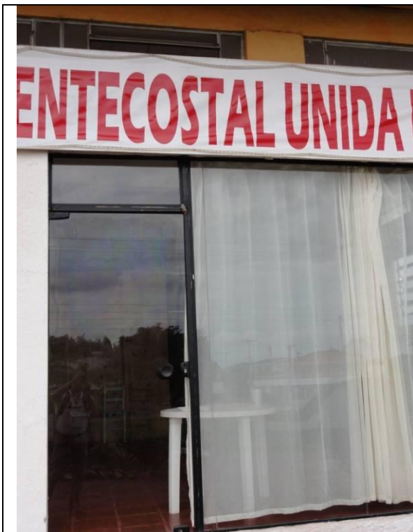
Fachada - Vidraças (DSC02228, 21/02/2011, 15:48h)
