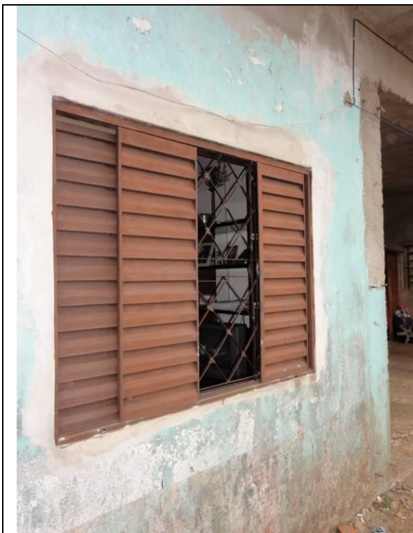
Janela fachada (DSC02603, 21/02/2011, 17:13h)
