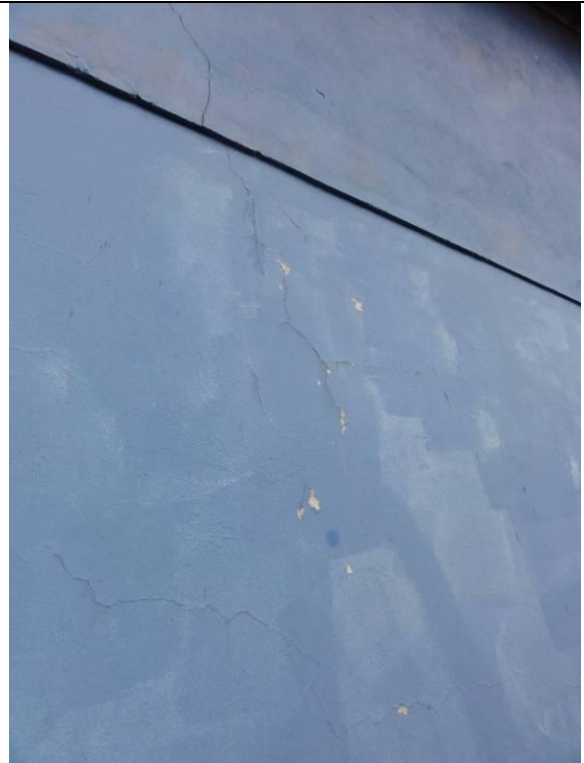
Piso Superior - Sacada (DSC03579, 23/02/2011, 09:37h)
