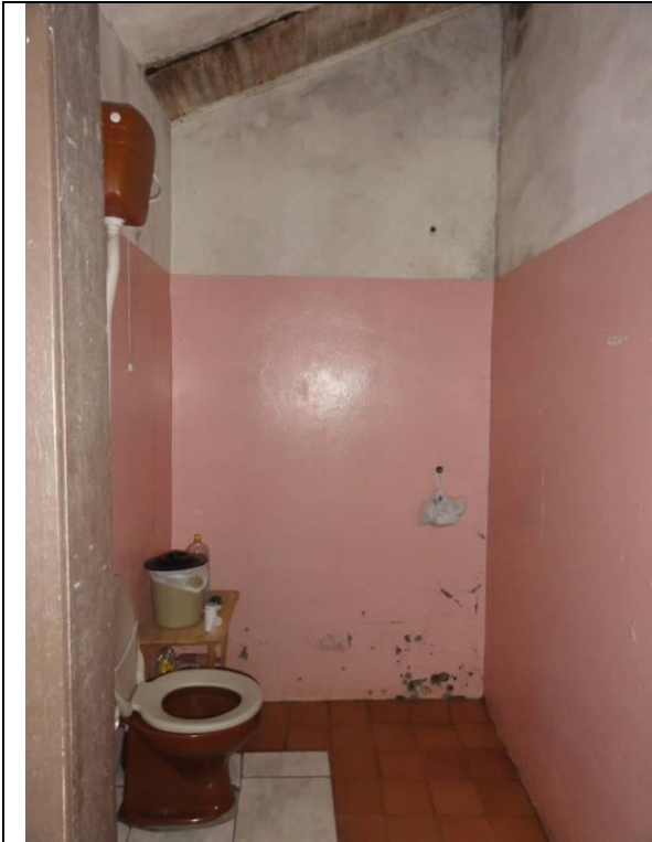
Piso Inferior – Loja – WC (DSC03444, 23/02/2011, 09:09h)
