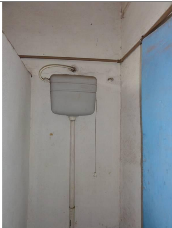
Piso Inferior – Fábrica – WC (DSC03090, 22/02/2011, 11:23h)
