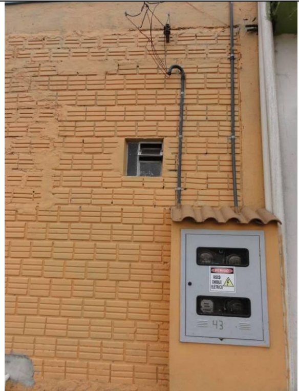
Lateral Esquerda – parede B – Caixa de luz (DSC02249, 21/02/2011, 15:51h)
