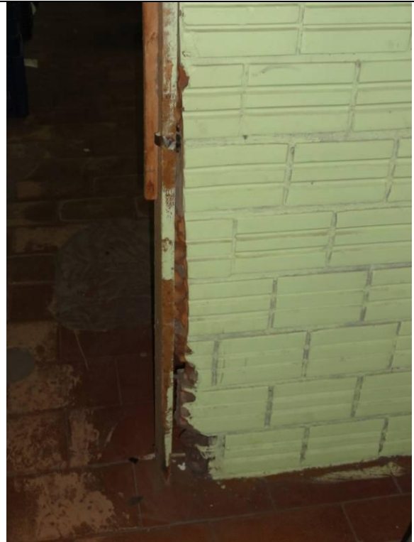
Piso Inferior – Fábrica – Parte 2 (DSC03184, 22/02/2011, 16:46h)
