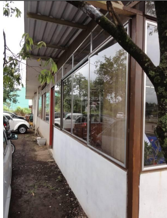
Fachada - Vidraça (DSC02766, 22/02/2011, 09:30h)
