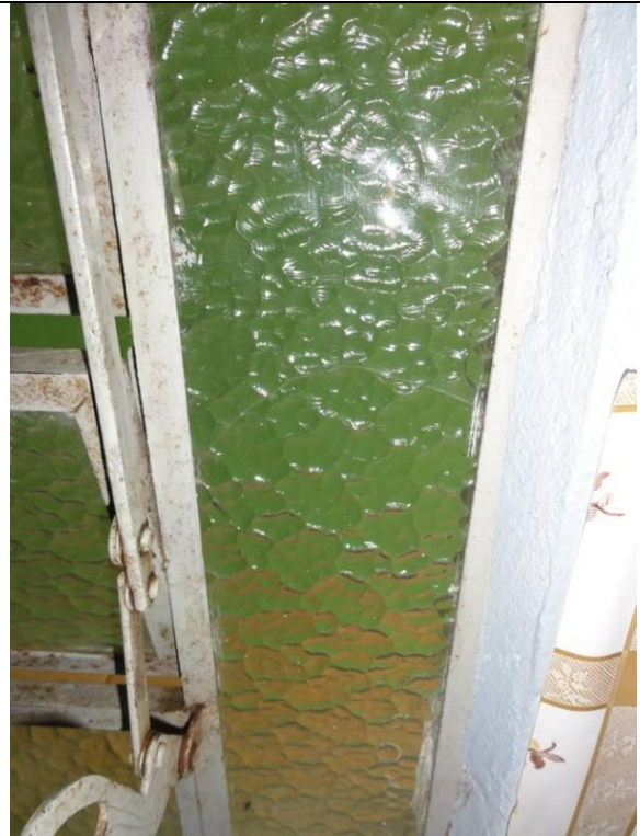
Piso superior - Area de Serviço (DSC02437, 21/02/2011, 16:33h)
