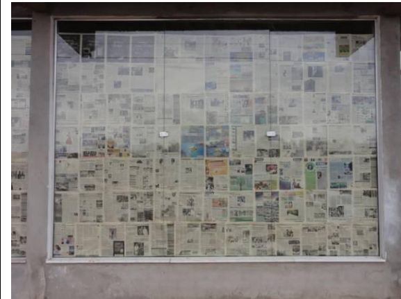
Fachada - Vidraças (DSC02725, 22/02/2011, 09:18h)
