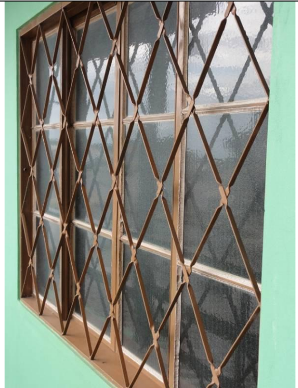
Parte 2 – Piso superior – Sacada (DSC02485, 21/02/2011, 16:42h)
