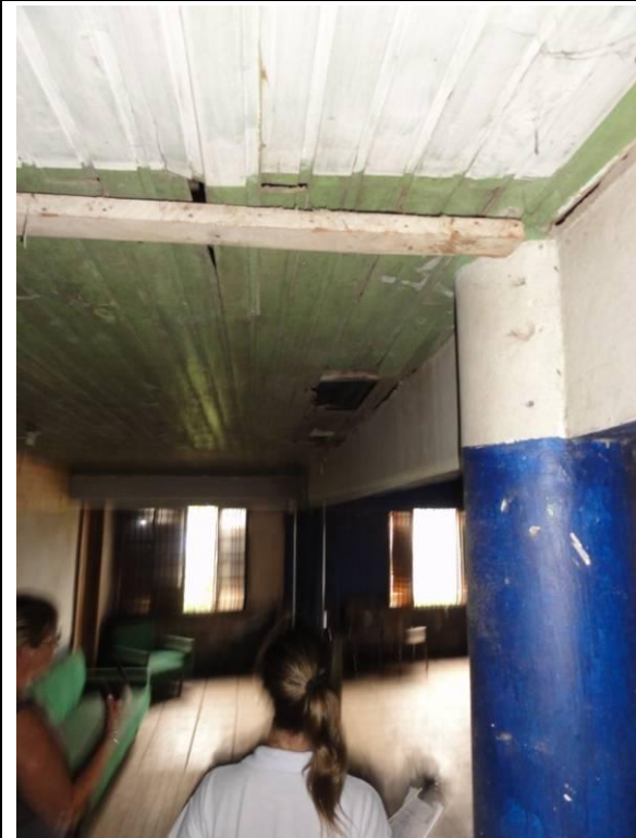
Piso superior (DSC03316, 22/02/2011, 17:12h)
