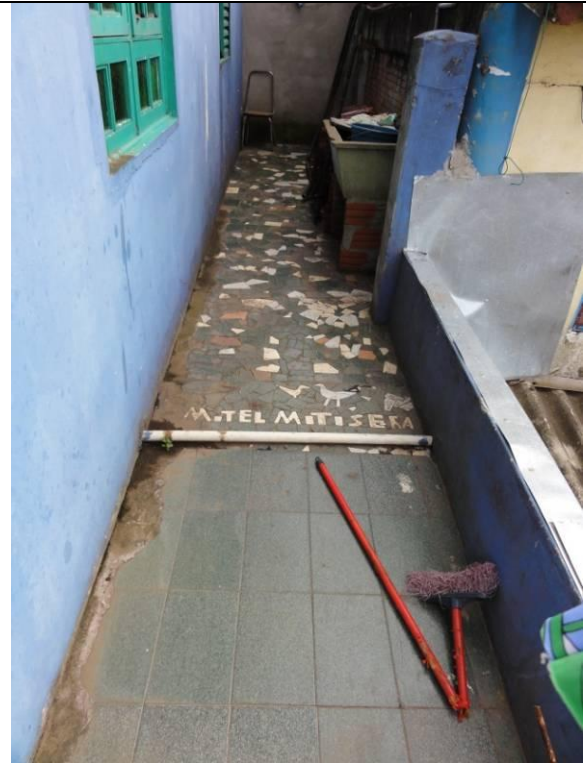
Piso Superior - Sacada (DSC03569, 23/02/2011, 09:35h)
