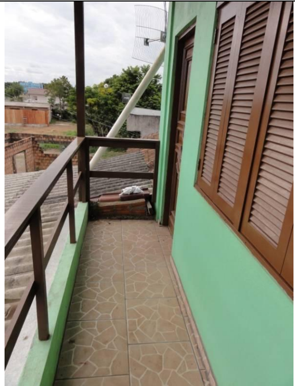
Parte 2 – Piso superior – Sacada (DSC02491, 21/02/2011, 16:43h)
