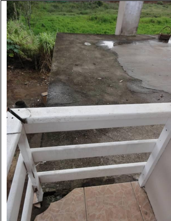
Piso superior – Sacada (DSC02948, 22/02/2011, 10:14h)
