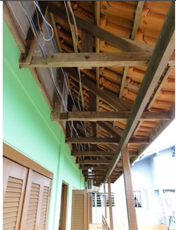
Parte 2 – Piso superior – Sacada - Marquise (DSC02495, 21/02/2011, 16:43h)
