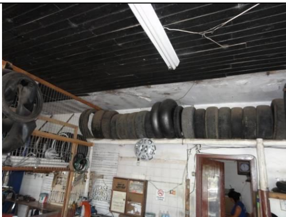
Piso Inferior - Borracharia (DSC03044, 22/02/2011, 10:58h)
