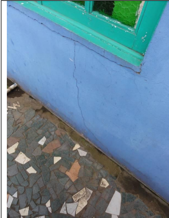
Piso Superior – Sacada (DSC03592, 23/02/2011, 09:38h)
