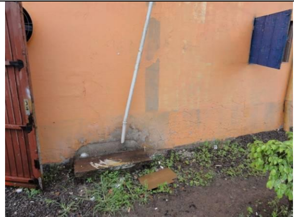
Lateral Esquerdo – Parede B (DSC03082, 22/02/2011, 11:20h)
