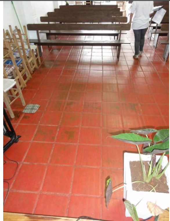
Parte 1 – Piso inferior – Igreja – Piso cerâmico (DSC02677, 21/02/2011, 17:43h)
