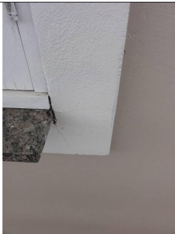
Piso superior – Sacada (DSC02955, 22/02/2011, 10:15h)
