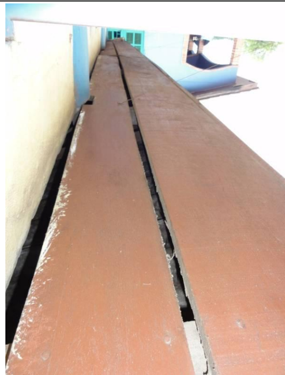
Piso superior (DSC03286, 22/02/2011, 17:07h)
