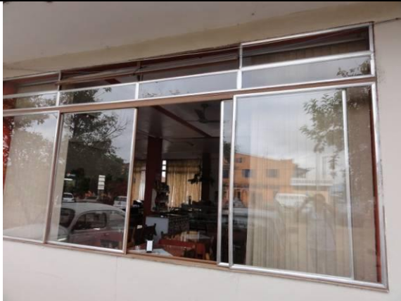
Fachada - Vidraça (DSC02771, 22/02/2011, 09:31h)
