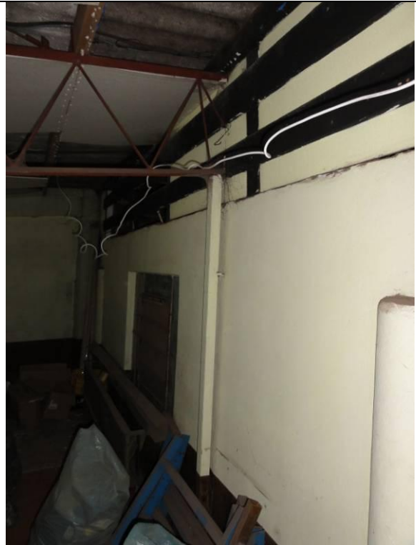
Piso Inferior – Fábrica – Parte 2 (DSC03226, 22/02/2011, 16:55h)
