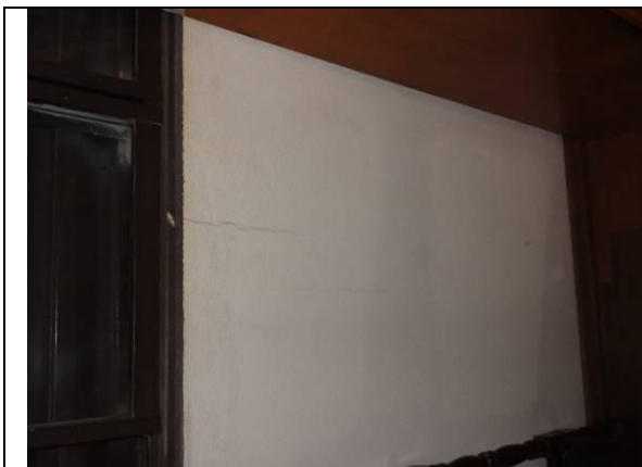
Piso superior - Cozinha (DSC02426, 21/02/2011, 16:29h)
