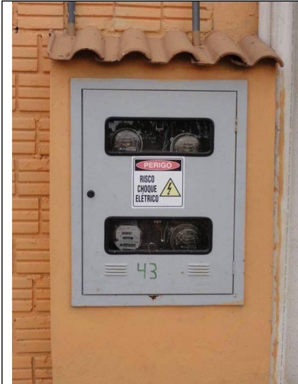
Lateral Esquerda – parede B – Caixa de luz (DSC02248, 21/02/2011, 15:51h)
