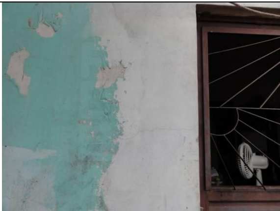
Fachada – Porta de entrada (DSC02613, 21/02/2011, 17:15h)
