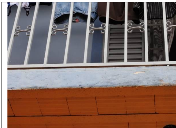
Lateral Direto – Parede D (DSC02288, 21/02/2011, 15:57h)
