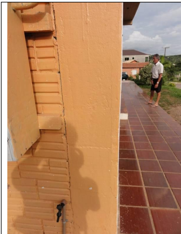
Parte 1 – Piso inferior – Igreja (DSC02591, 21/02/2011, 17:04h)
