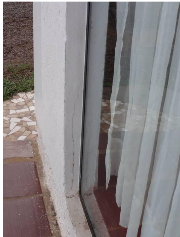
Parte 1 – Piso inferior – Igreja - Calçada (DSC02697, 21/02/2011, 17:47h)
