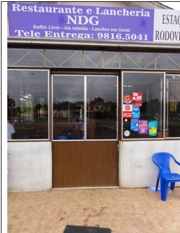
Fachada - Vidraças (DSC02763, 22/02/2011, 09:30h)
