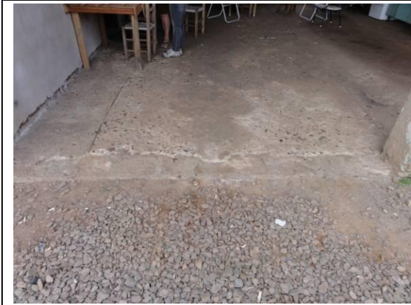
Calçada Garagem (DSC02627, 21/02/2011, 17:17h)
