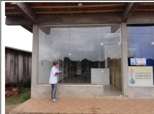
Fachada - Vidraças (DSC02722, 22/02/2011, 09:17h)
