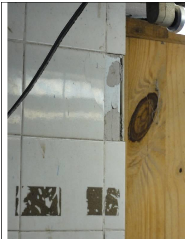
Piso Inferior – Fábrica (DSC03101, 22/02/2011, 11:25h)
