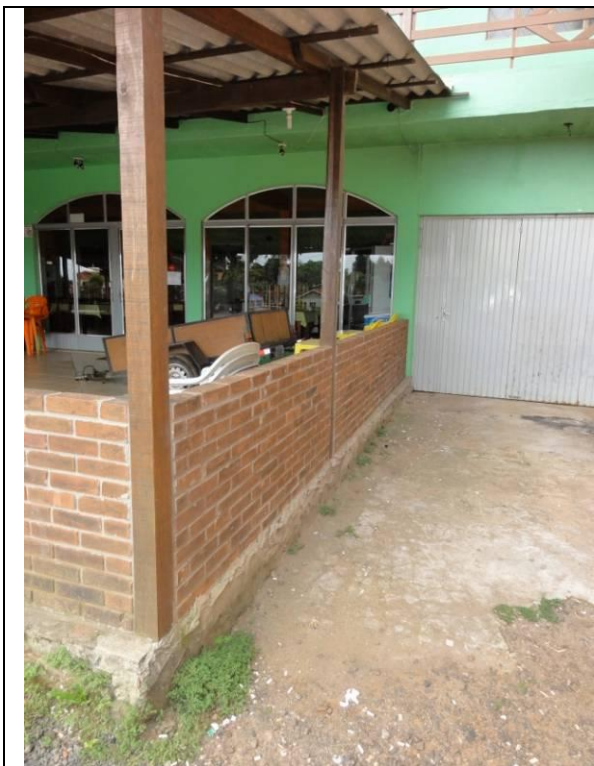
Cobertura Fachada(DSC02482, 21/02/2011, 16:41h)
