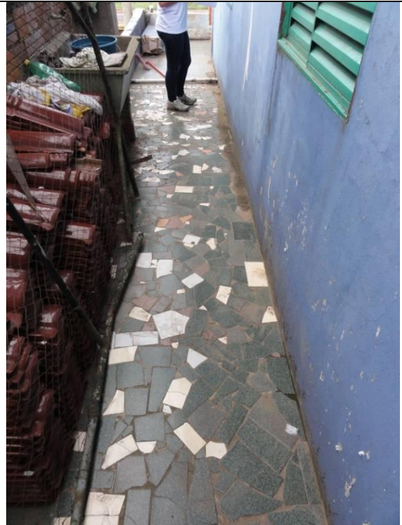
Piso Superior – Sacada (DSC03589, 23/02/2011, 09:38h)
