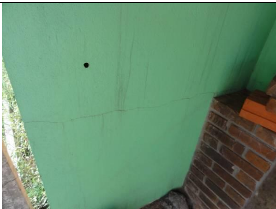
Parte 2 – Piso inferior – Lanchonete - Cobertura fachada (DSC02589, 21/02/2011, 17:03h)
