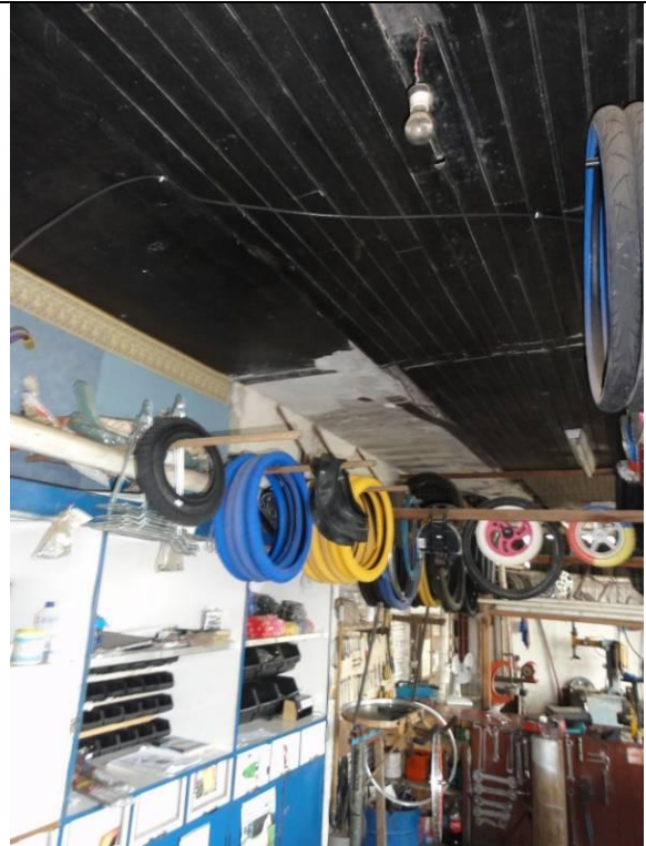
Piso Inferior – Borracharia (DSC03061, 22/02/2011, 11:01h)
