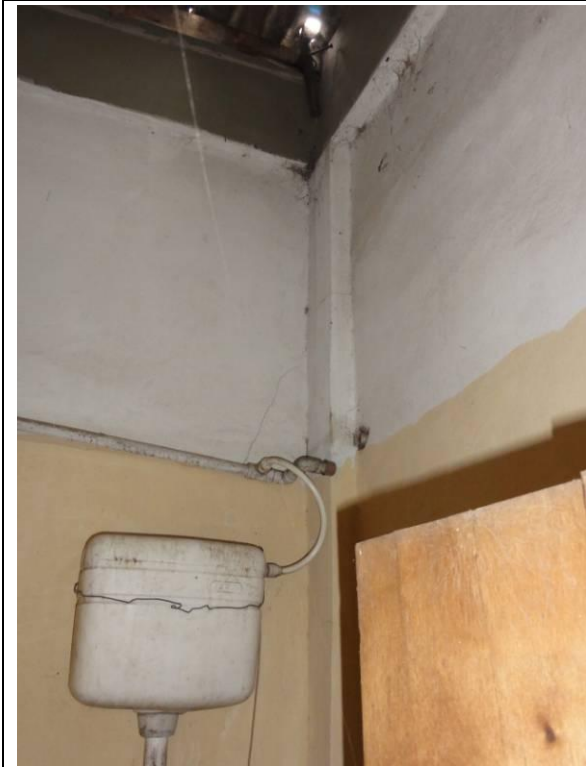
Piso superior (DSC03308, 22/02/2011, 17:10h)
