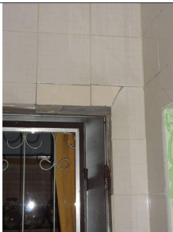
Piso superior - Cozinha (DSC02429, 21/02/2011, 16:31h)
