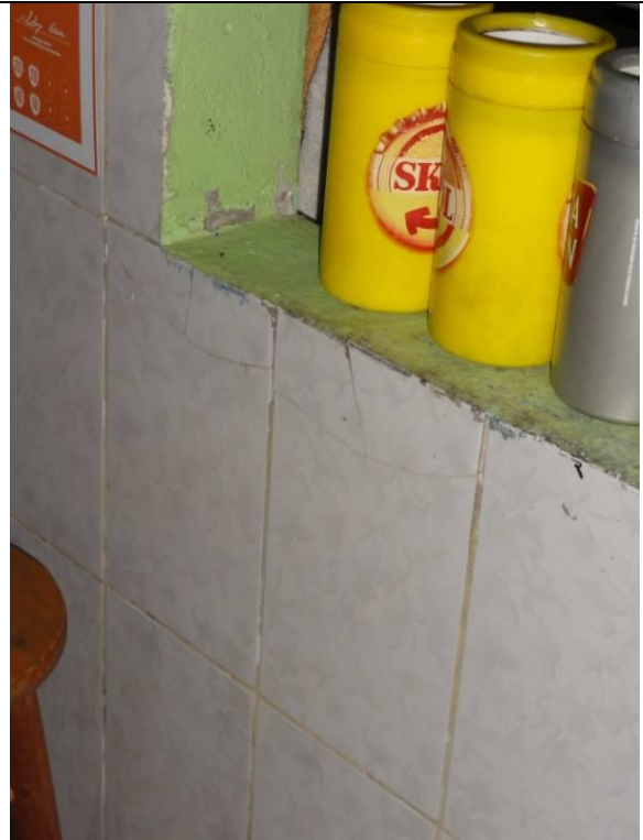
Parte 2 – Piso inferior – Lanchonete (DSC02566, 21/02/2011, 16:58h)
