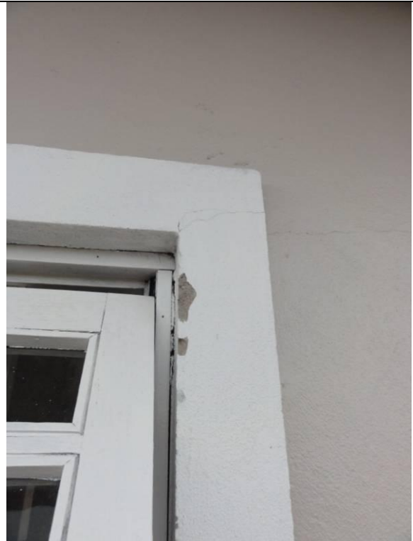
Piso superior – Sacada (DSC02959, 22/02/2011, 10:15h)
