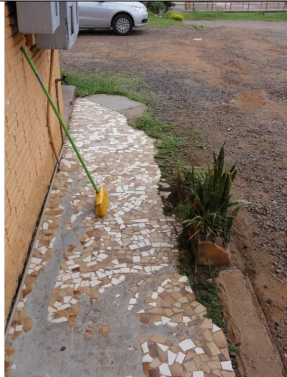
Lateral Direto – Parede D – Calçada (DSC02295, 21/02/2011, 15:59h)
