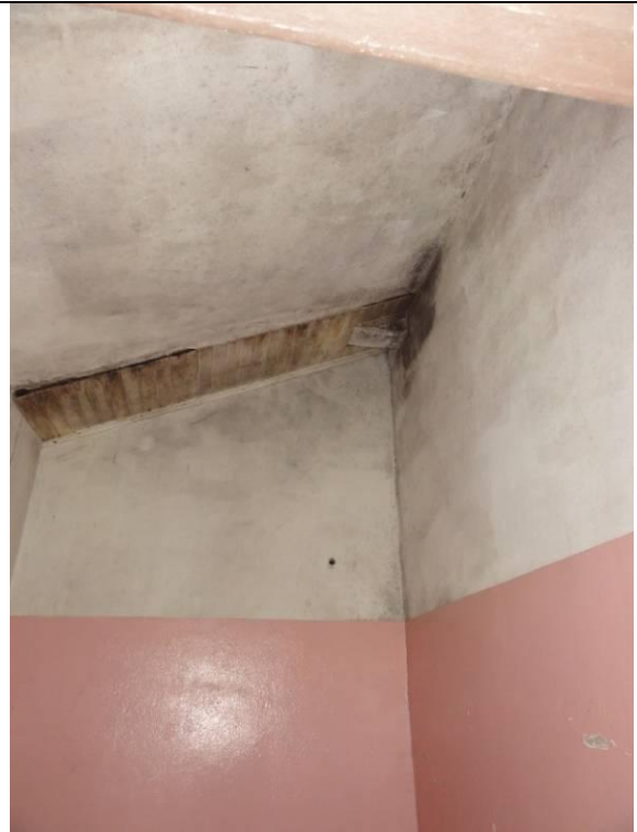
Piso Inferior – Loja – WC (DSC03445, 23/02/2011, 09:09h)
