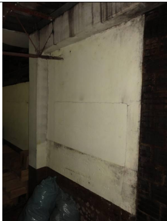
Piso Inferior – Fábrica – Parte 2 (DSC03216, 22/02/2011, 16:54h)
