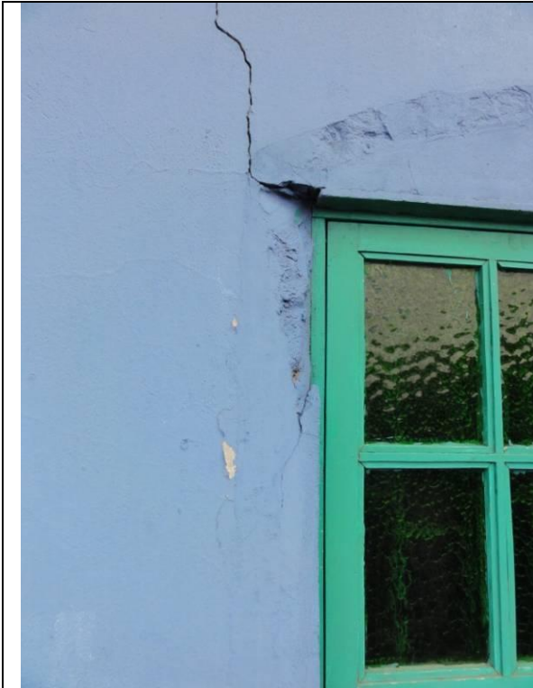
Piso Superior - Sacada (DSC03576, 23/02/2011, 09:37h)
