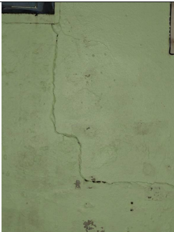
Piso Inferior – Fábrica – Parte 2 (DSC03243, 22/02/2011, 16:59h)
