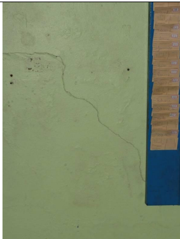
Piso Inferior – Fábrica – Parte 2 (DSC03244, 22/02/2011, 16:59h)
