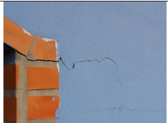
Piso Superior - Sacada (DSC03571, 23/02/2011, 09:36h)
