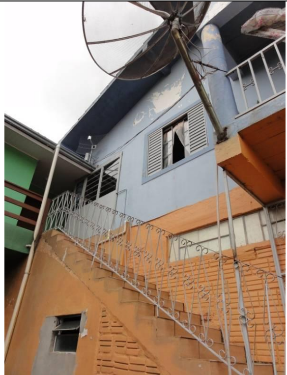
Lateral Direto – Parede D (DSC02269, 21/02/2011, 15:55h)
