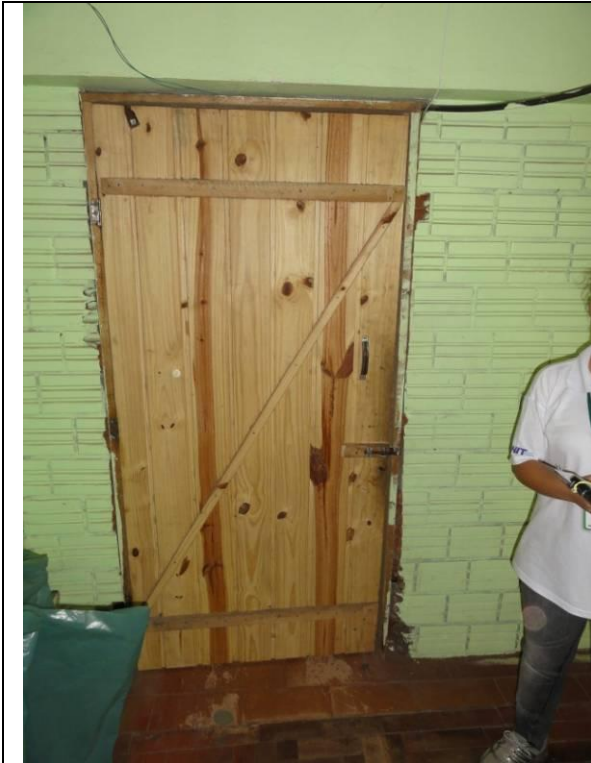
Piso Inferior – Fábrica – Parte 2 (DSC03183, 22/02/2011, 16:46h)
