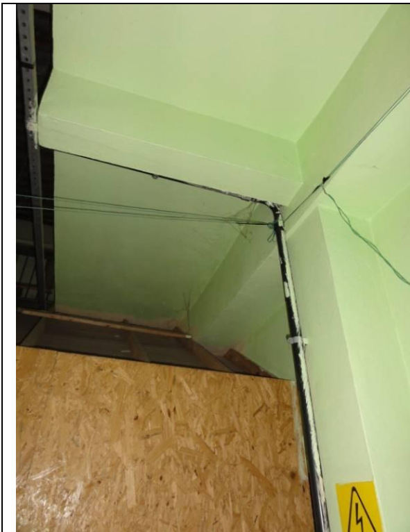
Piso Inferior – Fábrica – Parte 2 (DSC03181, 22/02/2011, 16:46h)
