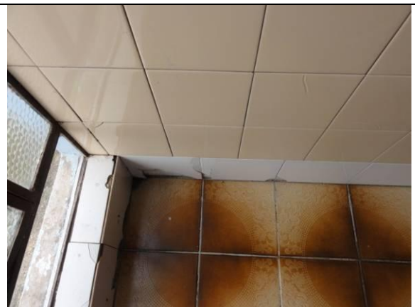
Piso superior - Area de Serviço (DSC02447, 21/02/2011, 16:34h)
