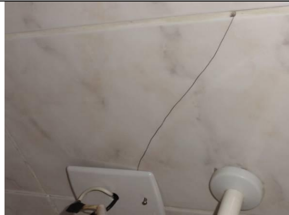
Piso superior – WC 1 (DSC02985, 22/02/2011, 10:22h)
