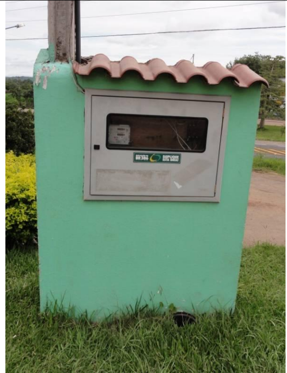
Parte 2 – Muro com caixa de luz (DSC02467, 21/02/2011, 16:39h)
