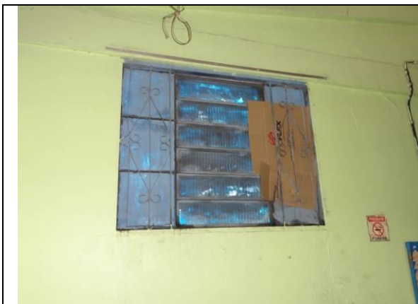
Piso Inferior – Fábrica – Parte 2 (DSC03241, 22/02/2011, 16:58h)
