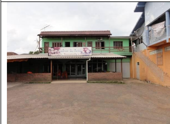
Parte 2 - Fachada (DSC02462, 21/02/2011, 16:38h)
