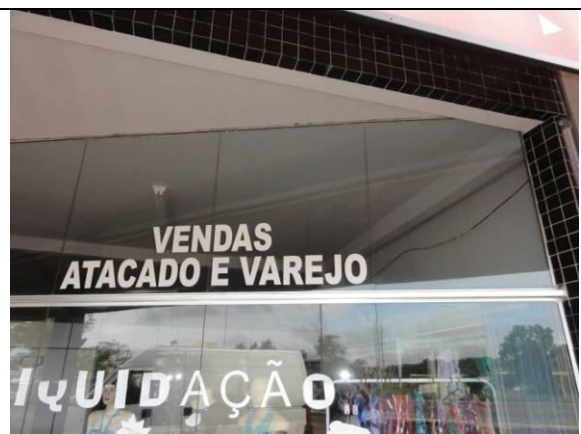
Fachada - Vidraças (DSC03363, 23/02/2011, 08:54h)
