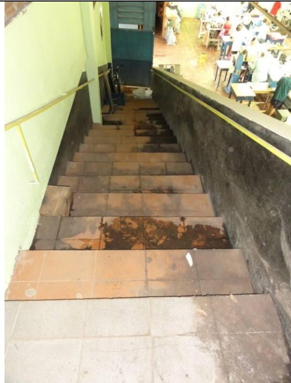
Piso Inferior – Fábrica – Parte 2 (DSC03230, 22/02/2011, 16:56h)
