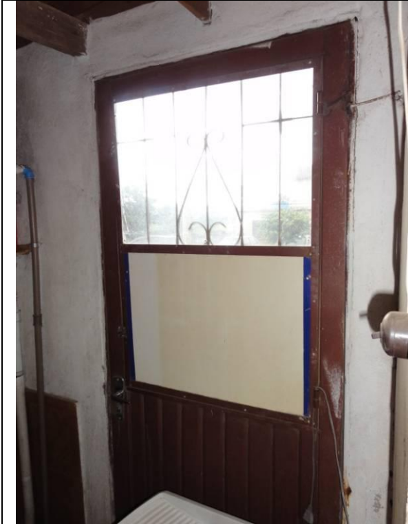
Piso Inferior – Borracharia (DSC03068, 22/02/2011, 11:02h)
