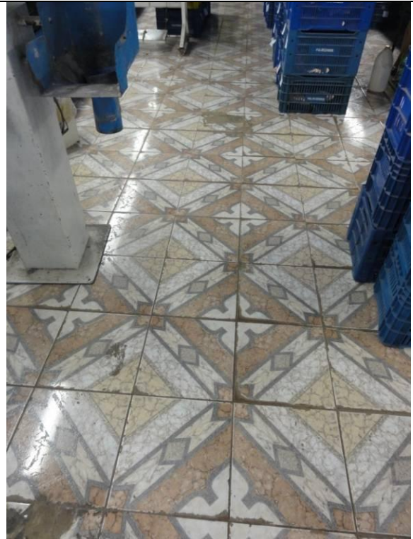
Piso Inferior – Fábrica – Piso cerâmico (DSC03106, 22/02/2011, 11:27h)
