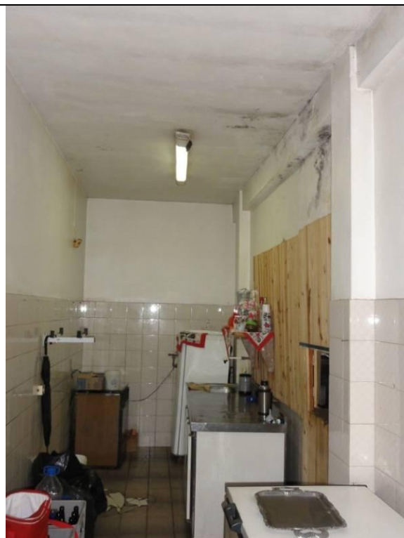
Parte 2 – Piso inferior – Lanchonete - Cozinha (DSC02562, 21/02/2011, 16:57h)
