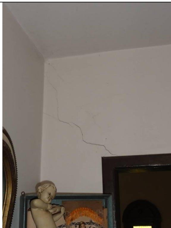
Piso superior - Corredor (DSC02393, 21/02/2011, 16:18h)
