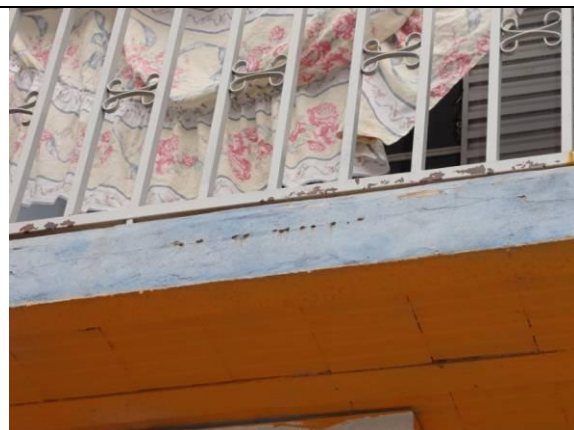
Lateral Direto – Parede D (DSC02289, 21/02/2011, 15:57h)
