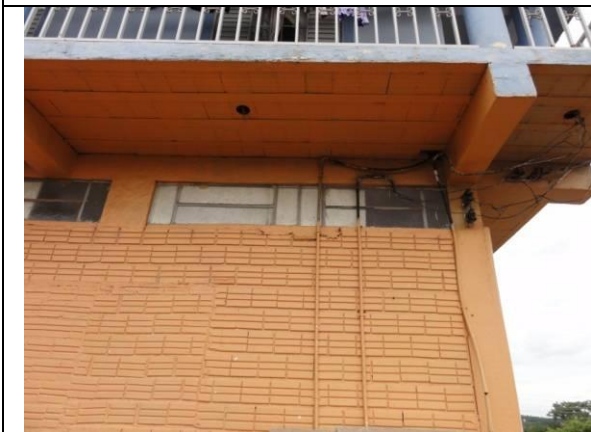
Lateral Direto – Parede D (DSC02266, 21/02/2011, 15:53h)
