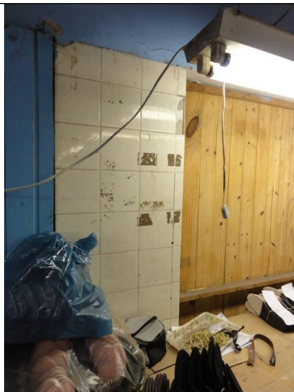
Piso Inferior – Fábrica (DSC03100, 22/02/2011, 11:25h)
