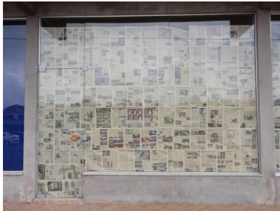
Fachada - Vidraças (DSC02724, 22/02/2011, 09:18h)
