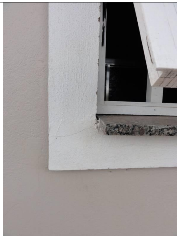
Piso superior – Sacada (DSC02957, 22/02/2011, 10:15h)
