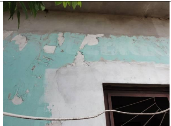
Fachada – Porta de entrada (DSC02614, 21/02/2011, 17:15h)
