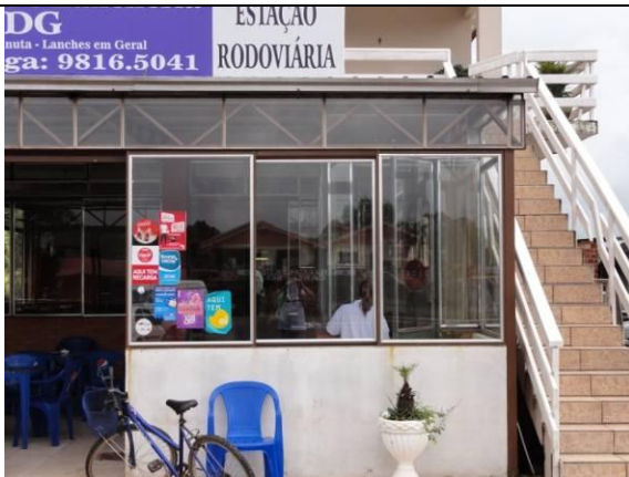
Fachada - Estação Rodoviária (DSC02761, 22/02/2011, 09:29h)
