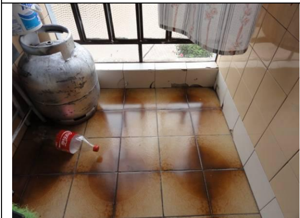
Piso superior - Area de Serviço (DSC02440, 21/02/2011, 16:33h)
