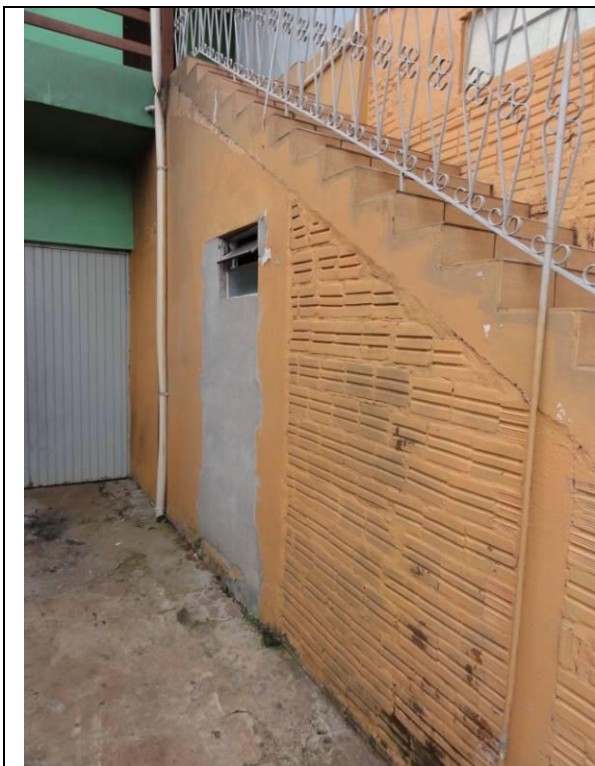
Lateral Direto – Parede D (DSC02270, 21/02/2011, 15:55h)
