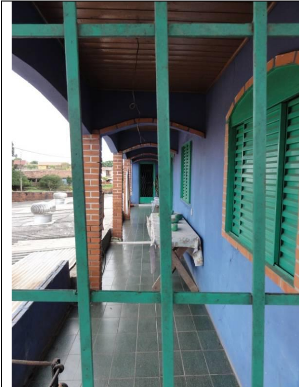
Piso Superior – Sacada (DSC03604, 23/02/2011, 09:40h)
