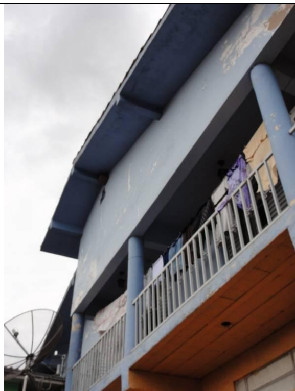
Lateral Direto – Parede D (DSC02283, 21/02/2011, 15:57h)
