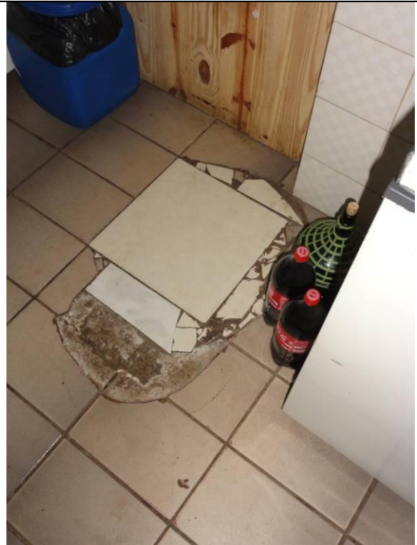
Parte 2 – Piso inferior – Lanchonete - Cozinha (DSC02558, 21/02/2011, 16:56h)
