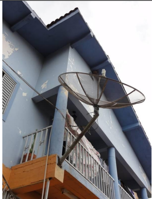
Lateral Direto – Parede D (DSC02273, 21/02/2011, 15:55h)
