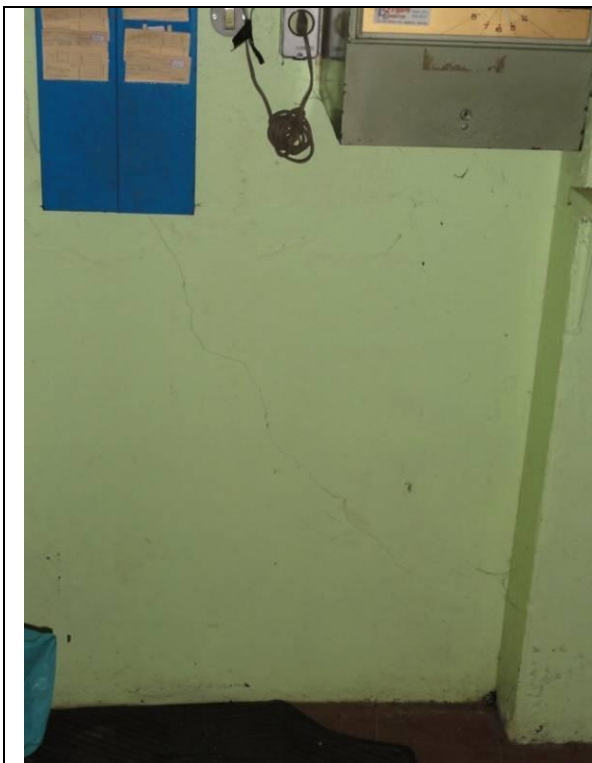
Piso Inferior – Fábrica – Parte 2 (DSC03245, 22/02/2011, 16:59h)
