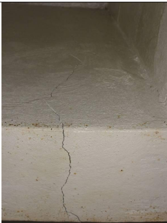
Parte 2 – Piso inferior – Lanchonete – Teto em geral com muita umidade e mofo (DSC02539, 21/02/2011, 16:53h)
