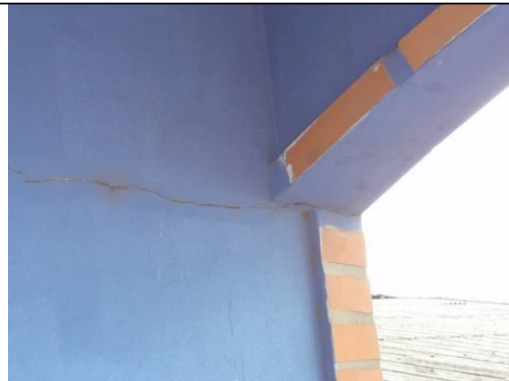
Piso Superior - Sacada (DSC03563, 23/02/2011, 09:35h)
