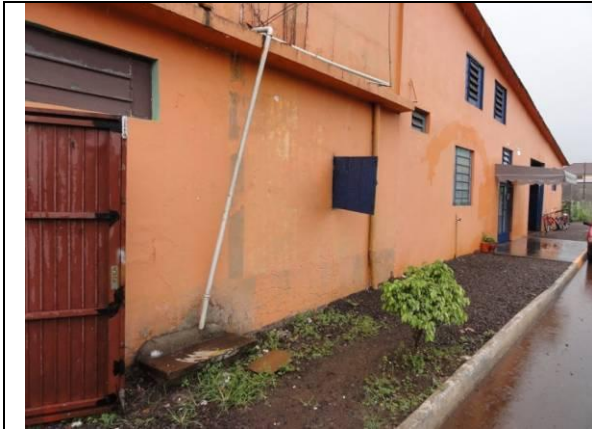
Lateral Esquerdo – Parede B (DSC03081, 22/02/2011, 11:20h)
