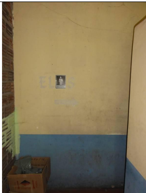
Piso Inferior – Fábrica – Parte 2 - WC (DSC03208, 22/02/2011, 16:52h)
