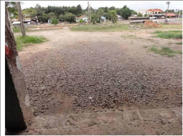
Calçada Garagem (DSC02628, 21/02/2011, 17:17h)
