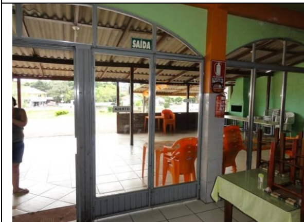
Parte 2 – Piso inferior – Lanchonete (DSC02569, 21/02/2011, 16:58h)
