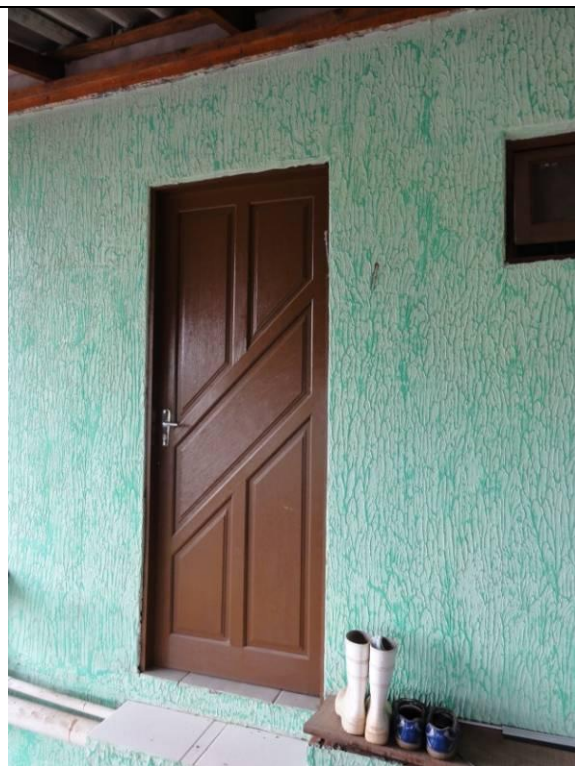
Parte 2 – Piso superior (DSC02507, 21/02/2011, 16:47h)
