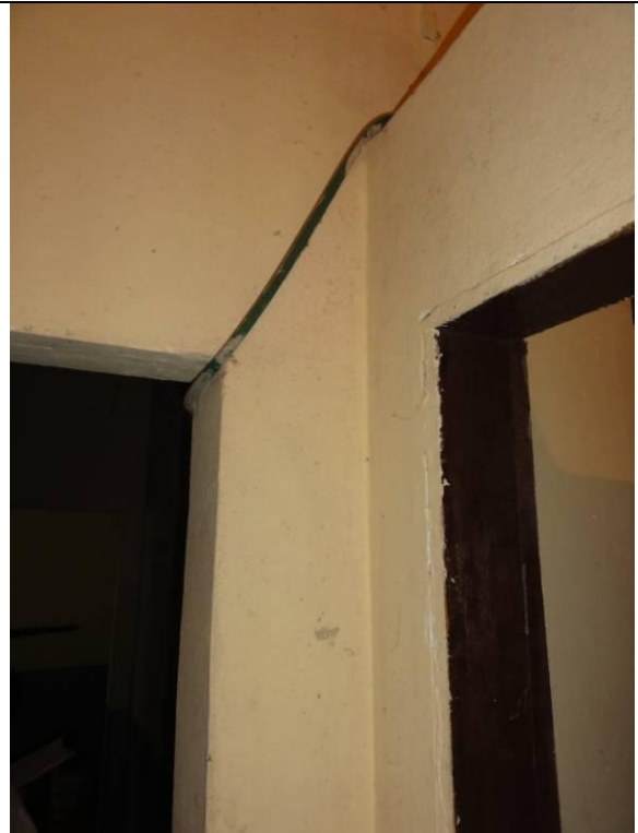
Piso Inferior – Fábrica – Parte 2 - WC (DSC03202, 22/02/2011, 16:51h)
