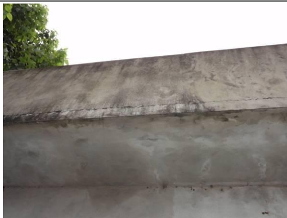
Marquise (DSC02621, 21/02/2011, 17:16h)
