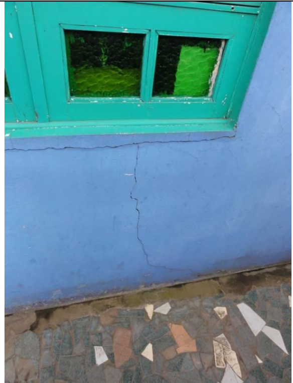
Piso Superior - Sacada (DSC03577, 23/02/2011, 09:37h)
