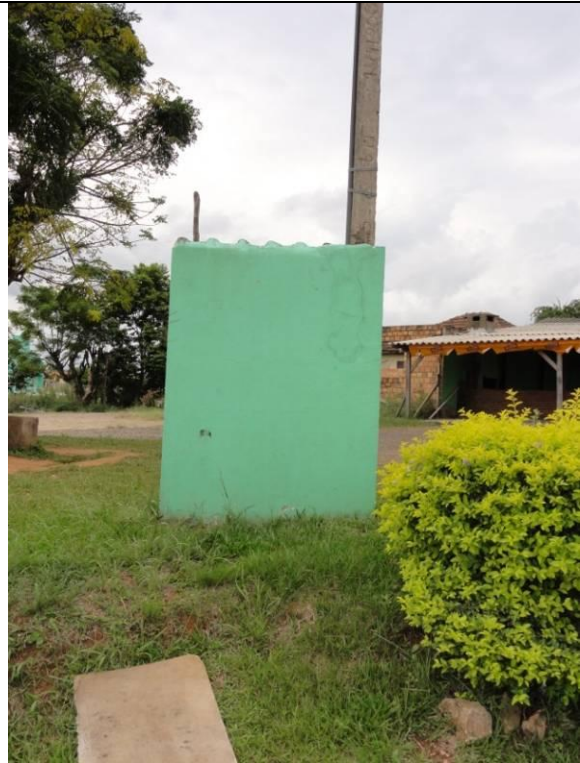
Parte 2 – Muro com caixa de luz (DSC02465, 21/02/2011, 16:38h)
