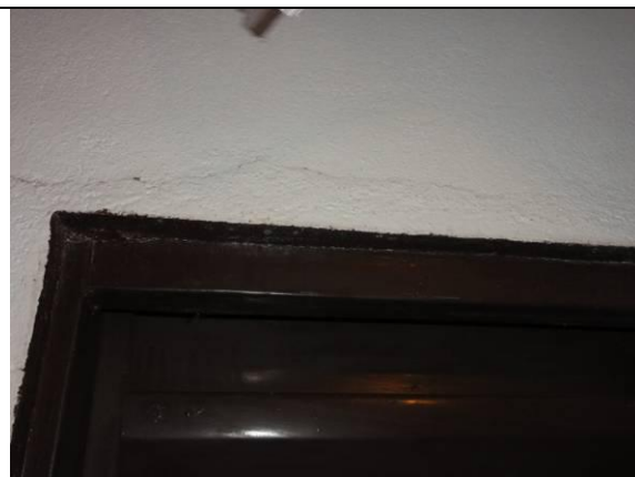
Piso superior - Cozinha (DSC02427, 21/02/2011, 16:29h)
