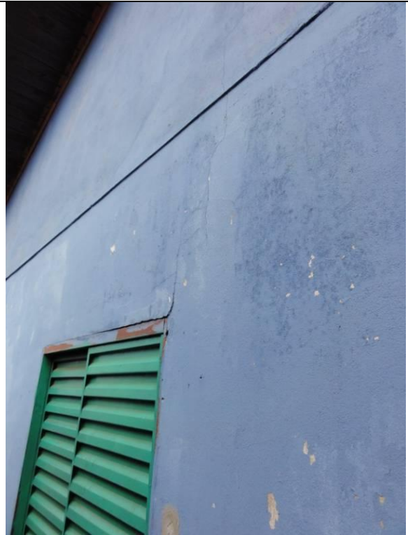
Piso Superior - Sacada (DSC03583, 23/02/2011, 09:37h)
