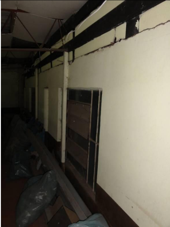
(Piso Inferior – Fábrica – Parte 2 (DSC03223, 22/02/2011, 16:55h)
