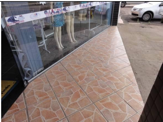
Fachada – Calçada Piso cerâmico (DSC03368, 23/02/2011, 08:54h)
