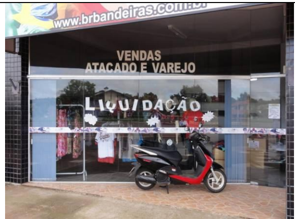
Fachada - Vidraças (DSC03361, 23/02/2011, 08:54h)
