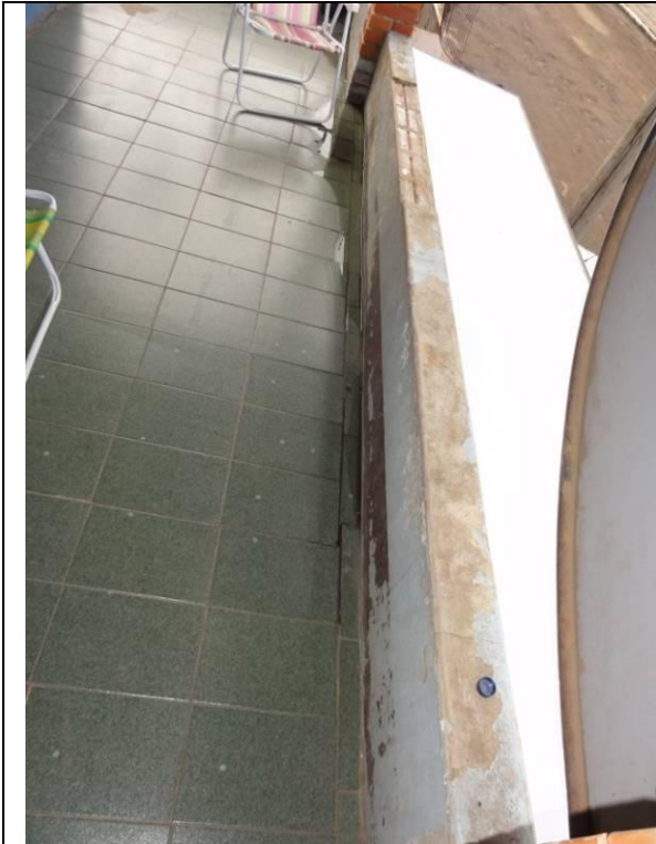
Piso Superior - Sacada (DSC03552, 23/02/2011, 09:33h)
