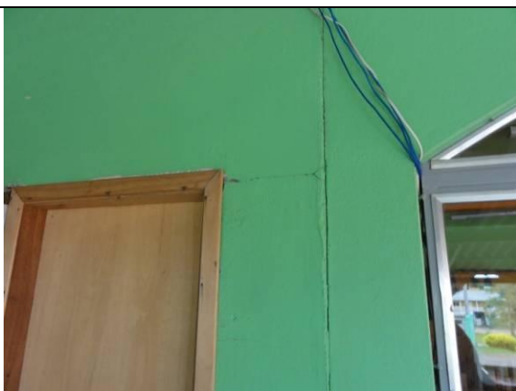
Parte 2 – Piso inferior – Lanchonete - Cobertura fachada (DSC02583, 21/02/2011, 17:01h)
