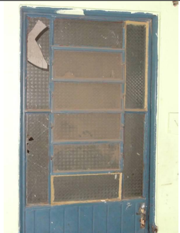
Piso Inferior – Fábrica – Parte 2 (DSC03212, 22/02/2011, 16:53h)
