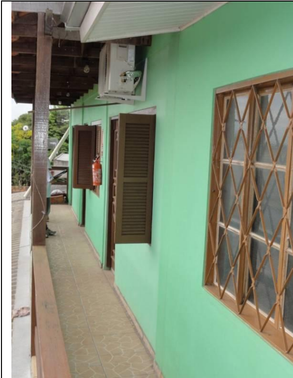
Parte 2 – Piso superior – Sacada (DSC02484, 21/02/2011, 16:42h)
