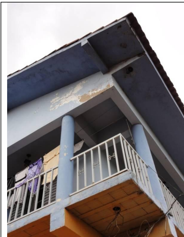
Lateral Direto – Parede D (DSC02282, 21/02/2011, 15:57h)
