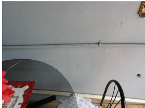
Piso superior - Area de Serviço (DSC02433, 21/02/2011, 16:32h)
