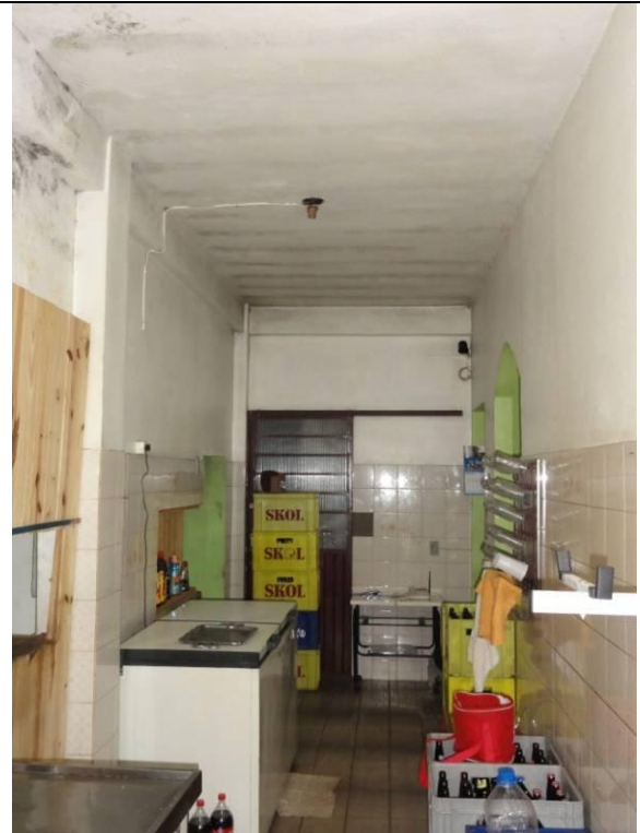
Parte 2 – Piso inferior – Lanchonete - Cozinha (DSC02560, 21/02/2011, 16:57h)
