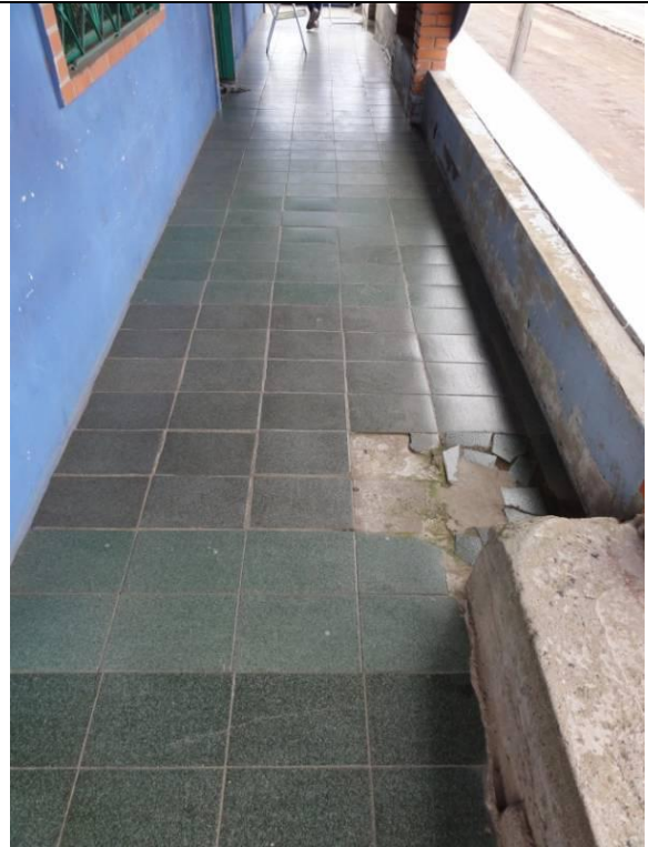
Piso Superior - Sacada (DSC03543, 23/02/2011, 09:32h)
