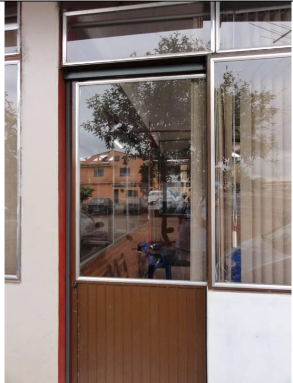
Fachada - Vidraça (DSC02770, 22/02/2011, 09:31h)
