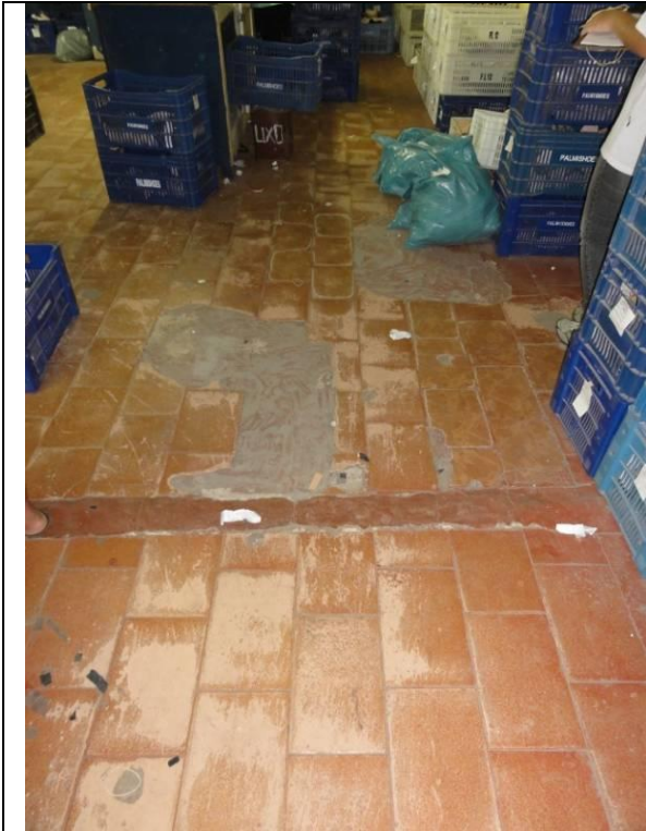
Piso Inferior – Fábrica (DSC03145, 22/02/2011, 16:39h)
