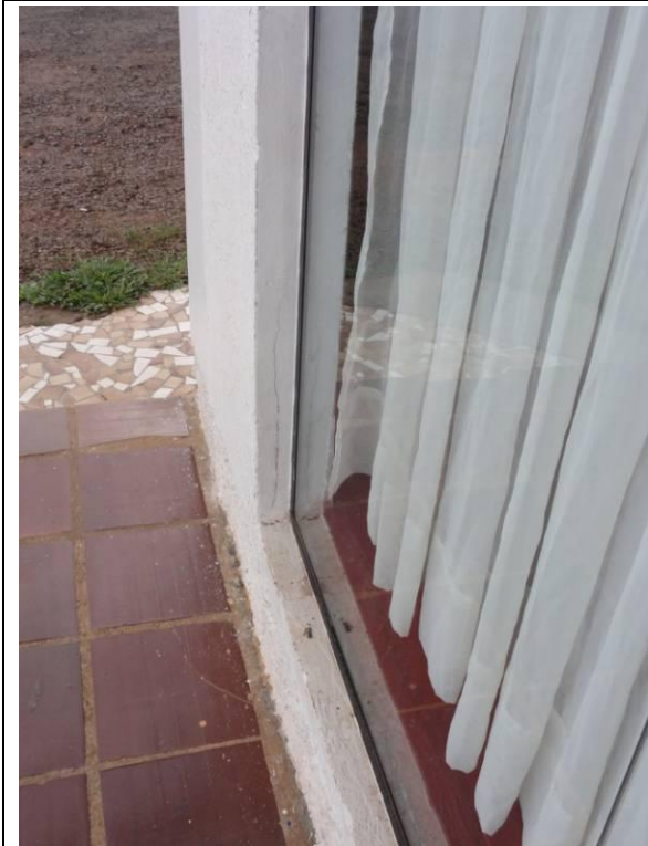
Parte 1 – Piso inferior – Igreja - Calçada (DSC02696, 21/02/2011, 17:47h)
