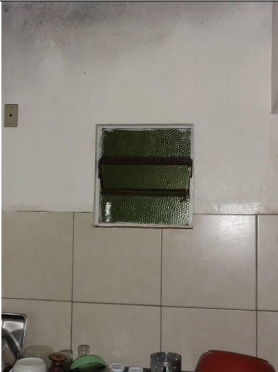
Parte 2 – Piso inferior (DSC02527, 21/02/2011, 16:50h)
