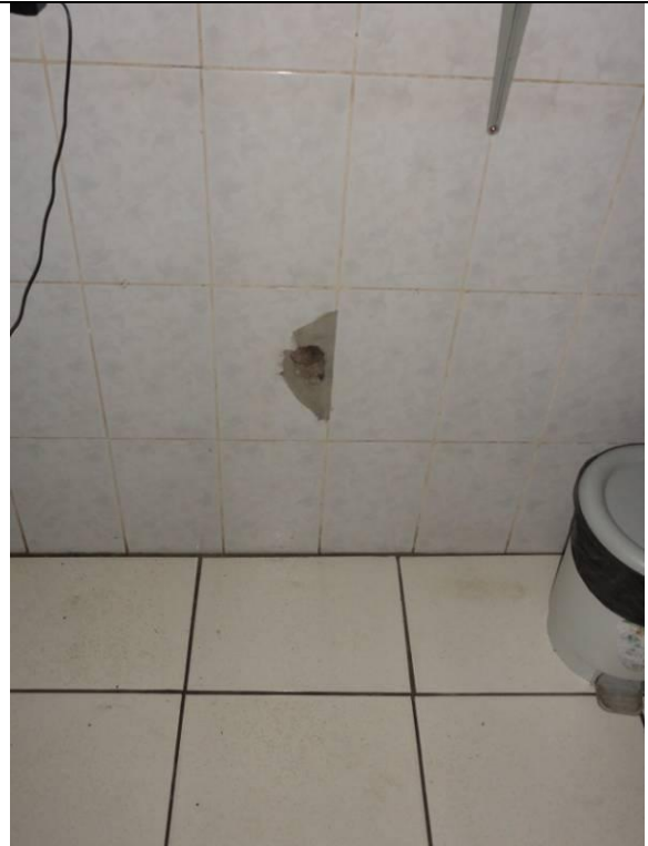
Parte 2 – Piso inferior – Lanchonete - Cozinha (DSC02564, 21/02/2011, 16:57h)
