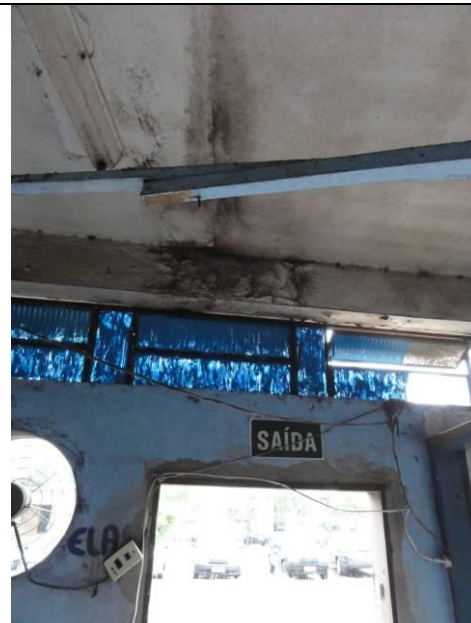
Piso Inferior - Fábrica (DSC03084, 22/02/2011, 11:22h)
