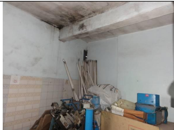
Piso Inferior – Fábrica (DSC03140, 22/02/2011, 16:38h)
