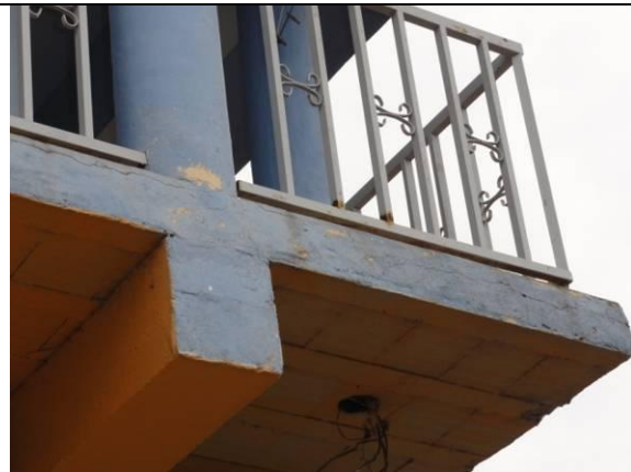
Lateral Direto – Parede D (DSC02287, 21/02/2011, 15:57h)
