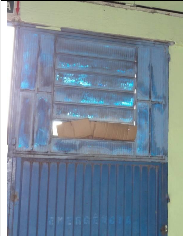
Piso Inferior – Fábrica – Parte 2 (DSC03249, 22/02/2011, 17:00h)
