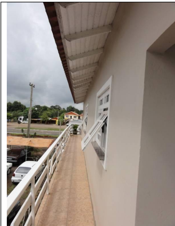
Piso superior - Sacada (DSC02904, 22/02/2011, 10:07h)
