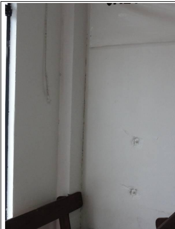
Parte 1 – Piso inferior – Igreja (DSC02694, 21/02/2011, 17:46h)
