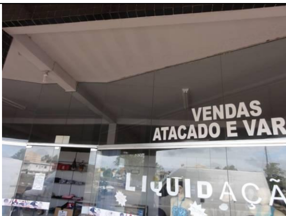
Fachada - Vidraças (DSC03364, 23/02/2011, 08:54h)
