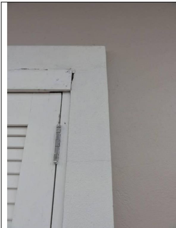
Piso superior – Sacada (DSC02956, 22/02/2011, 10:15h)
