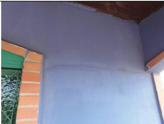
Piso Superior - Sacada (DSC03562, 23/02/2011, 09:35h)
