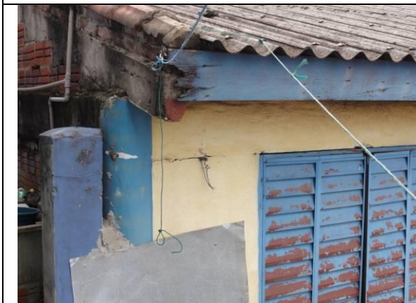
Piso Superior – Sacada (DSC03594, 23/02/2011, 09:39h)
