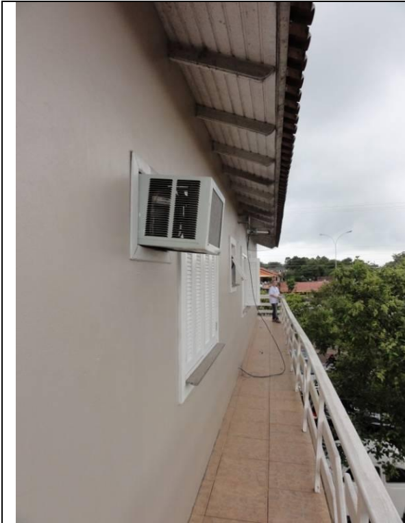
Piso superior – Sacada (DSC02950, 22/02/2011, 10:15h)
