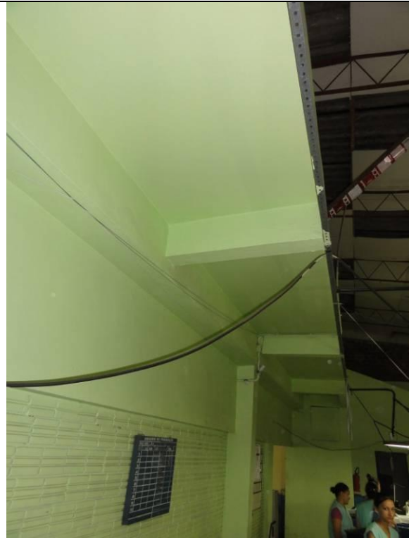
Piso Inferior – Fábrica – Parte 2 (DSC03180, 22/02/2011, 16:46h)
