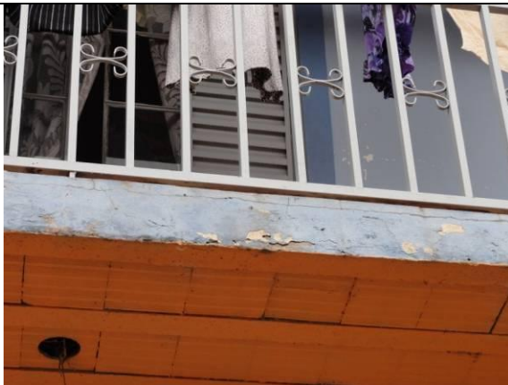
Lateral Direto – Parede D (DSC02286, 21/02/2011, 15:57h)
