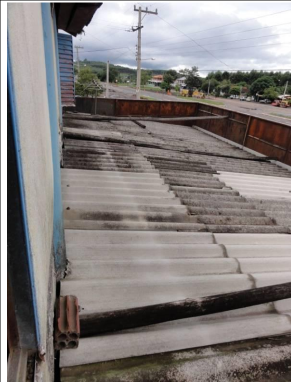
Piso superior (DSC03283, 22/02/2011, 17:07h)
