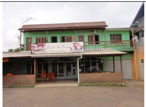
Parte 2 - Fachada (DSC02463, 21/02/2011, 16:38h)
