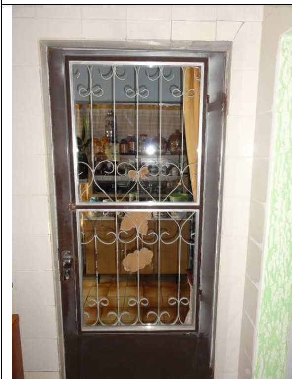
Piso superior - Cozinha (DSC02428, 21/02/2011, 16:31h)
