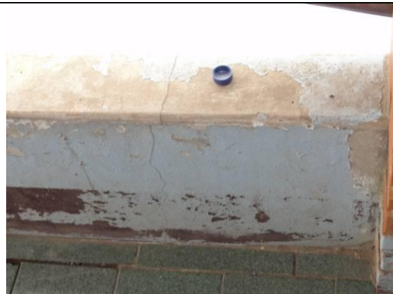
Piso Superior - Sacada (DSC03551, 23/02/2011, 09:33h)
