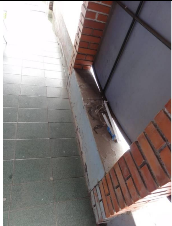
Piso Superior - Sacada (DSC03547, 23/02/2011, 09:33h)
