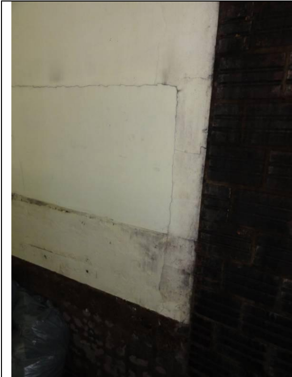
Piso Inferior – Fábrica – Parte 2 (DSC03217, 22/02/2011, 16:54h)
