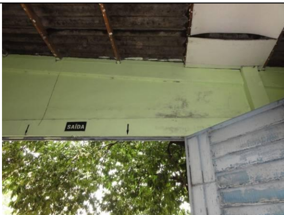
Piso Inferior – Fábrica – Parte 2 (DSC03231, 22/02/2011, 16:57h)
