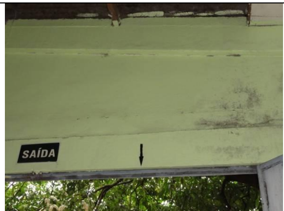
Piso Inferior – Fábrica – Parte 2 (DSC03232, 22/02/2011, 16:57h)
