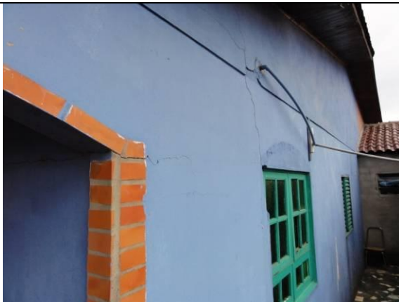
Piso Superior - Sacada (DSC03570, 23/02/2011, 09:36h)
