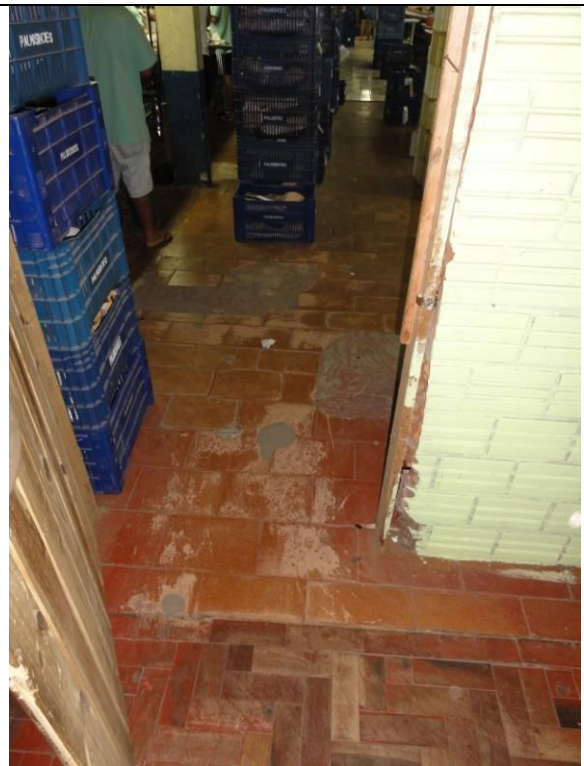
Piso Inferior – Fábrica – Parte 2 (DSC03182, 22/02/2011, 16:46h)
