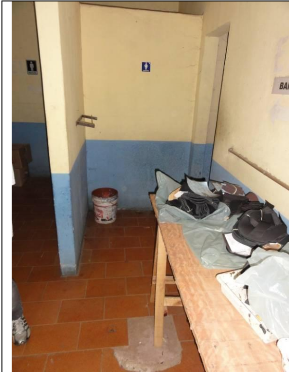
Piso Inferior – Fábrica – Parte 2 (DSC03189, 22/02/2011, 16:48h)
