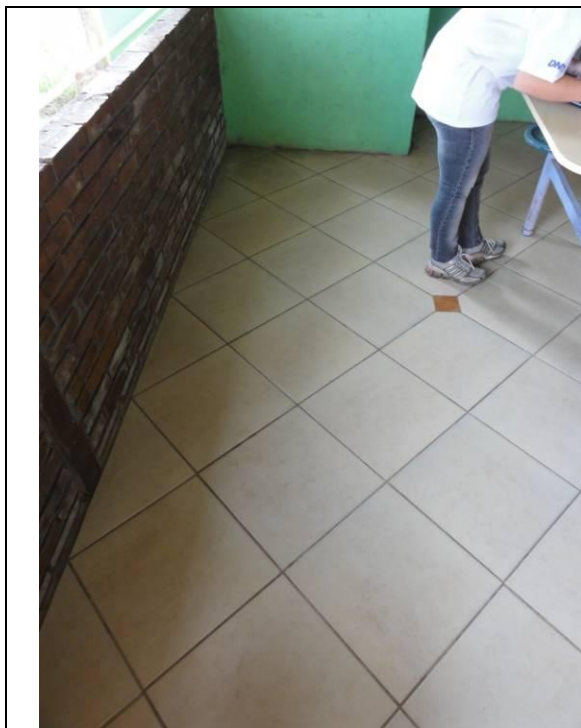
Parte 2 – Piso inferior – Lanchonete - Cobertura fachada (DSC02587, 21/02/2011, 17:02h)
