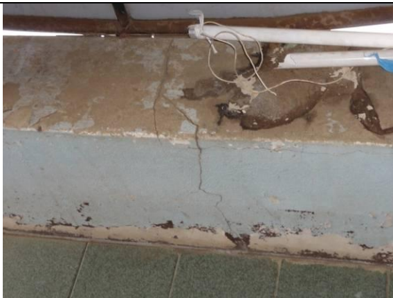
Piso Superior - Sacada (DSC03550, 23/02/2011, 09:33h)
