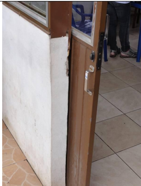
Fachada – Porta de entrada (DSC02764, 22/02/2011, 09:30h)
