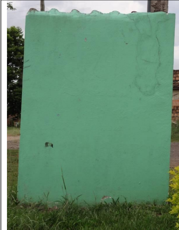
Parte 2 – Muro com caixa de luz (DSC02466, 21/02/2011, 16:39h)
