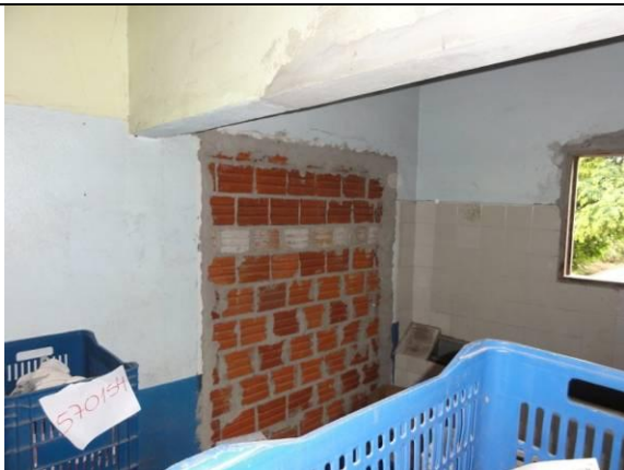
Piso Inferior – Fábrica (DSC03139, 22/02/2011, 16:38h)
