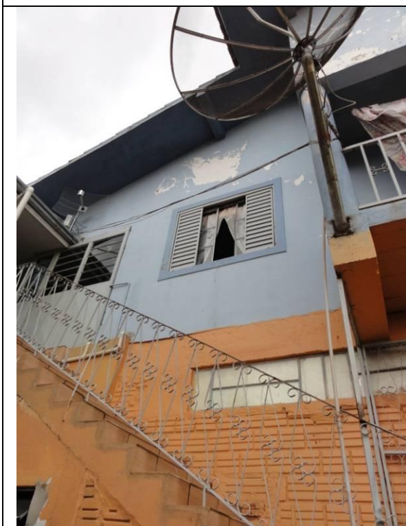
Lateral Direto – Parede D (DSC02290, 21/02/2011, 15:58h)
