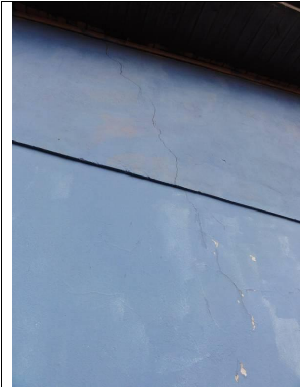
Piso Superior - Sacada (DSC03578, 23/02/2011, 09:37h)
