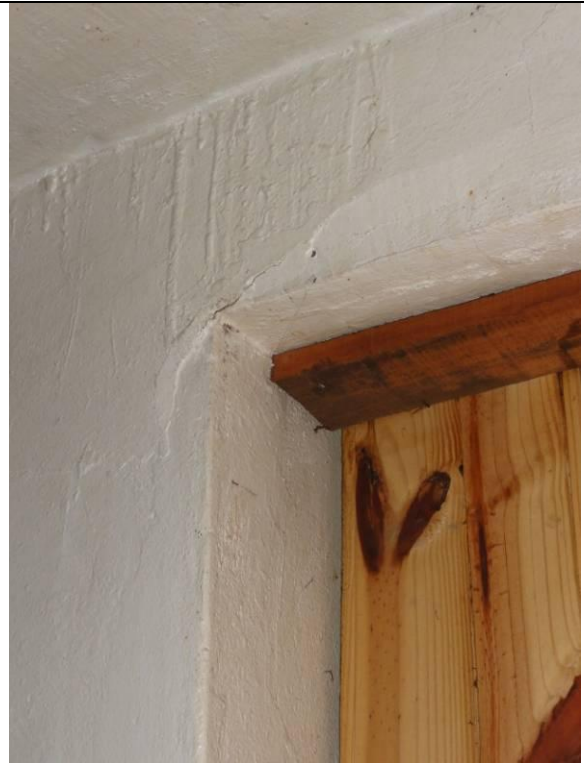
Parte 2 – Piso inferior – Lanchonete (DSC02554, 21/02/2011, 16:55h)
