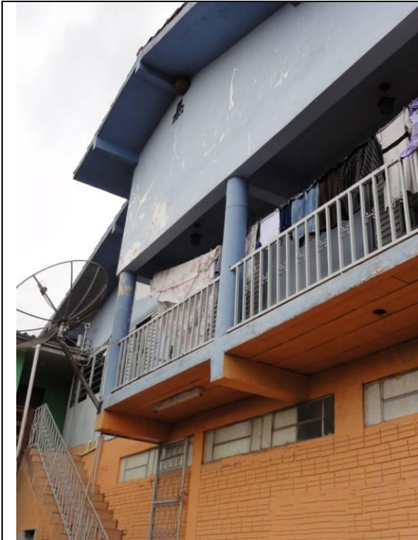
Lateral Direto – Parede D (DSC02284, 21/02/2011, 15:57h)
