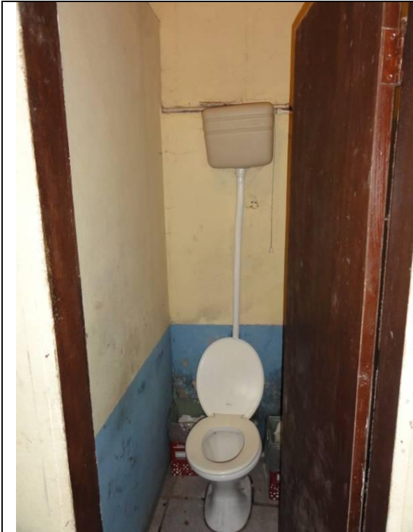
Piso Inferior – Fábrica – Parte 2 - WC (DSC03201, 22/02/2011, 16:51h)
