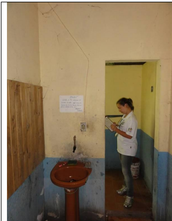
Piso Inferior – Fábrica – Parte 2 - WC (DSC03207, 22/02/2011, 16:51h)
