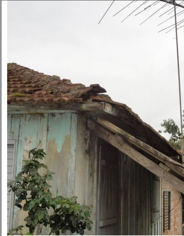
Telhado 2 (DSC02756, 22/02/2011, 09:25h)
