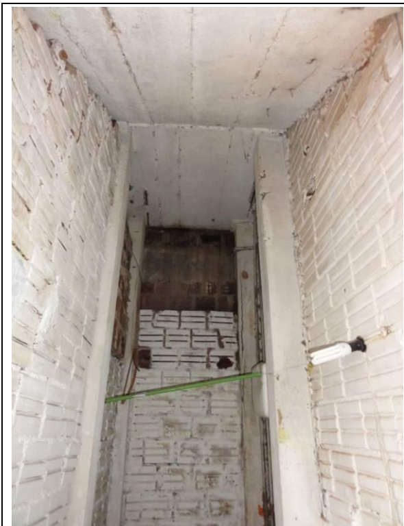
Parte 1 – Piso inferior – Igreja (DSC02684, 21/02/2011, 17:44h)
