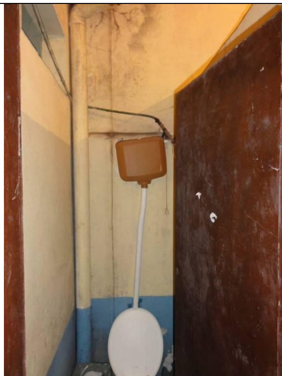
Piso Inferior – Fábrica – Parte 2 - WC (DSC03204, 22/02/2011, 16:51h)
