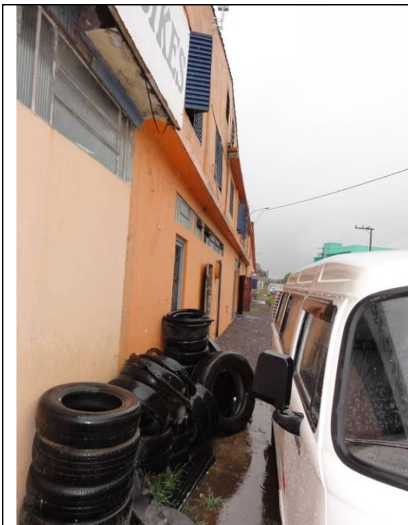
Lateral Esquerdo – Parede B (DSC03077, 22/02/2011, 11:18h)
