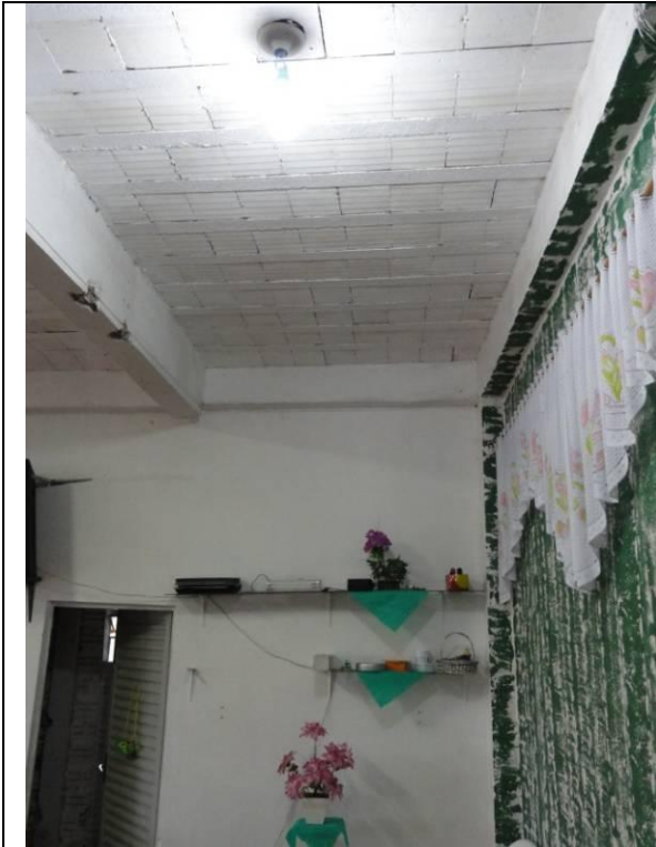
Parte 1 – Piso inferior – Igreja - Teto (DSC02676, 21/02/2011, 17:43h)
