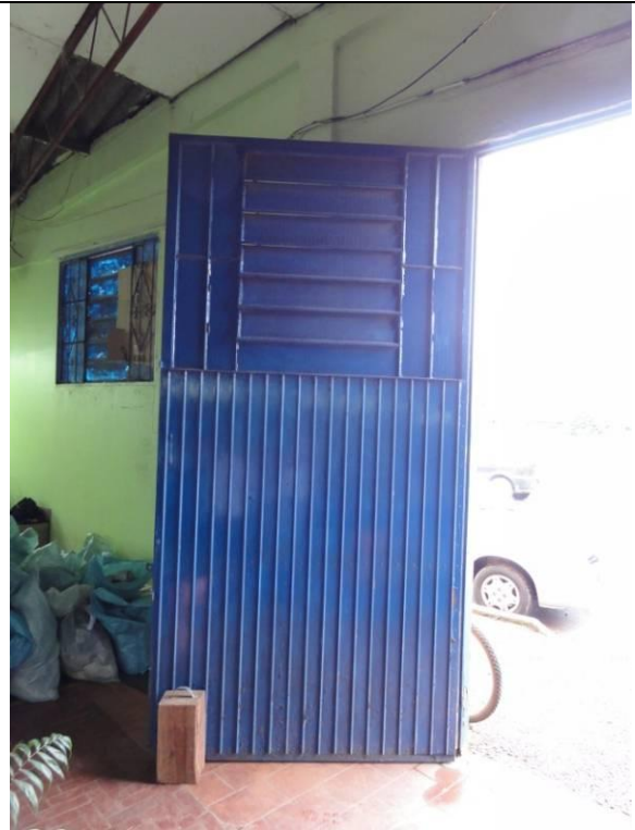
Piso Inferior – Fábrica – Parte 2 (DSC03250, 22/02/2011, 17:00h)
