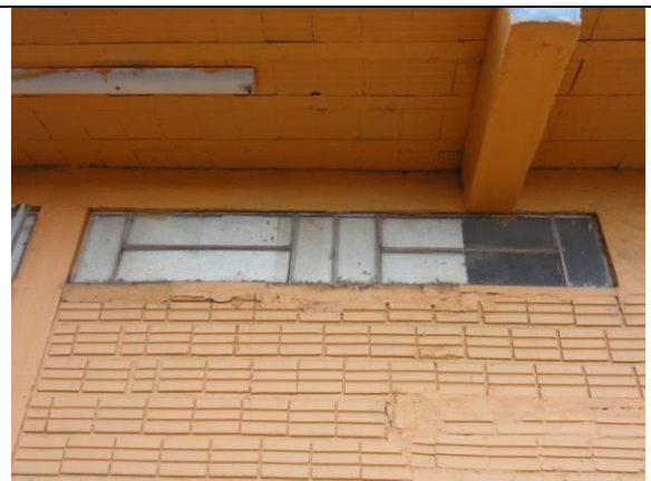
Lateral Direto – Parede D (DSC02267, 21/02/2011, 15:53h)
