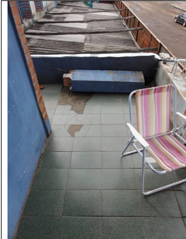
Piso Superior - Sacada (DSC03553, 23/02/2011, 09:34h)
