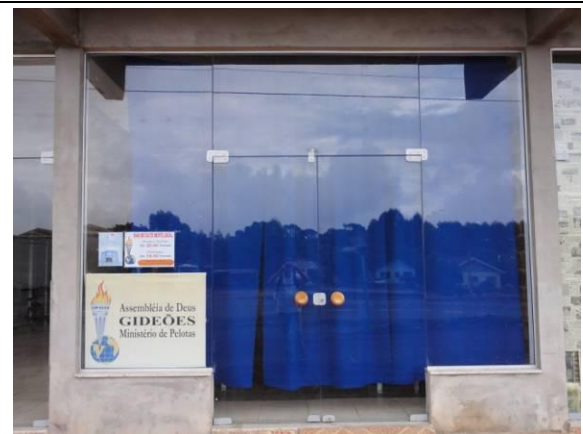
Fachada - Vidraças (DSC02723, 22/02/2011, 09:17h)
