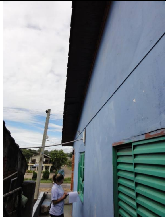
Piso Superior - Sacada (DSC03585, 23/02/2011, 09:37h)
