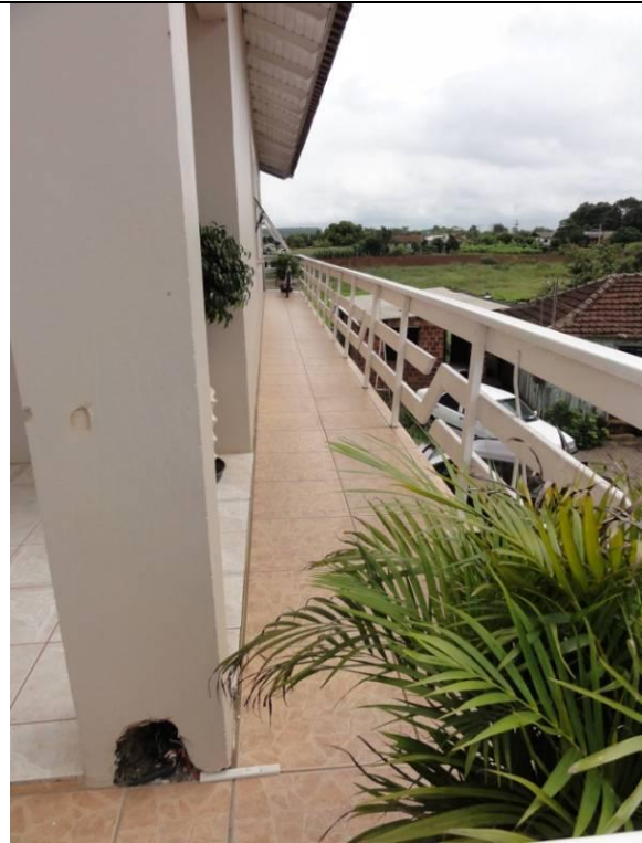
Piso superior - Sacada (DSC028953, 22/02/2011, 10:05h)
