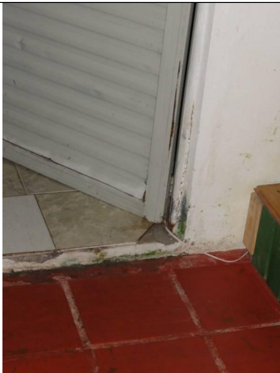
Parte 1 – Piso inferior – Igreja (DSC02680, 21/02/2011, 17:44h)
