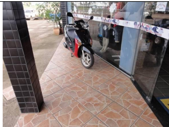
Fachada – Calçada Piso cerâmico (DSC03369, 23/02/2011, 08:55h)
