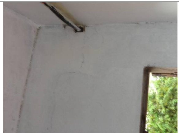
Piso Inferior – Fábrica (DSC03130, 22/02/2011, 16:36h)
