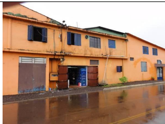
Lateral Esquerdo – Parede B (DSC03080, 22/02/2011, 11:20h)
