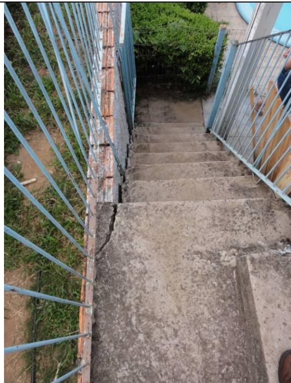
Parte 2 – Piso superior – Fundos - Escada (DSC02517, 21/02/2011, 16:48h)
