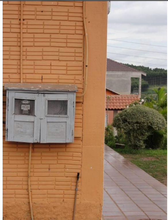
Lateral Direto – Parede D (DSC02297, 21/02/2011, 15:59h)
