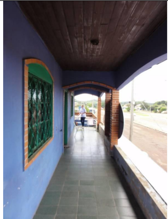
Piso Superior - Sacada (DSC03545, 23/02/2011, 09:33h)
