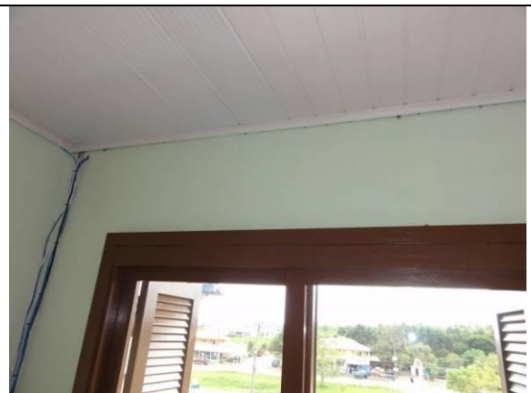
Parte 2 – Piso superior – Sala (DSC02497, 21/02/2011, 16:44h)
