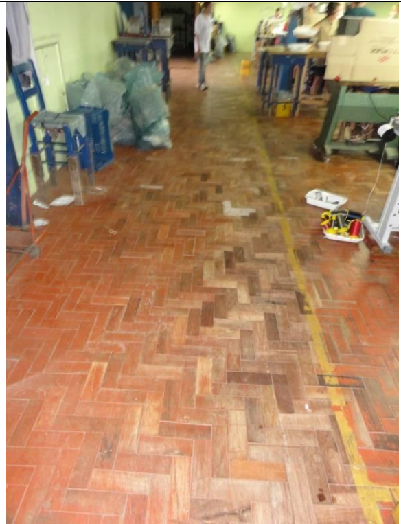
Piso Inferior – Fábrica – Parte 2 - Piso de taco (DSC03208, 22/02/2011, 16:52h)
