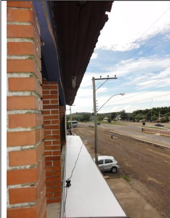
Piso Superior - Sacada (DSC03538, 23/02/2011, 09:32h)
