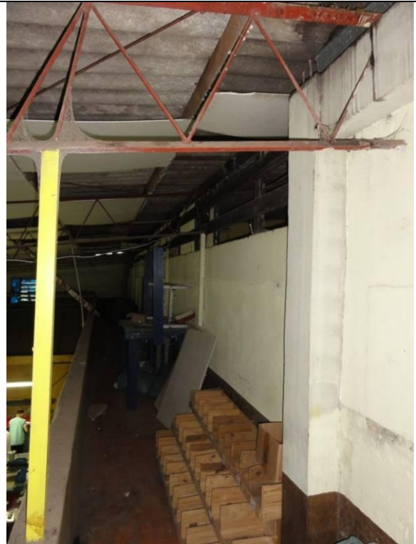
Piso Inferior – Fábrica – Parte 2 (DSC03218, 22/02/2011, 16:54h)
