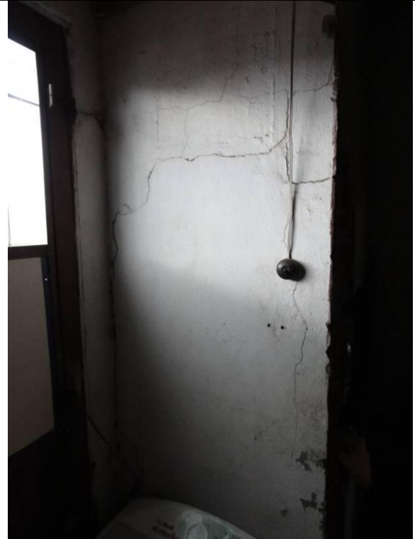
Piso Inferior – Borracharia (DSC03069, 22/02/2011, 11:03h)
