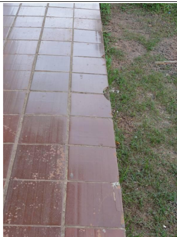
Parte 1 – Piso inferior – Igreja- Calçada (DSC02695, 21/02/2011, 17:46h)
