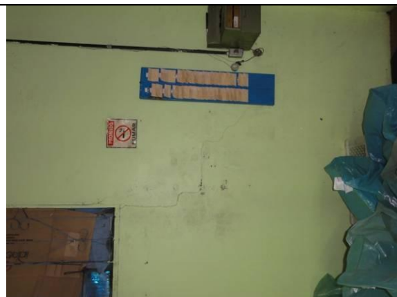
Piso Inferior – Fábrica – Parte 2 (DSC03242, 22/02/2011, 16:59h)
