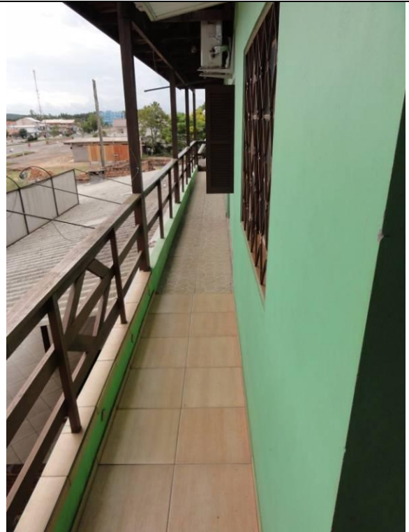
Parte 2 - Piso superior - Sacada (DSC02461, 21/02/2011, 16:37h)
