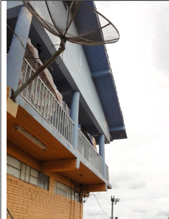
Lateral Direto – Parede D (DSC02274, 21/02/2011, 15:55h)
