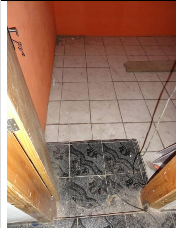
Piso Inferior – Salão 1 – Quarto 1 (DSC03508, 23/02/2011, 09:24h)
