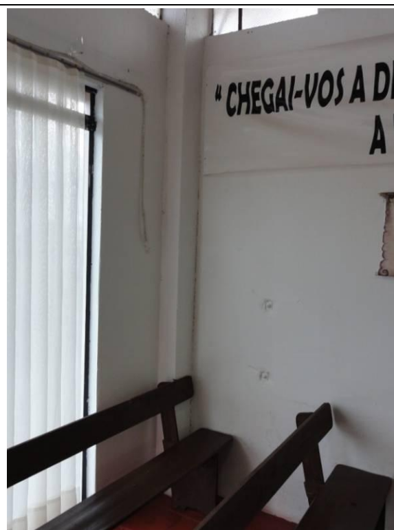
Parte 1 – Piso inferior – Igreja (DSC02693, 21/02/2011, 17:46h)
