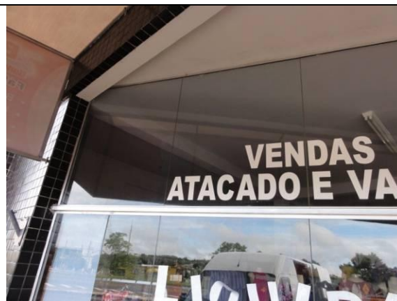
Fachada - Vidraças (DSC03365, 23/02/2011, 08:54h)
