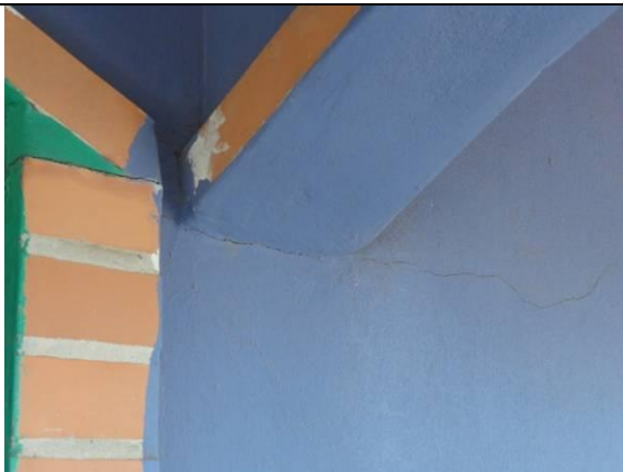
Piso Superior - Sacada (DSC03556, 23/02/2011, 09:34h)
