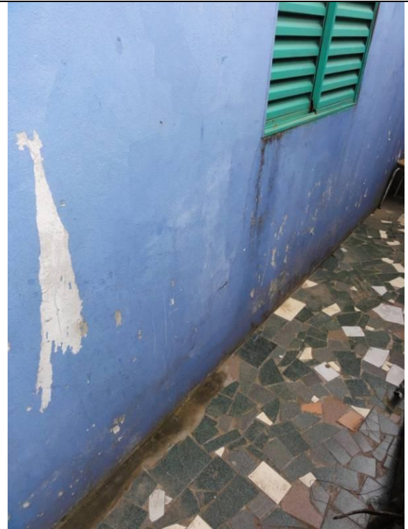
Piso Superior - Sacada (DSC03581, 23/02/2011, 09:37h)
