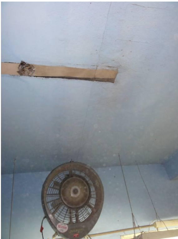
Piso Inferior – Fábrica – WC (DSC03095, 22/02/2011, 11:24h)
