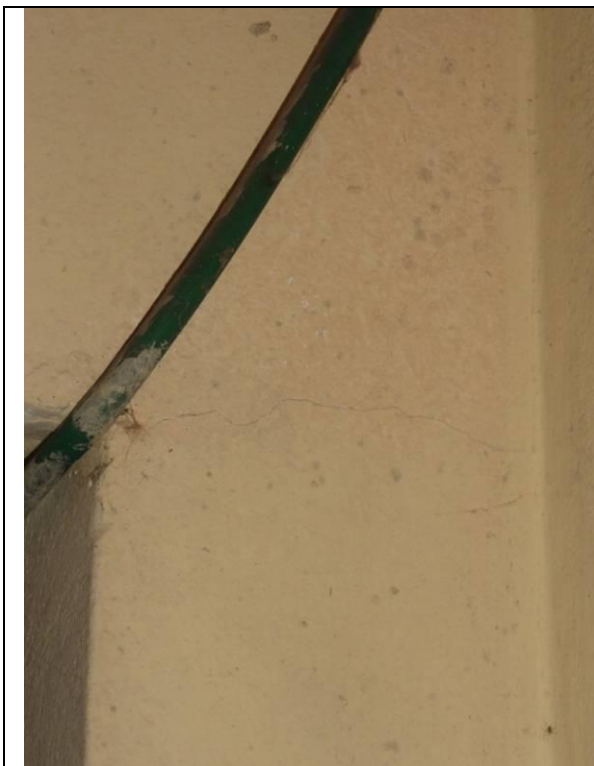
Piso Inferior – Fábrica – Parte 2 - WC (DSC03203, 22/02/2011, 16:51h)
