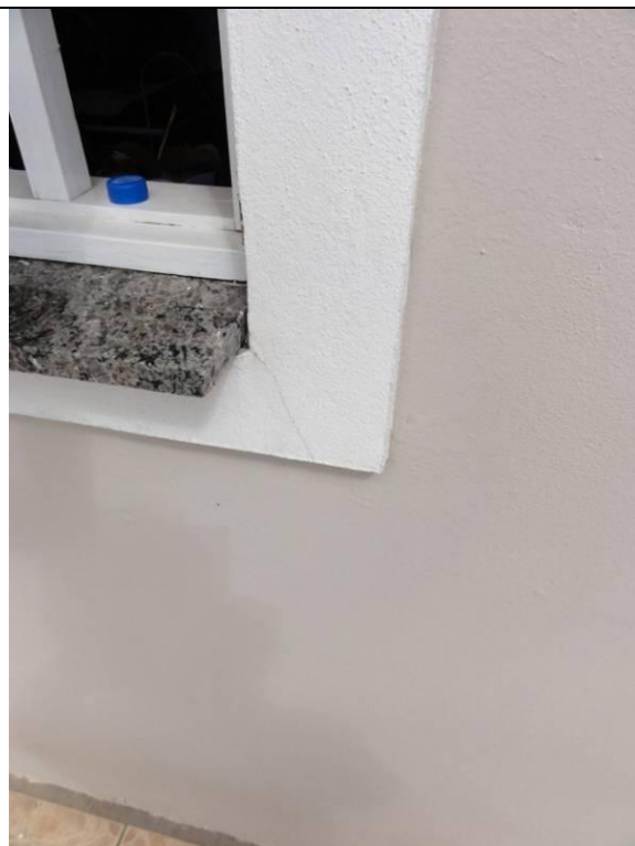
Piso superior - Sacada (DSC02905, 22/02/2011, 10:07h)
