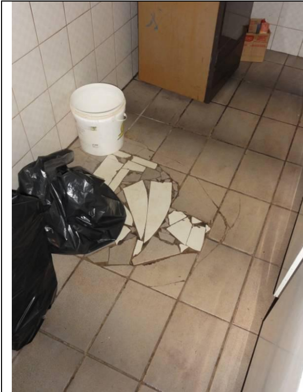
Parte 2 – Piso inferior – Lanchonete - Cozinha (DSC02559, 21/02/2011, 16:57h)
