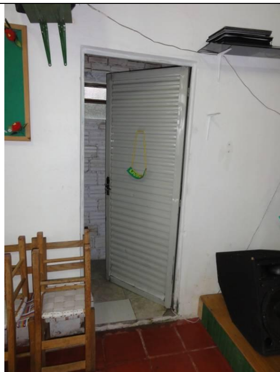
Parte 1 – Piso inferior – Igreja (DSC02679, 21/02/2011, 17:43h)
