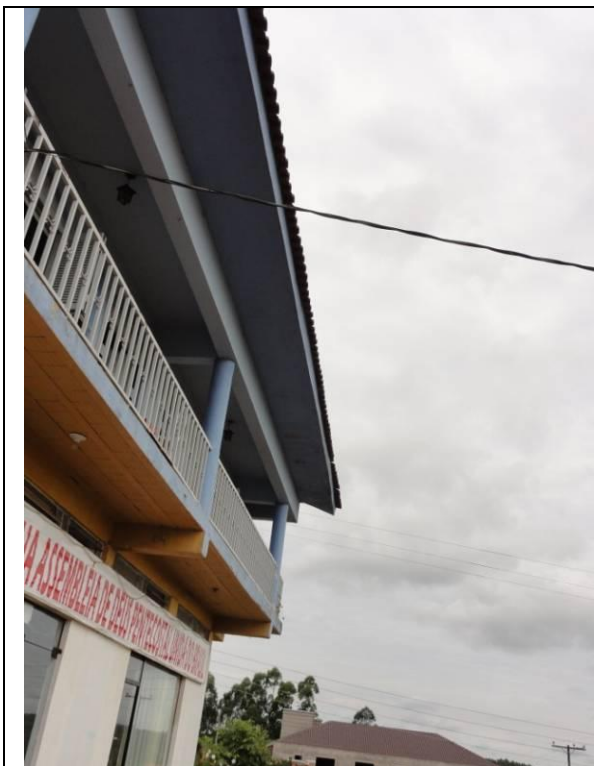
Parte 1 - Marquise (DSC02468, 21/02/2011, 16:39h)
