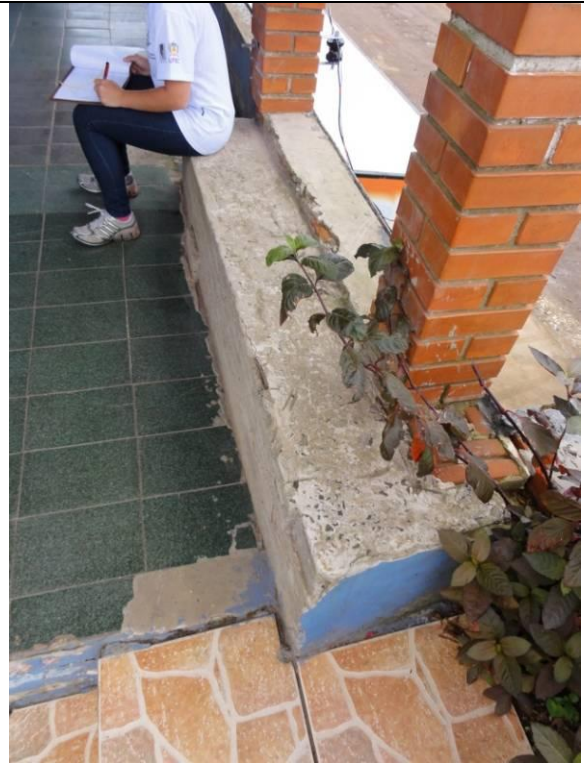
Piso Superior - Sacada (DSC03539, 23/02/2011, 09:32h)
