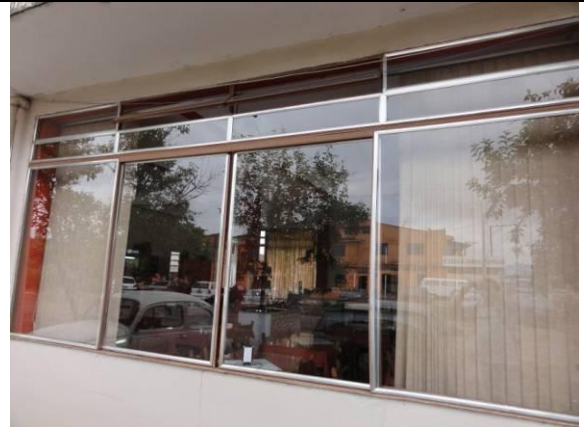
Fachada - Vidraça (DSC02772, 22/02/2011, 09:31h)
