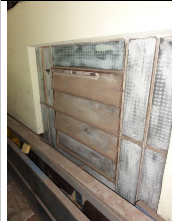
Piso Inferior – Fábrica – Parte 2 (DSC03227, 22/02/2011, 16:55h)
