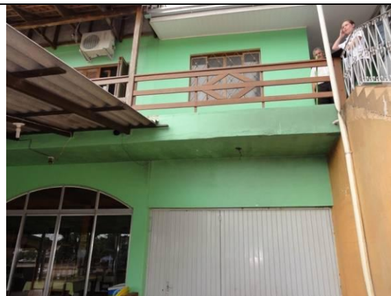
Parte 2 - Fachada (DSC02473, 21/02/2011, 16:40h)
