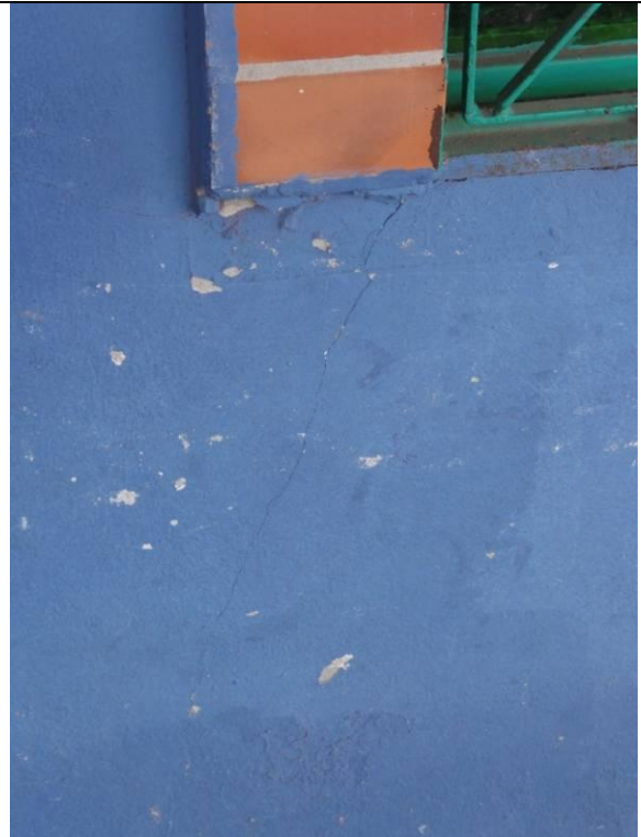
Piso Superior - Sacada (DSC03559, 23/02/2011, 09:34h)
