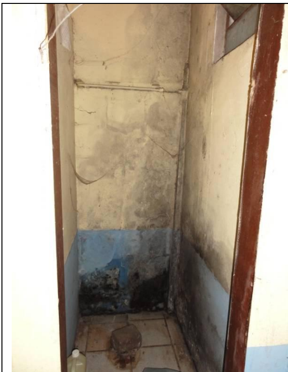
Piso Inferior – Fábrica – Parte 2 - WC (DSC03199, 22/02/2011, 16:50h)
