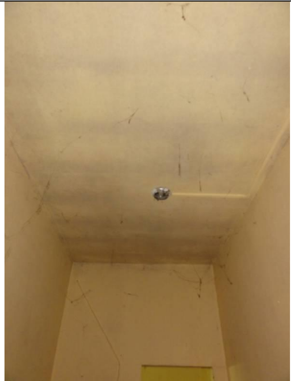
Piso Inferior – Fábrica – Parte 2 - WC (DSC03206, 22/02/2011, 16:51h)
