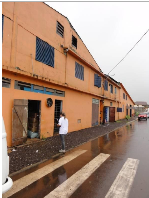
Lateral Esquerdo – Parede B (DSC03078, 22/02/2011, 11:18h)
