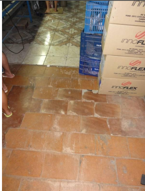
Piso Inferior – Fábrica - Piso cerâmico (DSC03164, 22/02/2011, 16:42h)
