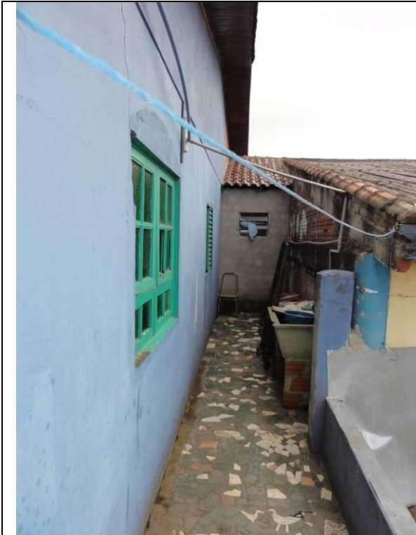
Piso Superior - Sacada (DSC03568, 23/02/2011, 09:35h)
