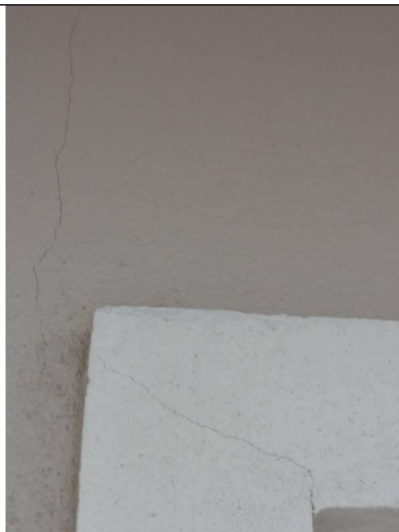
Piso superior - Sacada (DSC02909, 22/02/2011, 10:07h)
