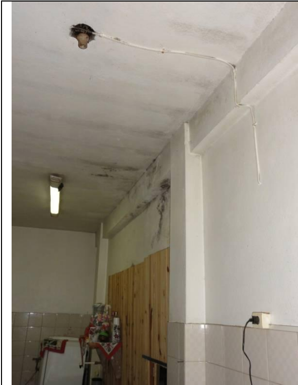
Parte 2 – Piso inferior – Lanchonete - Cozinha (DSC02557, 21/02/2011, 16:56h)
