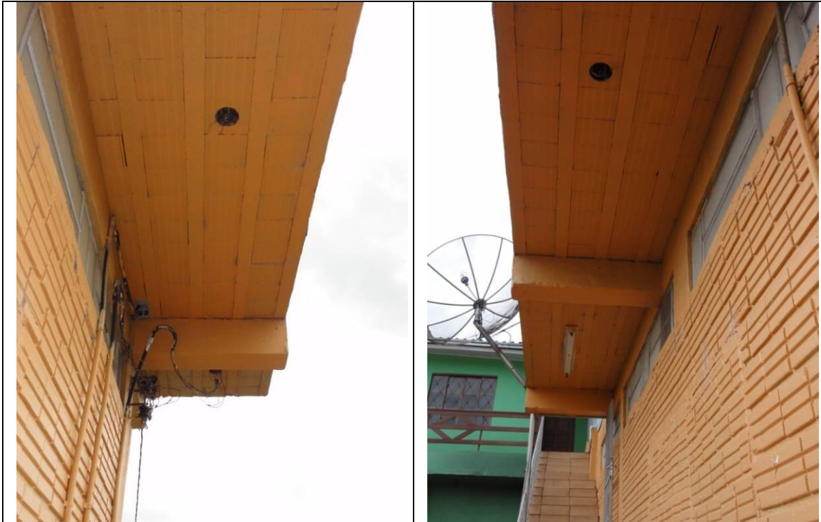
Lateral Direto – Parede D - Marquise (DSC02276, 21/02/2011, 15:55h)
