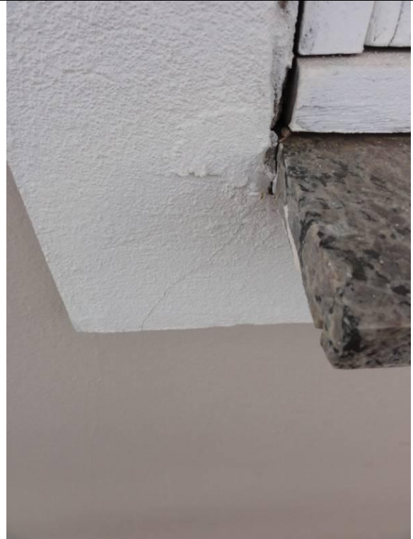
Piso superior – Sacada (DSC02953, 22/02/2011, 10:15h)
