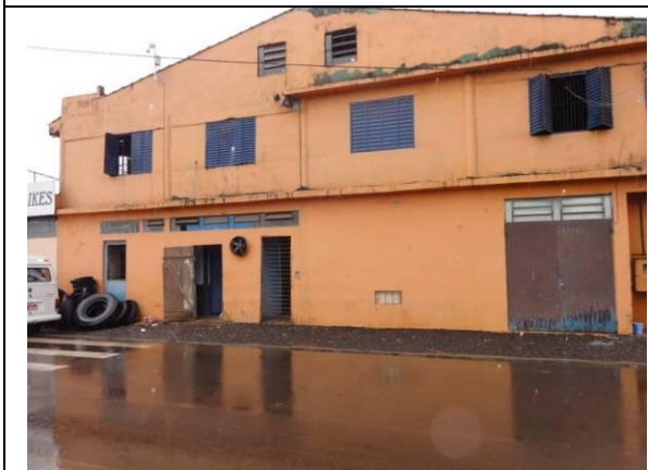
Lateral Esquerdo – Parede B (DSC03079, 22/02/2011, 11:20h)
