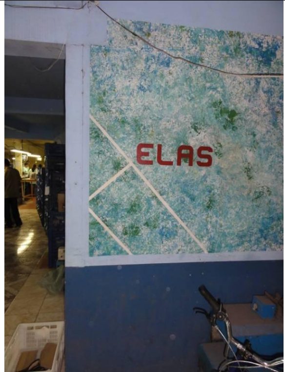
Piso Inferior – Fábrica – WC (DSC03094, 22/02/2011, 11:24h)
