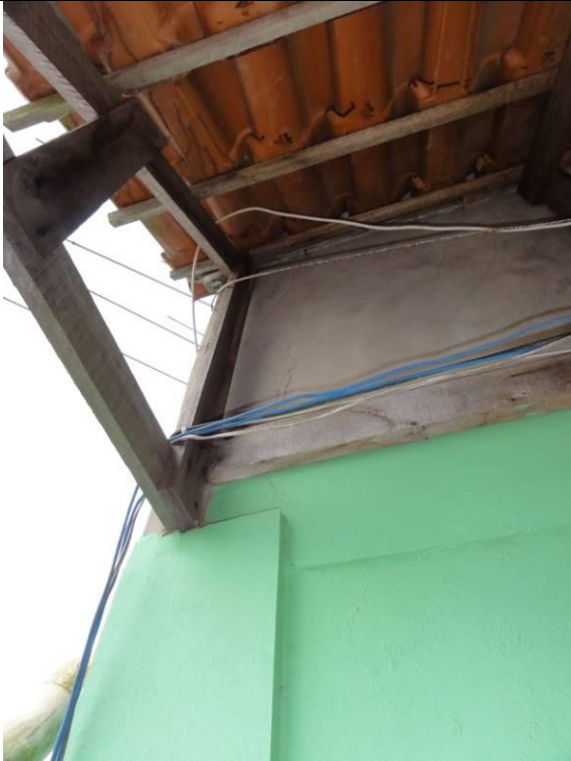
Parte 2 – Piso superior – Sacada - Marquise (DSC02492, 21/02/2011, 16:43h)
