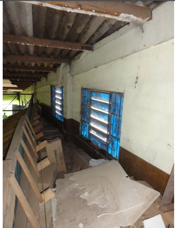
Piso Inferior – Fábrica – Parte 2 (DSC03228, 22/02/2011, 16:56h)
