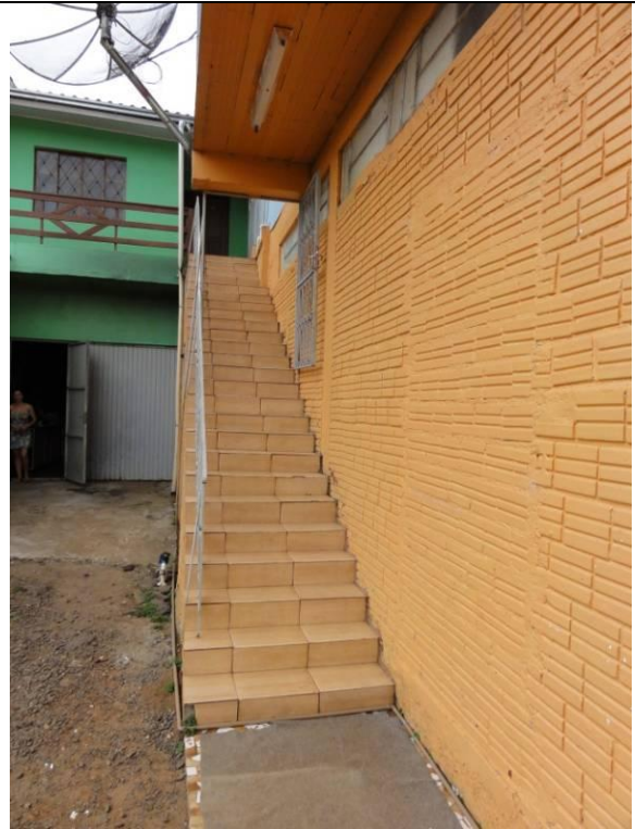
Lateral Direto – Parede D – Escada (DSC02265, 21/02/2011, 15:53h)
