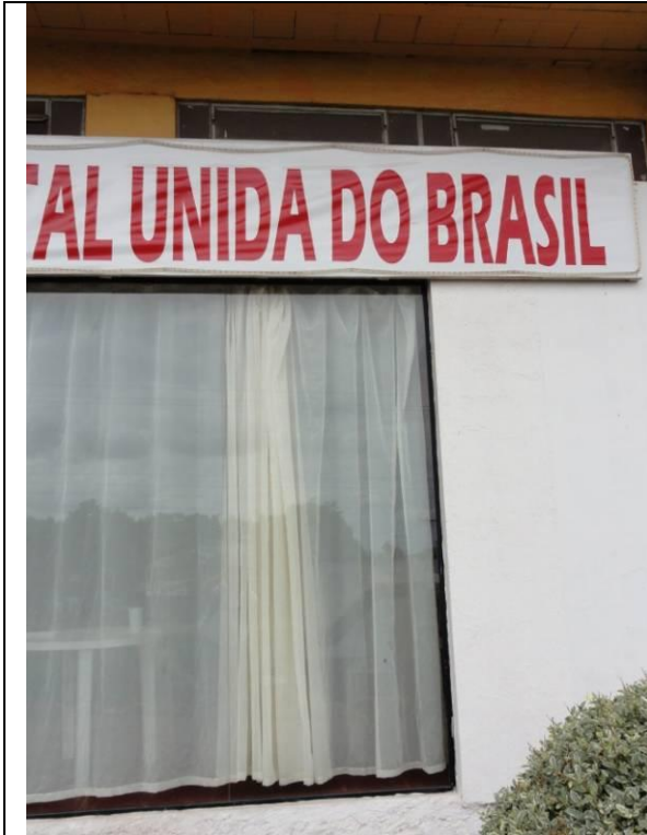
Fachada - Vidraças (DSC02230, 21/02/2011, 15:48h)
