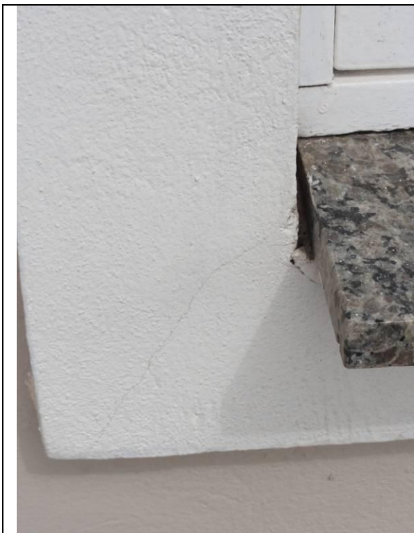
Piso superior - Sacada (DSC02908, 22/02/2011, 10:07h)
