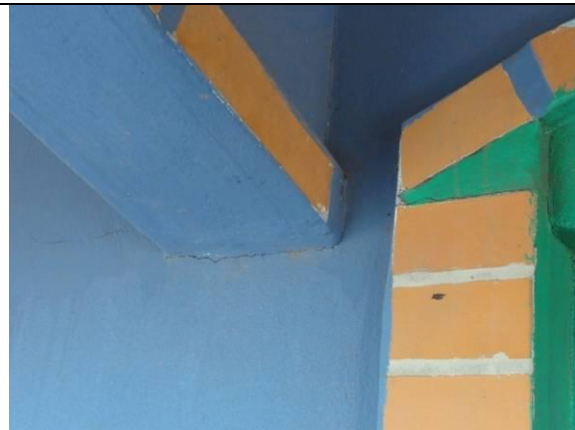
Piso Superior - Sacada (DSC03557, 23/02/2011, 09:34h)
