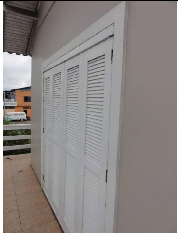
Piso superior – Sacada (DSC02925, 22/02/2011, 10:10h)
