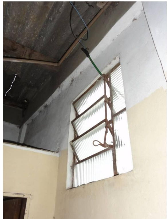
Piso superior (DSC03307, 22/02/2011, 17:10h)
