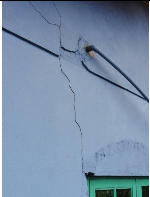
Piso Superior - Sacada (DSC03573, 23/02/2011, 09:36h)
