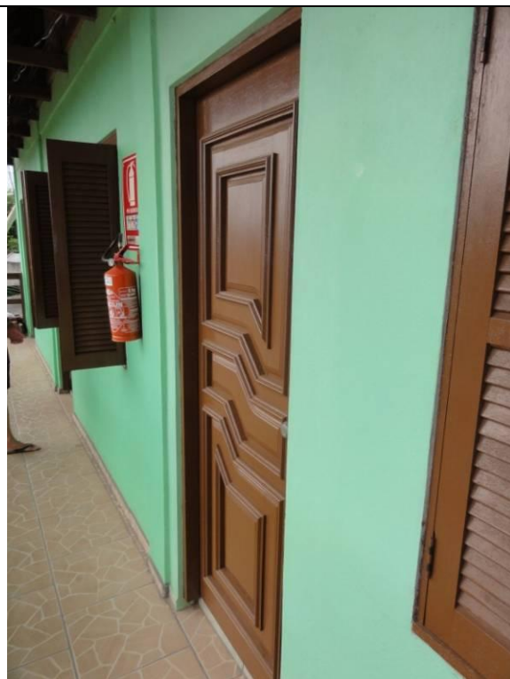
Parte 2 – Piso superior – Sacada (DSC02489, 21/02/2011, 16:43h)
