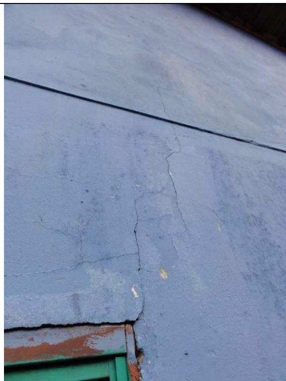
Piso Superior – Sacada (DSC03591, 23/02/2011, 09:38h)
