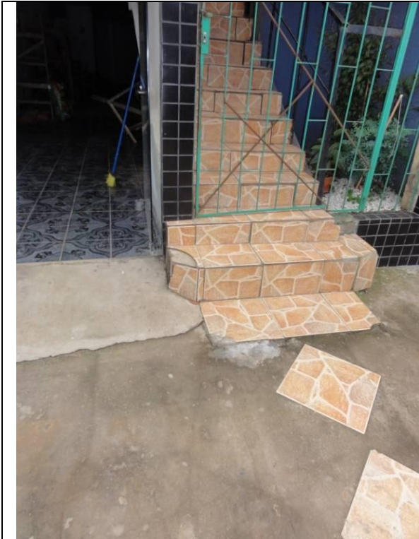
Piso Inferior – Escada (DSC03520, 23/02/2011, 09:27h)
