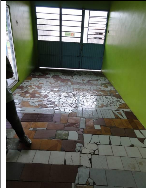
Parte 2 – Piso inferior (DSC02524, 21/02/2011, 16:50h)
