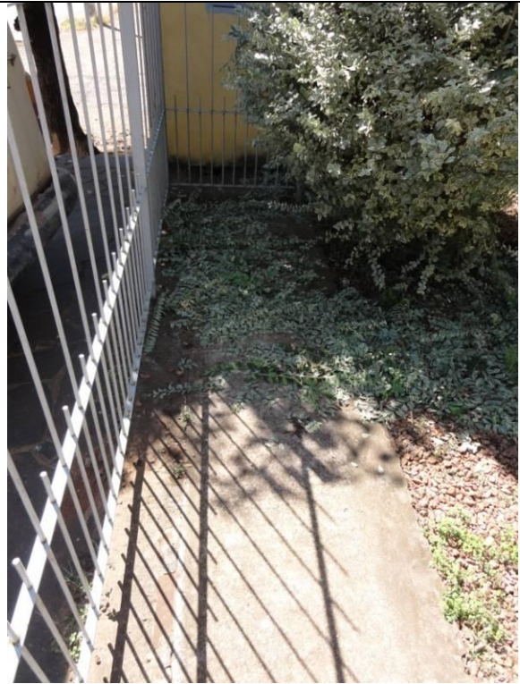
Calçada (DSC01410, 17/02/2011, 10:02h)
