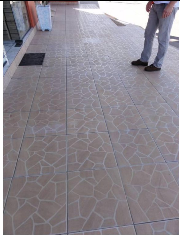
Fundos – Loja – Calçada de piso cerâmico (DSC00763, 16/02/2011, 10:02h)
