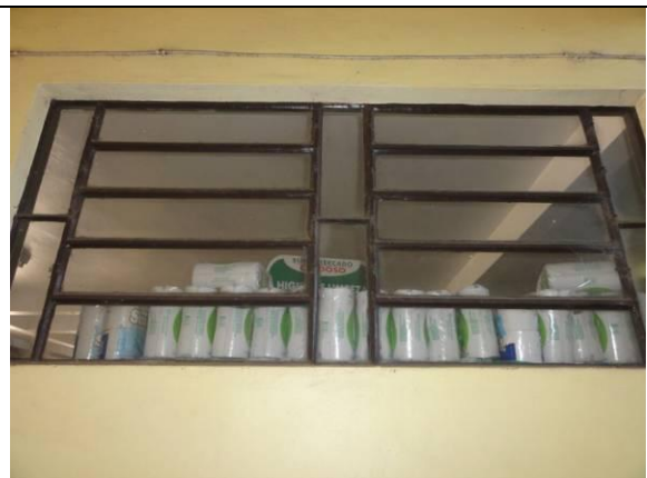
Piso inferior - Parede B – Externo - Janela (DSC01310, 17/02/2011, 08:56h)
