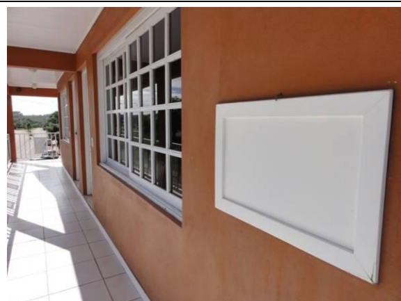
Piso superior – Sacada (DSC00673, 16/02/2011, 09:33h)
