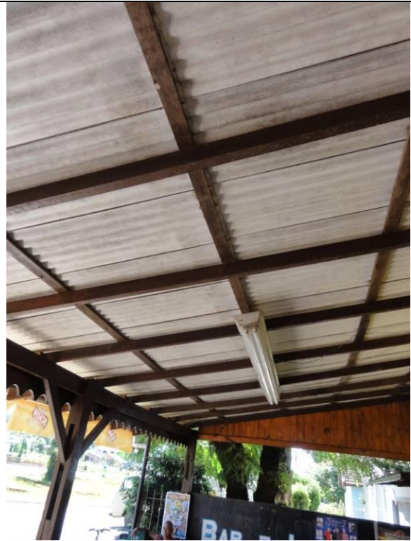
Entrada Bar – Telhado (DSC01398, 17/02/2011, 09:54h)
