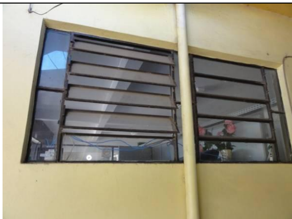
Piso inferior - Parede B – Externo - Janela (DSC01309, 17/02/2011, 08:56h)
