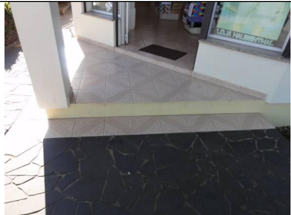
Entrada piso inferior (DSC01219, 17/02/2011, 08:14h)
