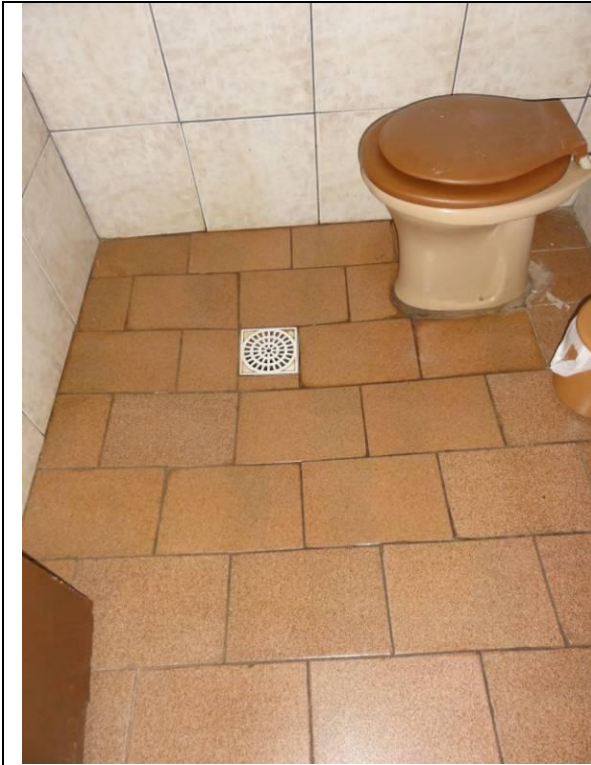
Bar - Banheiro (DSC00842, 16/02/2011, 10:26h)
