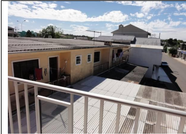
Telhado (DSC00760, 16/02/2011, 09:59h)
