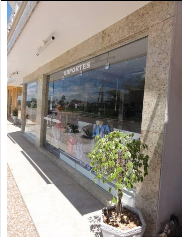
Fachada – Vidraças (DSC00913, 16/02/2011, 13:22h)
