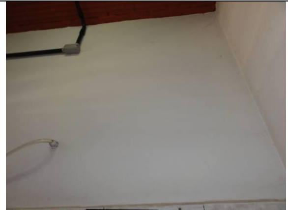
Bar - Banheiro (DSC00841, 16/02/2011, 10:26h)
