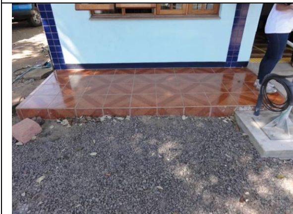
Fachada Correio – Piso cerâmico (DSC02192, 18/02/2011, 10:01h)
