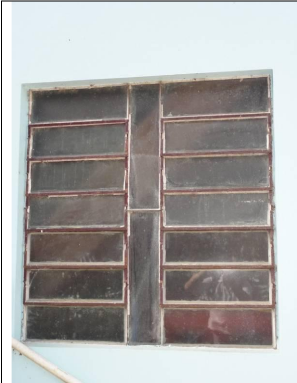
Piso inferior - Fundos (DSC01610, 17/02/2011, 15:43h)
