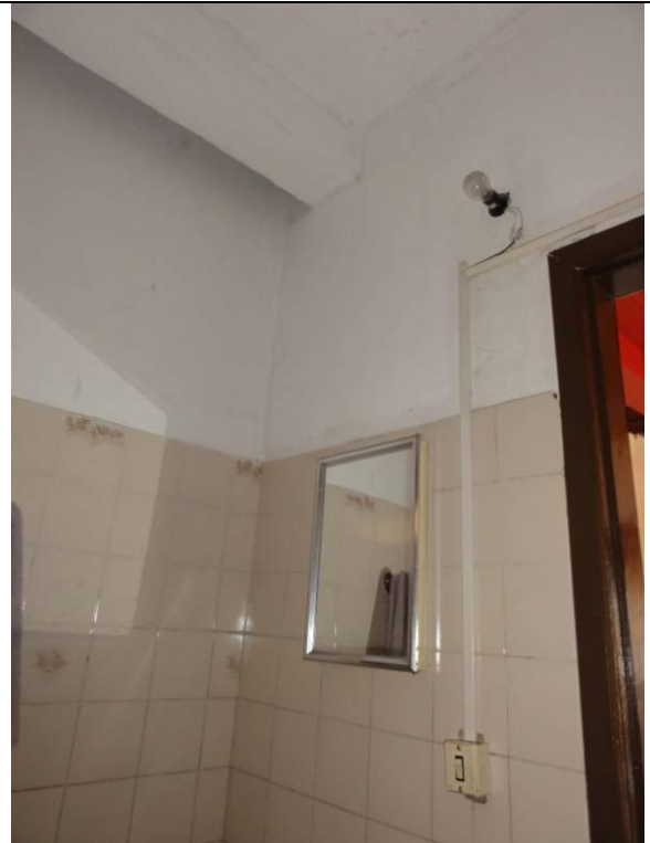
Bar - Banheiro (DSC00827, 16/02/2011, 10:21h)
