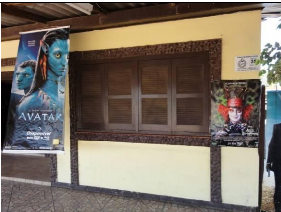
Fachada – Parede A - Janela (DSC01283, 17/02/2011, 08:47h)
