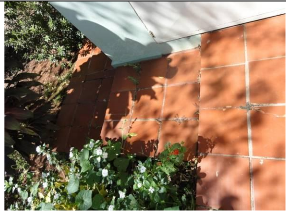
Parede D – Lateral Direita – Piso cerâmico (DSC01450, 17/02/2011, 10:25h)
