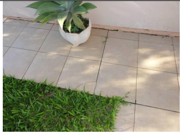
Calçada em torno da casa (DSC01161, 17/02/2011, 07:46h)
