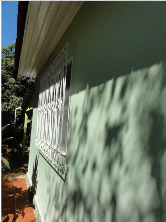
Parede D – Lateral Direita (DSC01451, 17/02/2011, 10:25h)
