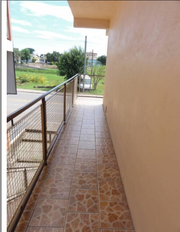
Piso superior – Sacada (DSC00862, 16/02/2011, 10:35h)
