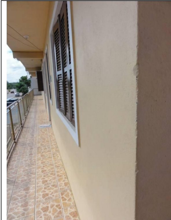
Piso superior – Sacada (DSC00866, 16/02/2011, 10:36h)
