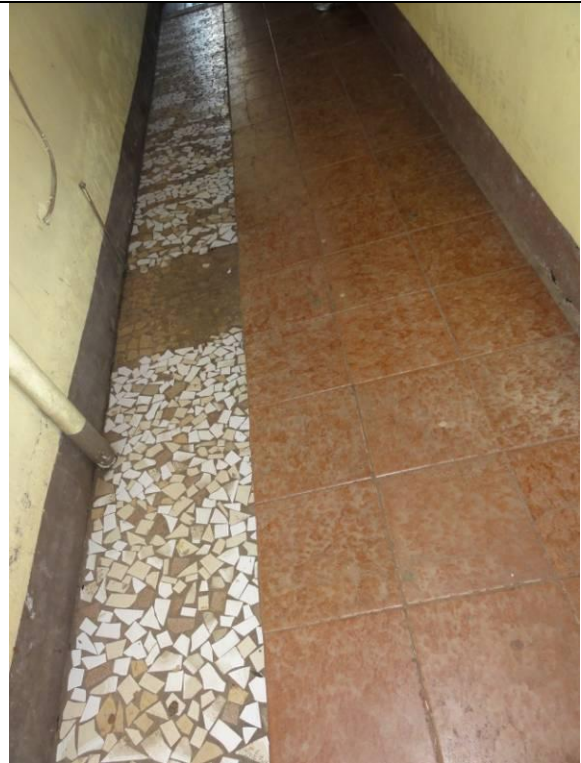
Piso inferior - Lateral B – Piso cerâmico (DSC01312, 17/02/2011, 08:56h)
