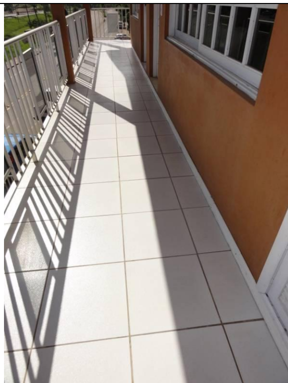
Piso superior – Sacada (DSC00671, 16/02/2011, 09:33h)
