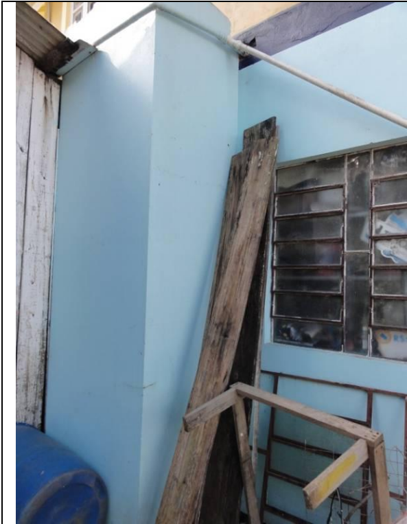
Piso inferior - Fundos (DSC01606, 17/02/2011, 15:42h)
