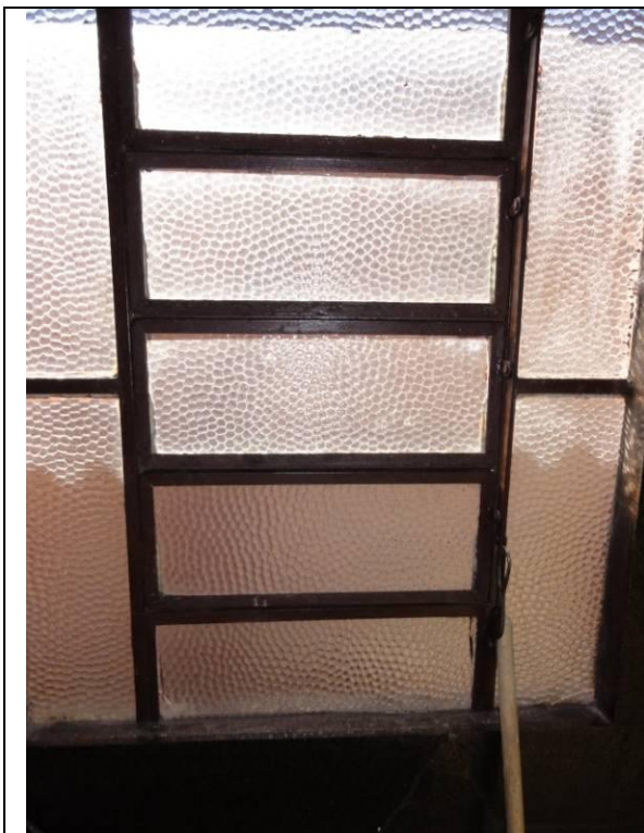
Parede D interna - Janela (DSC01403, 17/02/2011, 09:56h)
