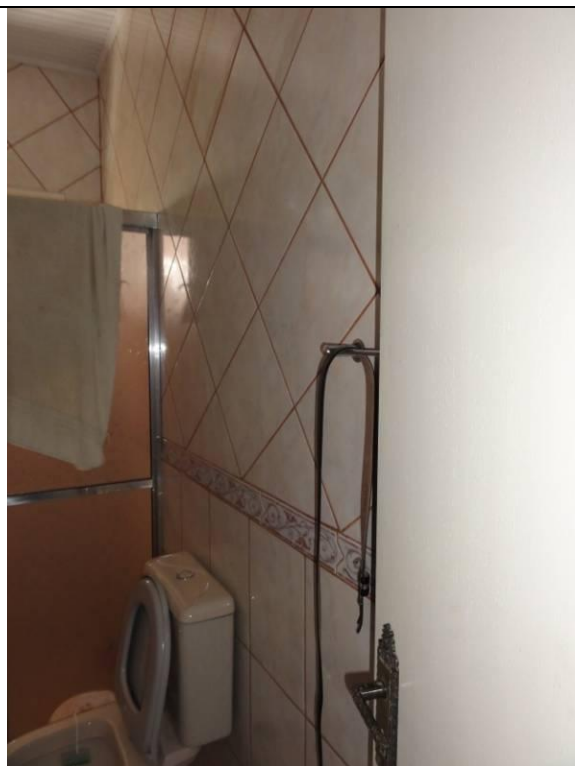
Piso superior – Banheiro (DSC00747, 16/02/2011, 09:54h)
