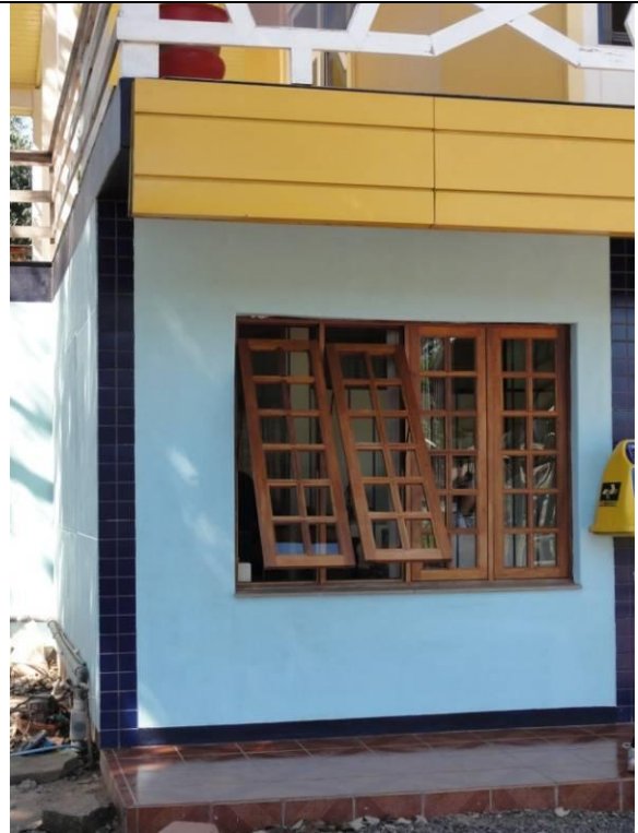
Fachada Correio – Janela (DSC02191, 18/02/2011, 10:01h)
