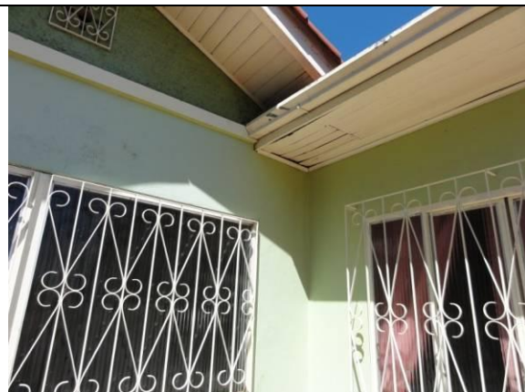
Parede D – Lateral Direita (DSC01448, 17/02/2011, 10:24h)
