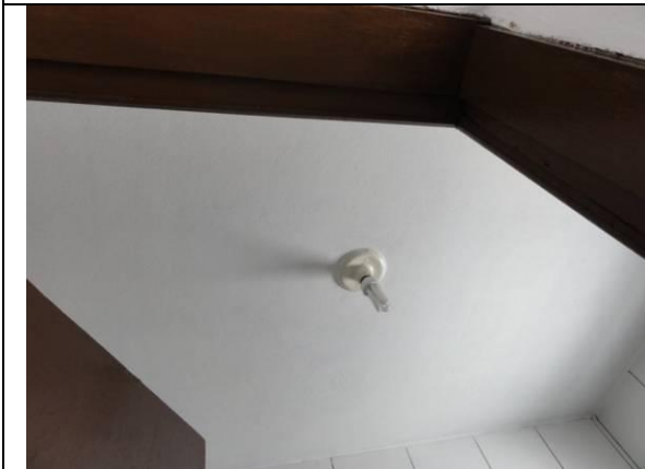
Piso superior – Apto 1 – Area de Serviço (DSC00874, 16/02/2011, 10:39h)
