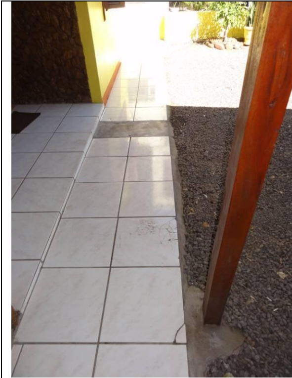
Entrada Casa – Piso cerâmico (DSC01351, 17/02/2011, 09:34h)
