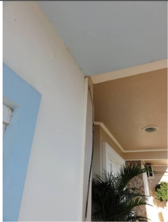
Piso superior - Sacada (DSC01140, 17/02/2011, 07:32h)
