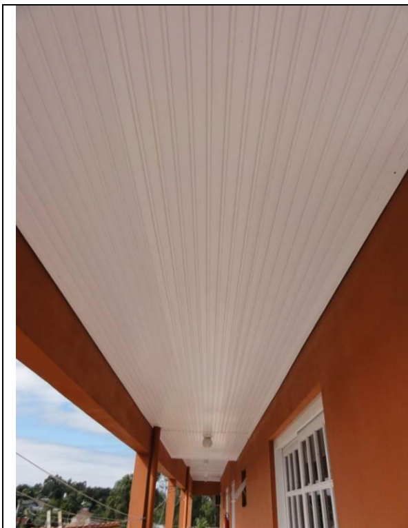
Piso superior – Sacada – Teto com forro PVC (DSC00688, 16/02/2011, 09:39h)
