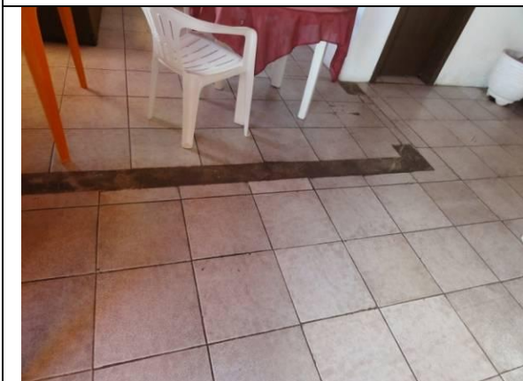
Bar – Piso cerâmico (DSC00818, 16/02/2011, 10:20h)
