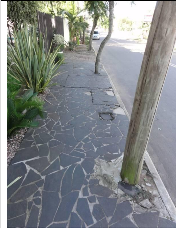
Lateral B – Calçada – Pedras quebradas (DSC01210, 17/02/2011, 08:12h)
