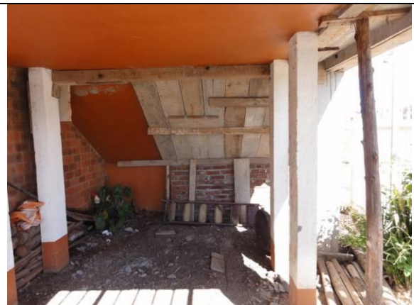
Embaixo da escada (DSC00639, 16/02/2011, 09:24h)
