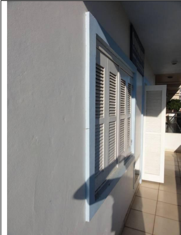
Piso superior - Sacada (DSC01137, 17/02/2011, 07:32h)
