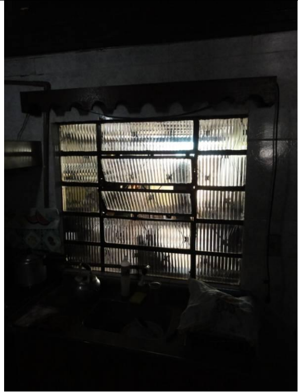
Parede D interna - Janela (DSC01400, 17/02/2011, 09:55h)
