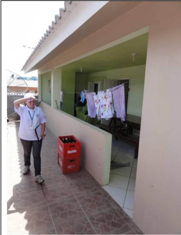
Piso superior - Fundos - Sacada (DSC01038, 16/02/2011, 14:13h)
