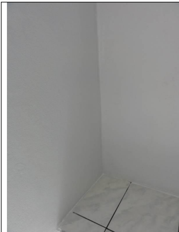
Piso superior – Apto 2 - Quarto (DSC00890, 16/02/2011, 10:46h)
