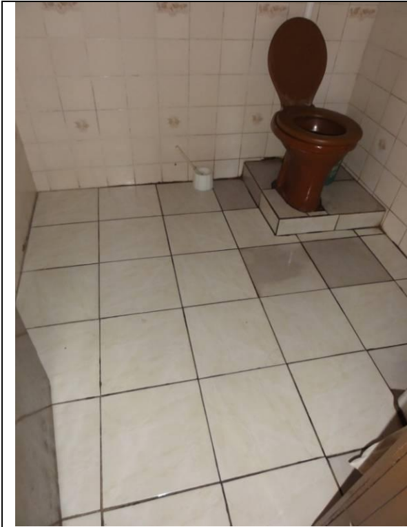
Bar - Banheiro (DSC00824, 16/02/2011, 10:21h)
