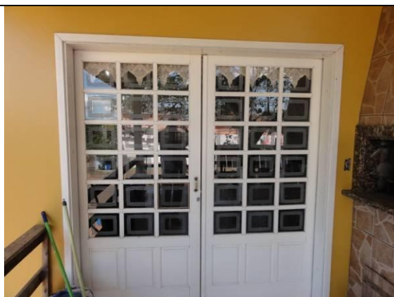
Sacada - fundos (DSC01678, 17/02/2011, 15:55h)
