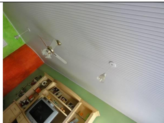
Piso superior – Sala – Teto com forro PVC (DSC00705, 16/02/2011, 09:44h)
