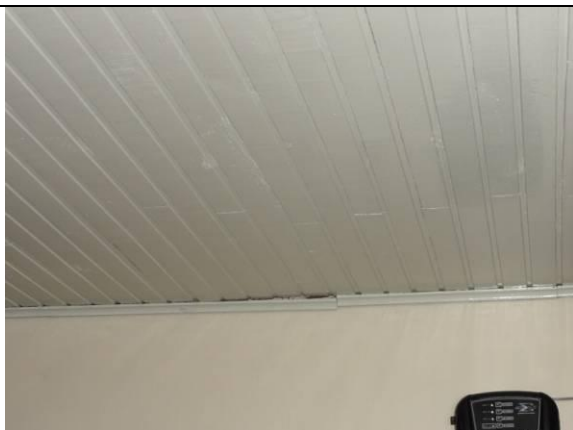
Sala – Teto com forro PVC (DSC01521, 17/02/2011, 10:47h)
