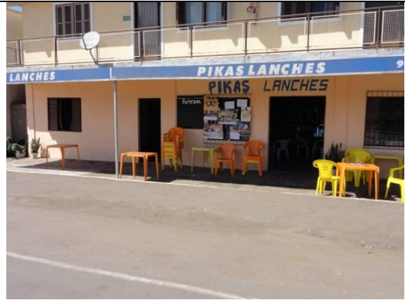
Fachada - Bar (DSC00801, 16/02/2011, 10:17h)
