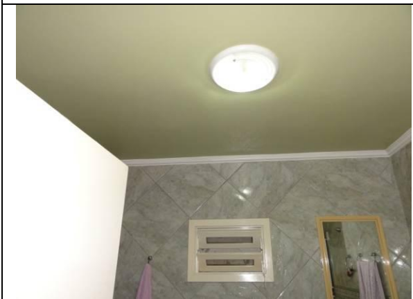
Piso superior - Banheiro (DSC01032, 16/02/2011, 14:11h)
