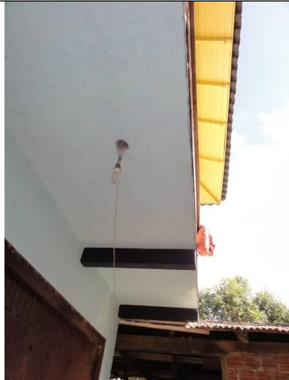
Lateral B – Esquerdo - Marquise (DSC01585, 17/02/2011, 15:38h)
