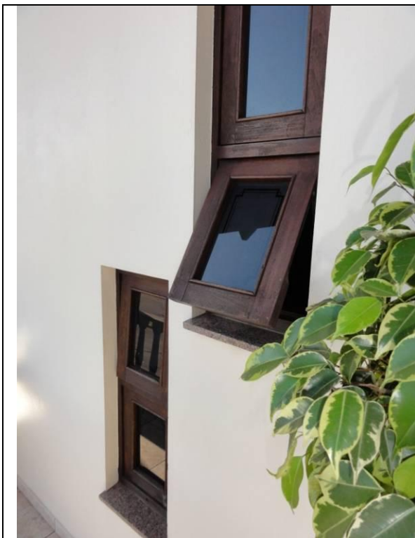
Piso superior – Casa – Sacada - Janelas (DSC01237, 17/02/2011, 08:20h)
