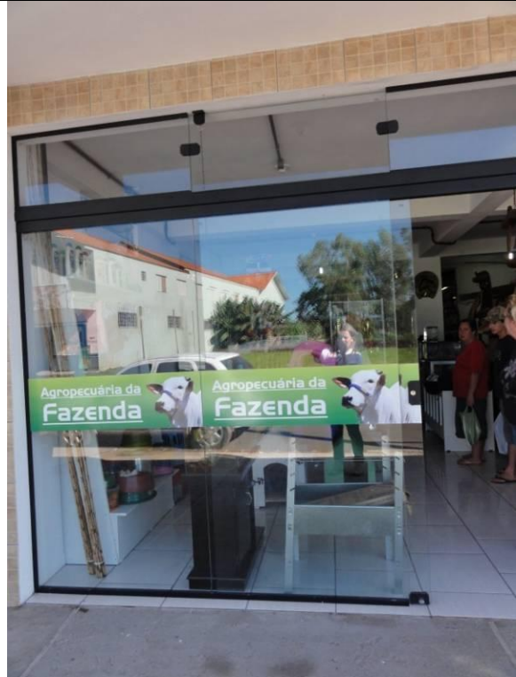
Piso inferior - Loja – Fundos - Vidraças (DSC00621, 16/02/2011, 09:04h)
