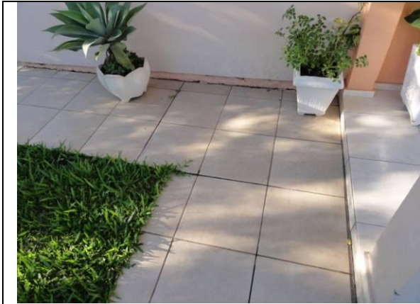
Calçada em torno da casa (DSC01160, 17/02/2011, 07:46h)
