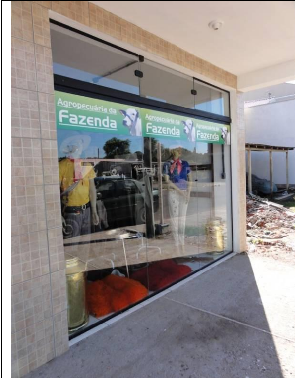
Piso inferior - Loja – Fundos - Vidraças (DSC00622, 16/02/2011, 09:04h)
