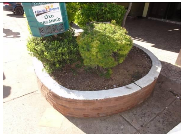
Fachada - Canteiro (DSC01276, 17/02/2011, 08:46h)
