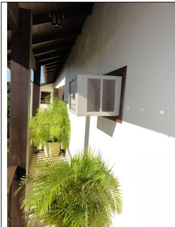
Piso superior – Casa – Sacada (DSC01239, 17/02/2011, 08:20h)
