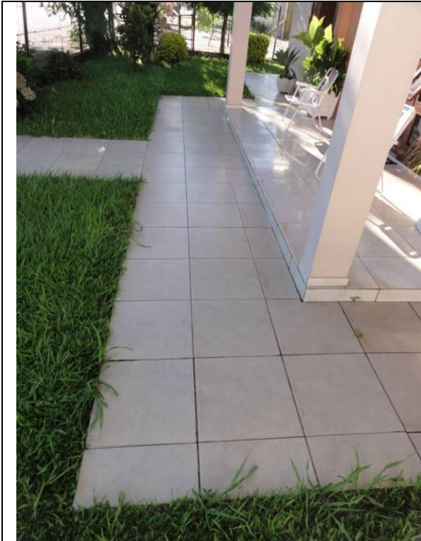
Calçada em torno da casa (DSC01156, 17/02/2011, 07:45h)
