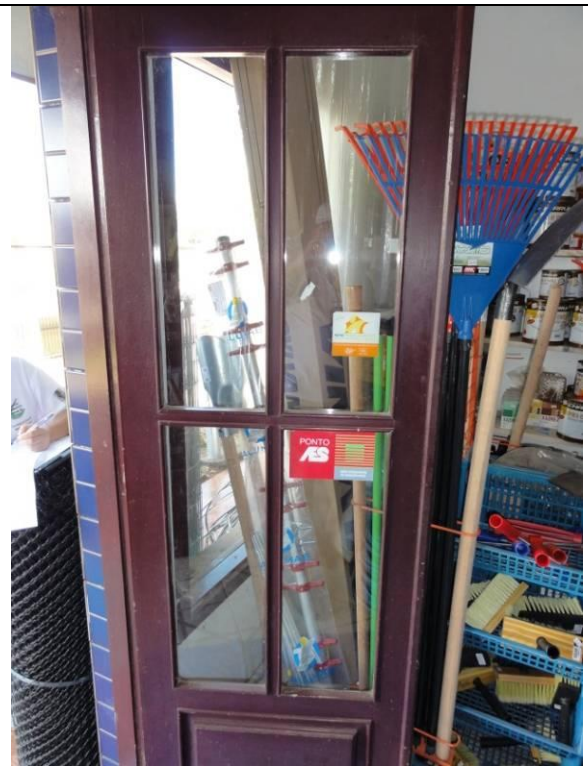
Fachada - Entrada (DSC01597, 17/02/2011, 15:40h)
