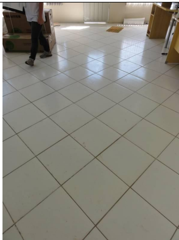
Sala - Piso cerâmico (DSC01524, 17/02/2011, 10:47h)
