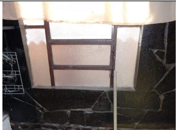
Parede D interna - Janela (DSC01402, 17/02/2011, 09:56h)
