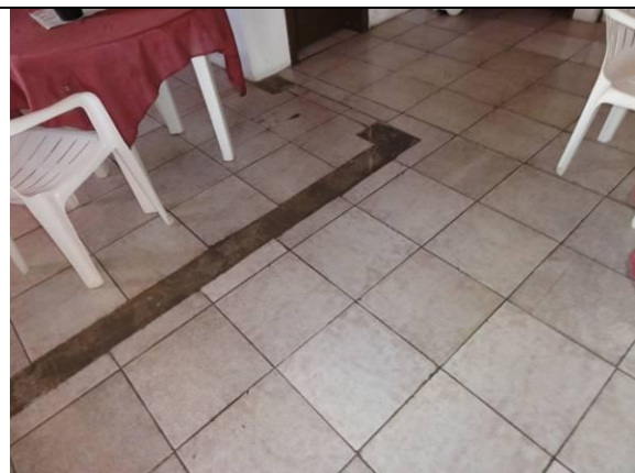
Bar – Piso cerâmico (DSC00819, 16/02/2011, 10:20h)
