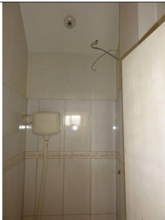
Piso inferior – Padaria – Parede 1 com fissuras no reboco (DSC00995, 16/02/2011, 14:00h)
