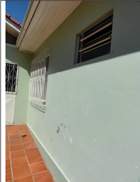
Parede D – Lateral Direita (DSC01445, 17/02/2011, 10:24h)
