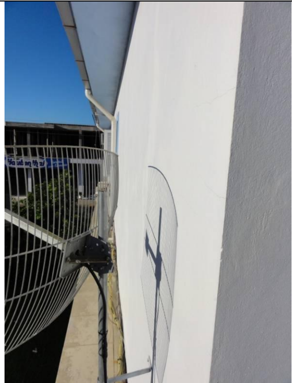
Piso superior - Sacada (DSC01136, 17/02/2011, 07:32h)
