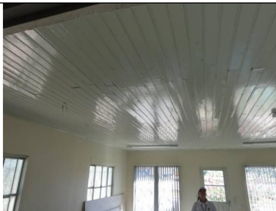
Sala – Teto com forro PVC (DSC01522, 17/02/2011, 10:47h)
