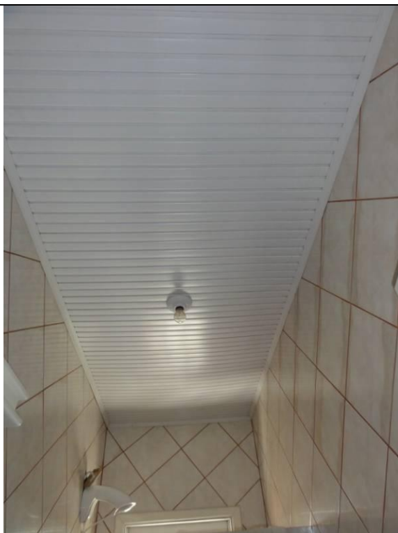
Piso superior – Banheiro – Teto com forro PVC (DSC00745, 16/02/2011, 09:53h)
