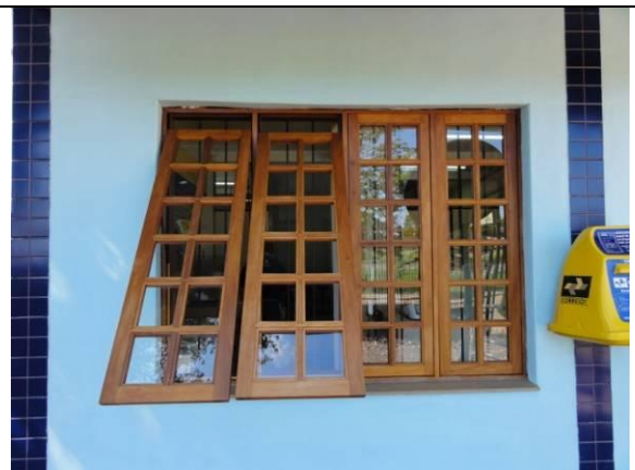
Fachada Correio – Janela (DSC02193, 18/02/2011, 10:01h)
