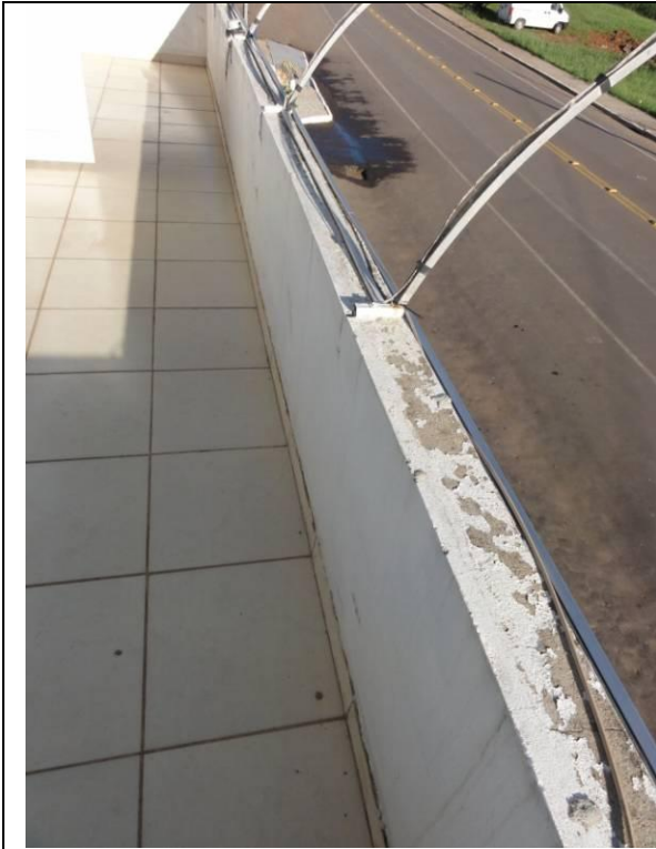
Piso superior - Sacada (DSC01139, 17/02/2011, 07:32h)
