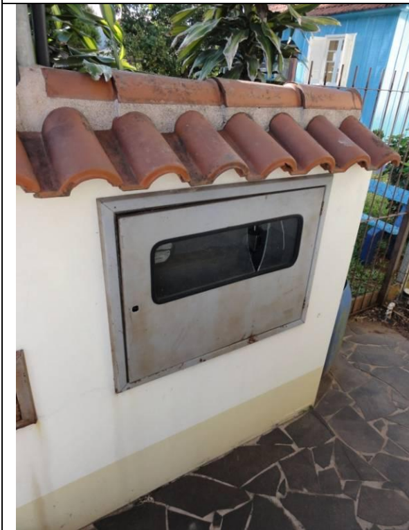
Fachada – Muro de caixa de luz (DSC01200, 17/02/2011, 08:11h)
