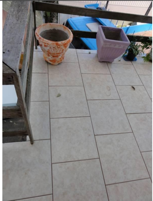
Sacada - fundos (DSC01673, 17/02/2011, 15:54h)
