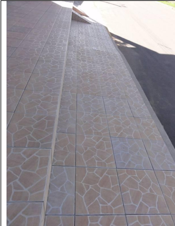
Fundos – Loja – Calçada de piso cerâmico (DSC00764, 16/02/2011, 10:02h)
