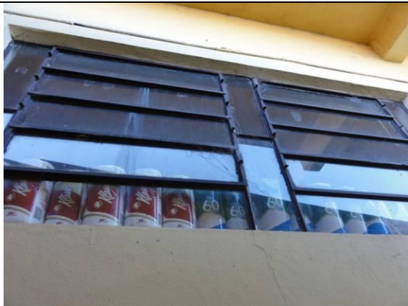
Piso inferior - Parede B – Externo - Janela (DSC01313, 17/02/2011, 08:57h)
