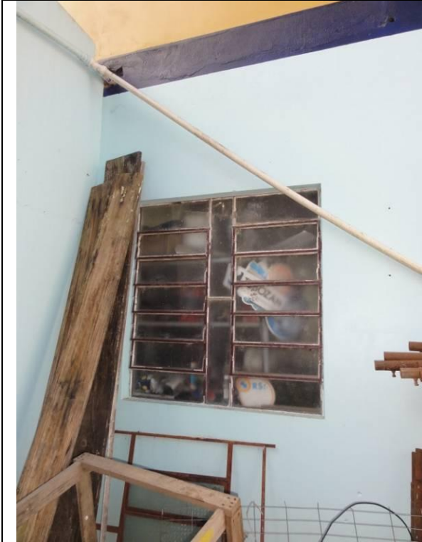
Piso inferior - Fundos (DSC01608, 17/02/2011, 15:43h)
