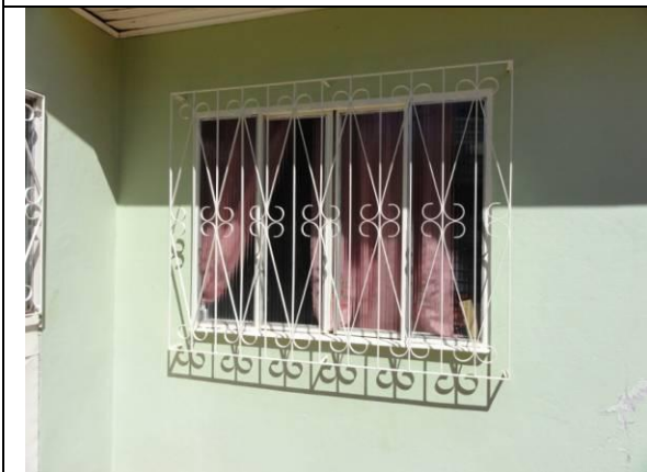
Parede D – Lateral Direita (DSC01447, 17/02/2011, 10:24h)
