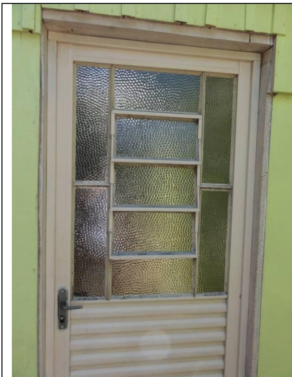
Parede B – Lateral Esquerda (DSC01465, 17/02/2011, 10:28h)
