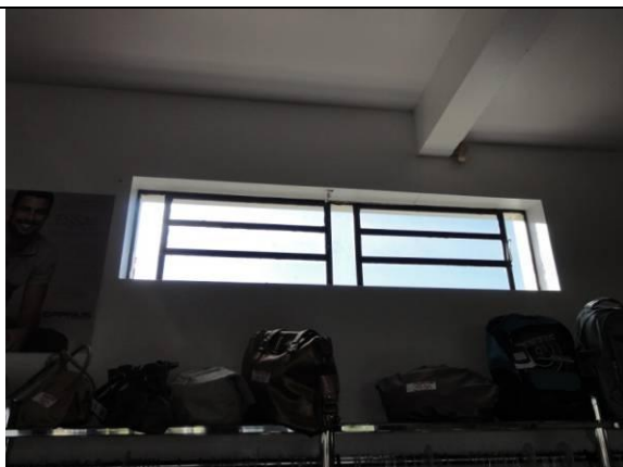
Piso inferior – Loja - Basculantes (DSC01233, 17/02/2011, 08:17h)
