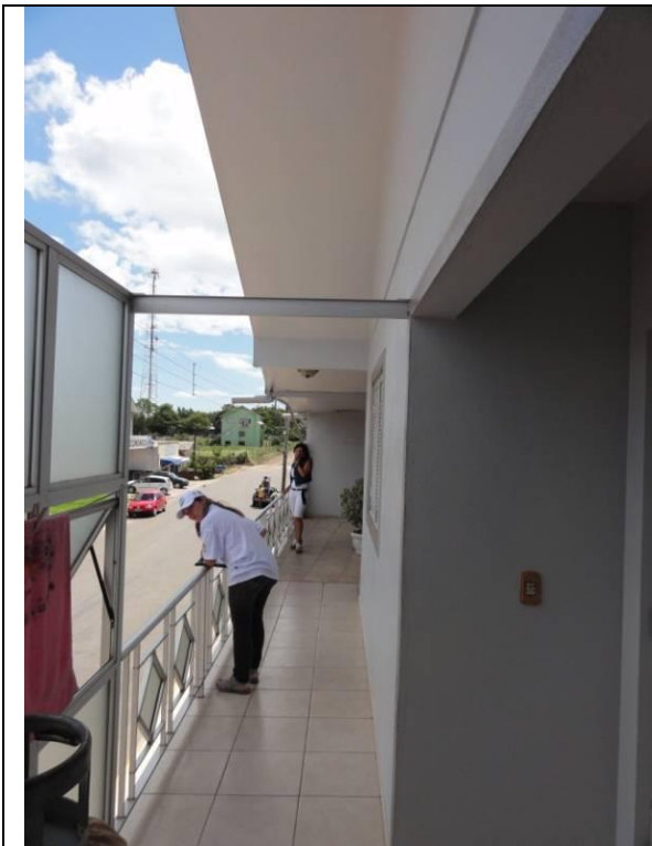
Piso superior – Sacada – Fundos (DSC00952, 16/02/2011, 13:37h)
