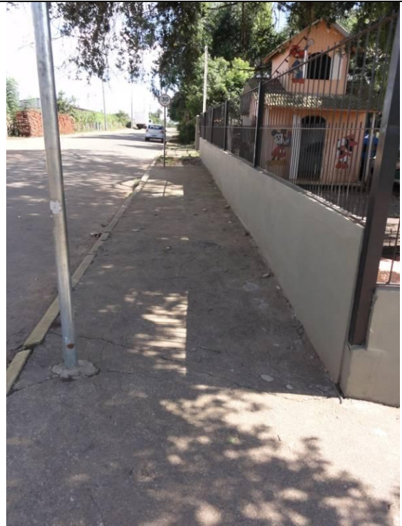
Lateral Direita - Calçada (DSC01563, 17/02/2011, 15:35h)
