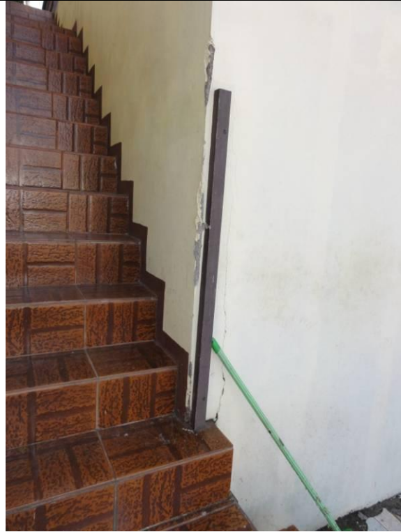
Piso inferior - Escada Fundos (DSC01315, 17/02/2011, 08:57h)
