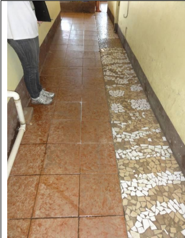
Piso inferior - Lateral B – Externo – Piso cerâmico (DSC01311, 17/02/2011, 08:56h)
