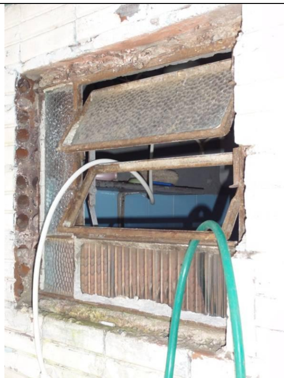
Salão – Basculante sem vidro (DSC01426, 17/02/2011, 10:07h)
