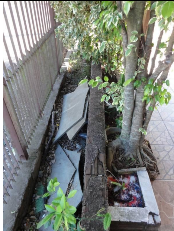
Entrada – Portão (DSC01282, 17/02/2011, 08:47h)
