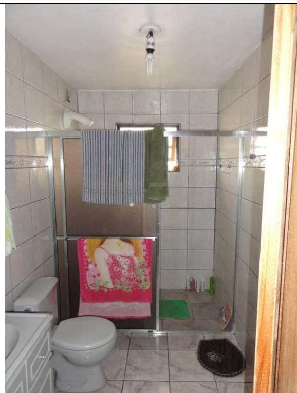
Piso superior – Apto 3 - Banheiro (DSC00903, 16/02/2011, 13:13h)
