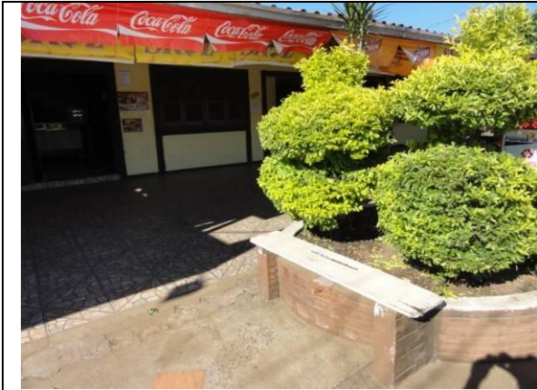
Fachada - Canteiro (DSC01277, 17/02/2011, 08:46h)
