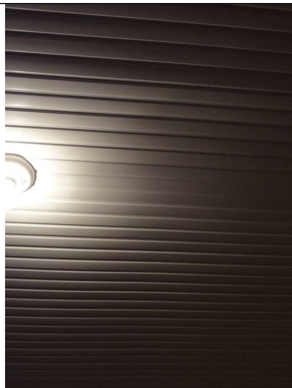
Piso superior – Corredor(DSC00725, 16/02/2011, 09:49h)
