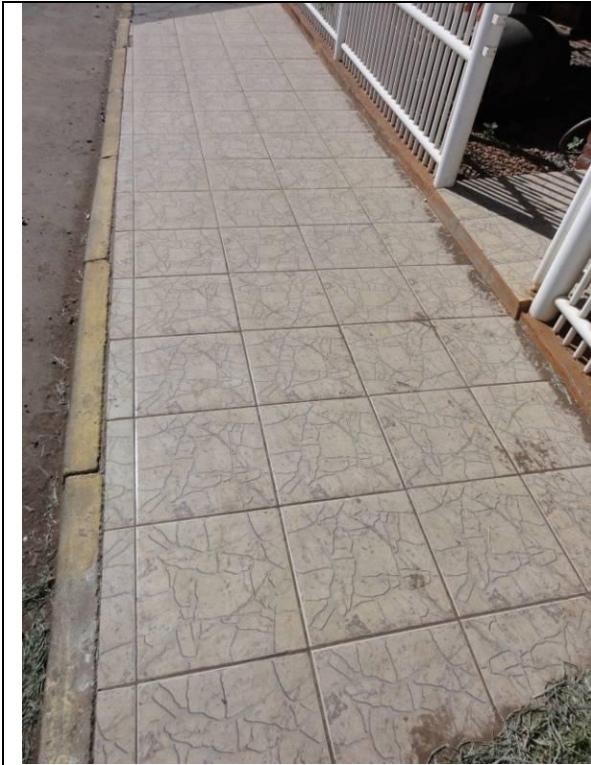
Calçada (DSC00630, 16/02/2011, 09:21h)
