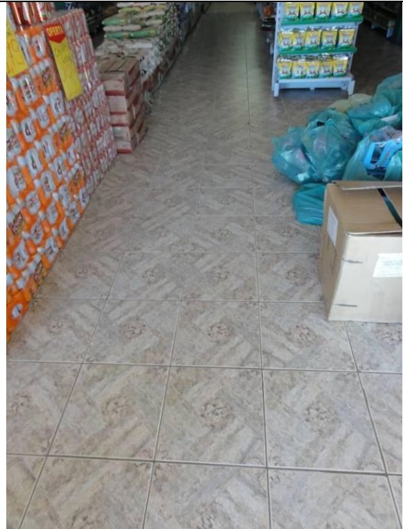
Piso inferior – Loja – Piso cerâmico (DSC01306, 17/02/2011, 08:55h)
