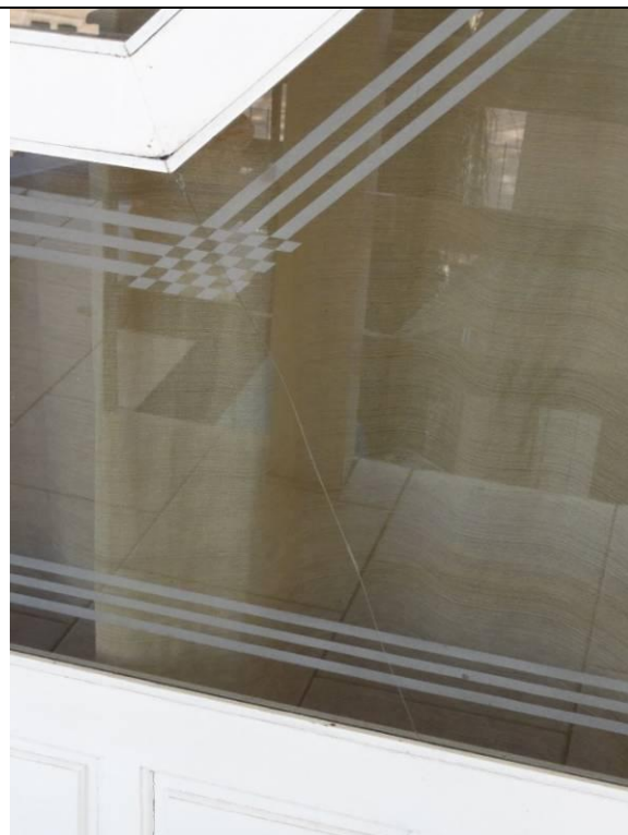
Sacada – Fundos – Porta com vidro rachado (DSC01653, 17/02/2011, 15:51h)
