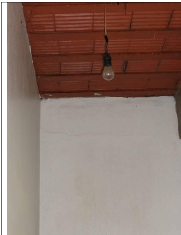
Bar - Banheiro (DSC00844, 16/02/2011, 10:27h)
