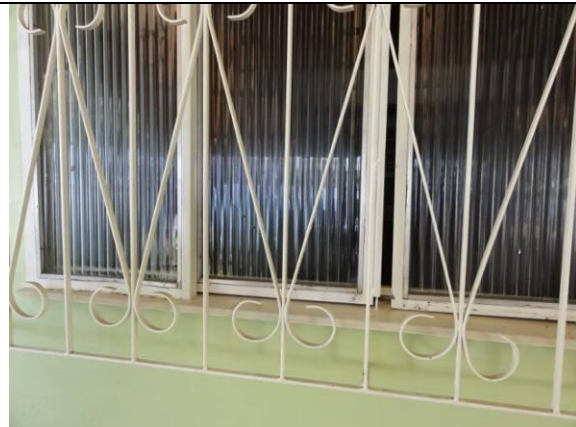
Parede B – Lateral Esquerda (DSC01462, 17/02/2011, 10:28h)
