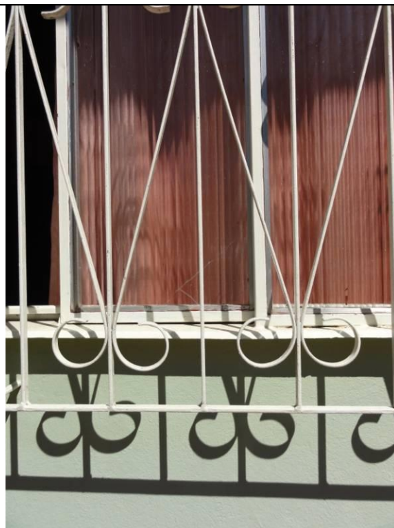
Parede D – Lateral Direita – Janela com vidro rachado (DSC01444, 17/02/2011, 10:24h)
