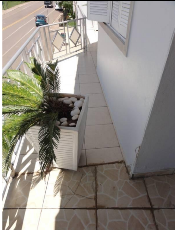
Piso superior – Sacada (DSC00940, 16/02/2011, 13:35h)
