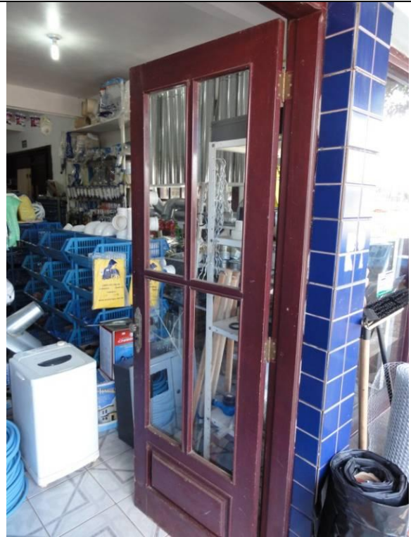
Fachada - Entrada (DSC01595, 17/02/2011, 15:39h)
