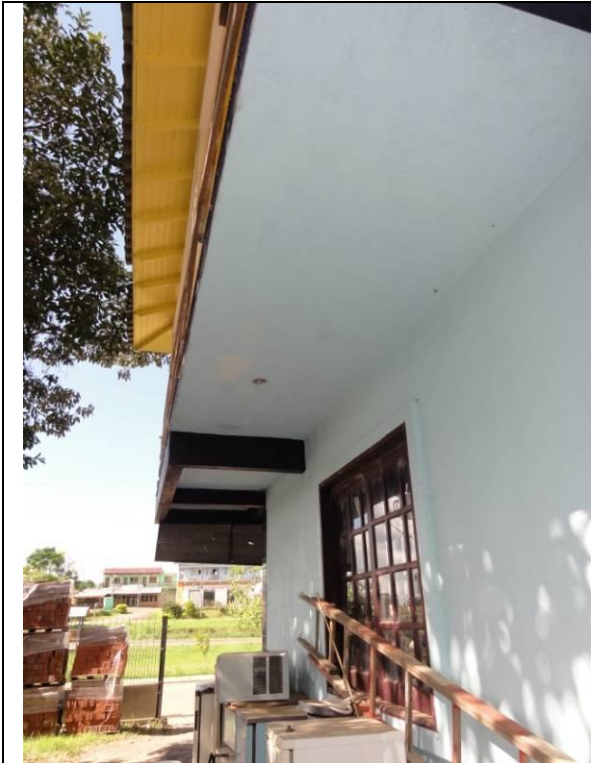
Lateral B – Esquerdo - Marquise (DSC01586, 17/02/2011, 15:38h)
