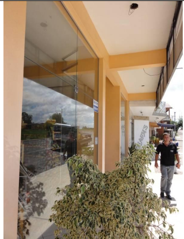
Fachada - Vidraças (DSC00979, 16/02/2011, 13:53h)
