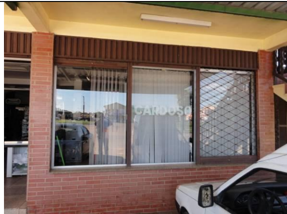
Fachada – Parede A - Janela (DSC01304, 17/02/2011, 08:53h)
