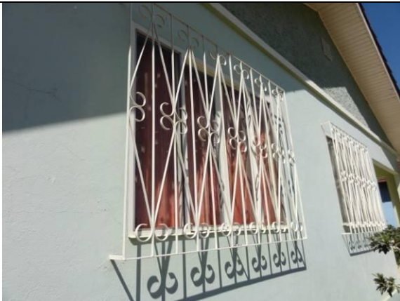
Parede D – Lateral Direita (DSC01439, 17/02/2011, 10:23h)
