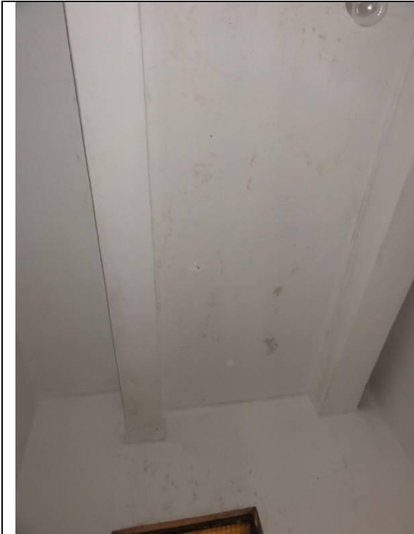
Bar - Banheiro (DSC00826, 16/02/2011, 10:21h)
