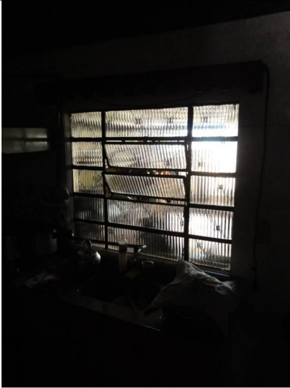
Parede D interna - Janela (DSC01399, 17/02/2011, 09:55h)
