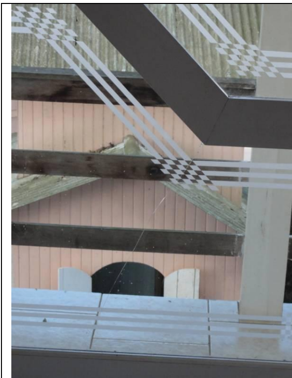
Cozinha – Porta com vidro rachado (DSC01686, 17/02/2011, 15:57h)
