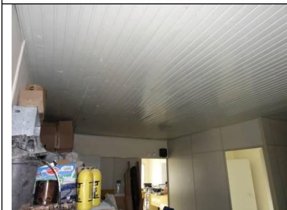
Sala – Teto com forro PVC (DSC01517, 17/02/2011, 10:46h)
