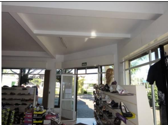
Piso inferior – Loja – Teto (DSC01228, 17/02/2011, 08:16h)
