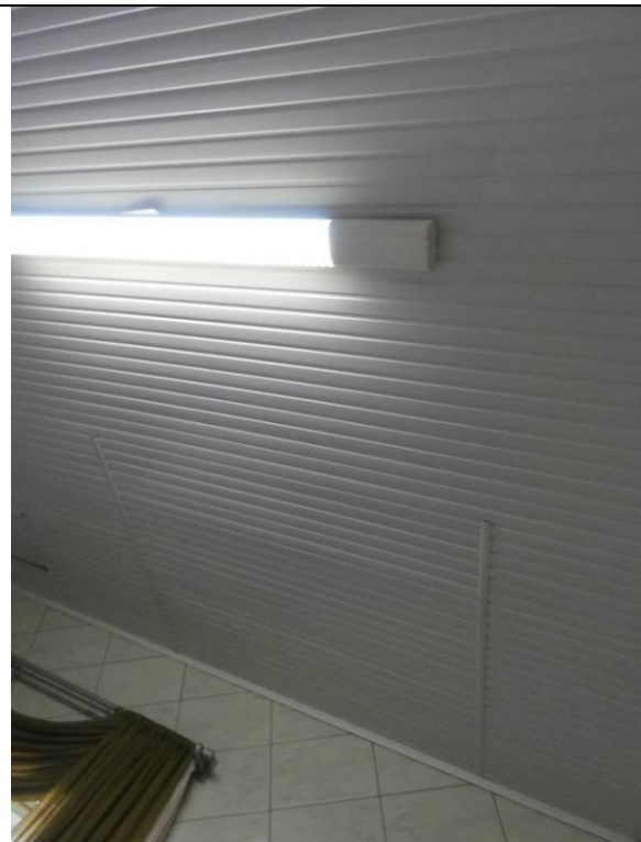
Piso superior – Cozinha – Teto com forro PVC (DSC00715, 16/02/2011, 09:46h)
