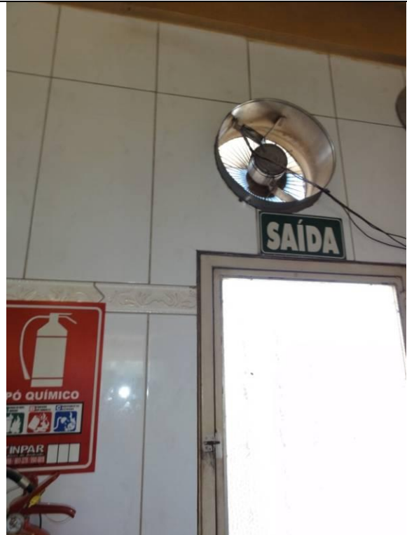
Piso inferior – Padaria (DSC01001, 16/02/2011, 14:03h)
