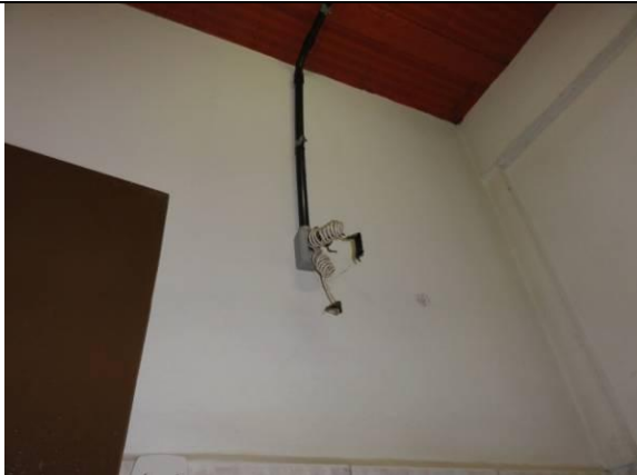
Bar - Banheiro (DSC00840, 16/02/2011, 10:26h)
