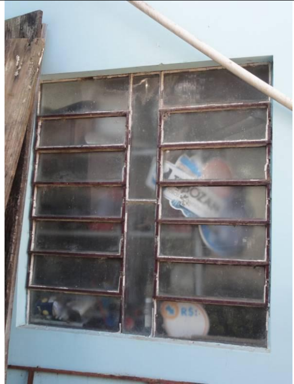
Piso inferior - Fundos (DSC01609, 17/02/2011, 15:43h)
