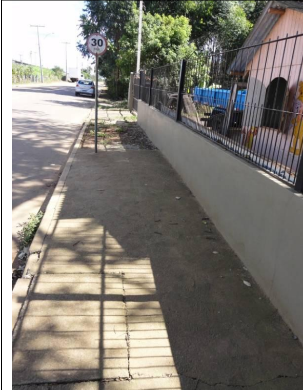
Lateral Direita - Calçada (DSC01564, 17/02/2011, 15:35h)
