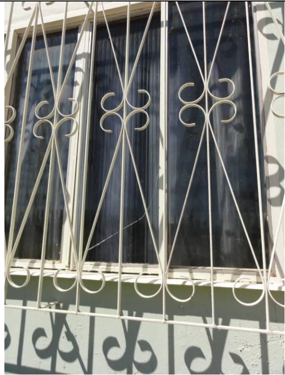
Parede D – Lateral Direita (DSC01438, 17/02/2011, 10:23h)
