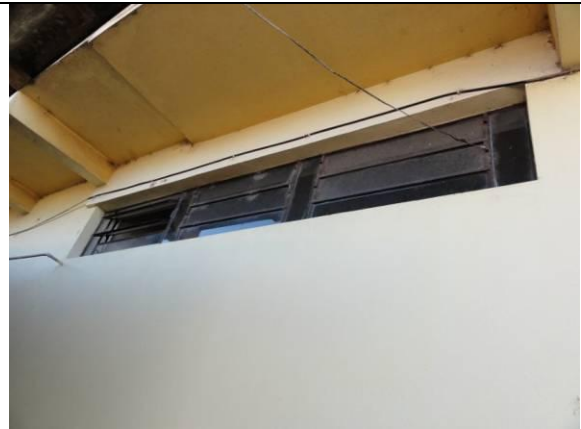
Piso inferior - Parede B – Externo - Janela (DSC01314, 17/02/2011, 08:57h)
