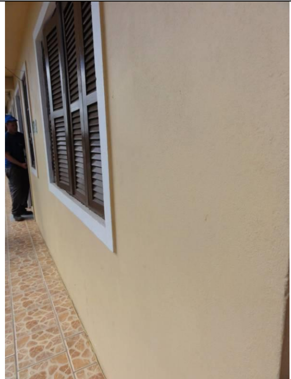
Piso superior – Sacada (DSC00867, 16/02/2011, 10:37h)
