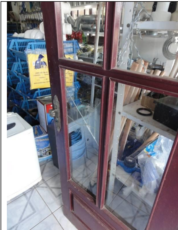
Fachada - Entrada (DSC01596, 17/02/2011, 15:39h)
