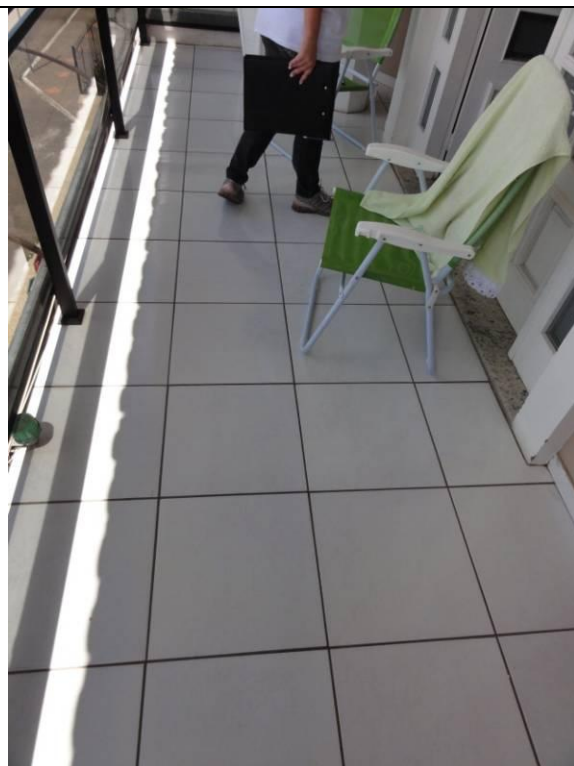
Piso superior - Piso cerâmico (DSC01027, 16/02/2011, 14:10h)
