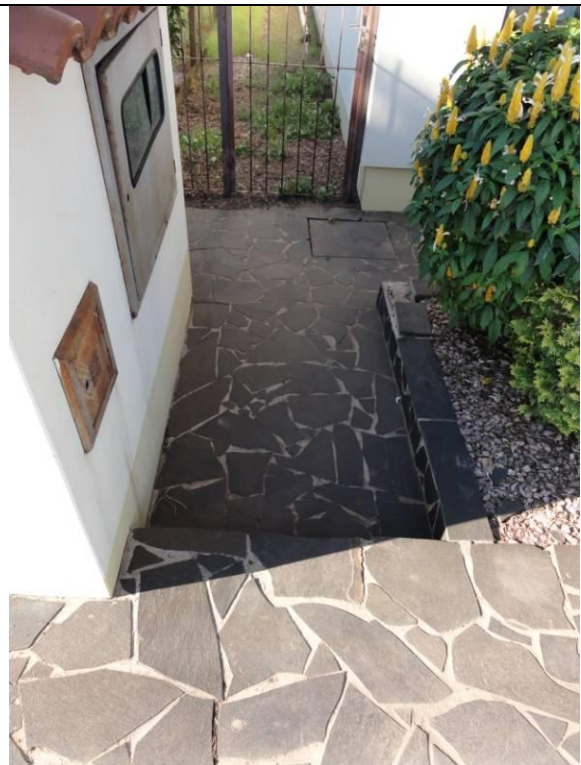
Fachada – Muro de caixa de luz (DSC01201, 17/02/2011, 08:11h)
