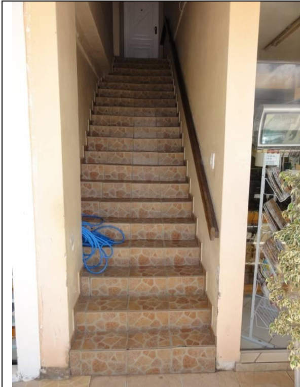
Escada lateral (DSC00978, 16/02/2011, 13:53h)
