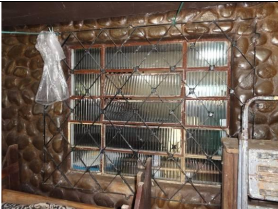
Parede D interna - Janela (DSC01401, 17/02/2011, 09:55h)
