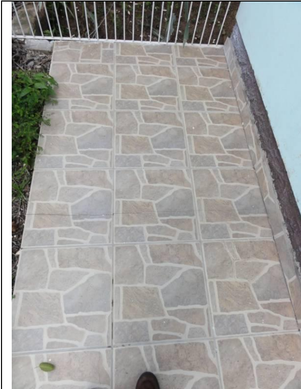
Calçada de piso cerâmico (DSC00120, 15/02/2011, 13:52h)
