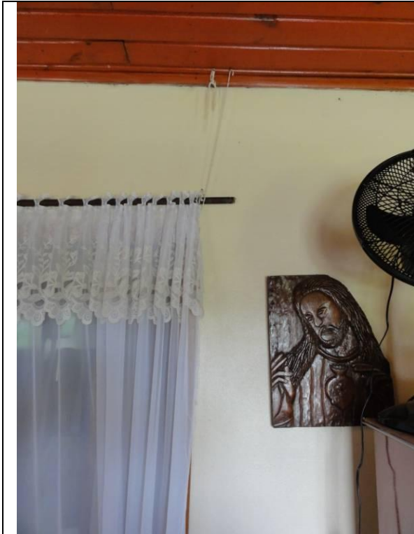
Teto e parede (DSC00048, 15/02/2011, 13:32h)
