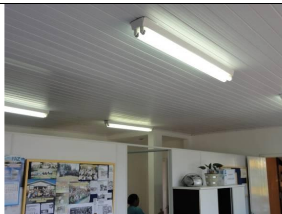
Sala 6 – Teto com forro PVC (DSC01987, 18/02/2011, 08:40h)
