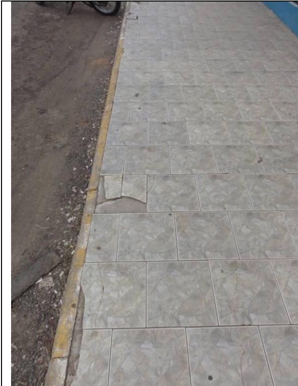
Calçada em torno do prédio (DSC00399, 15/02/2011, 15:52h)
