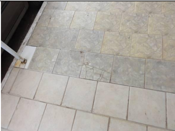
Calçada em torno do prédio (DSC00391, 15/02/2011, 15:51h)
