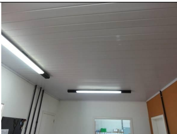
Sala 1 – Teto com forro PVC (DSC01840, 18/02/2011, 07:58h)
