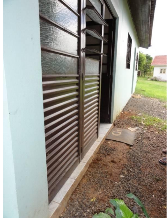
Porta de entrada (DSC00011, 15/02/2011, 14:14h)
