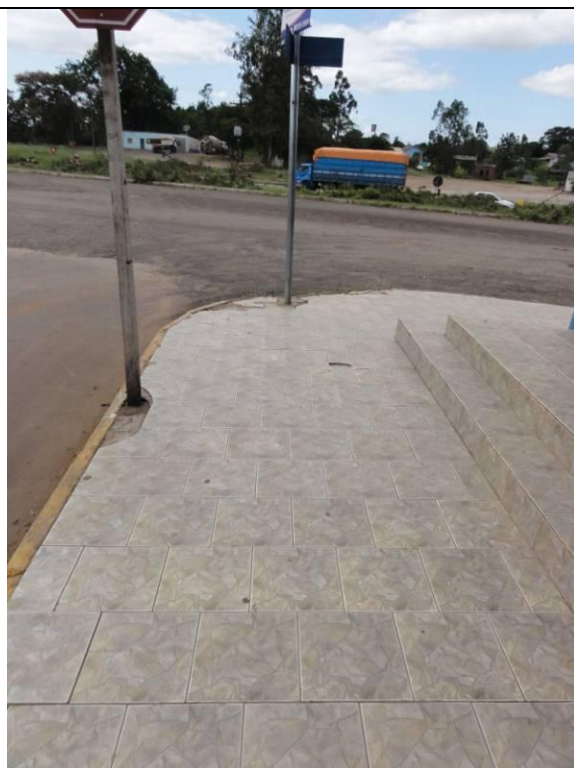
Calçada em torno do prédio (DSC00396, 15/02/2011, 15:51h)
