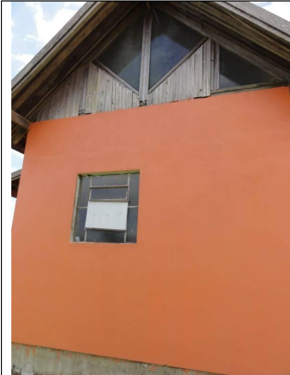
Parede B (DSC00204, 15/02/2011, 14:18h)
