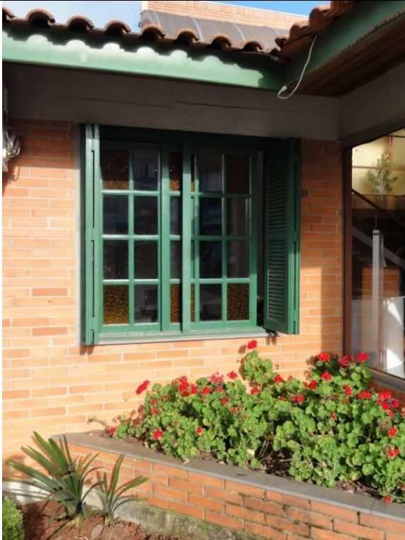
Janela fachada (DSC01806, 18/02/2011, 07:51h)
