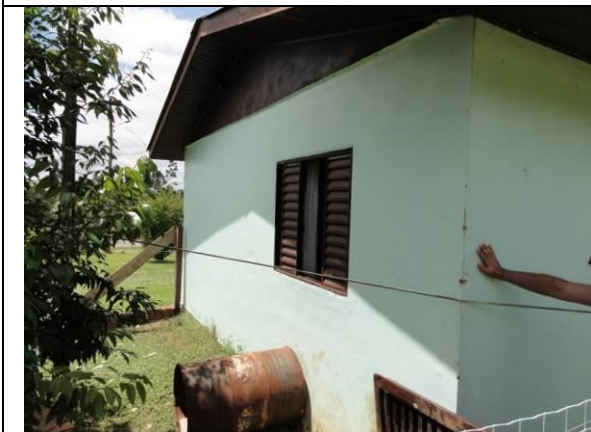
Lateral – parede B(DSC00018, 15/02/2011, 14:16h)
