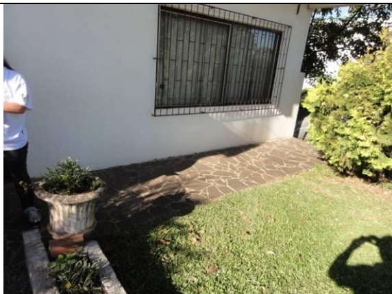
Calçada (DSC00515, 16/02/2011, 08:20h)
