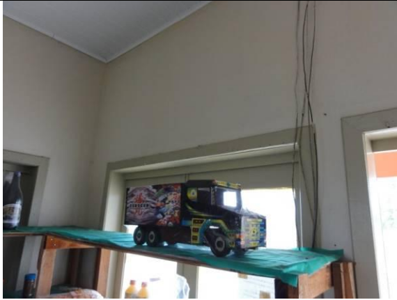
Parede interna (DSC00214, 15/02/2011, 14:20h)
