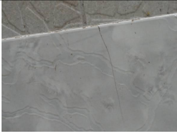
Hall 2º Piso (DSC00322, 15/02/2011, 15:21h)
