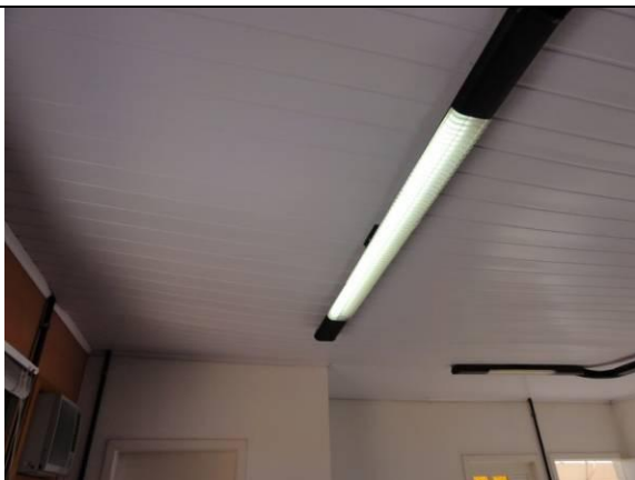
Parte superior – Sala 2 – Teto com forro PVC (DSC02026, 18/02/2011, 08:49h)
