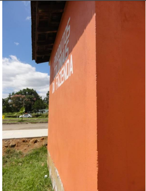
Parede B (DSC00209, 15/02/2011, 14:19h)
