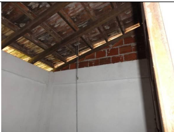
Teto sem forro (DSC00224, 15/02/2011, 14:22h)
