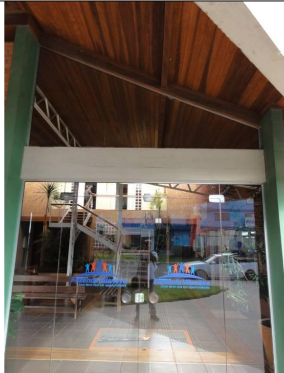
Porta entrada (DSC01813, 18/02/2011, 07:52h)
