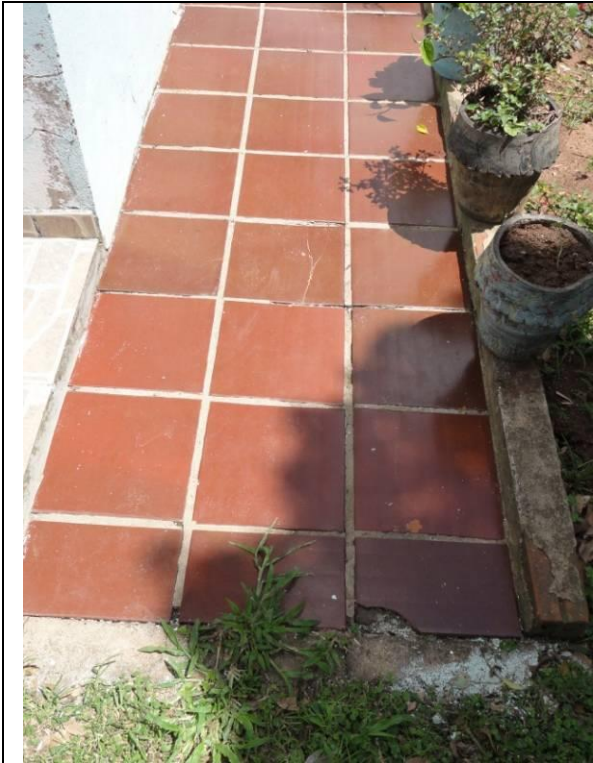
Piso cerâmico (DSC00076, 15/02/2011, 13:45h)
