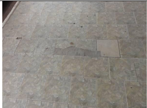
Calçada em torno do prédio (DSC00392, 15/02/2011, 15:51h)
