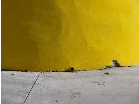
Canteiro (DSC00485, 16/02/2011, 08:01h)
