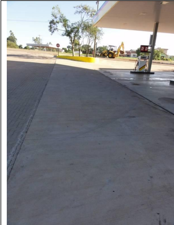
Calçada em frente da fachada (DSC00477, 16/02/2011, 08:00h)
