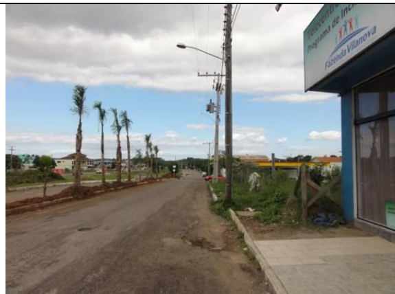
Calçada (DSC00435, 15/02/2011, 16:07h)
