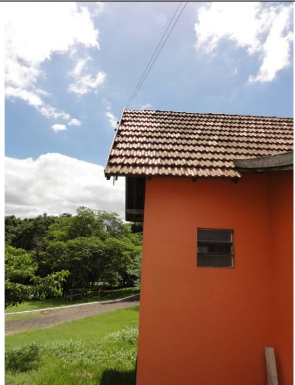
Telhado (DSC00203, 15/02/2011, 14:18h)
