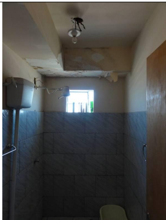
Apto 304 – Banheiro (DSC02159, 18/02/2011, 09:27h)
