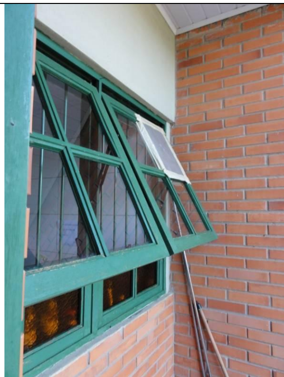
Janela da cozinha – Lado externo (DSC01937, 18/02/2011, 08:28)
