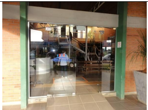
Porta de vidro entrada (DSC01809, 18/02/2011, 07:51h)
