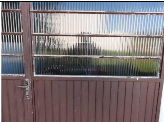
Fundos - Portão (DSC00529, 16/02/2011, 08:25h)
