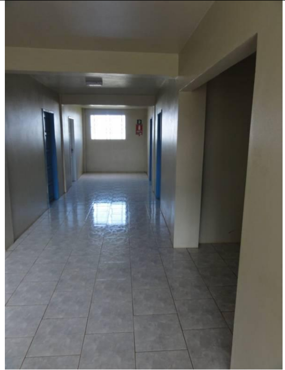
Hall 1º Piso (DSC00327, 15/02/2011, 15:25h)
