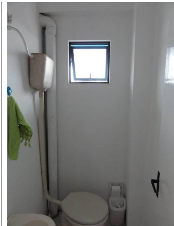
Sala 201 - Banheiro (DSC00365, 15/02/2011, 15:43h)
