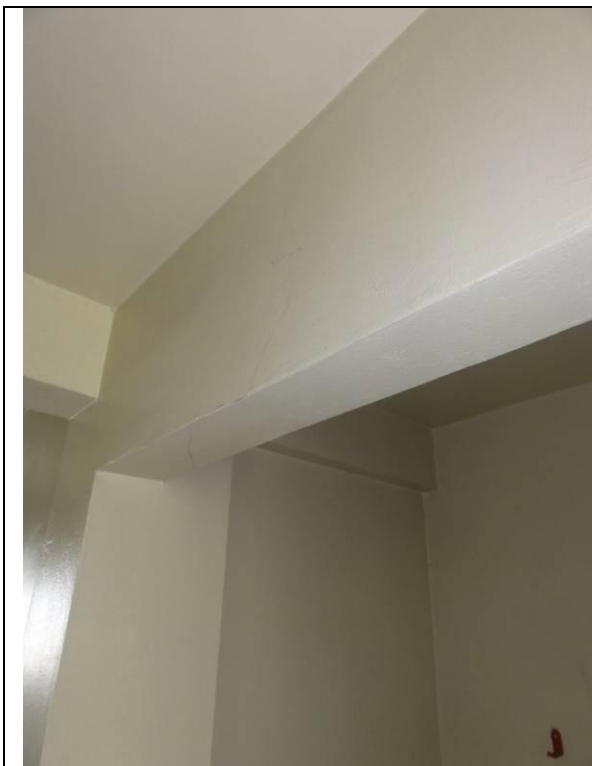
Hall 1º Piso (DSC00328, 15/02/2011, 15:25h)
