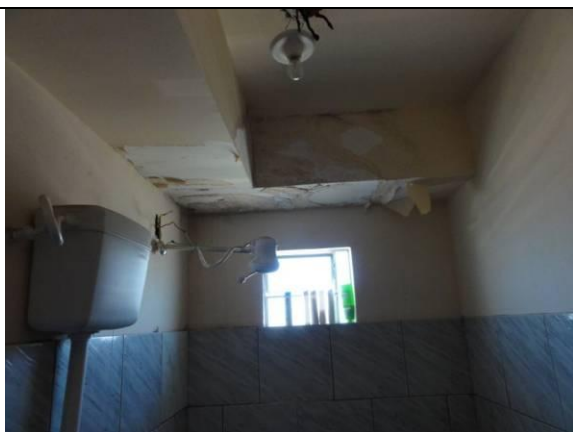
Apto 304 – Banheiro (DSC02160, 18/02/2011, 09:27h)
