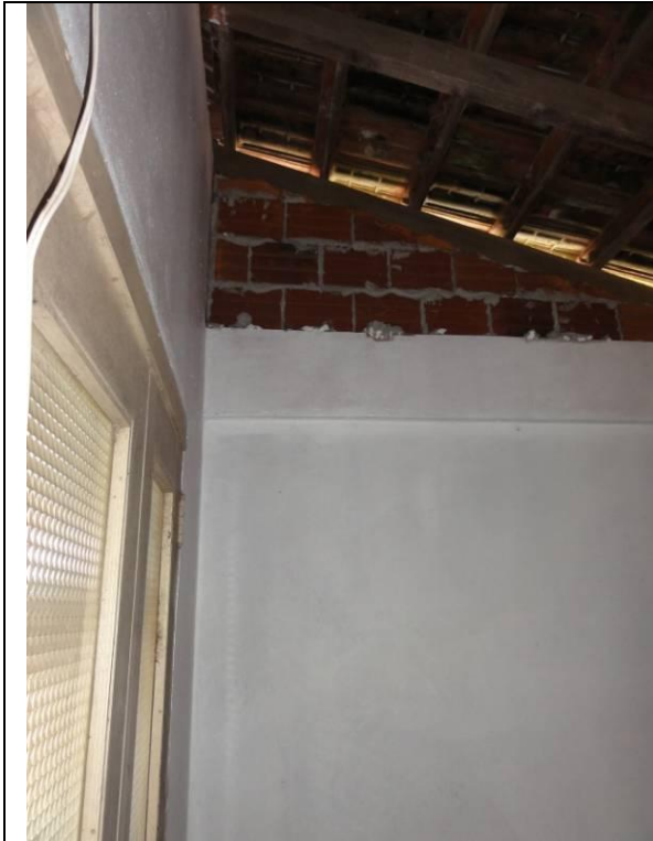
Teto sem forro (DSC00222, 15/02/2011, 14:21h)
