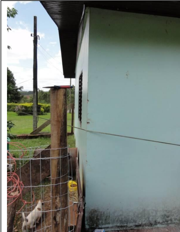
Parede fundos (DSC00016, 15/02/2011, 14:16h)
