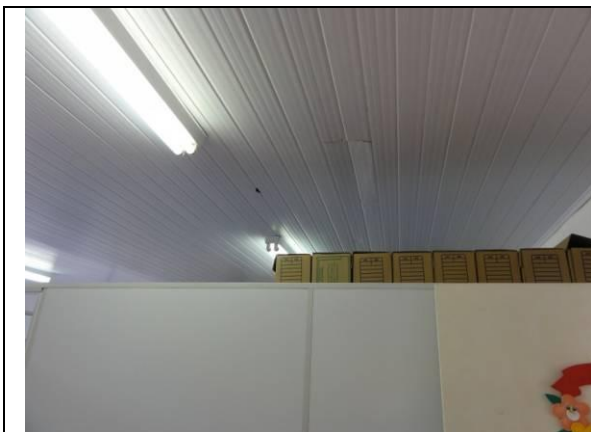
Sala 6 – Teto com forro PVC (DSC01970, 18/02/2011, 08:36h)
