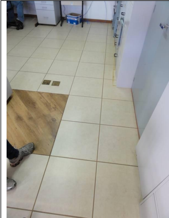
Sala 2 – Piso cerâmico (DSC01866, 18/02/2011, 08:06h)
