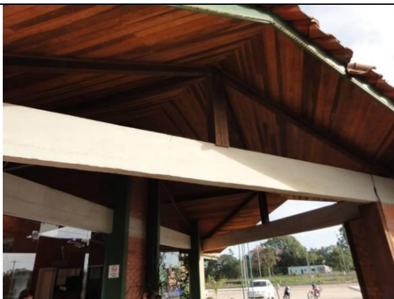
Forro entrada (DSC01808, 18/02/2011, 07:51h)
