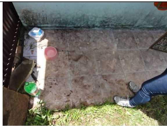
Piso fundos (DSC00023, 15/02/2011, 14:18h)
