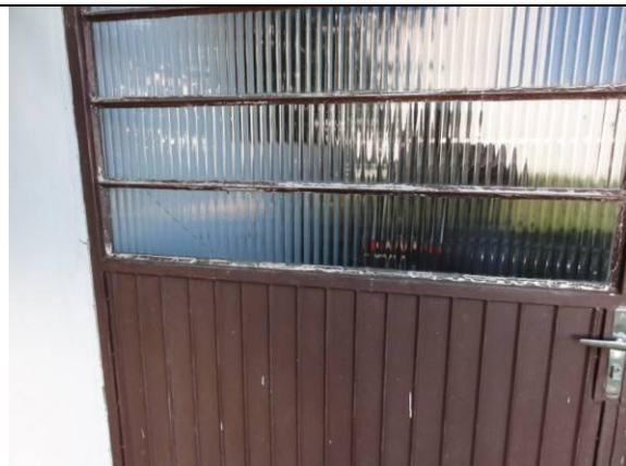
Fundos - Portão (DSC00530, 16/02/2011, 08:26h)
