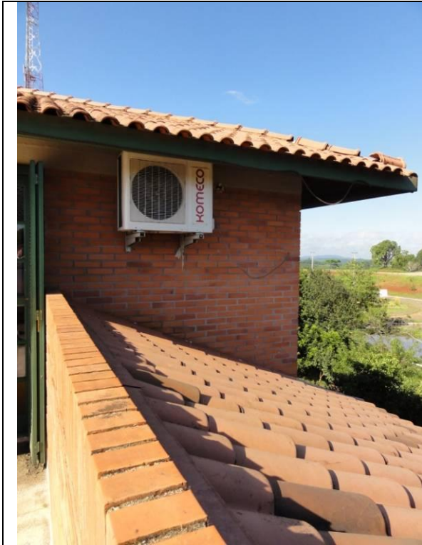
Telhado (DSC02042, 18/02/2011, 08:52h)
