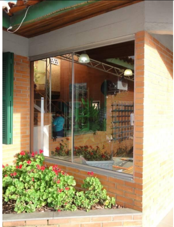
Janela entrada (DSC01807, 18/02/2011, 07:51h)
