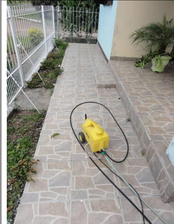
Calçada de piso cerâmico (DSC00118, 15/02/2011, 13:52h)
