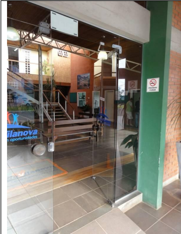
Porta entrada (DSC01810, 18/02/2011, 07:51h)
