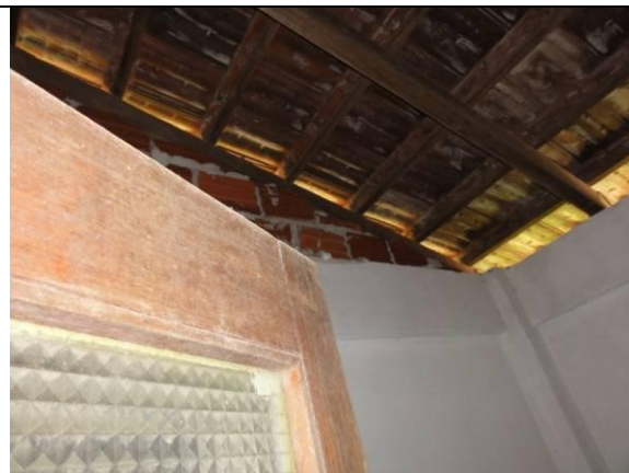
Telhado (DSC00225, 15/02/2011, 14:22h)
