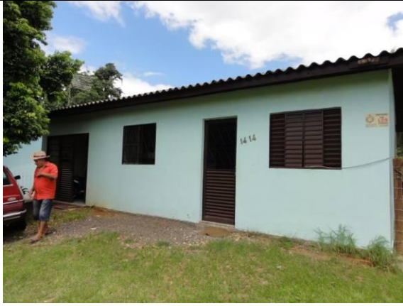
Fachada – parede A (DSC00006, 15/02/2011, 14:12h)
