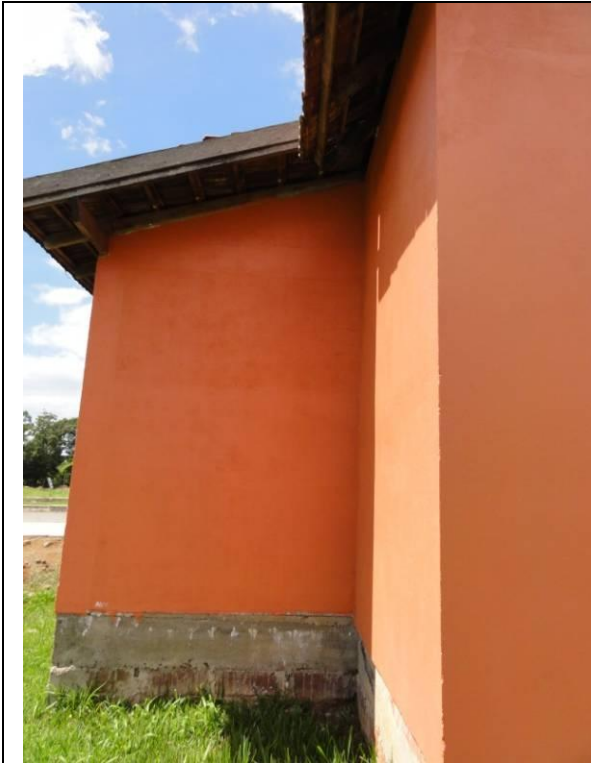
Parede D (DSC00206, 15/02/2011, 14:18h)
