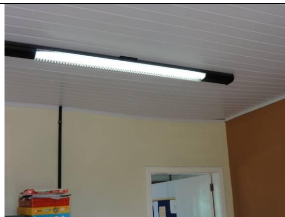
Sala 6 – Teto com forro PVC (DSC02003, 18/02/2011, 08:43h)
