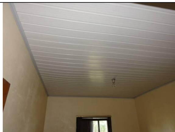
Quarto 1 – Teto com forro PVC (DSC00168, 15/02/2011, 14:02h)
