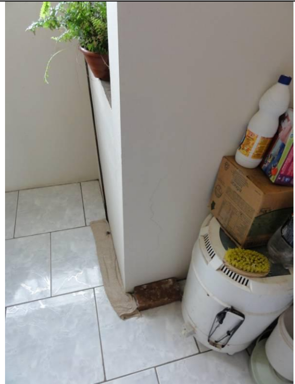
Apto 307 – Area de Serviço – Piso cerâmico (DSC00269, 15/02/2011, 15:05h)
