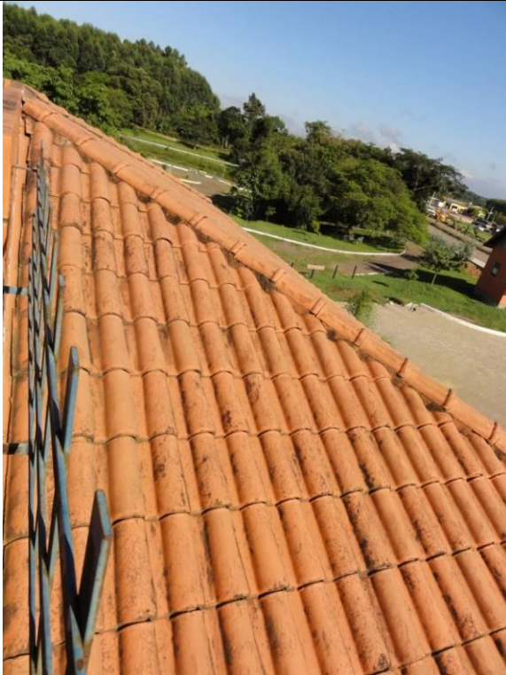
Telhado (DSC02036, 18/02/2011, 08:51h)
