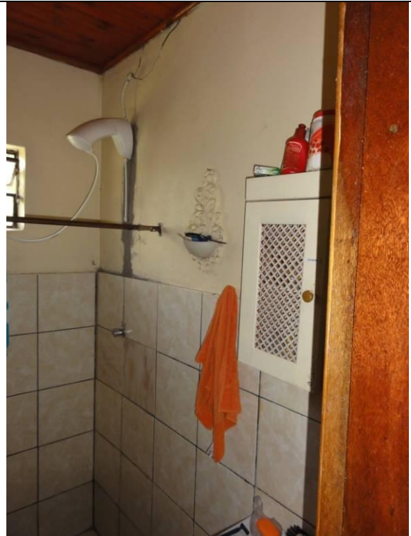
Banheiro (DSC00063, 15/02/2011, 13:37h)
