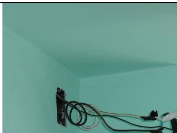
Apto 301 - Banheiro (DSC02104, 18/02/2011, 09:13h)
