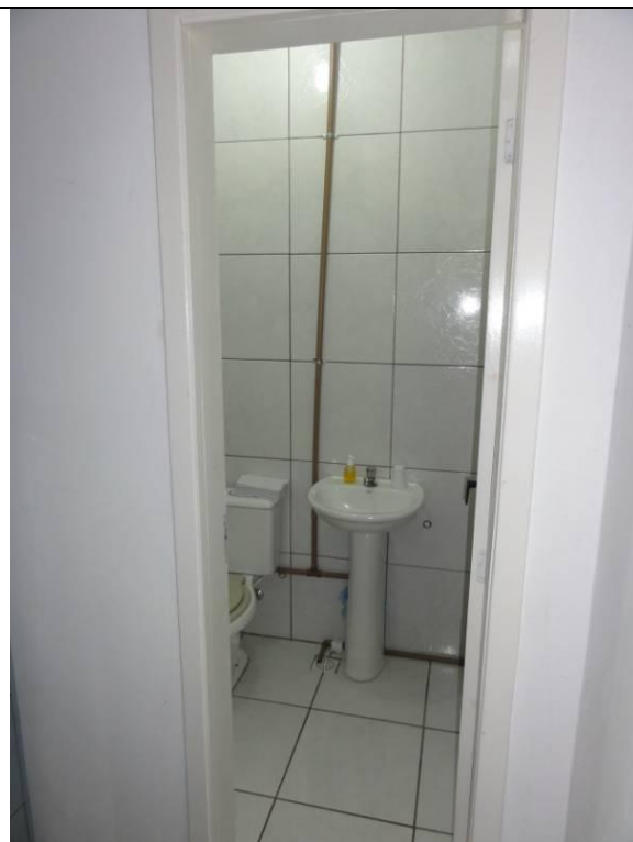
Sala 6 – Banheiro (DSC01981, 18/02/2011, 08:39h)
