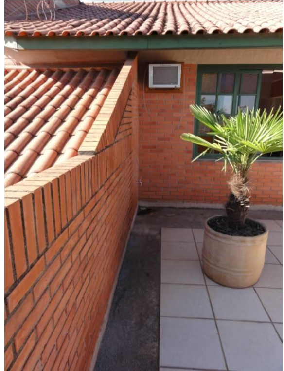
Parte superior – Sacada (DSC02041, 18/02/2011, 08:52h)
