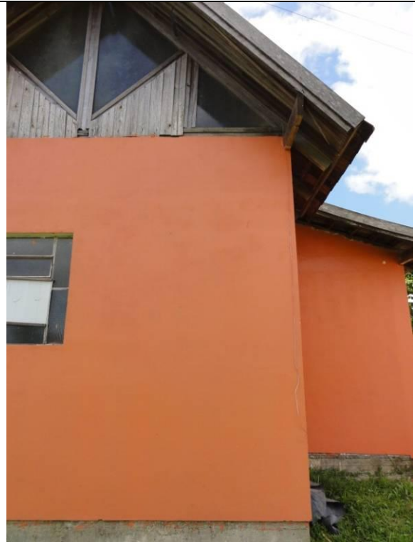
Parede B (DSC00205, 15/02/2011, 14:18h)
