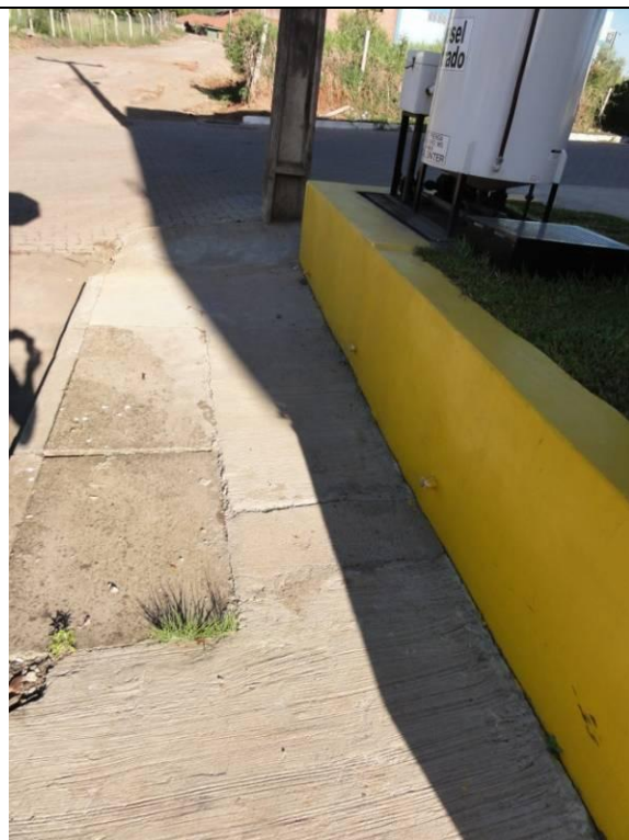
Calçada em frente da fachada (DSC00470, 16/02/2011, 07:58h)
