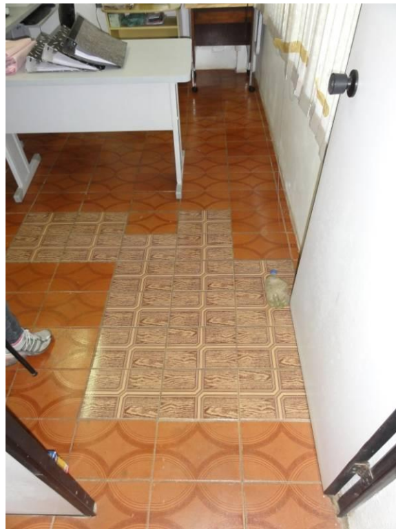
Piso cerâmico (DSC00560, 16/02/2011, 08:32h)
