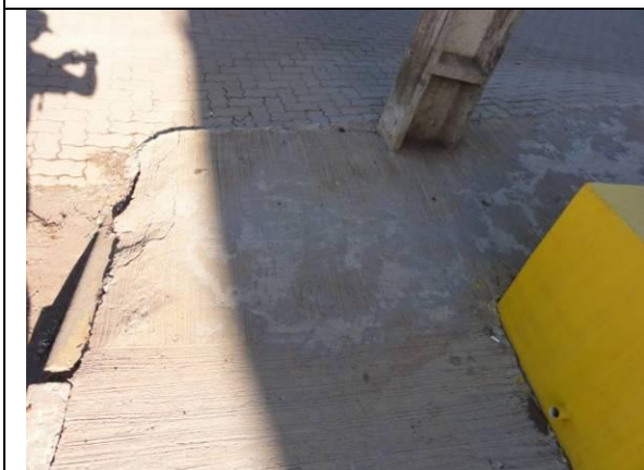
Calçada em frente da fachada (DSC00471, 16/02/2011, 07:59h)
