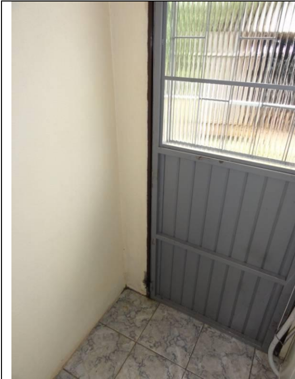
Porta de ferro - Garagem (DSC00140, 15/02/2011, 13:57h)
