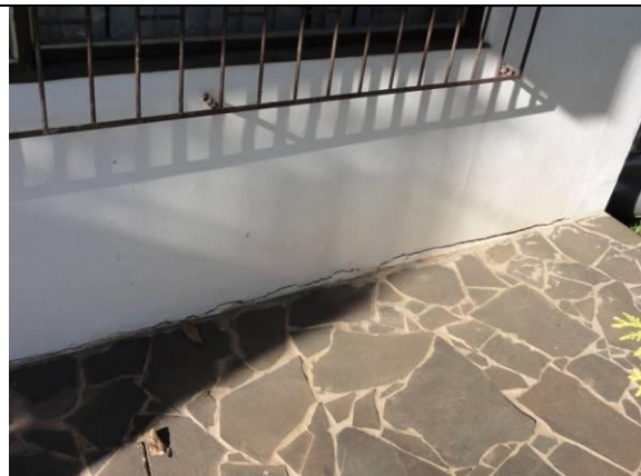
calçada (DSC00516, 16/02/2011, 08:20h)
