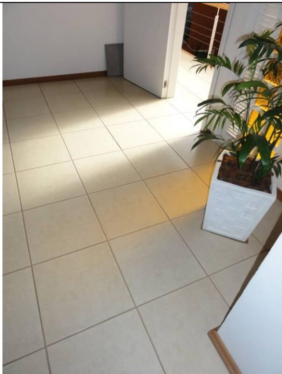
Parte Superior – Sala 3 - Piso cerâmico (DSC02056, 18/02/2011, 08:57h)
