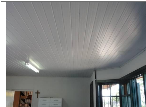
Sala 6- Teto com forro PVC (DSC01986, 18/02/2011, 08:40h)
