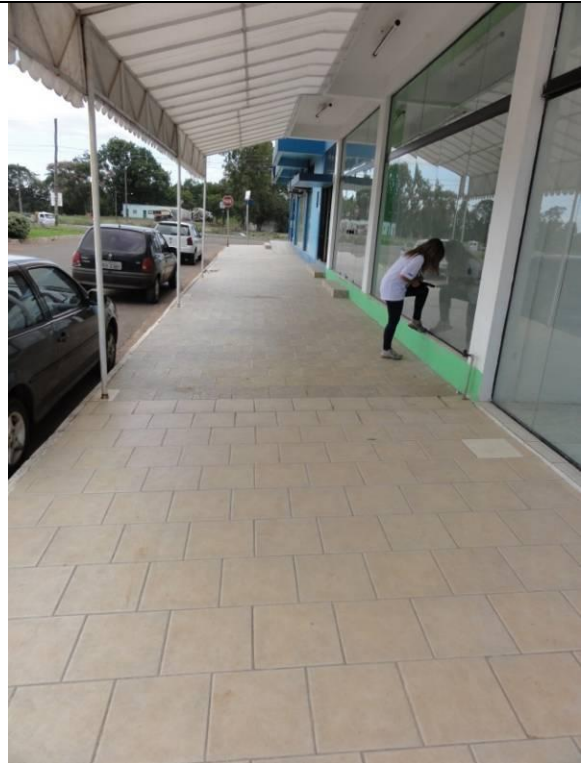
Calçada em torno do prédio (DSC00390, 15/02/2011, 15:51h)
