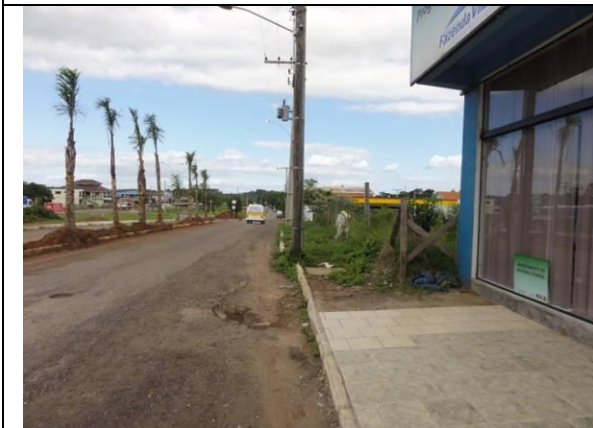
Calçada (DSC00434, 15/02/2011, 16:05h)
