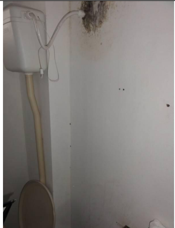
Sala 207 - Banheiro (DSC01702, 17/02/2011, 16:22h)
