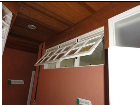
Corredor (DSC01921, 18/02/2011, 08:25h)
