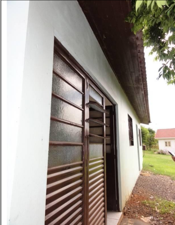
Porta de Entrada (DSC00010, 15/02/2011, 14:14h)
