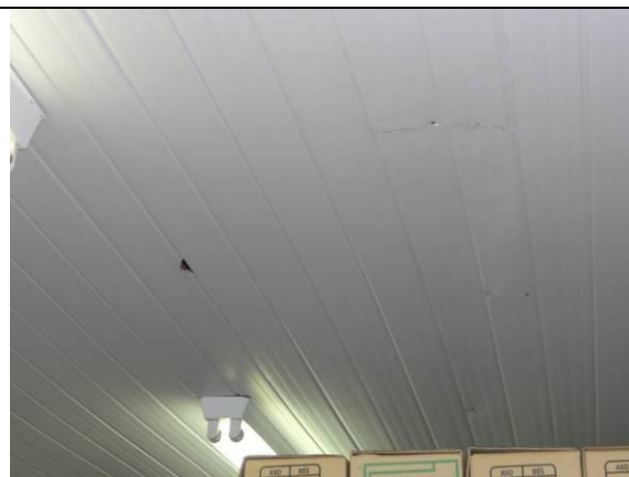
Sala 6 – Teto com forro PVC (DSC01971, 18/02/2011, 08:37h)
