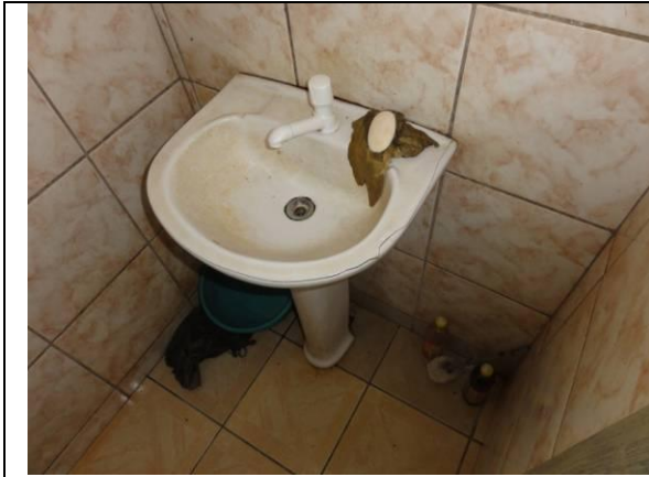
Banheiro (DSC00218, 15/02/2011, 14:20h)
