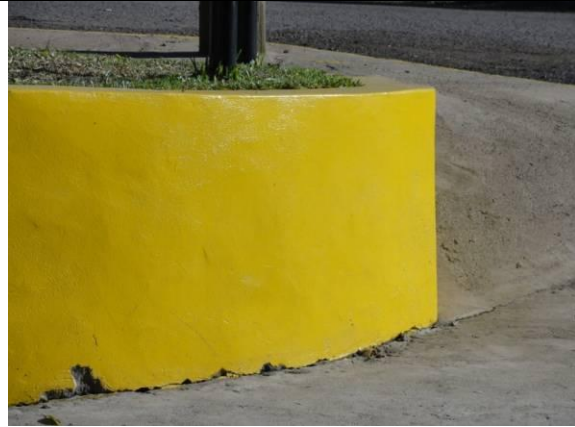
Canteiro (DSC00486, 16/02/2011, 08:01h)
