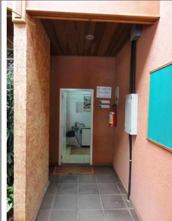
Corredor (DSC018788, 18/02/2011, 08:09h)
