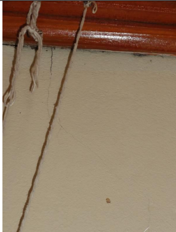
Divisória teto e parede (DSC00047, 15/02/2011, 13:32h)
