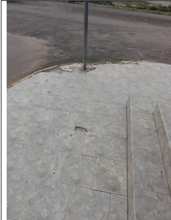
Calçada em torno do prédio (DSC00397, 15/02/2011, 15:51h)
