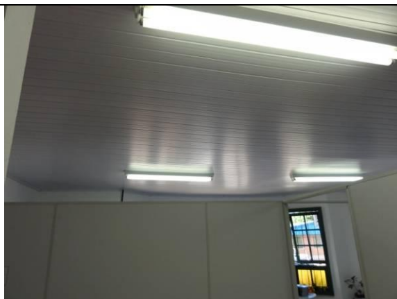
Sala 6 – Teto com forro PVC (DSC01972, 18/02/2011, 08:37h)
