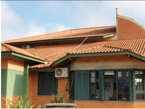
Telhado (DSC01792, 18/02/2011, 07:48h)
