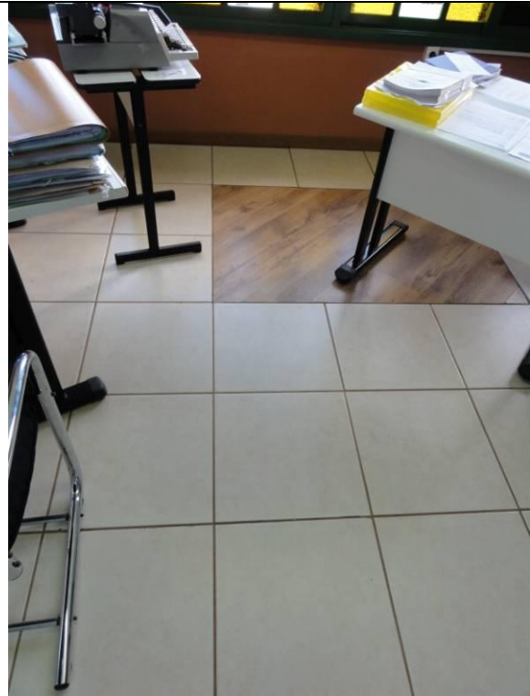
Sala 2 – Piso cerâmico (DSC01867, 18/02/2011, 08:06h)
