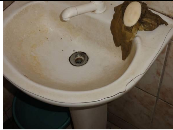
Banheiro – pia rachada (DSC00219, 15/02/2011, 14:20h)
