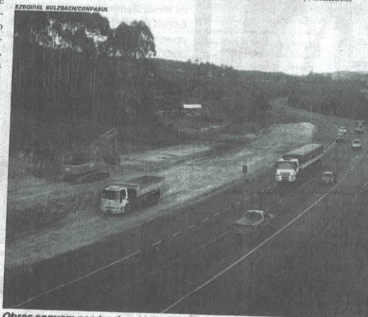
Obras seguem nos trechos já liberados sem atraso
