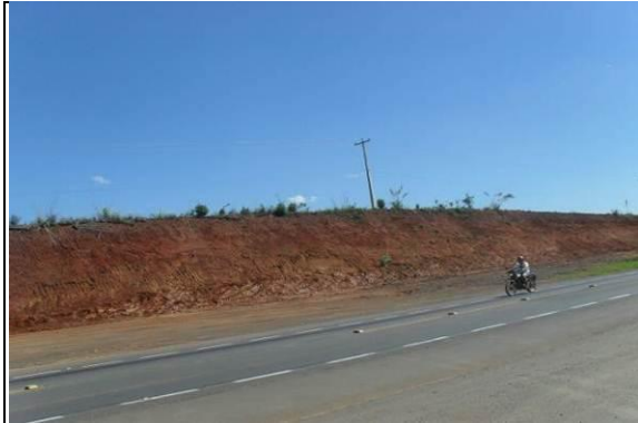
EC 17 – km 9+400, jazida de argila junto à faixa de domínio.
