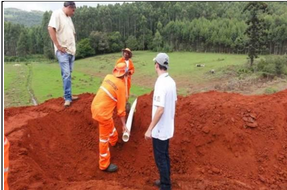
Treinamento da equipe de meio ambiente do Consórcio (implantação de dispositivos de controle de erosão – bacia de sedimentação).
