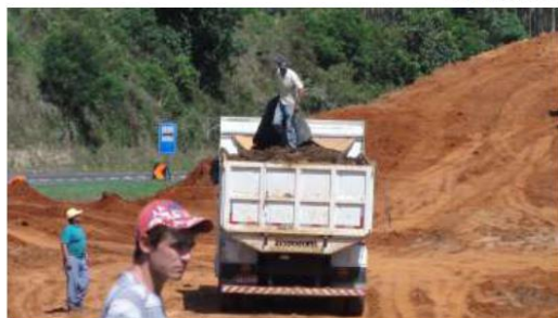
Motorista cobrindo a caçamba com lona.
