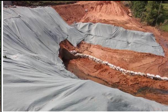
Revestimento de taludes de aterros não consolidados com manta geotêxtil.
