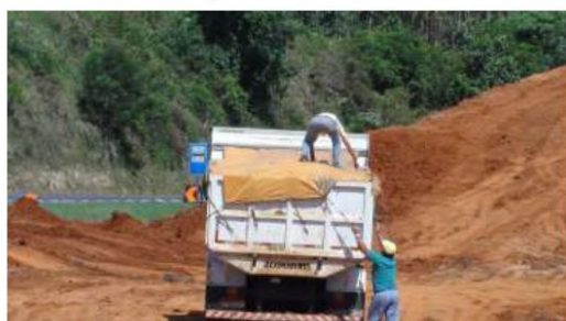
Detalhe da lona instalada.
