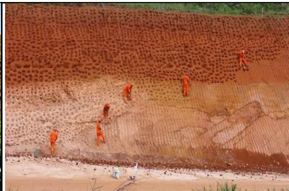
Hidrosemeadura. Preparação dos taludes.
