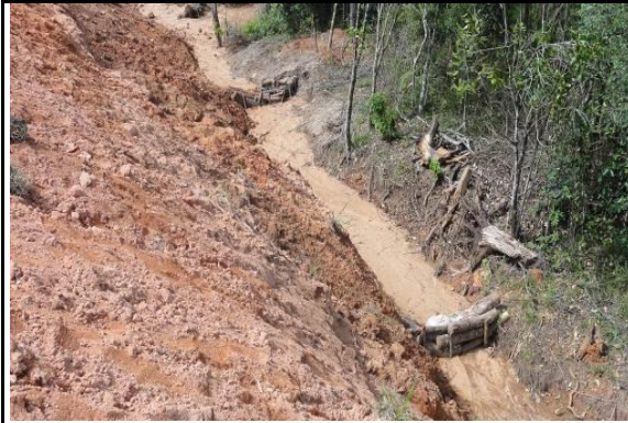
Barreira de sedimentos criada com a lenha oriunda da supressão.
