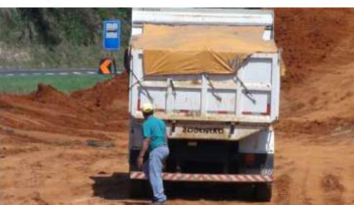
Lona sendo instalada sobre a carga.
