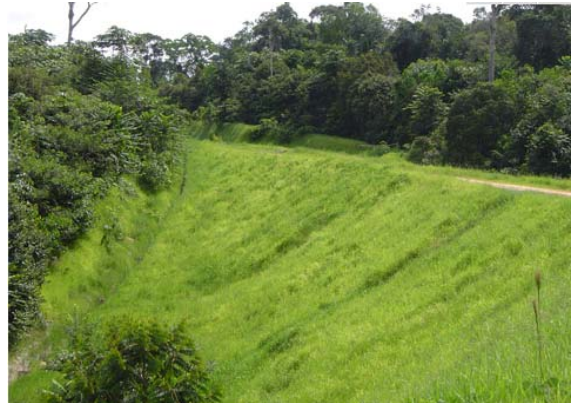
Figura 4 - Depois: Área após aplicação da fibromanta projetada. Fonte: Conspizza
