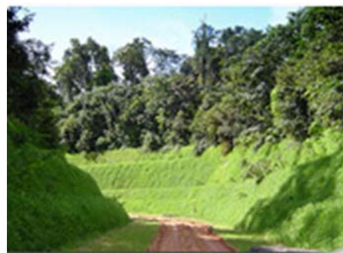
Figura 2 - Área após os procedimentos de hidrossemeadura. Fonte: Conspizza
