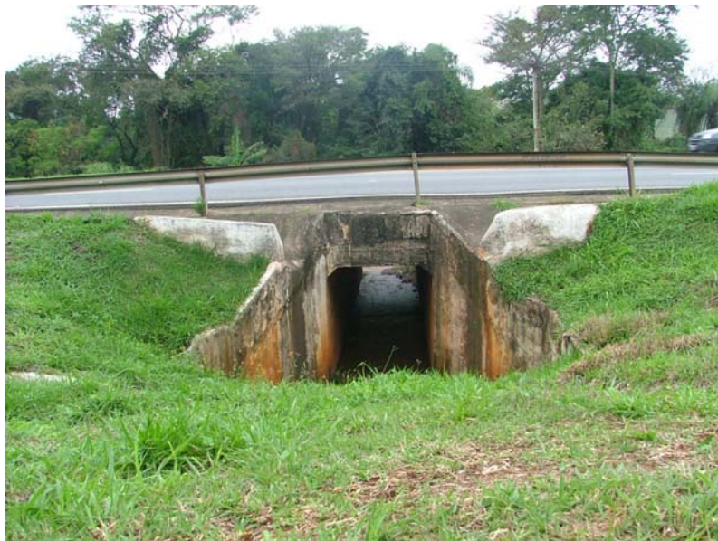
Figura 8 - Imagem de local de passagem de fauna na Rodovia Raposo Tavares (SP-270) em São Paulo. Demonstrando boa entrada de iluminação.
