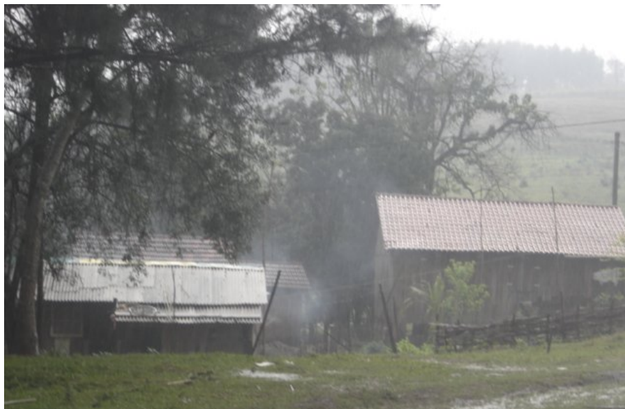
Figura 218 – Moradias sem infraestrutura, saneamento básico e fornecimento de energia, no km 354, município de Estrela
