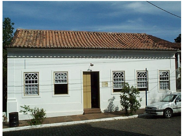
Figura 334 – Vista geral da Biblioteca pública
