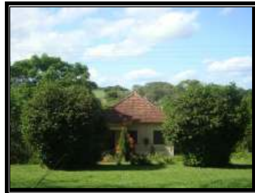
Foto 40 – Edificação com sistema construtivo de madeira, cobertura quatro águas com telha cerâmica do tipo francesa. Município de Tabaí
