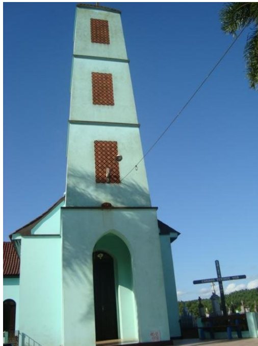
Figura 346 – Igreja localizada na comunidade de Linha Conceição, em Fazenda Vilanova. Edificação com sistema construtivo em alvenaria autoportante de tijolo maciço, esquadrias metálicas e presença de torre central
