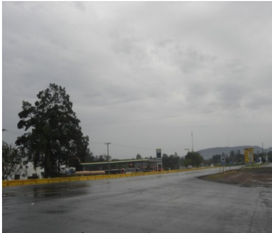
Figura 178 – Área já duplicada no km 386, em Tabaí. Necessidade de passarela
