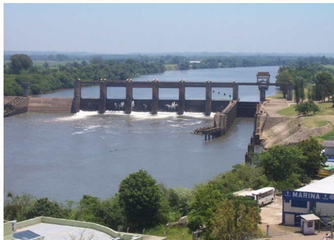
Figura 358 – Barragem Eclusa, Bom Retiro do Sul
