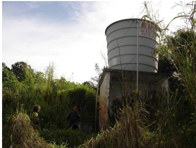
Figura 300 – Caixa d'água da TI Estrela, próxima da área de mata
