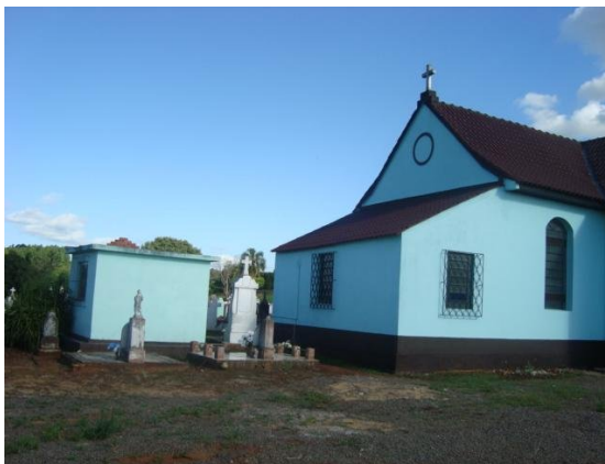
Figura 348 – Igreja localizada na comunidade de Linha Conceição, em Fazenda Vilanova. Edificação com sistema construtivo em alvenaria autoportante de tijolo maciço, esquadrias metálicas e presença de torre central
