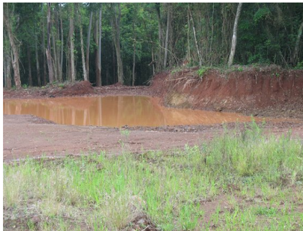
Figura 364 – Pequeno talude no passivo nº 02
