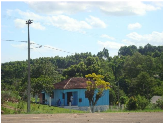
Figura 356 – Edificação com sistema construtivo de madeira, cobertura quatro águas com telha cerâmica do tipo francesa, presença de porão baixo e varanda frontal
