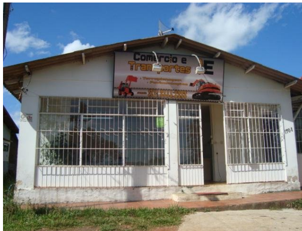
Figura 251 – Prestação de serviços, UTM 420066, 6726394
