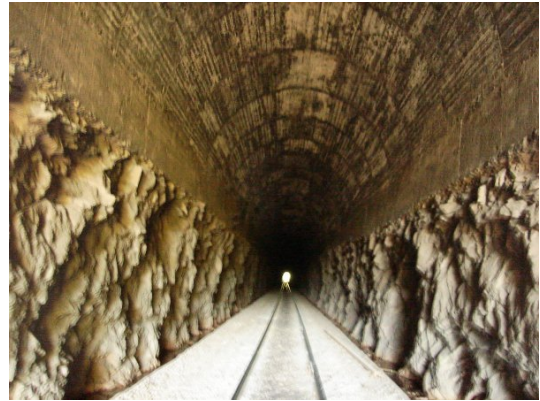
Figura 355 – Túnel Morro Azul
