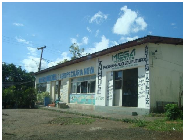
Figura 249 – Prestação de serviços, UTM 420066, 6726394
