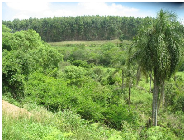
Figura 371 – Vista parcial do aterro e da área a jusante a partir da margem da rodovia
