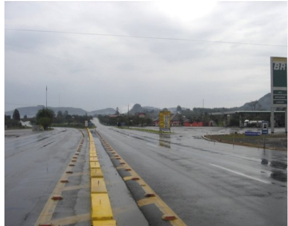
Figura 179 – Área já duplicada no km 386, em Tabaí. Necessidade de passarela
