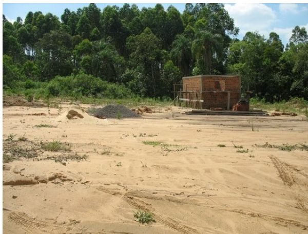
Figura 376 – Vista parcial do passivo nº 06
