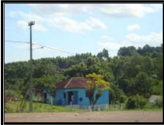
Foto 39 – Edificação com sistema construtivo de madeira, cobertura quatro águas com telha cerâmica do tipo francesa, presença de porão baixo e varanda frontal. Município de Tabaí.
