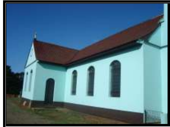
Foto 42 – Igreja localizada na comunidade de Linha Conceição, em Fazenda Vila Nova. Edificação com sistema construtivo em alvenaria autoportante de tijolo maciço, esquadrias metálicas e presença de torre central.
