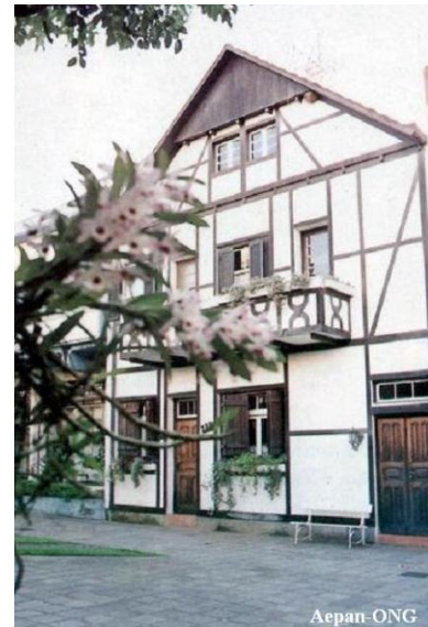
Figura 344 – Casa em estilo enxaimel no centro de Estrela Fonte: Aepan-ONG.
