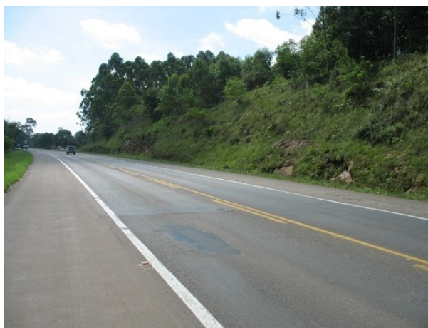
Figura 378 – Vista geral do corte
