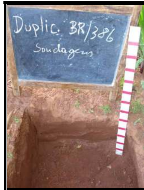
Foto 08 - Sondagens no km 358,8
