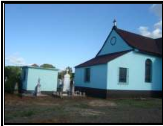
Foto 44 – Edificação com sistema construtivo em alvenaria autoportante, cobertura quatro águas com telha cerâmica do tipo francesa, verga reta e esquadria de madeira com bandeira fixa envidraçada. Localizada na Linha Conceição, em Fazenda Vila Nova.
