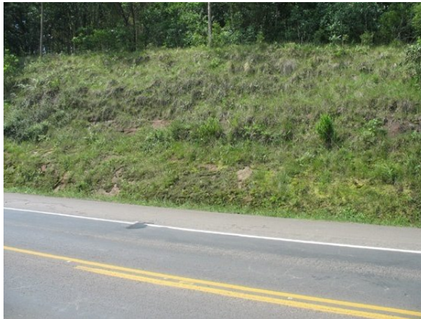
Figura 380 – Trecho do talude com boas condições de estabilidade
