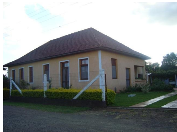
Figura 349 – Edificação com sistema construtivo em alvenaria autoportante, cobertura quatro águas com telha cerâmica do tipo francesa, verga reta e esquadria de madeira com bandeira fixa envidraçada. Localizada na Linha Conceição, em Fazenda Vilanova
