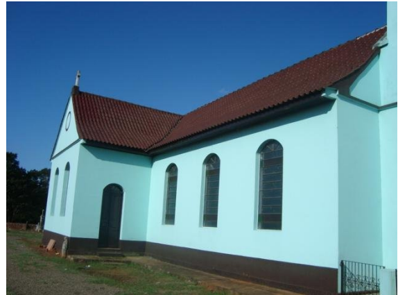
Figura 347 – Igreja localizada na comunidade de Linha Conceição, em Fazenda Vilanova. Edificação com sistema construtivo em alvenaria autoportante de tijolo maciço, esquadrias metálicas e presença de torre central
