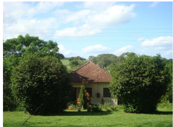
Figura 357 – Edificação com sistema construtivo de madeira, cobertura quatro águas com telha cerâmica do tipo francesa
