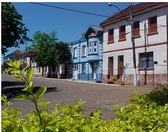
Figura 359 – Casario antigo na cidade de Bom Retiro do Sul
