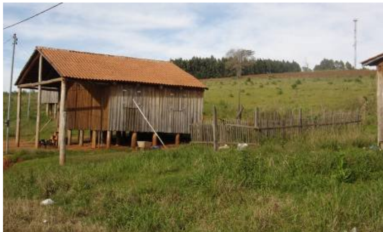
Figura 298 – Habitação construída pela FUNAI
