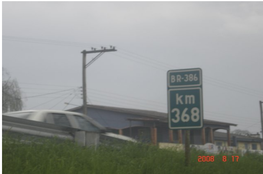
Figura 174 – Fazenda Vilanova. Necessidade de sinalização horizontal e vertical e viadutos (km 368)
