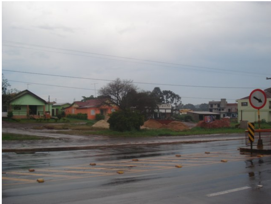
Figura 220 – Residências localizadas a cerca de 20 m da margem esquerda da BR-386, Fazenda Vilanova
