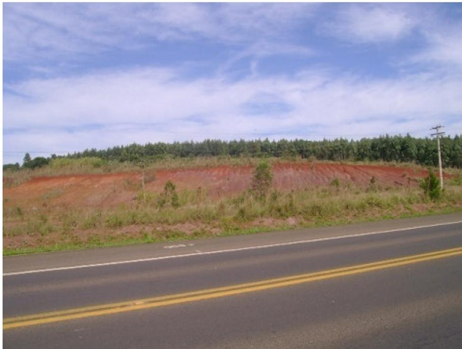
**Figura 9 – Argila muito arenosa, provável material a ser utilizado para camada de aterro, no km 358+900, lado direito**
