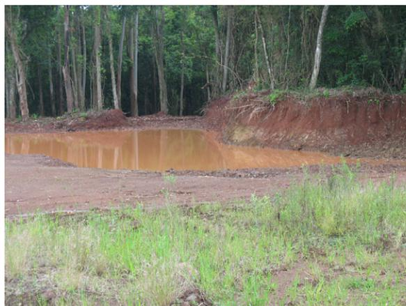
**Figura 74 – Corte de barranco de solo argiloso com área alagada devido à baixa taxa de infiltração após período de chuva**
