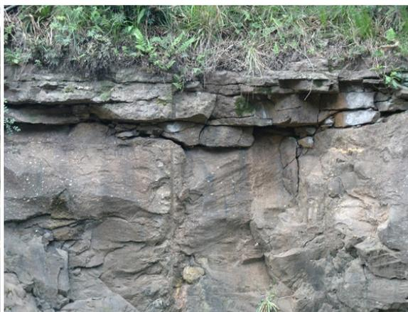
**Figura 40 – Detalhe da disjunção tabular e da porção maciça da rocha basáltica, km 353+660**
