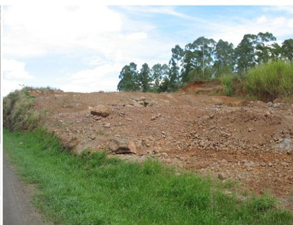
**Figura 38 – Afloramento no km 352+140, lado direito da rodovia, onde se observa que já foi removido o horizonte de solo, restando parte do regolito**
