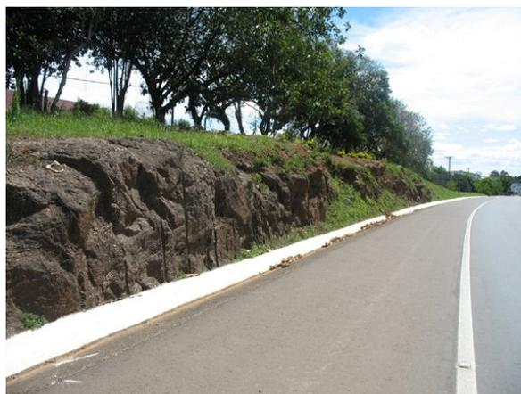
**Figura 35 – Afloramento de basalto vesicular com 2,5 m de altura e 50 m de extensão no km 351**
