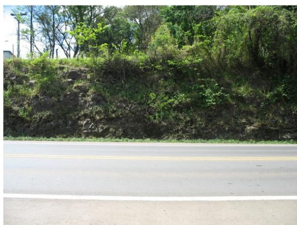
**Figura 37 – Afloramento de basalto com disjunção horizontal e fraturamento intenso, km 352+120**
