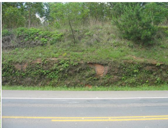
**Figura 75 – Afloramento de arenito em corte de estrada onde se observa água vertendo após período de chuva**
