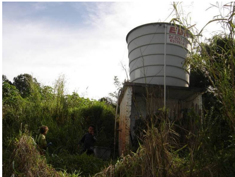
Figura 9 – Caixa d'água da TI Estrela, próxima da área de mata
