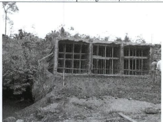
Foto 16 – Substituição de galeria tripla para passagem de um córrego.
