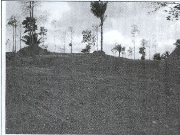
Foto 15 – Jazida “do Roberto” já esgotada e sendo recuperada com solo superficial
