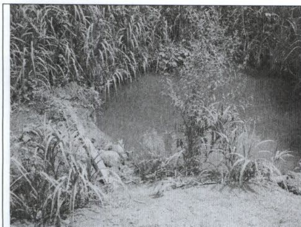
Foto 07 – água represada em obra de arte
