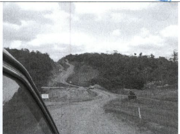
Foto 14 – Corte realizado para regularização da rodovia.
