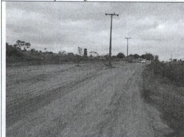
Foto 03 – Obras de terraplenagem
