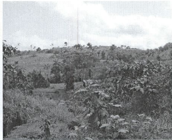
FIGURA 37 – Local onde há alagamento – lado direito – km 14+800 – Ponto 17 GPS.
