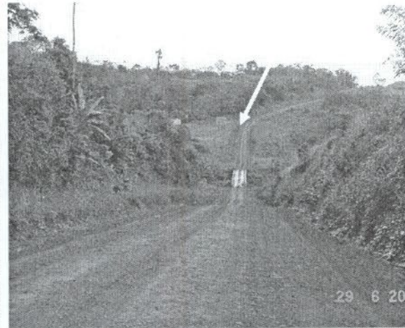
FIGURA 97 – Visão final do trecho e ponte sobre o Rio Seiko – km 82+000.
