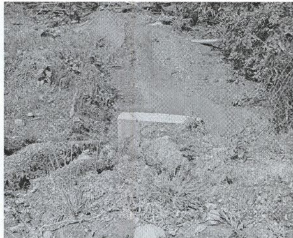
FIGURA 71 – Visão à esquerda de bueiro que drena o córrego originado na área da Figura 70.
