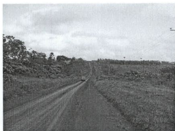
FIGURA 20 – Visão da plataforma rodoviária – km 9.
