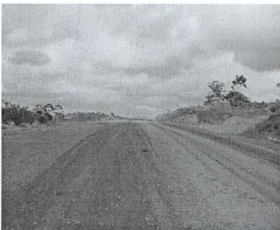
FIGURA 34 – Área de empréstimo utilizada na conserva da rodovia – lado direito – km 12+900 – Ponto 15 GPS.
