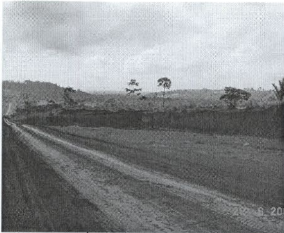
FIGURA 24 – Área de empréstimo utilizada na conserva da rodovia – lado esquerdo – km 10+600 – Ponto 11 GPS.
