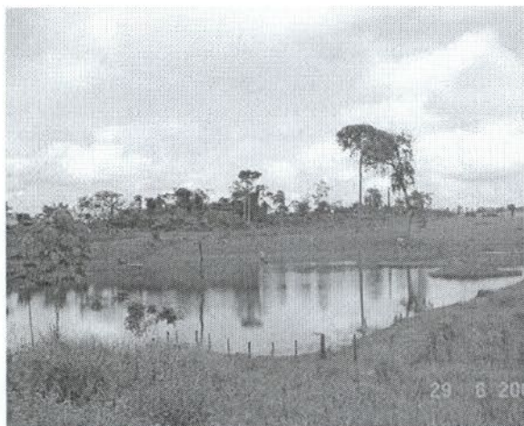
FIGURA 18 – Represamento de água no lado direito da rodovia – km 9+100.
