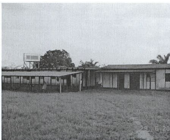
FIGURA 01 – Construções existentes na área proposta para implantação do Canteiro de Obras Administrativo.
