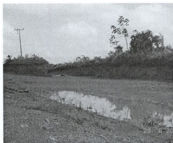
FIGURA 22 – Área de empréstimo utilizada na conserva da rodovia – lado direito – km 10+600 – Ponto 11 GPS.
