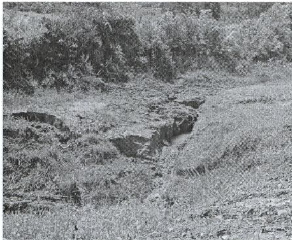
FIGURA 70 – Área de nascente à direita da rodovia.
