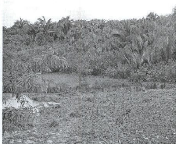
FIGURA 45 – Água acumulada no lado direito da rodovia – km 21+200 – Ponto 21 GPS.
