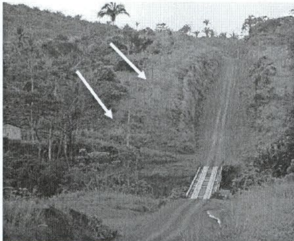
FIGURA 100 – Detalhe da ponte sobre o Rio Seiko e posteamento CELPA na faixa de domínio.
