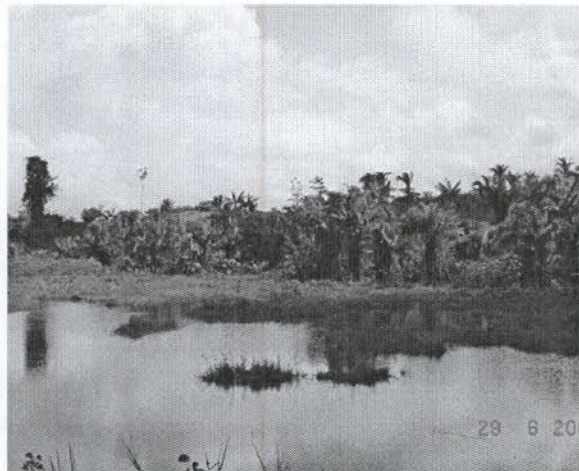
FIGURA 47 – Acúmulo de água no lado direito da rodovia – km 25+500 – Ponto 26 GPS.
