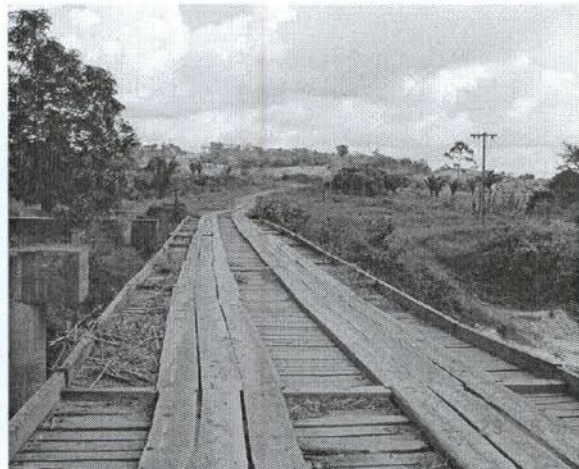
FIGURA 75 – Ponte atual sobre o Rio Penetecal II – km 54+900.
