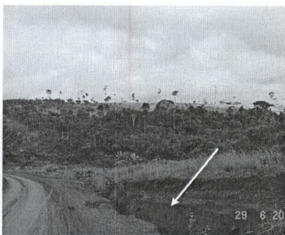
FIGURA 29 – Erosão em sulco próxima ao Rio Panelas.
