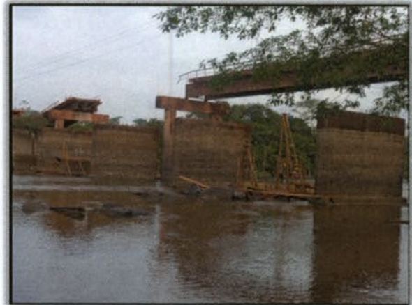
Foto 9 - Vista das estruturas de concreto que servirão de base para ponte de madeira. Lado Direito. Margem esquerda. S 03°51'45,4" W 050°26'44,0" 05/01/2016
