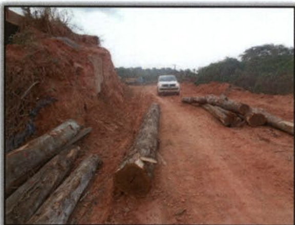
Foto 176 – Madeira que está sendo empregada nas obras da ponte. Lado Direito. Margem esquerda. S 03°51'45,4" W 050°26'44,0" 05/01/2016
