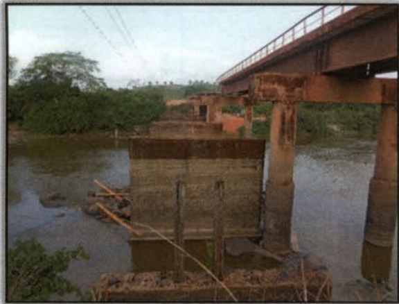
Foto 8 - Vista frontal das estruturas de concreto que servirão de base para ponte de madeira. Lado Direito. Margem esquerda. S 03°51'45,4" W 050°26'44,0" 05/01/2016
