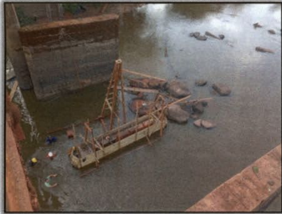
Foto 14 – Aumento da altura da base de concreto. Lado Direito. Margem esquerda. S 03°51'45,4" W 050°26'44,0" 05/01/2016
