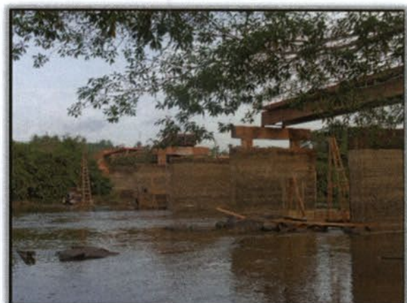
Foto 7 – Estruturas de concreto que serão utilizadas na construção da ponte de madeira. Lado Direito. Margem esquerda. S 03°51'45,4" W 050°26'44,0" 05/01/2016
