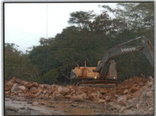
Foto 04 – Base de rochas sendo implementada no leito do rio. Lado Esquerdo. Margem esquerda. S 03°51'45,4" W 050°26'44,0" 16/12/2015
