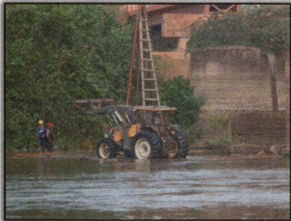
Foto 10 - Máquina auxiliando nas atividades no leito do rio. Lado Direito. Margem esquerda. S 03°51'45,4" W 050°26'44,0" 05/01/2016
