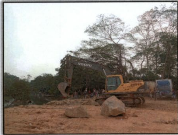
Foto 01 – Execução da rampa de acesso à área de aterro. Lado Esquerdo. Margem esquerda. S 03°51'45,4" W 050°26'44,0" 16/12/2015
