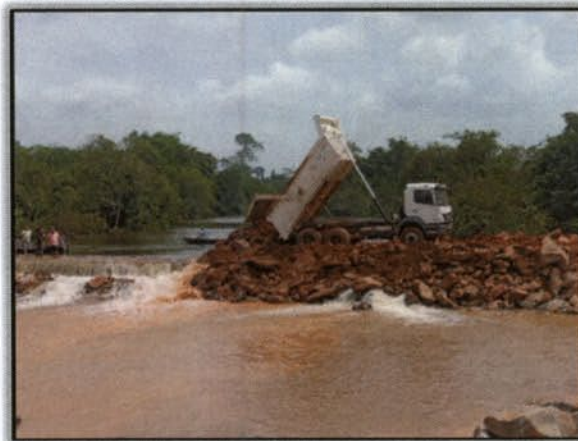
Foto 08 – Deposição de aterro sobre o desvio. Lado esquerdo. Margem esquerda. S 03°51'45,4" W 050°26'44,0" 06/01/2016
