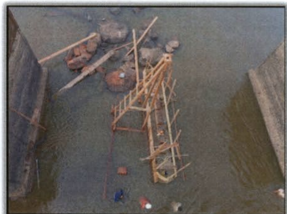
Foto 13 - Reforço da base de concreto entre vãos da estrutura. Lado Direito. Margem esquerda. S 03°51'45,4" W 050°26'44,0" 05/01/2016
