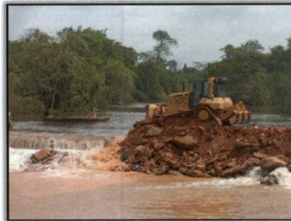
Foto 10 – Terraplanagem do aterro sobre o desvio. Lado esquerdo. Margem esquerda. S 03°51'45,4" W 050°26'44,0" 06/01/2016
