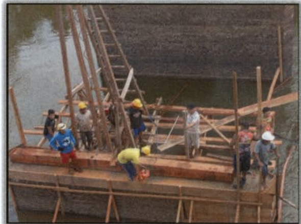
Foto 2817 – Preparação de fundação para apoio de estrutura de madeira. Lado Direito. Margem esquerda. S 03°51'45,4" W 050°26'44,0" 06/01/2016
