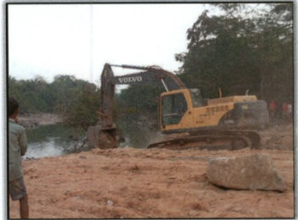
Foto 02 – Transposição de material para o leito do rio. Lado Esquerdo. Margem esquerda. S 03°51'45,4" W 050°26'44,0" 16/12/2015
