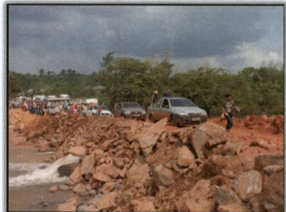
Foto 165 – Tráfego liberado para veículos. Lado esquerdo. Margem esquerda. S 03°51'45,4" W 050°26'44,0" 06/01/2016
