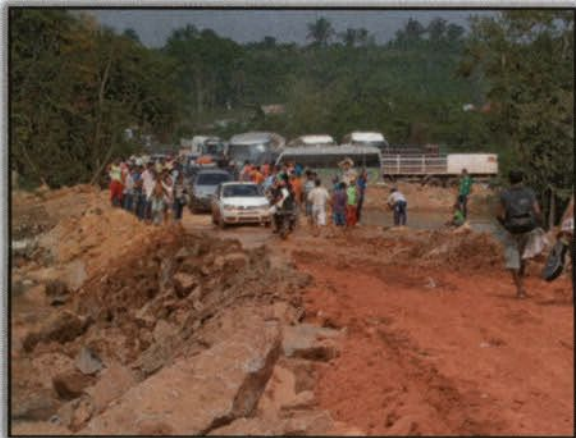
Foto 15 – Início do tráfego de veículos sobre o desvio. Lado esquerdo. Margem esquerda. S 03°51'45,4" W 050°26'44,0" 06/01/2016
