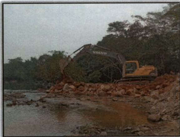
Foto 03 – Avanço do aterro que servirá de base para o desvio de caráter emergencial. Lado Esquerdo. Margem esquerda. S 03°51'45,4" W 050°26'44,0" 16/12/2015
