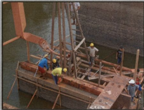
Foto 2716 – Preparação de fundação para apoio de estrutura de madeira. Lado Direito. Margem esquerda. S 03°51'45,4" W 050°26'44,0" 06/01/2016
