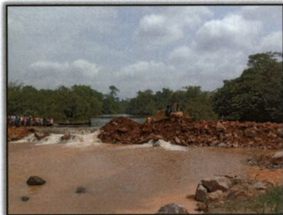
Foto 09 – Máquina realizando terraplanagem sobre o desvio. Lado esquerdo. Margem esquerda. S 03°51'45,4" W 050°26'44,0" 06/01/2016
