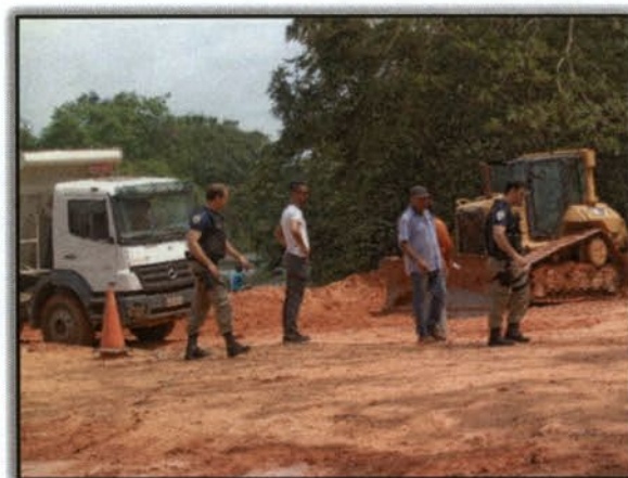
Foto 1 – PRF acompanhando execução das atividades Margem esquerda. S 03°51'45,4" W 050°26'44,0" 06/01/2016
