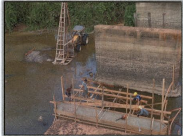
Foto 15 – Trabalhadores reforçando base de concreto entre vão da estrutura principal. Lado Direito. Margem esquerda. S 03°51'45,4" W 050°26'44,0" 05/01/2016
