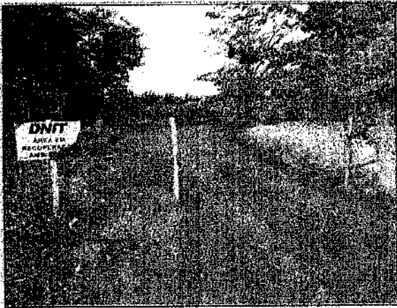
Foto 7 - Placas danificadas por ovelhas. S 03°51'38.7" W 050°25'53.1" 20/10/2015
