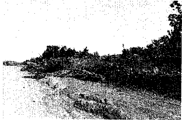
Foto 10: Supressão e Limpeza do horizonte A.
