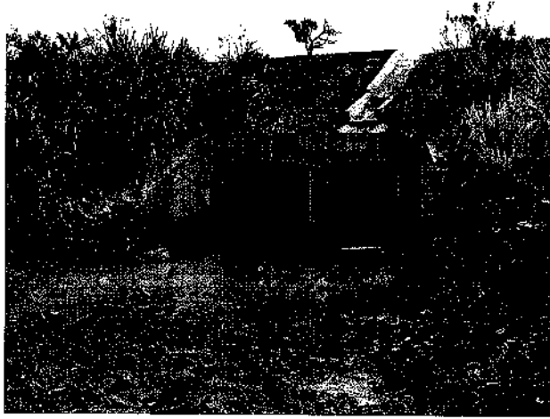
Foto 54: Exemplo de BDCC, nos quais deverão ser implantadas adaptações para garantir passagem seca de fauna.
