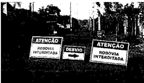
Foto 81 - Desvio para construção de pontes na BR-230, em Altamira (-03°12'1.70", -52°14'13.69")
