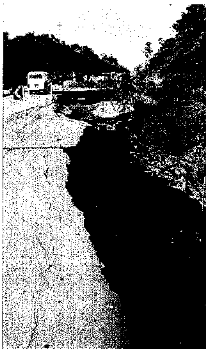
Foto 67: Ponto crítico: rompimento pavimento (-03°18'39.69", -52°32'59.74")
