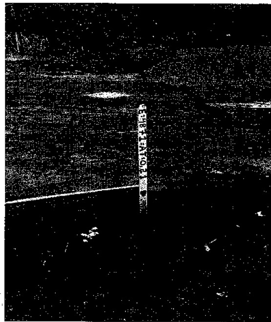
Foto 06 – Construção OAC's, detalhe estaca
