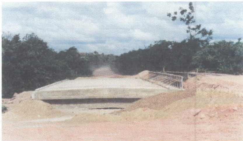
Construção da Ponte de Concreto Armado
