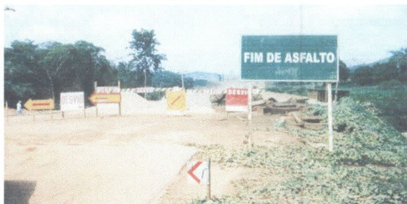
Construção da ponte de concreto armado.
