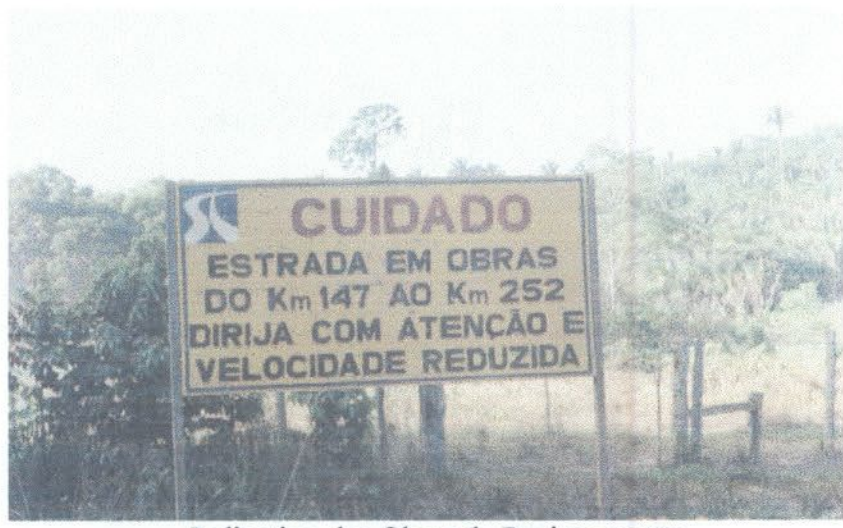
Indicativo das Obras de Pavimentação
