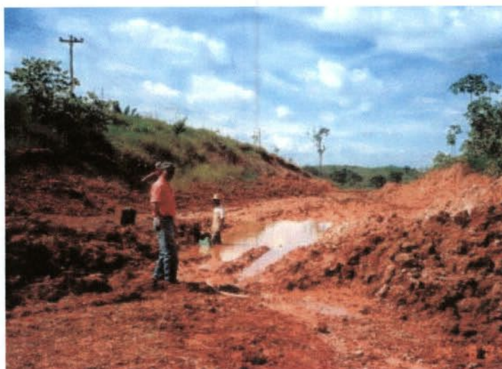
Foto 5 – Longo trecho apresentando atoleiros que interrompem freqüentemente o tráfego de veículos, entre eles ambulâncias e veículos com cargas perecíveis.
