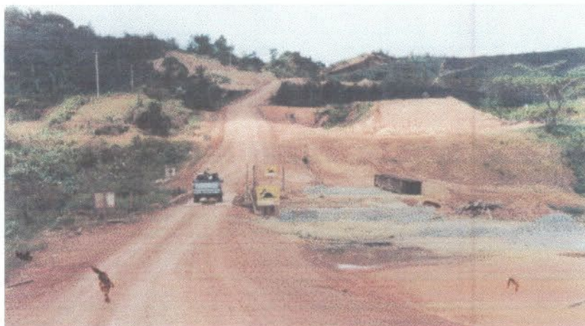
Terraplenagem/Movimentação de Material Particulado/Supressão de Vegetação
