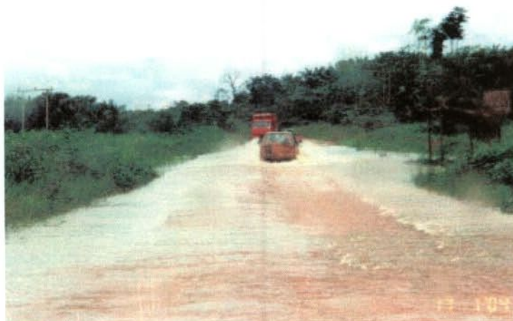
Foto 2 – Trecho constantemente inundado por falta de sistema de drenagem devidamente implantado e dimensionado.
