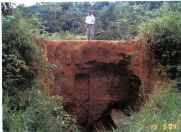
Foto 4 – Queda de barreira por falta de infra-estrutura necessária.
