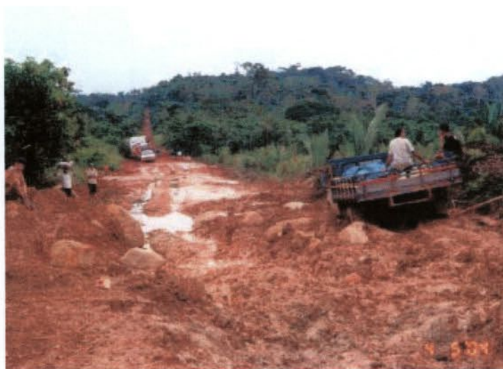
Foto 2 – Trecho constantemente inundado por falta de sistema de drenagem devidamente implantado e dimensionado.
