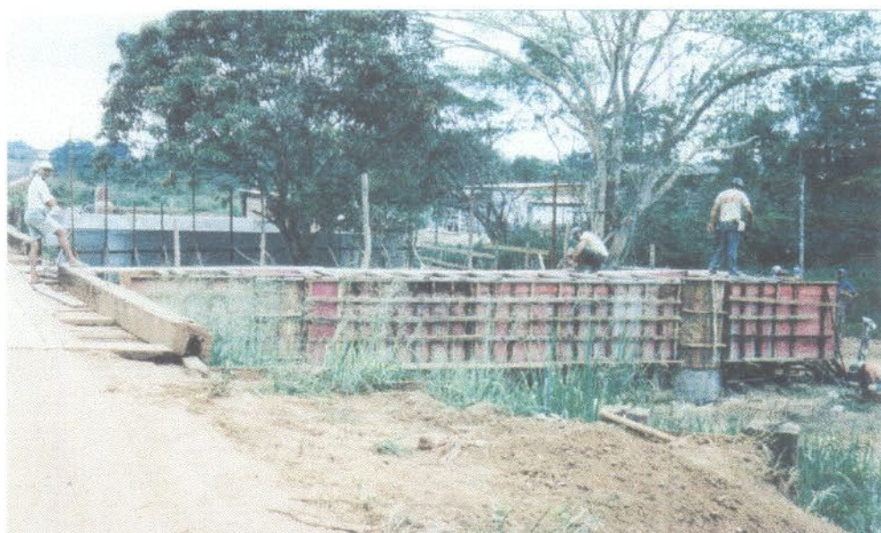
Construção de Ponte de Concreto Armado
