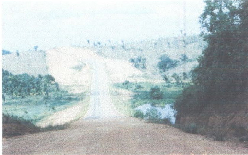
Corte de Taludes/Supressão de Vegetação
