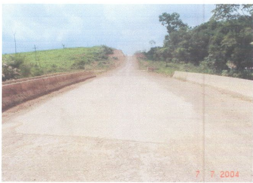
Construção de Ponte de Concreto Armado
