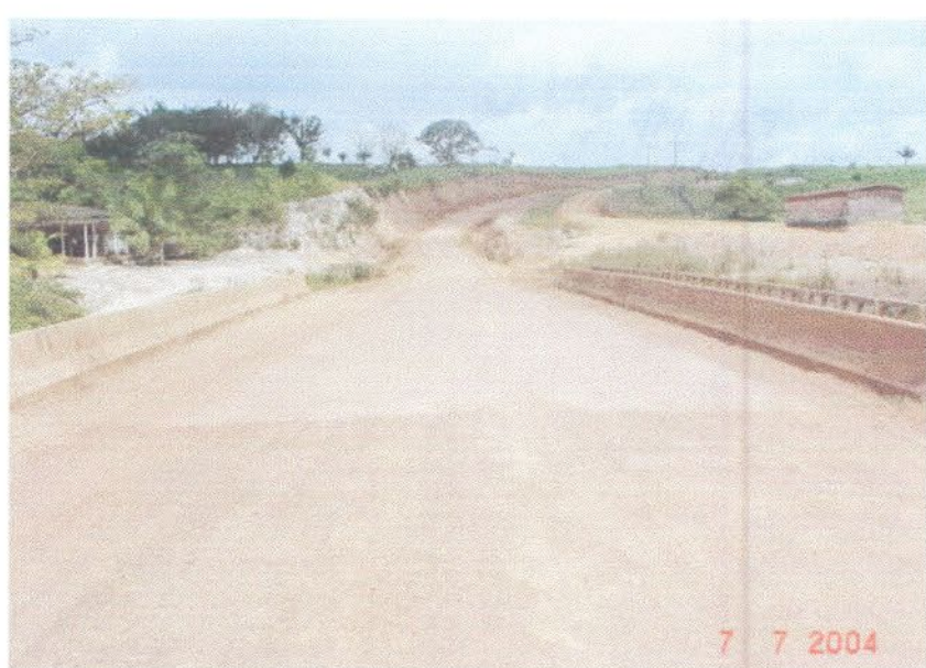
Corte de Talude/Supressão de Vegetação/Terraplenagem
