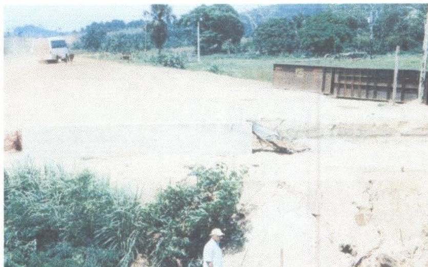
Construção da ponte de concreto armado.
