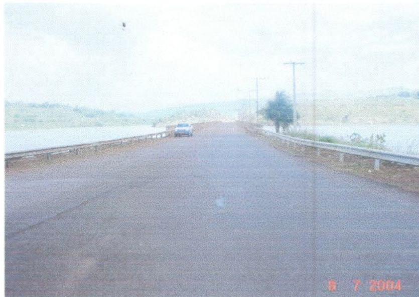
Obra de Pavimentação até a Ponte de Concreto Armado sobre o Lago de Tucuruí
