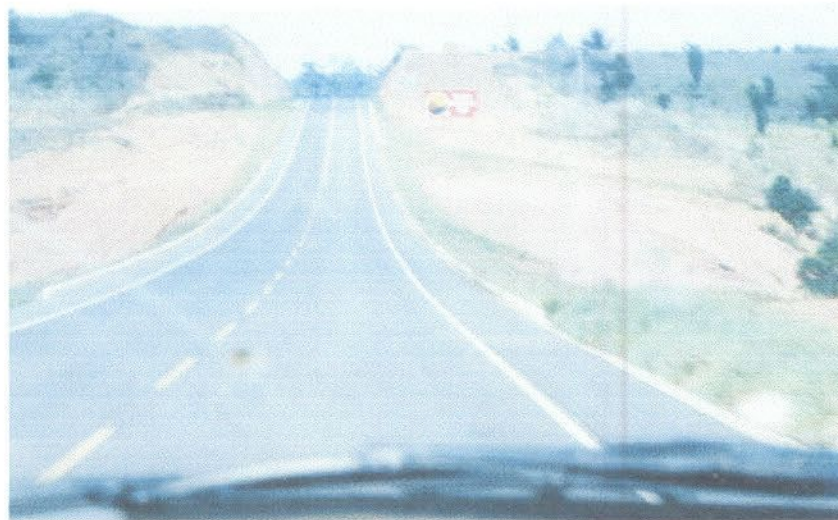
Corte de talude/Assoreamento de manancial
