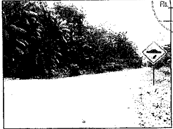
Foto 15 – Redutor de Velocidade. Eixo. S 04,61866° W 049,76906° 21/08/2013
