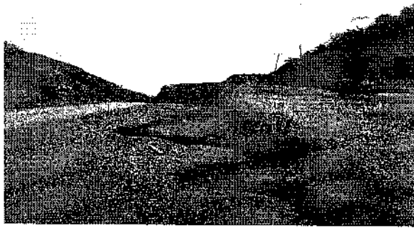
Lote 2: Processos erosivo m trecho onde houve serviços de terraplenagem
