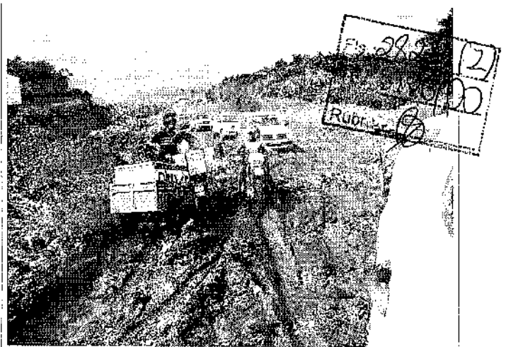
Lote 4: 8 km de atoleiro após a travessia do Rio Xingu
