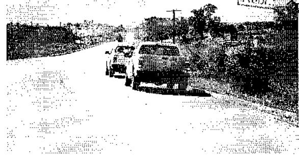
Lote 2: trecho pavimentado
