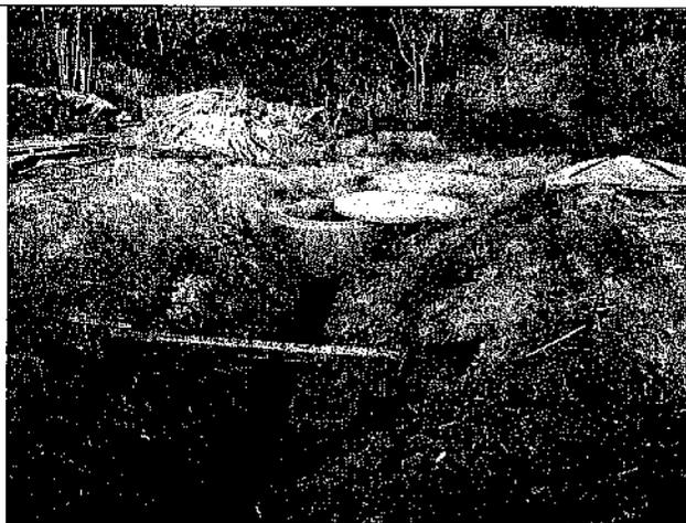
Foto 040 – Caixa de separação de água e óleo proveniente da rampa em cimento associada à oficina no canteiro
