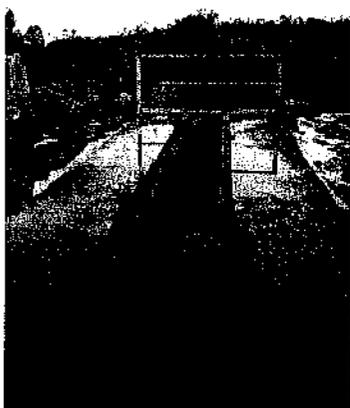
Foto 039 – Rampa em cimento para reparação de veículos associada à oficina no Canteiro da TORC
