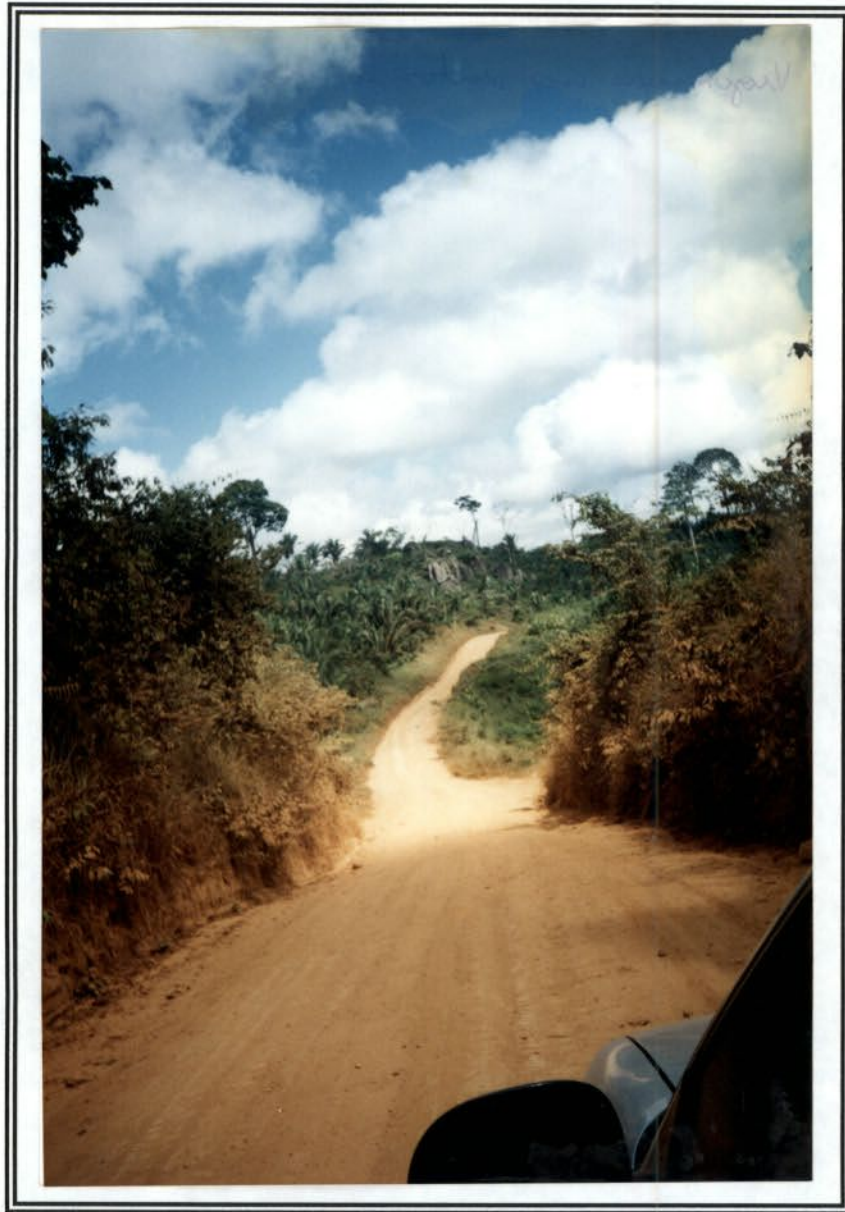
Foto 32 – Largura da pista de rolamento.
