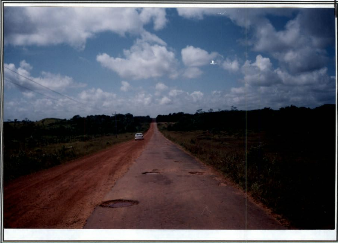
Foto 03. BR-308 - Meia Pista com asfalto ( aproximadamente 9Km).
