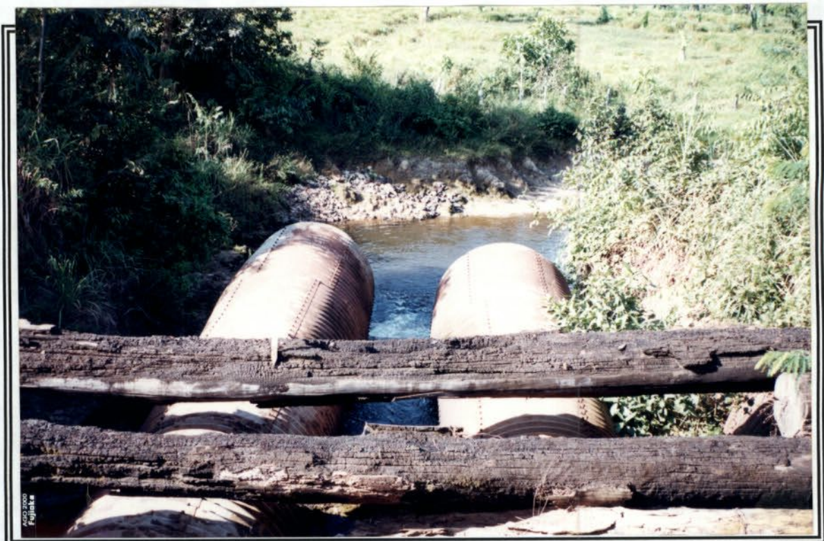
Foto 4 – Ponte sobre bueiro ármico duplo.
