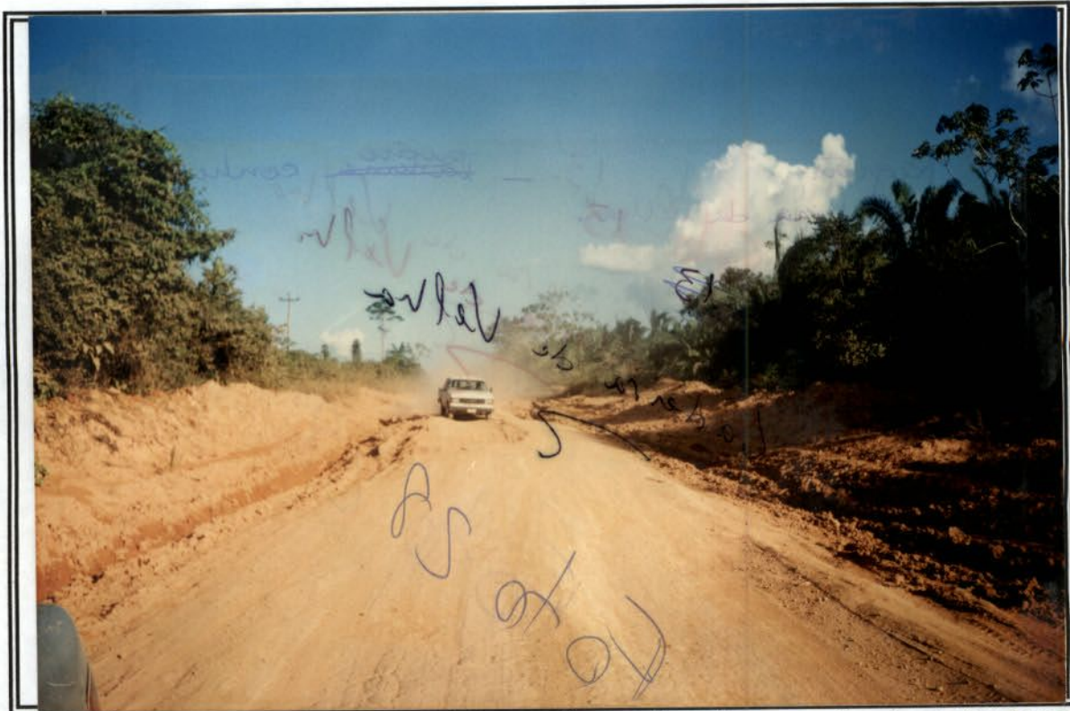
Foto 29 – Local de constante atoleiro na época das chuvas – Trecho entre Novo Repartimento e Altamira.
