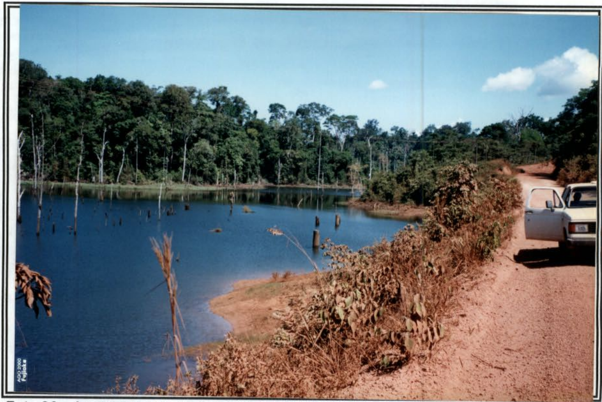
Foto 23 - Assoreamento do braço do lago Tucuruí provocado por erosão da rodovia.
