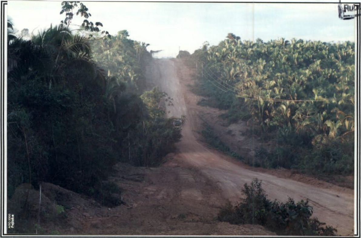
Foto 26 – Faixa de domínio da BR-230 em região ondulada.
