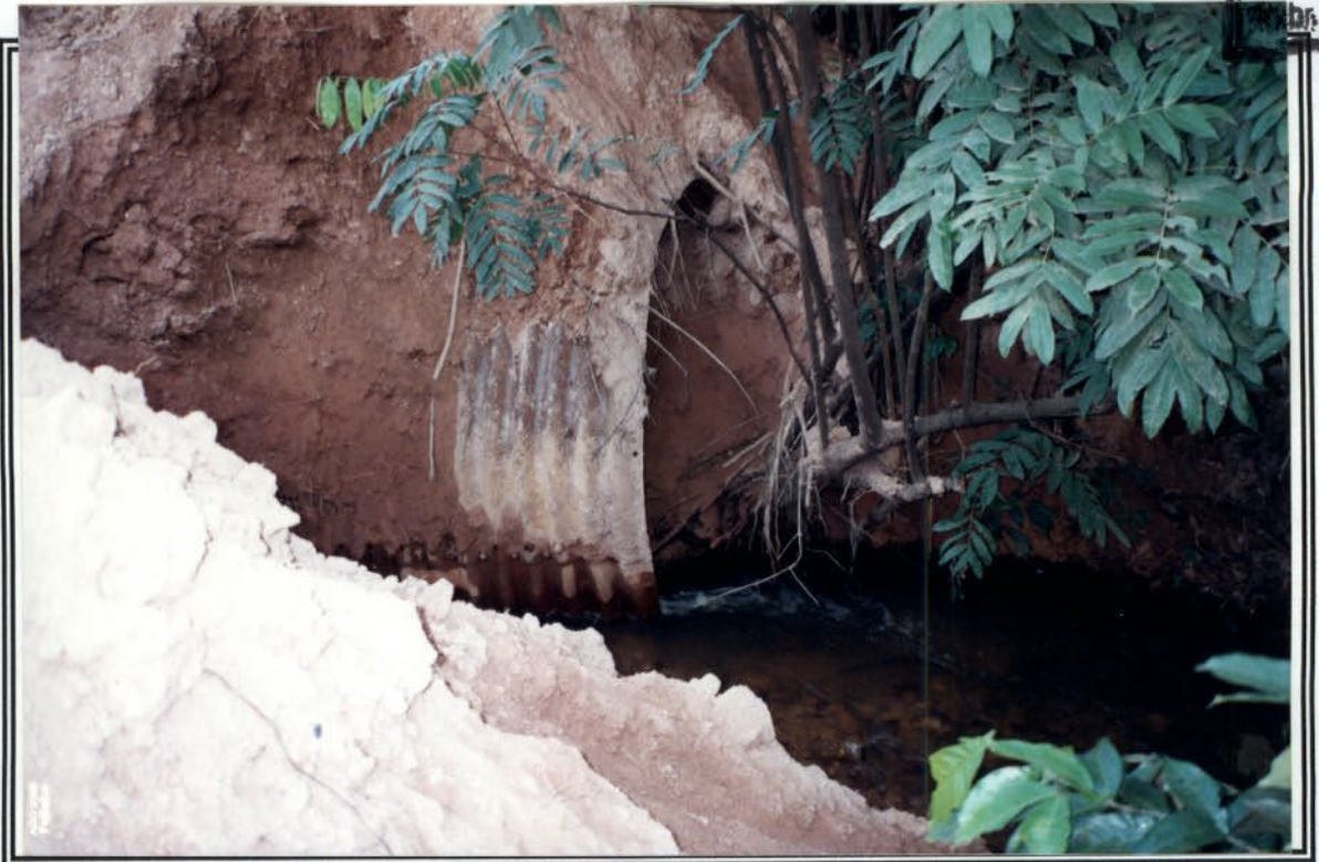
Foto 3 – Saída do bueiro ármico.
