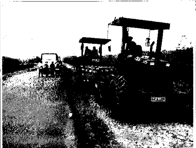
Figura 35: intervenções no acostamento em andamento durante a vistoria
