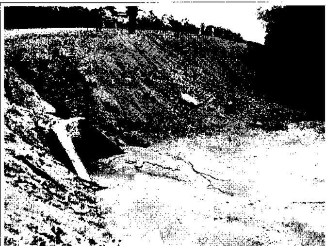
Figura 129: troca recente sem medidas de controle de erosão
