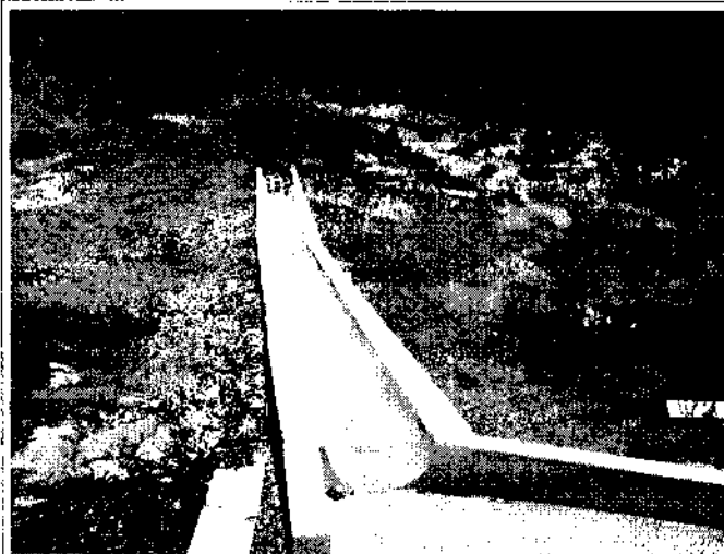
Figura 68: dissipador de energia instalado de forma incorreta, ainda causando sulcos erosivos
