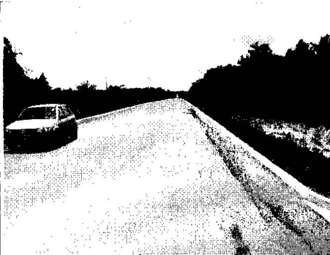
Figura 64: segmento da rodovia já pavimentado pela GAUTAMA
