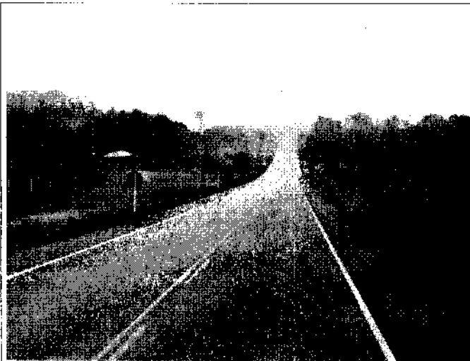
Figura 2: segmento do Lote 04 já finalizado
