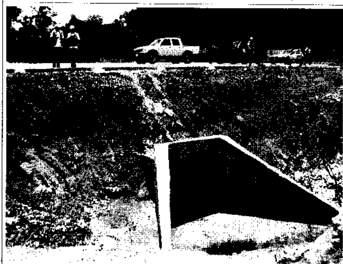
Figura 112: bueiro recentemente construído
