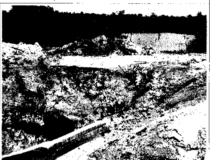
Figura 113: o bueiro foi implantado para escoamento de um empocamento formado pela rodovia
