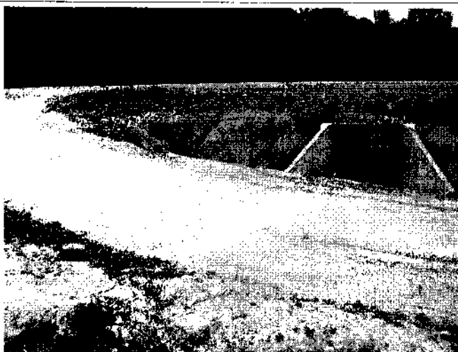
Figura 28: desvio com interrupção do curso d'água, facilmente constatado em frente ao bueiro tubular.
