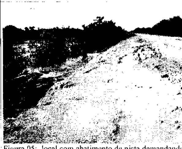
Figura 05: local com abatimento de pista demandando a reconstrução das camadas de base da plataforma da rodovia (ao lado verifica-se que o abatimento está causando o assoreamento/ aterramento progressivo do corpo d'água)
