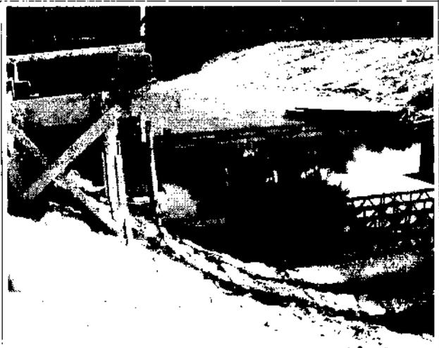
Figura 135: plataforma do pilar com estacas visíveis na parte inferior da ponte
