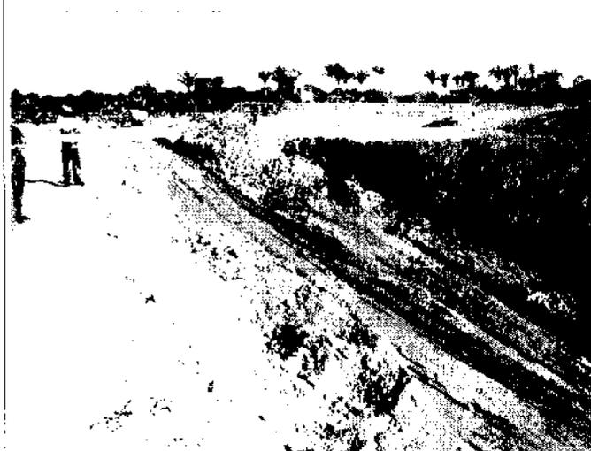
Figura 64: material depositado na área de barranca, sem medida de contenção
