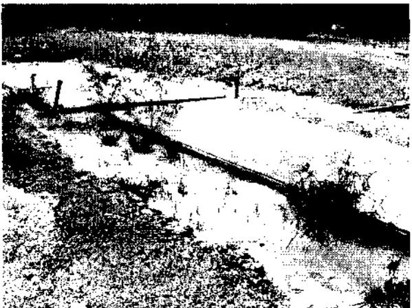
Figura 51: fossa séptica com trincas e infiltrações, possibilitando a entrada de água da chuva
