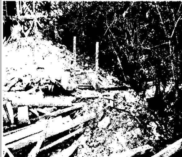
Figura 25: avanço do aterro com disposição conjunta de resíduos de obras
