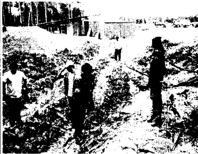
Figura 50: vala de drenagem na área da Oficina sem barreira de contenção e dissipação
