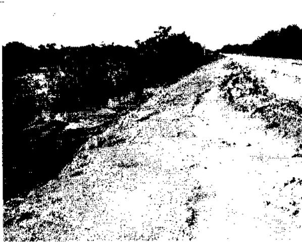
Figura 09: novos pontos erosivos surgiram, como este abatimento da plataforma da rodovia, com elevado assoreamento (Ponto GPS 007 - UTM 20M 789978 / 9573198)
