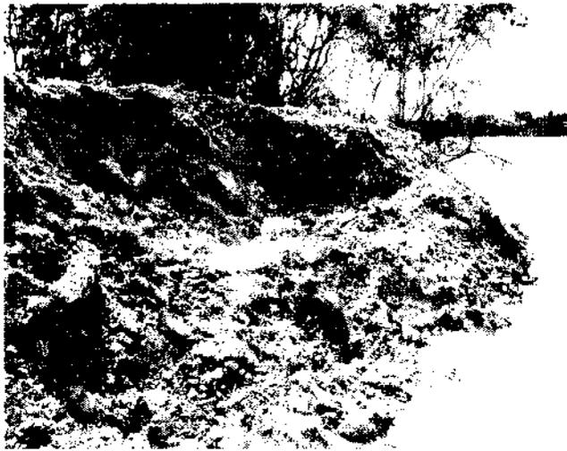
Figura 24: margem direita – parte final do aterro em contato com o rio, demandando retaludamento e contenção
