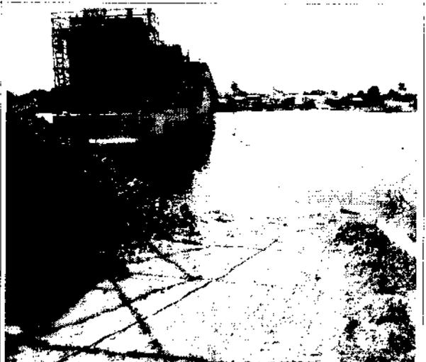
Figura 23: margem direita - rampa construída para acesso da balsa, com lançamento do solo escavado atingindo o leito do rio
