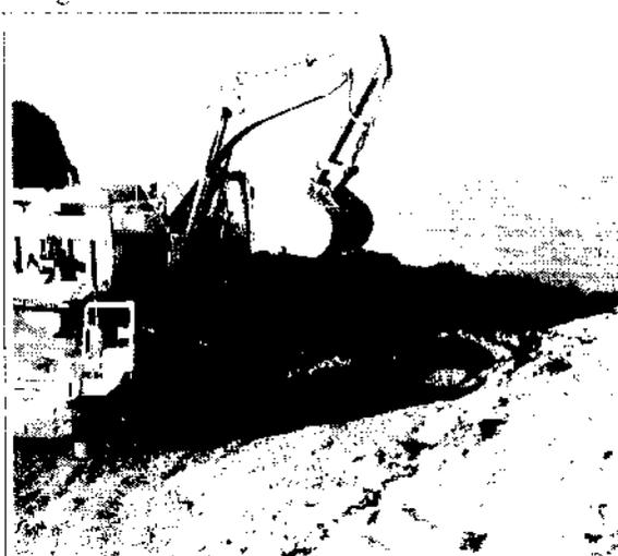
Figura 65: detalhe do aterramento em curso na margem do rio, com assoreamento das águas
