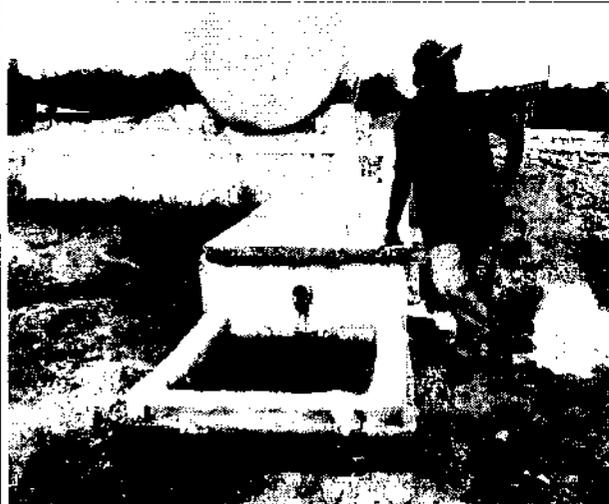
Figura 58: caixa separadora do tanque de combustível, com caixa de areia construída de modo incorreto
