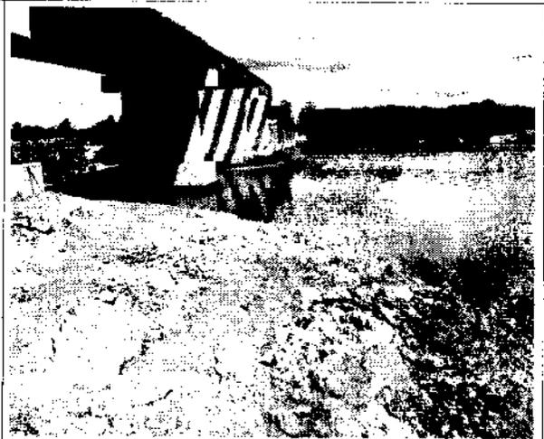
Figura 21: margem esquerda aterro realizado na margem pela escavação para os conjuntos de pilares, com aterramento do leito do rio
