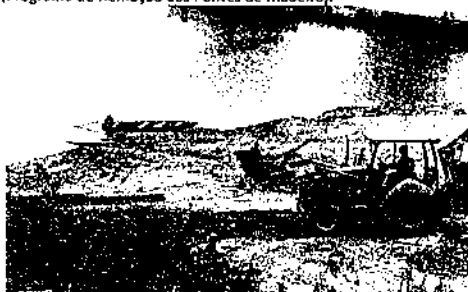
2 - Retirada das madeiras da antiga ponte, conforme PRP (Programa de Remoção das Pontes de Madeira).
