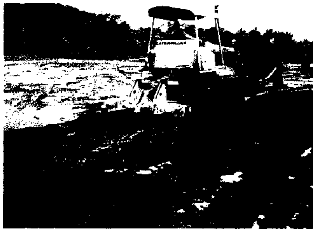
Remoção de resíduos de concreto e restos de material contaminado
