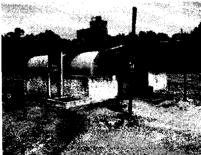
Figura 41: tancagem de combustível, somente com mureta de contenção, e sem caixa separadora água-óleo
