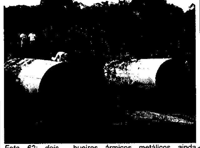
Foto 62: dois bueiros ármicos metálicos ainda funcionando
