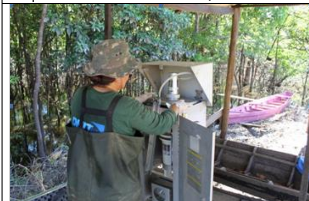
Figura 6.1.188 – Colocação do manômetro diferencial para a calibração do equipamento de monitoramento da Qualidade do Ar.
