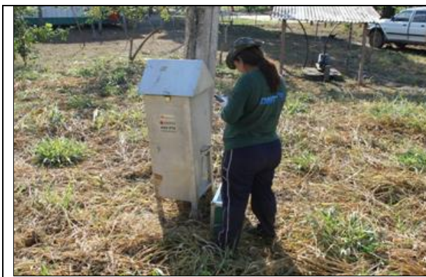
Figura 6.1.211 – Instalação do Aparelho de Monitoramento da Qualidade do Ar (AGV).
