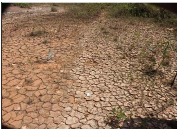
Figura 6.1.54 - Rachaduras no solo resultante da dilatação e contração provocada pelo umedecimento e ressecamento do material (Greta de contração). Coordenadas 20 M 596585 9390794. Fonte: Engespro. Data: 17/06/2014
