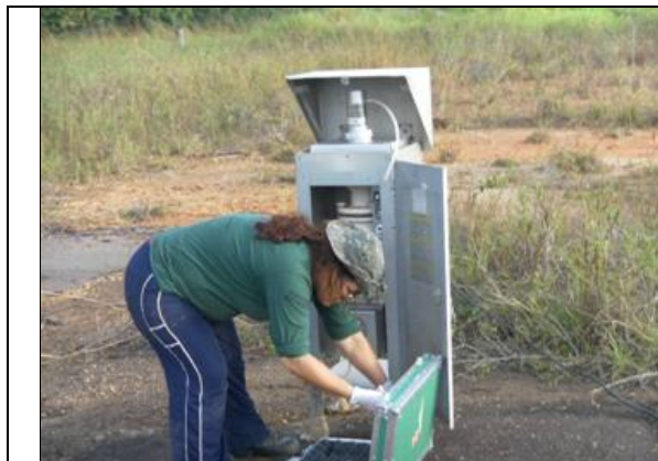
Figura 6.1.224 – Manômetro diferencial usado na calibração do aparelho de monitoramento da Qualidade do Ar.
