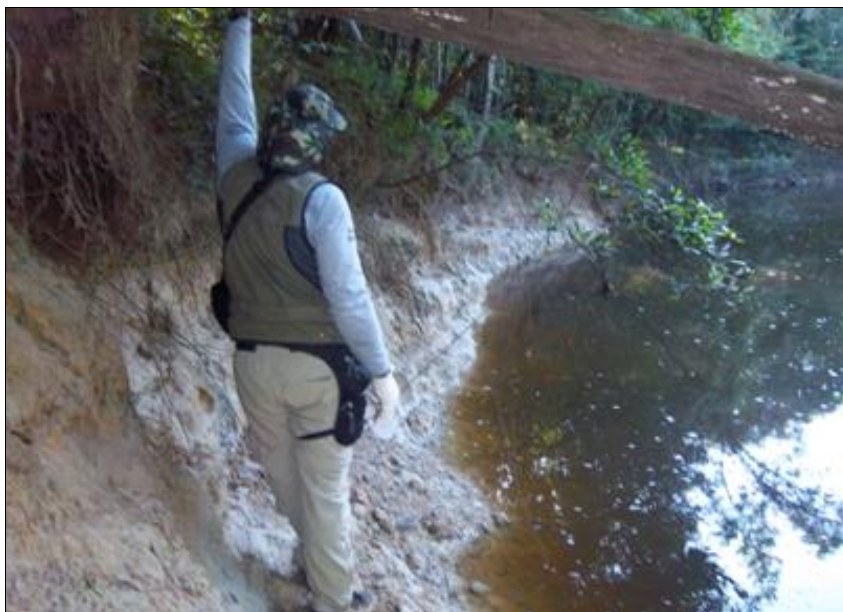
Figura 6.1.31 - Processo erosivo nas margens do Rio Jacaretinga provocada pela variação da vazão do rio. Coordenadas 20 M 669892 9457790. Fonte: Engespro. Data: 17/06/2014.
