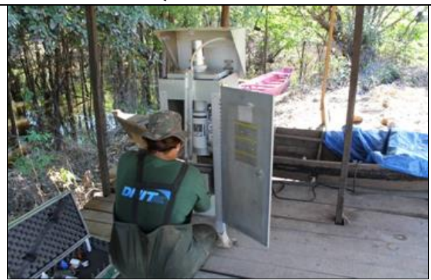
Figura 6.1.189 – Instalação do disco registrador no aparelho de Monitoramento da Qualidade do Ar.
