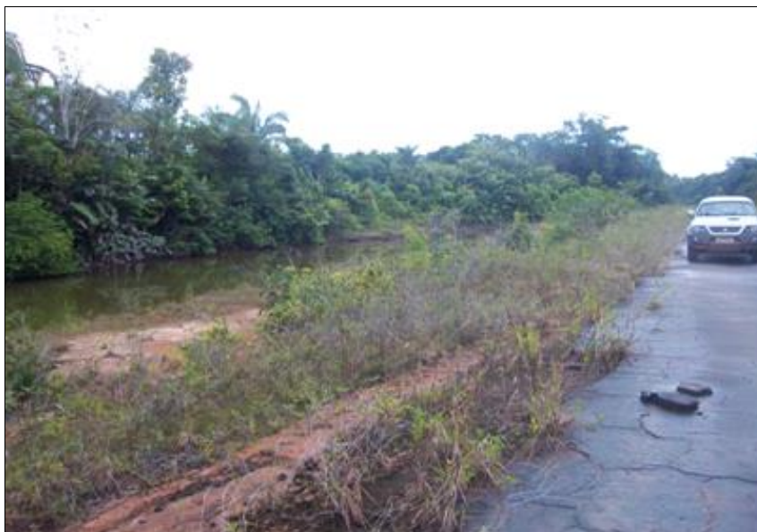
Figura 6.1.30 - Lagoa Marginal formada pelas caixas de empréstimos abandonadas, sem recuperação. Coordenadas 20 M 610108 9411833. Fonte: Engespro. Data: 19/06/2014.
