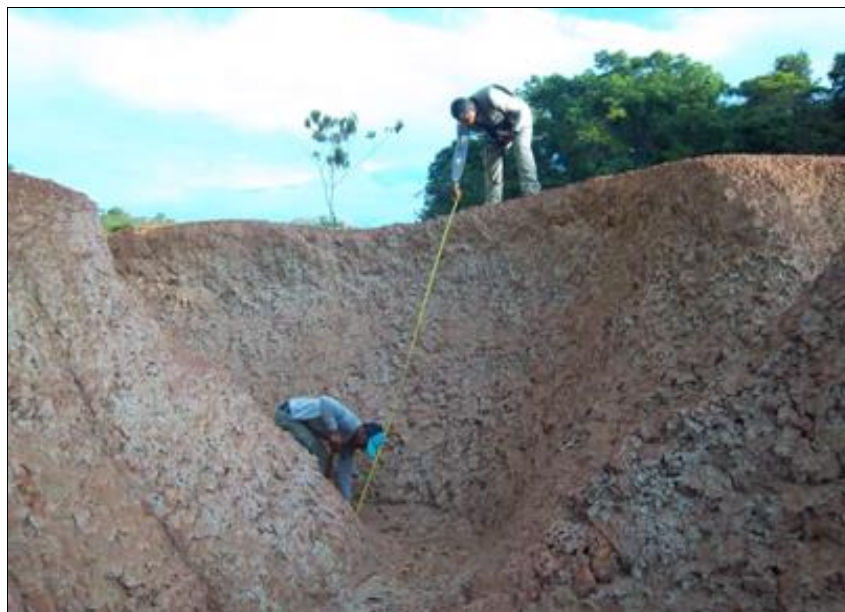
Figura 6.1.29 - Processo de vossorocamento avançado provocado por escoamento superficial, devido exposição do solo ao impacto direto da ação da água da chuva. Coordenadas 20 M 625851 9421861. Fonte: Engespro. Data: 20/06/2014.
