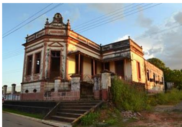
Figura 29 "Castelo" da Av. Gusmão em Humaitá/AM.
