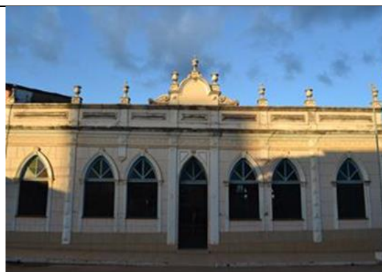
Figura 34 Atual Prédio da Biblioteca em Humaitá/AM.
