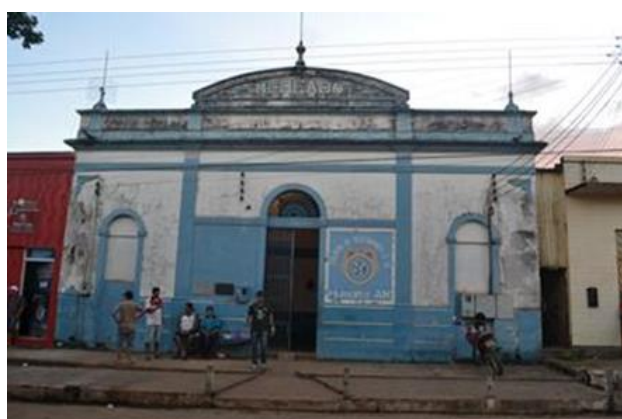
Figura 31 Antigo prédio do mercado em Humaitá/AM.
