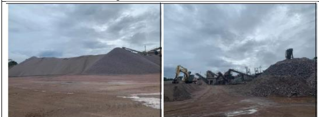
Figura 3.61: Pedreira MADECON operando junto a BR-364 sentido Porto Velho a Rio Branco.
