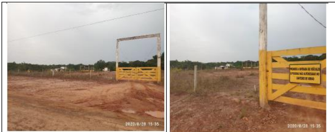
Figura 3.57: Canteiro de Obras do Segmento 03.
