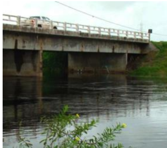
Figura 6.2.3.295 – Mesma ponte da foto anterior, porém no período chuvoso. Percebe-se a ausência da passagem da fauna em virtude da vazão do rio. Fonte: Embrapa Pantanal, 2010.
