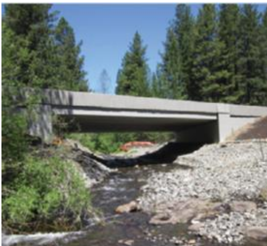
Figura 6.2.3.292 – Vão livre sob a ponte com elevação da passarela para garantir a passagem da fauna. Fonte: Van der Ree et al., 2015.
