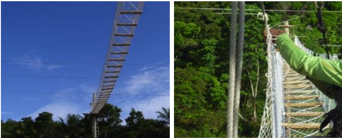
Figura 6.2.3.296 – Formato em U da passarela, com destaque para a rede de proteção. Fonte: GrupoEco. Acesso: Abril/2020.
