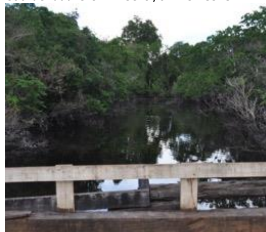
Figura 6.2.3.28 - P10- Rio Acará. Data: setembro/2014. Coordenada: 6°25'47.46"S /62°34'53.54"O
