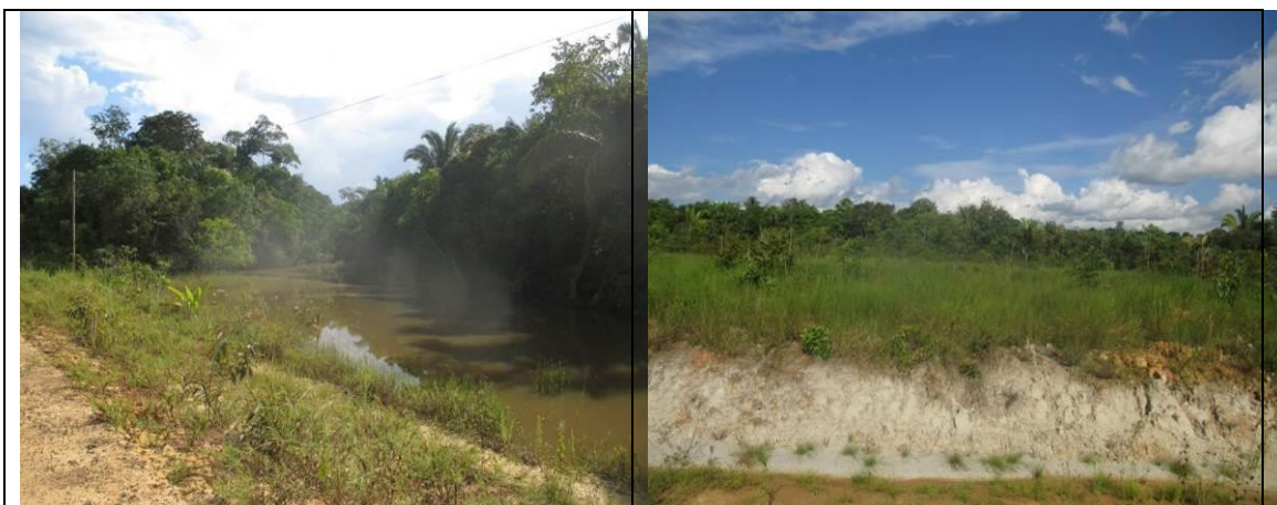
Figura 6.2.225 - Área alagada pela elevação do greide da rodovia, onde a vegetação na ADA da BR-319/AM está no estágio inicial de regeneração e na AE em estágio médio - lado direito (coordenada de referência 20M 658138/9449275). Data 07/06/2019.
