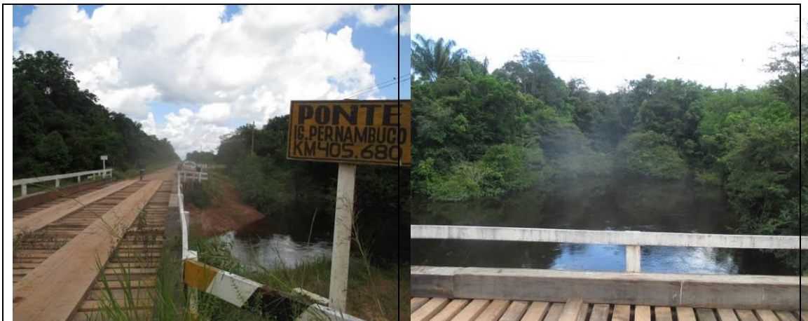
Figura 6.2.391 - Igarapé Pernambuco km 405,7 (coordenada de referência 20M 588800/9379740). Data 12/06/2019.
