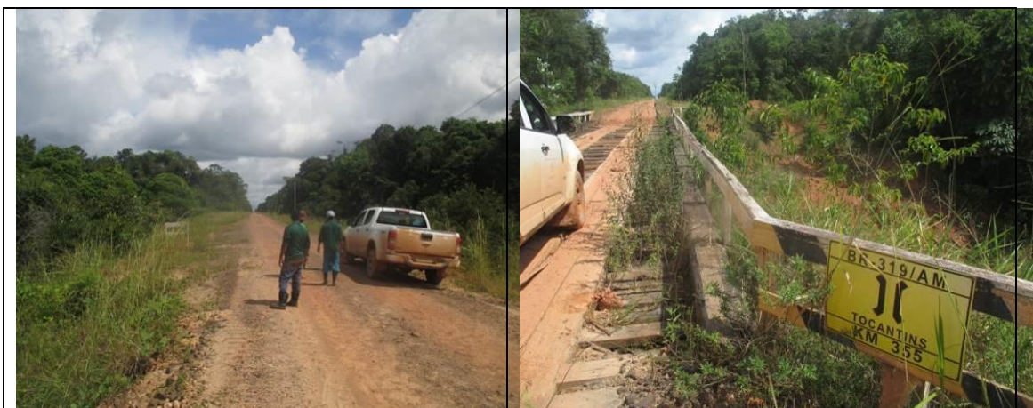
Figura 6.2.311 - Vista panorâmica da ADA da rodovia, após o Igarapé sem nome, onde a Floresta Ombrófila Densa na ADA se alterna entre os estágios inicial e médio de regeneração (coordenada de referência 20M 621414/9418737). Data 10/06/2019.
