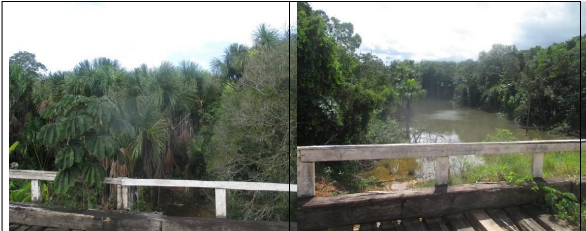
Figura 6.2.313 - Igarapé Tocantins com ponte – lado esquerdo, onde a Floresta Ombrófila Aluvial na ADA da BR-319/AM está no estágio médio de regeneração – lado esquerdo (coordenada de referência 20M 621153/9418480). Data 10/06/2019.
