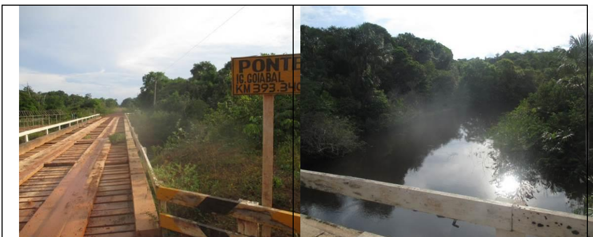
Figura 6.2.369 - Igarapé Goiabal km 393,3 (coordenada de referência 20M 595660/9389606). Data 11/06/2019.
