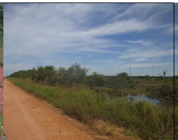
Figura 6.2.472 - Igarapé sem nome com bueiro – lado esquerdo da BR-319/AM, onde a Floresta Ombrófila Aluvial na ADA e em parte da AE foi praticamente toda substituída por pastagem. (coordenada de referência 20M 541548/9318773). Data 15/06/2019.
