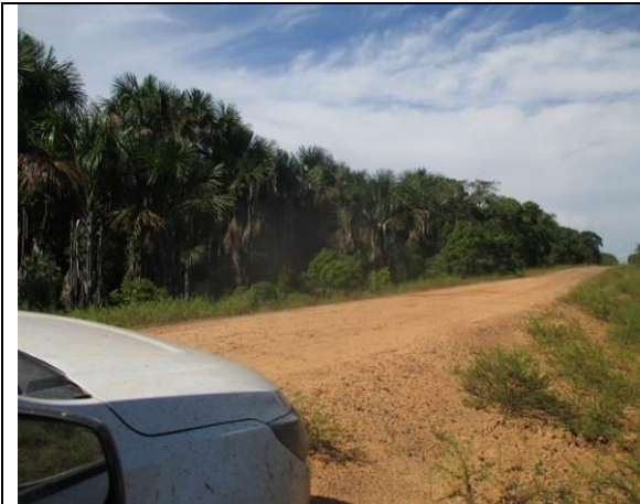
Figura 6.2.165 - Corpo hídrico sem nome com bueiro, onde a vegetação está em estágio médio de regeneração na ADA no lado esquerdo da rodovia (coordenada de referência 20M 674536/9462218). Data 07/06/2019.
