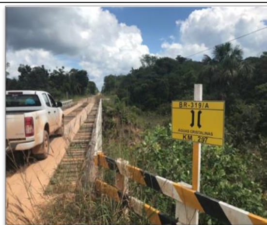
Figura 6.2.8 – Corpo hídrico e sua respectiva Área de Preservação Permanente - APP com ponte. Data 09/06/2019 (coordenada de referência 20M. 663389/9453434).
