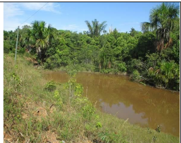
Figura 6.2.168 – Área alagada pela elevação do greide da rodovia. A Floresta Ombrófila Densa na ADA está no estágio inicial de regeneração. Na AE no estágio médio de regeneração – lado direito (coordenada de referência 20M 674370/9461859). Data 07/06/2019.
