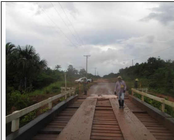
Figura 6.2.97 - Região do km 250,0 - início do trecho – ponte sobre o Igarapé Jordão (coordenada de referência 20M 692557/9485543). Data 03/06/2019.
