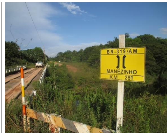
Figura 6.2.145 - Igarapé Manézinho km 281 da BR-319/AM (coordenada de referência 20M 675848/9463739). Data 07/06/2019.
