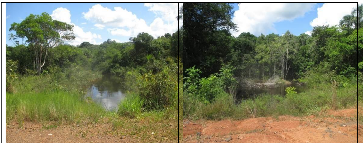
Figura 6.2.397 - Igarapé sem nome com bueiro – lado direito da BR-319/AM, onde a Floresta Ombrófila Aluvial na ADA e parte da AE estão no estágio inicial de regeneração (coordenada de referência 20M 586743/9376482). Data 12/06/2019.
