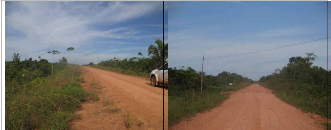
Figura 6.2.481 - Panorâmica da rodovia, sentido Igarapé Pequiá, onde a Floresta Ombrófila Aberta foi removida para implantação pastagem atingindo os limites da ADA e AE da BR-319/AM (coordenada de referência 20M 529201/9306883). Data 15/06/2019.
