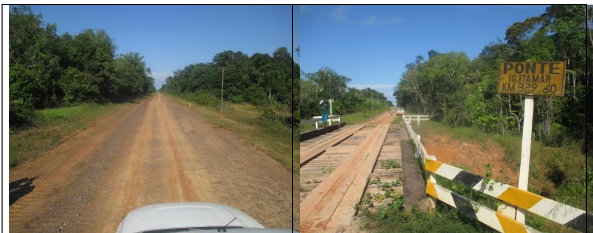
Figura 6.2.255 - Vista panorâmica da ADA da rodovia, após área de pastagem, onde Floresta Ombrófila Densa está no estágio médio de regeneração (coordenada de referência 20M 641546/9434284). Data 09/06/2019.
