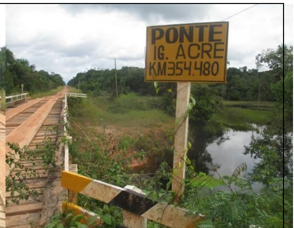
Figura 6.2.304 - Igarapé Acre (coordenada de referência 20M 621559/9418872). Data 10/06/2019.
