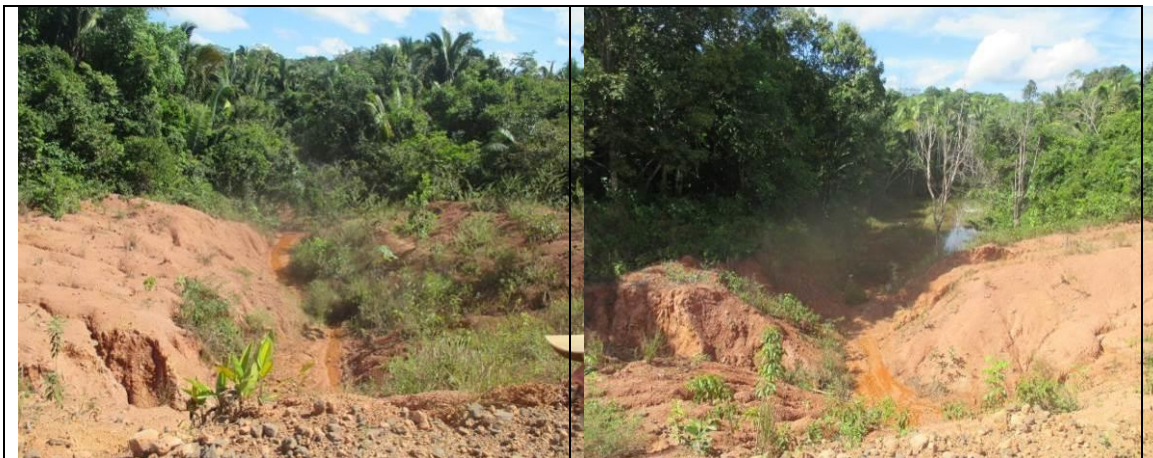
Figura 6.2.499 - Igarapé sem nome com bueiro – lado direito da BR-319/AM, onde a Floresta Ombrófila Aluvial e a Floresta Ombrófila Aberta na ADA e parte da AE estão no estágio inicial de regeneração (coordenada de referência 20M 516041/9290594). Data 16/06/2019.
