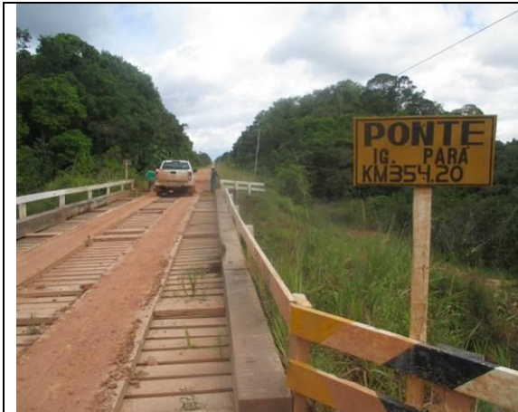
Figura 6.2.301 - Igarapé Pará (coordenada de referência 20M 621768/9419079). Data 10/06/2019.
