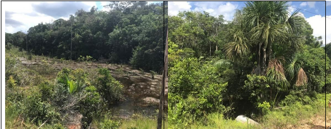
Figura 6.2.207 - Corpo hídrico sem nome com bueiro na BR-319/AM, onde a Floresta Ombrófila Aluvial na ADA e na AE foi alagada devido à baixa capacidade de escoamento das águas de montante, ocasionando a morte de indivíduos arbóreos – lado direito (coordenada de referência 20M 662030/9452413). Data 07/06/2019.
