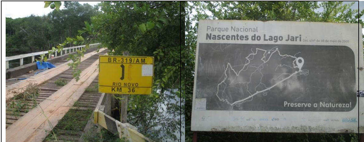
Figura 6.2.333 - Rio Novo km 367,0 (coordenada de referência 20M 610765/9412152). Data 10/06/2019.
