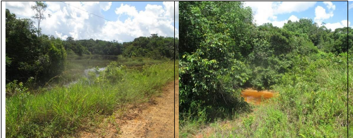
Figura 6.2.395 - Igarapé sem nome com bueiro – lado direito da BR-319/AM, onde a elevação do greide da rodovia nos limites da ADA e de AE aumentou a lâmina d'água matando indivíduos arbóreos por afogamento do sistema radicular (coordenada de referência 20M 587232/9377255). Data 12/06/2019.
