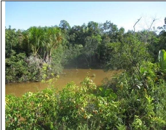
Figura 6.2.169 - Área alagada pela elevação do greide da rodovia, onde a vegetação na ADA da BR-319/AM está no estágio inicial de regeneração. - lado esquerdo, (coordenada de referência 20M 674370/9461859). Data 07/06/2019.
