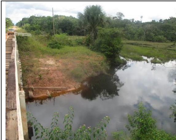
Figura 6.2.305 - Igarapé Acre com ponte, onde a Floresta Ombrófila Aluvial na ADA da rodovia está no estágio inicial de regeneração – lado direito (coordenada de referência 20M 621559/9418872). Data 10/06/2019.
