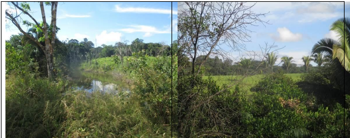
Figura 6.2.491 - Igarapé sem nome com bueiro – lado esquerdo da BR-319/AM, onde a Floresta Ombrófila Aluvial na ADA e em parte da AE está no estágio inicial de regeneração. Ao fundo na ADA se pode observar área de pastagem (coordenada de referência 20M 518619/9293394). Data 16/06/2019.
