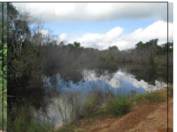
Figura 6.2.386 - Igarapé sem nome com bueiro – lado esquerdo da BR-319/AM, onde a elevação do greide da rodovia matou a vegetação por afogamento do sistema radicular na ADA e AE (coordenada de referência 20M 589511/9380877). Data 12/06/2019.
