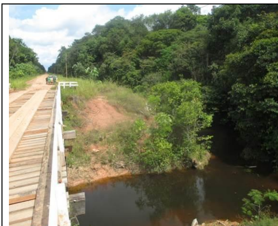
Figura 6.2.295 - Igarapé Roraima com ponte, onde a Floresta Ombrófila Aluvial em parte da ADA da BR-319/AM está no estágio médio de regeneração – lado esquerdo (coordenada de referência 20M 625232/9422455). Data 10/06/2019.
