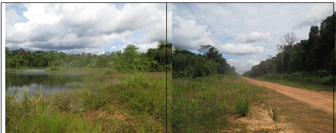
Figura 6.2.435 - Lagoa formada pela elevação do greide da rodovia, que abrange os limites da ADA e AE – lado direito. Ao fundo se pode observar a Floresta Ombrófila Densa no estágio médio de regeneração (coordenada de referência 20M 563344/9345671). Data 13/06/2019.
