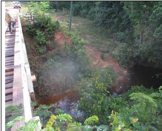
Figura 6.2.231 - Corpo hídrico sem nome com ponte, onde a Floresta Ombrófila Aluvial na ADA está no estágio inicial de regeneração – lado direito (coordenada de referência 20M 657028/9448291). Data 08/06/2019.
