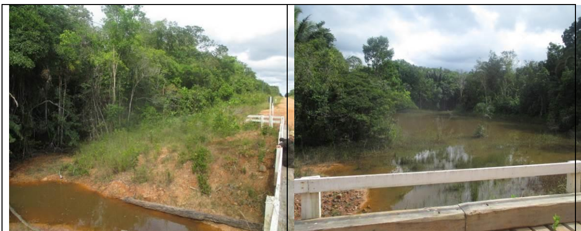
Figura 6.2.271 - Igarapé Ponte dos Milagres com ponte – lado esquerdo, onde a Floresta Ombrófila Aluvial na ADA da BR-319/AM está, em sua maioria, no estágio médio de regeneração (coordenada de referência 20M 634997/9428864). Data 09/06/2019.
