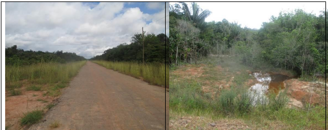
Figura 6.2.285 - Vista panorâmica da ADA da rodovia, após o Rio Manicoré, onde se pode observar a ADA com capim exótico Andropogon bicornis – Capim andropogon e a Floresta Ombrófila Densa no estágio inicial de regeneração (coordenada de referência 20M 629313/9425309). Data 10/06/2019.
