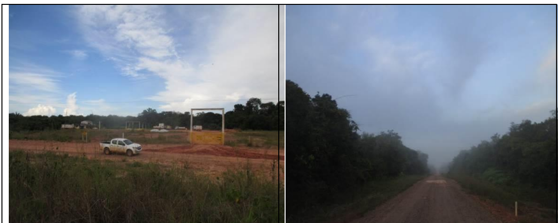
Figura 6.2.459 - Canteiro de obras da empreiteira CMM – lado esquerdo BR-319/AM dentro dos limites da ADA e de parte da AID (coordenada de referência 20M 547390/9325708). Data 13/06/2019.
