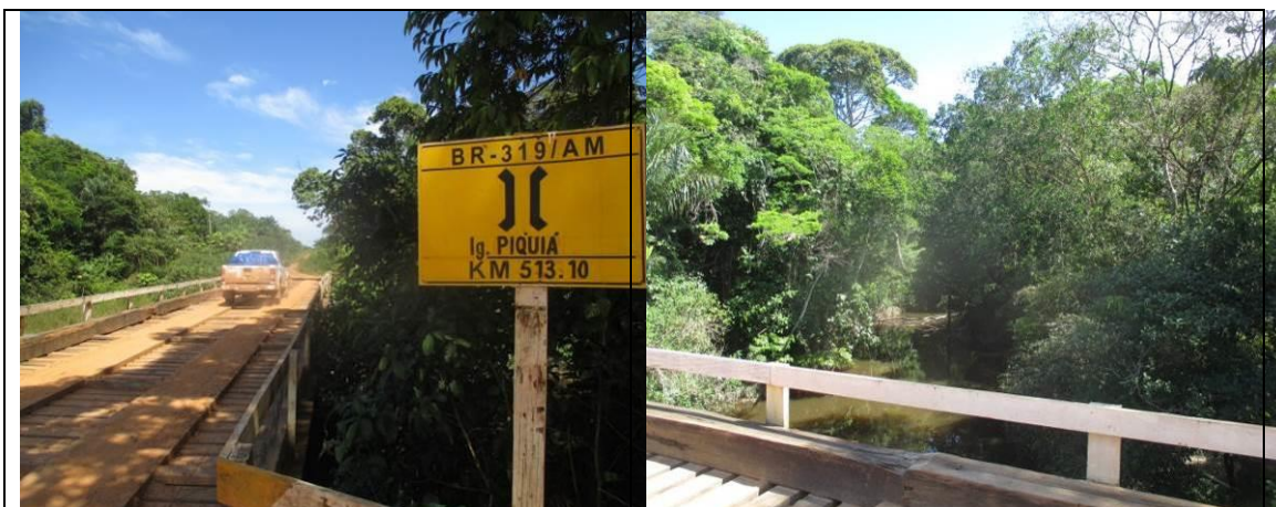
Figura 6.2.487 - Igarapé Pequiá - km 513,10 (coordenada de referência 20M 521191/9295783). Data 16/06/2019.
