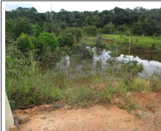
Figura 6.2.115 - Corpo hídrico sem nome com bueiro no lado direito da rodovia, onde a vegetação nas suas margens está em estágio inicial de regeneração (coordenada de referência 20M 688418/9476655). Data 04/06/2019.
