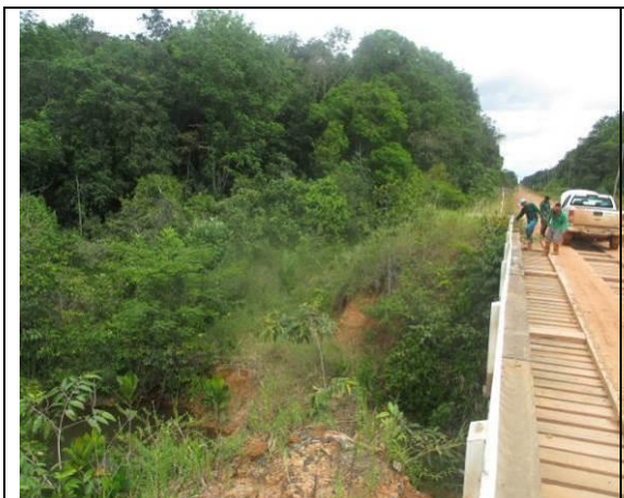
Figura 6.2.303 - Igarapé Pará com ponte, onde a Floresta Ombrófila Aluvial na ADA está no estágio inicial de regeneração – lado esquerdo da BR-319/AM (coordenada de referência 20M 621768/9419079). Data 10/06/2019.
