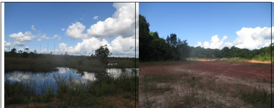
Figura 6.2.405 - Lagoa formada pela elevação do greide da rodovia nos limites da ADA e AE – lado esquerdo (coordenada de referência 20M 581948/9368884). Data 12/06/2019.
