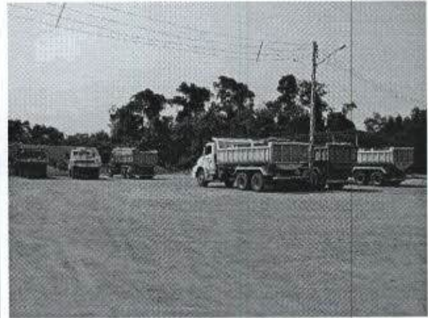
Foto 74: canteiro de obras da construtora.
