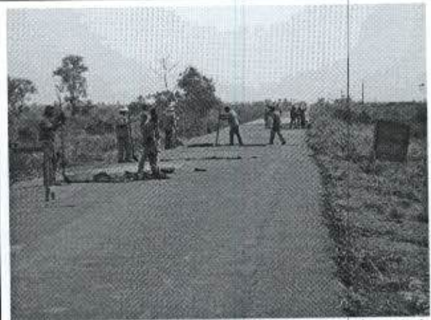
Foto 6: De forma geral o pavimento possui regular estado de conservação, sendo realizadas operações tapa-buracos como nesta foto.
