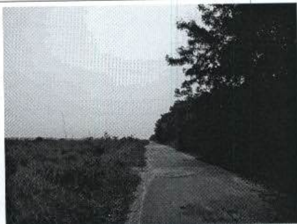
Foto 8: na Transamazônica, há ocupação mais antiga das margens, com conversão de áreas florestais em pastagens. Nesta foto, podemos visualizar a nítida diferença entre as margens da rodovia: à esquerda pastagens, e à direita, área do Exército.
