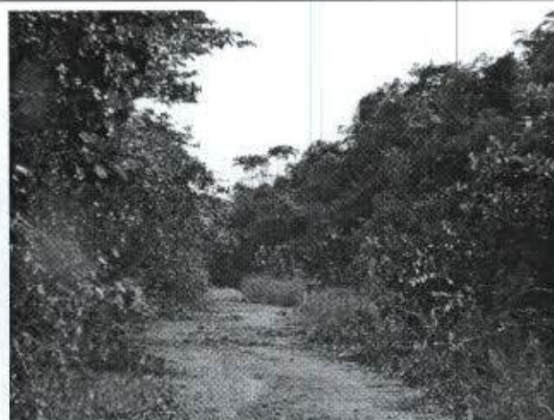
Foto 48: floresta avançando em direção à rodovia.
