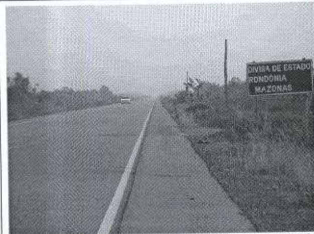
Foto 3: Rodovia em bom estado de conservação desde Porto Velho até a divisa RO/AM
