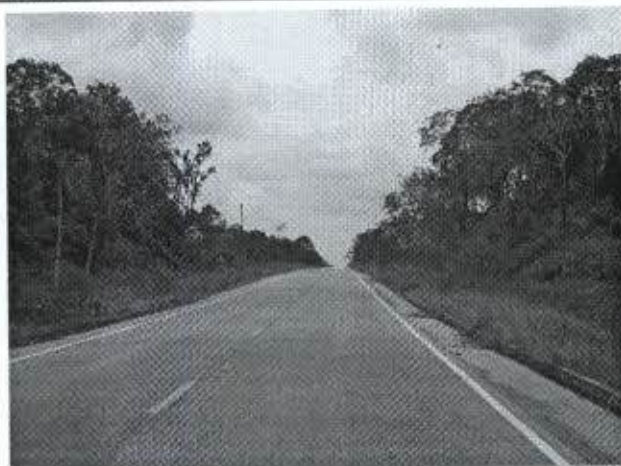
Foto 77: início do trecho 5, com ótimas condições de trafegabilidade
