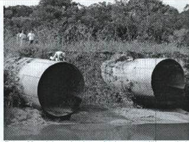
Foto 62: dois bueiros ármicos metálicos ainda funcionando
