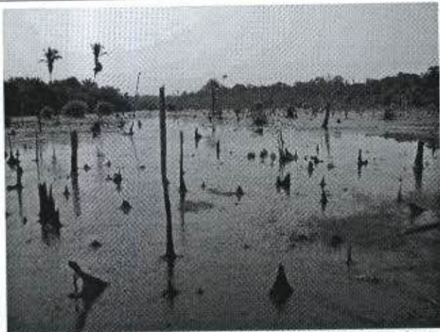
Foto 13: Paliteiro – troncos de árvores mortas em áreas inundadas com a interrupção da drenagem natural, causada pela instalação da rodovia.
