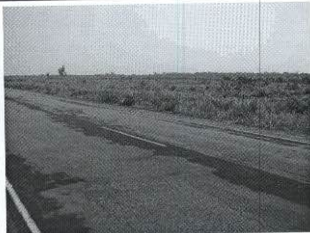
Foto 18: Trecho com rodovia em bom estado de conservação. Entorno desmatado para pastagens. Apesar disso, a ocupação do entorno da rodovia por pastagens, além do desmatamento, não têm a intensidade visualizada no entorno da rodovia Transamazônica.
