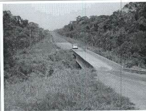
Foto 10: Ponte de pista única, característica desse trecho inicial da rodovia.
