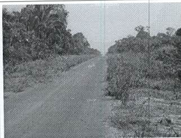
Foto 20: Final do trecho 2, em bom estado de conservação.
