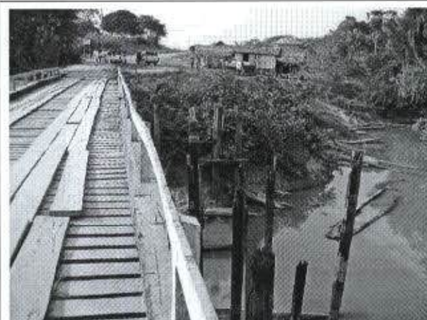
Foto 25: Ponte construída pela EMBRATEL próxima ao projeto de assentamento "Realidade". Ao lado esqueleto de antiga ponte e de bueiros metálicos dispostos no rio.
