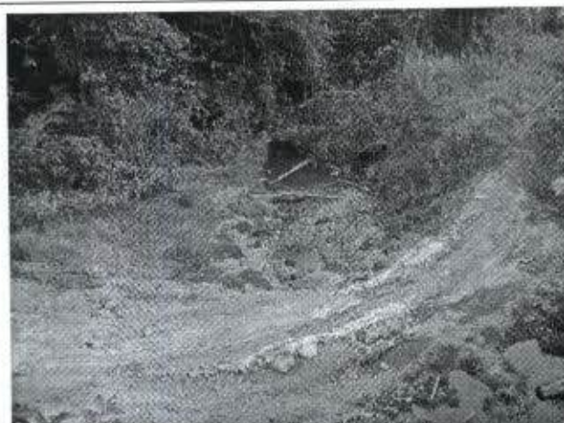
Foto 9: Aterramento de curso d'água para passagem provisória de veículos.
