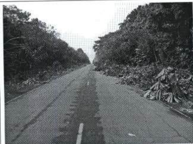
Foto 19: Rodovia em bom estado com supressão de vegetação na faixa de domínio.
