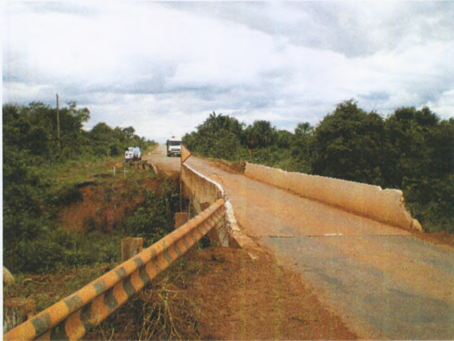
Figura 8 - Vista geral da ponte sobre o igarapé Bem-Te-Vi.
