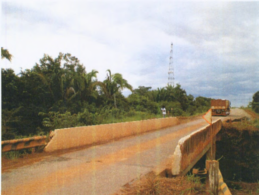
Figura 9 - Vista da ponte sobre o igarapé Galo.
