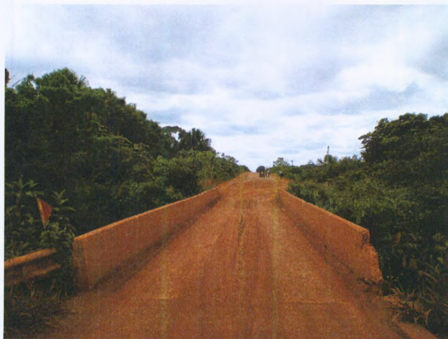
Figura 7 - Vista de ponte sobre o rio Ipixuna.
