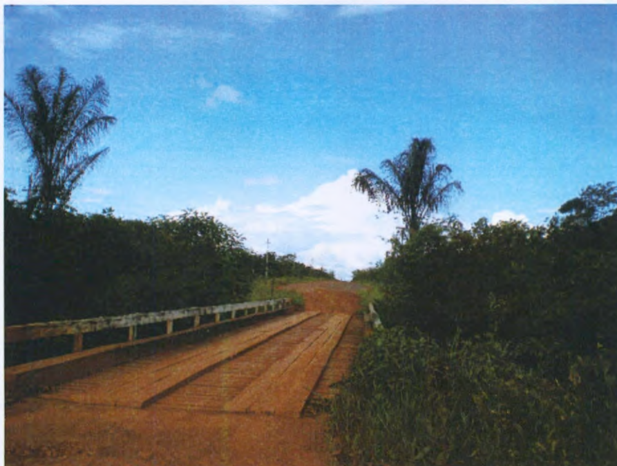
Figura 103 - Vista da ponte de madeira sobre o Igarapé Açua
