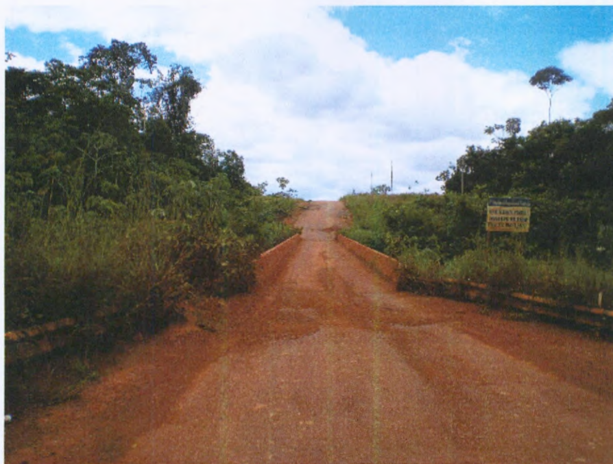
Figura 6 - Vista geral da ponte sobre o igarapé Been.
