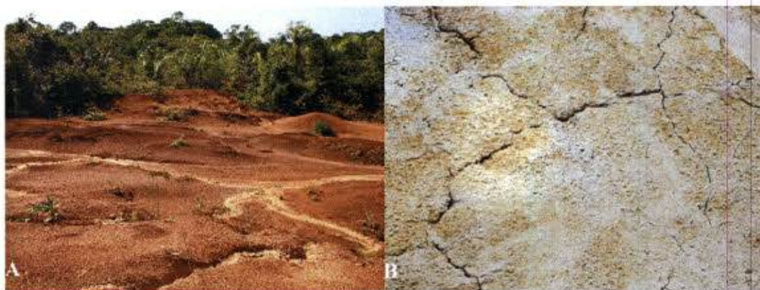
Figura 7. Solo com sulco erosivo (A) e fraturado (B) no Segmento "C" da BR-319. A regeneração inicial é incipiente, advinda da floresta do entorno (A). Note a marca das gotas de chuva no solo (B). Foi observado que o solo apresenta uma coloração esbranquiçada, indicando o componente caulinita (cor esbranquiçada em B) em maior proporção que o componente argila (cor amarelo em B).
