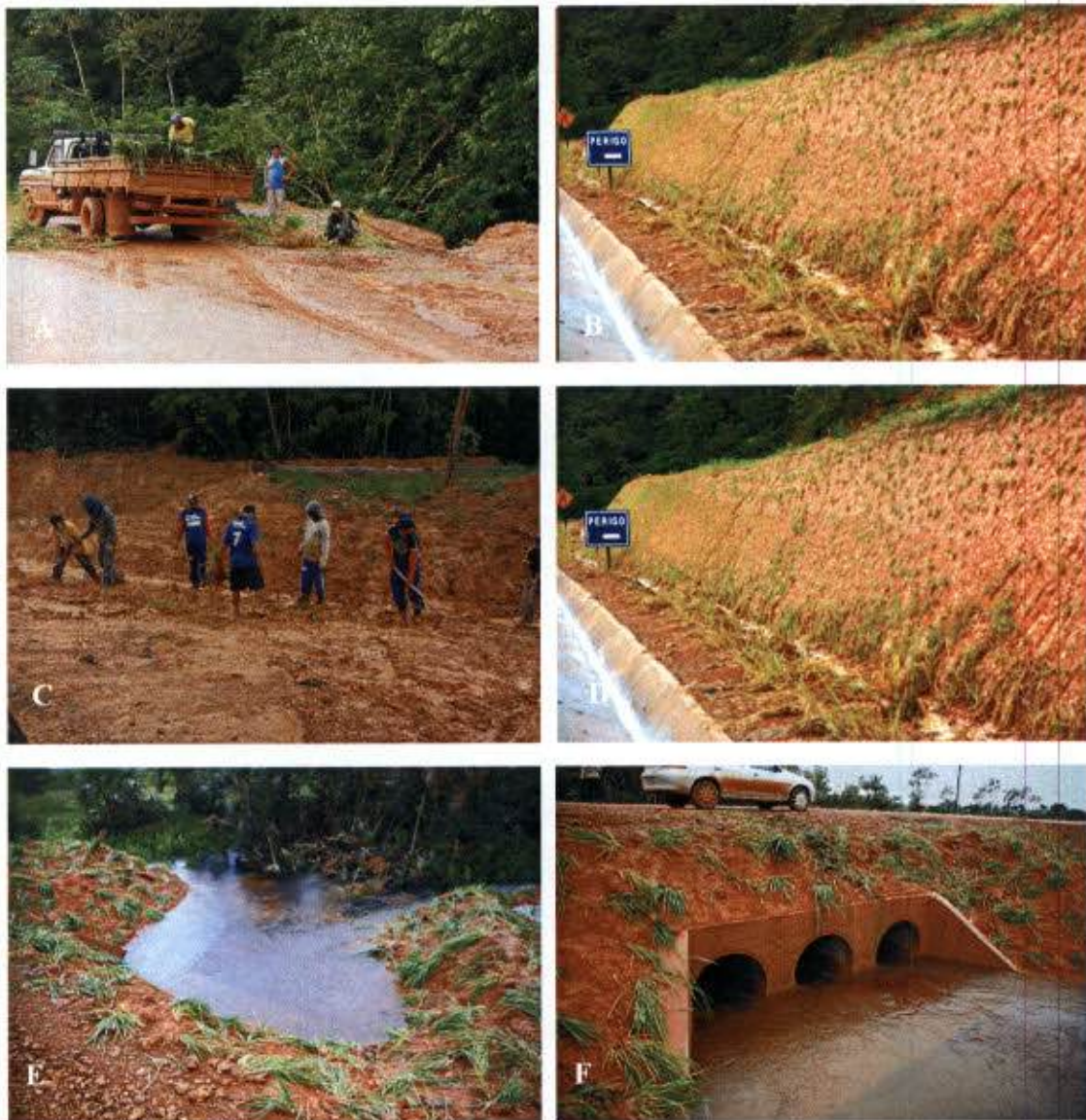
Figura 12. Plantio de capim quicuiu da amazônia nas margens do cursos de água do Lote 1 Sul, Segmento "B". Em A, caminhão carregado com a gramínea coletada. Em B, corte da gramínea. Em C, plantio da gramínea. Em D, E e F, aspecto das áreas plantadas com a gramínea.
