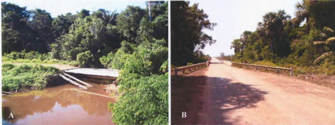
Fig. 3: Antiga ponte de madeira que existia ao longo do segmento estudado (A), e que foi substituída por pontes de concreto armado (B).
