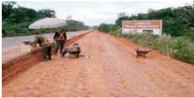
Figura 25 – Regularizações de Subleito na rodovia BR-319.
