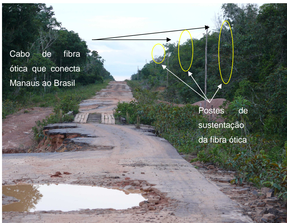
Figura 29 – Na margem da pista, observa-se o cabo de fibra ótica que conecta Manaus ao resto do Brasil, merecem destaque os postes usados para sua sustentação.
