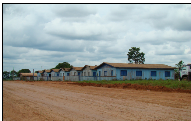
Alojamento / Canteiro já implantado (km 38)
