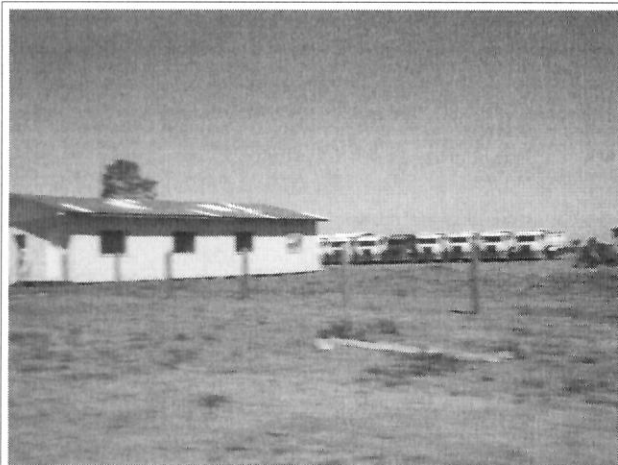
Foto 09: Canteiro de obras implantado- Margem direita da rodovia
