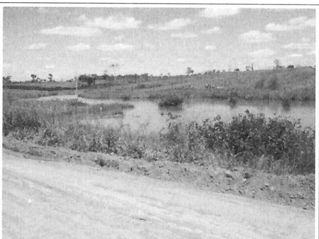
Foto 17: Área de APP desmatada- Margem esquerda da rodovia
