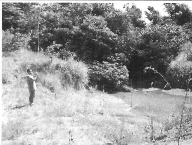
Foto 14: Área de APP desmatada- Margem direita da rodovia
