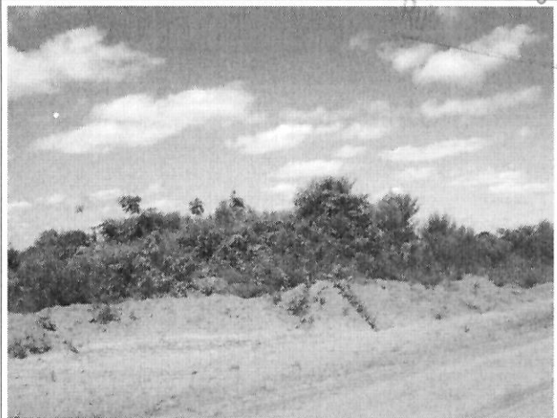
Foto 13: Disposição inadequada de solo- Margem esquerda da rodovia
