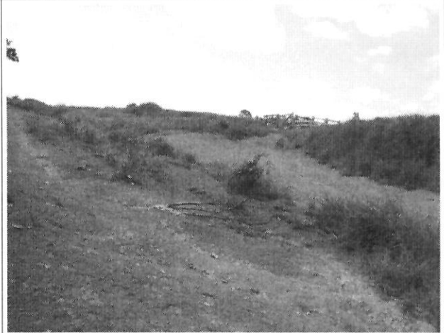
Foto 02: Detalhe da erosão no talude de corte – Margem esquerda da rodovia
