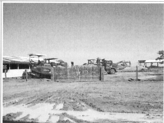
Foto 10: Canteiro de obras implantado- Margem direita da rodovia
