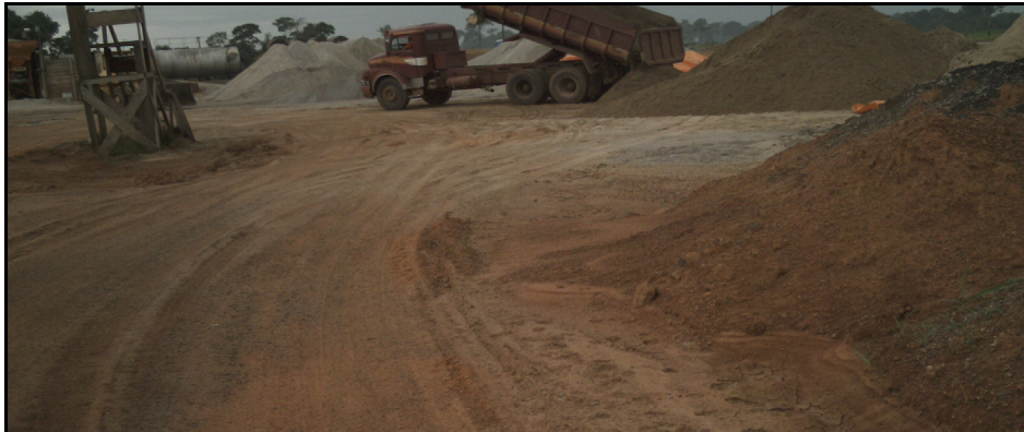
Foto 7-1 – Foto Ilustrativa: Representação de um canteiro de obra.
