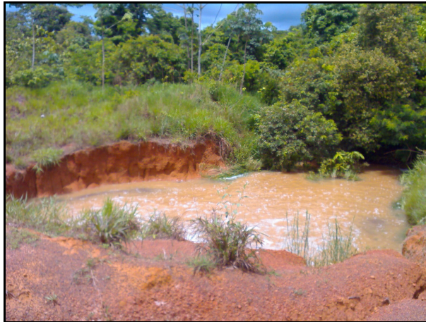
Foto 7-3 – Córrego interceptado pela rodovia em processo de assoreamento.
