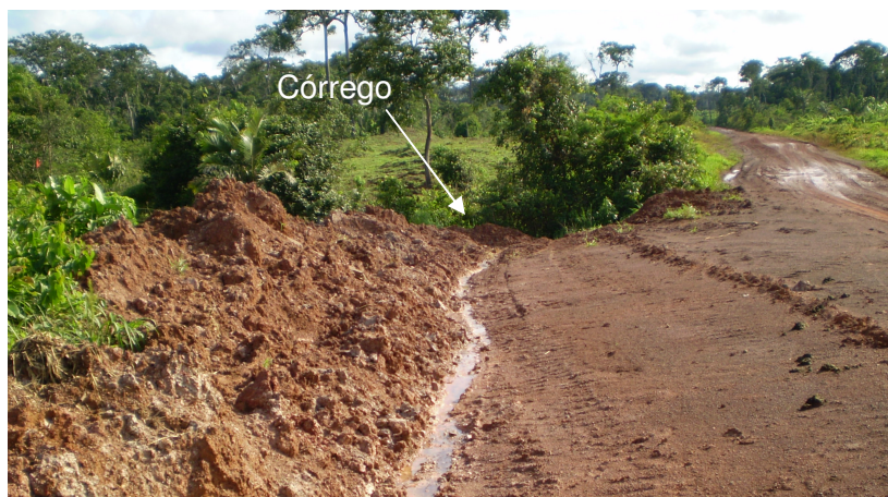
Foto 7-5 – Trecho com carregamento de materiais para o curso hídrico
