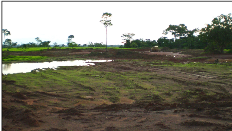
Foto 7-6 – Área de extração na faixa de serviço.
