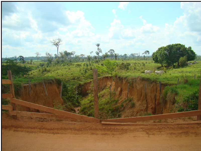
Foto 7-4 - Erosão as margens da rodovia
