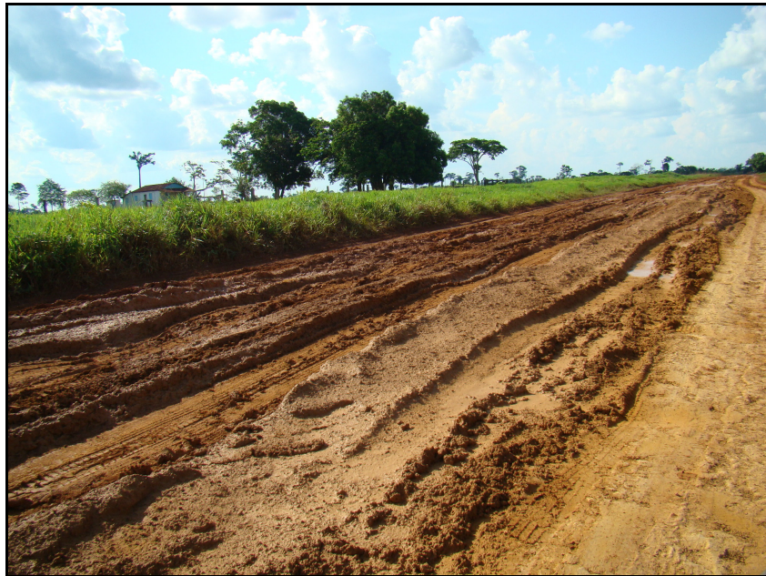
Foto 6-1 – Característica geral dos trechos não pavimentados da rodovia.
