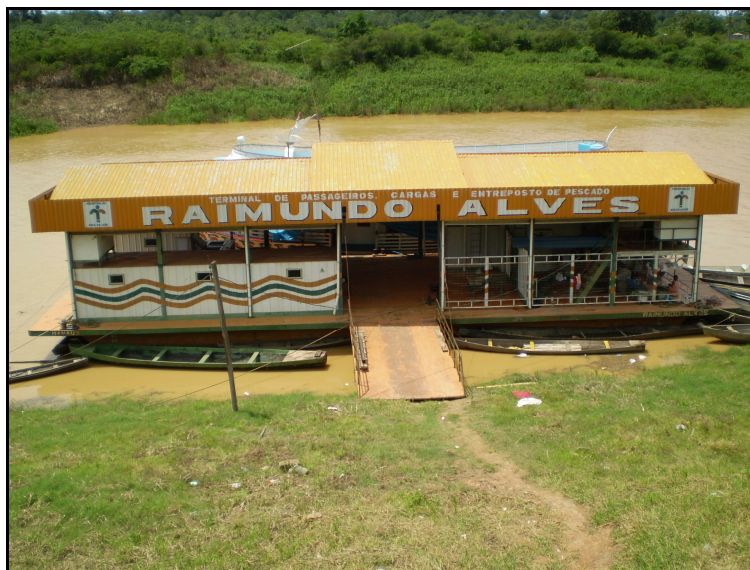
Foto 6-12 – Terminal de passageiros em Boca do Acre/AM
