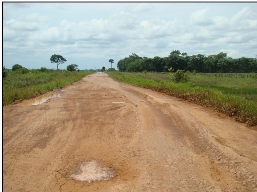
Foto 6-2 – Vista de um trecho pavimentado na BR 317/AM
