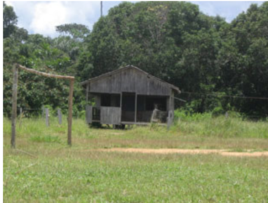
Foto 5.3—67— Construção habitacional típica na região, com piso suspenso apoiado em esteios de madeira, no Território Indígena Boca do Acre.
