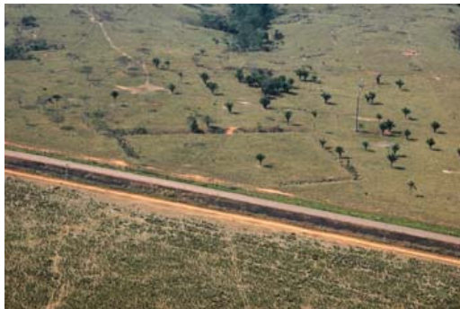
Foto 5.3—35- Quadrado parcialmente destruído, na Fazenda Baixa Verde, na BR 317 (Disponível em http://www.geoglifos.com.br ).
