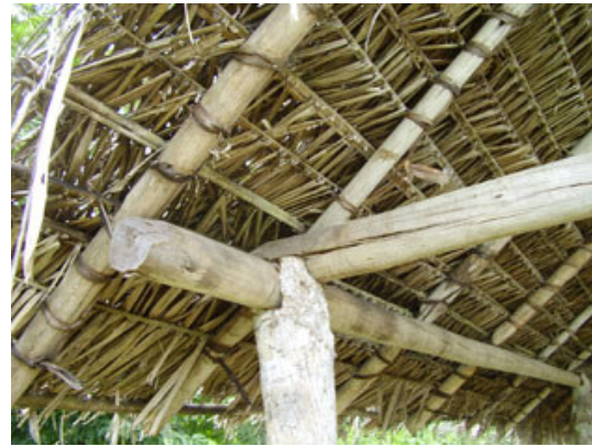
Foto 5.3—62 - Detalhe do sistema de apoio da estrutura do telhado – Camicuã.
