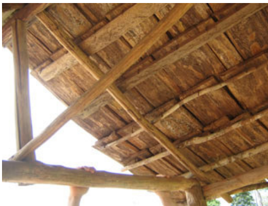
Foto 5.3—59- Detalhe da tesoura de madeira roliça e caibros de madeira lascada em construção nativa de Território Indígena.
