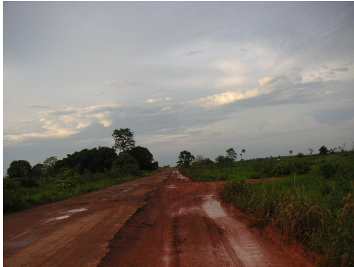
Foto 5.3—19- Trecho da BR 317/AM próximo a Boca do Acre
