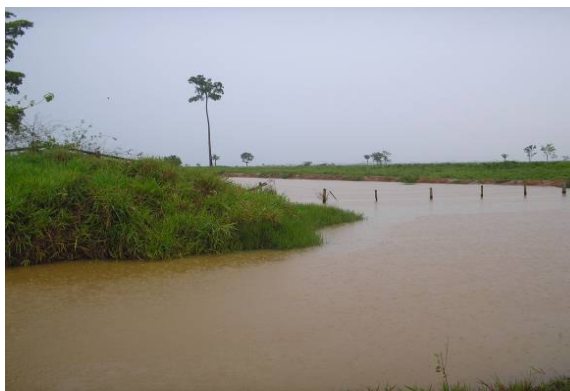
Foto 5.2-33 Passivo - Área de empréstimo sujeito a alagamento; lado direito. Coordenadas: 688.403 / 8.992.190
