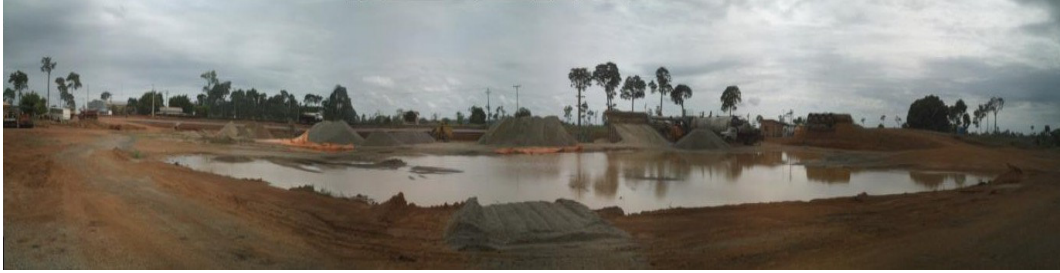
Foto 5.1-36 - Pátio de operação em usina de asfalto (foto ilustrativa)
