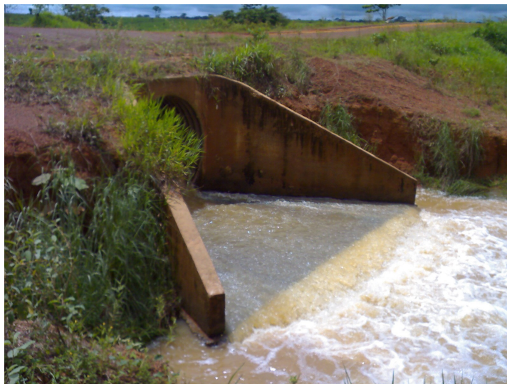
Foto 5.1-27 – Bueiro ármico, no km 37,3.
