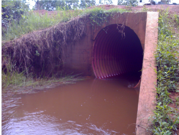
Foto 5.1-26 – Bueiro ármico, no km 24,7.
