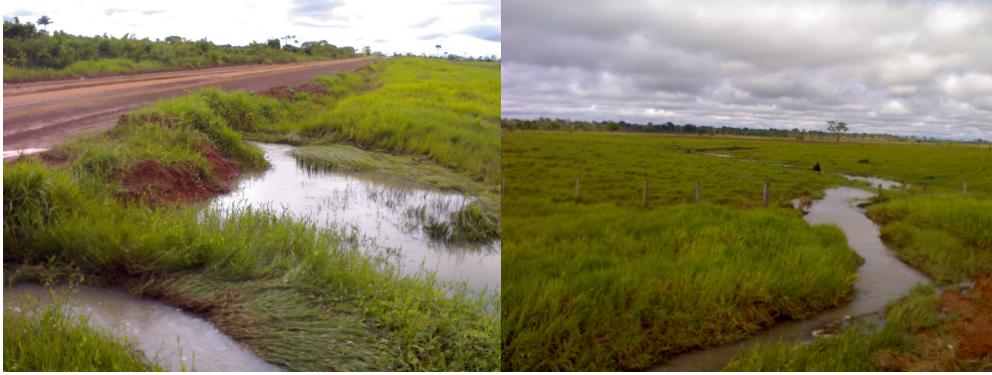
Foto 5.1-28 - Igarapé interceptado pela BR-317/AM, no km 12,9.
