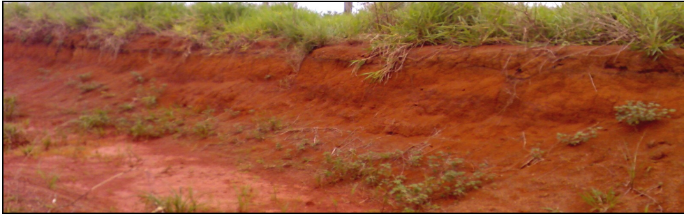
Foto 5.1-22 - Talude de corte da rodovia, no km 55.
