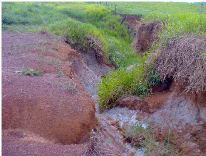
Foto 5.1-6 – Material mais friável (saibroso) exposto as intempéries climáticas, no km 54,4.
