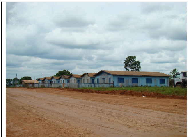
Foto 2—3 Área que será destinada ao canteiro de obras
