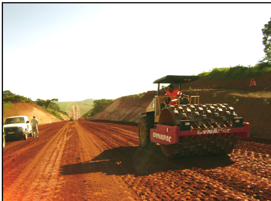
Foto 2—9 Foto ilustrativa: Terraplenagem
