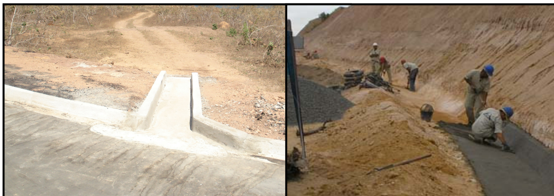
Foto 2—10 Foto ilustrativa: Entradas para descidas d'água - Sarjeta de corte em seção triangular
